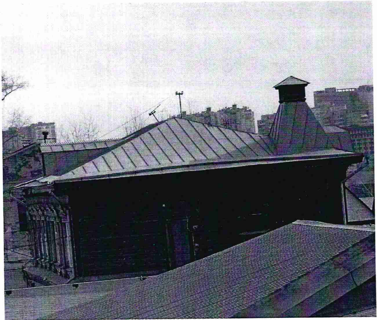
Рис 4. Вид на крышу объекта со стороны здания, расположенного по адресу: ул. Ногина 10/1 корпус 1
