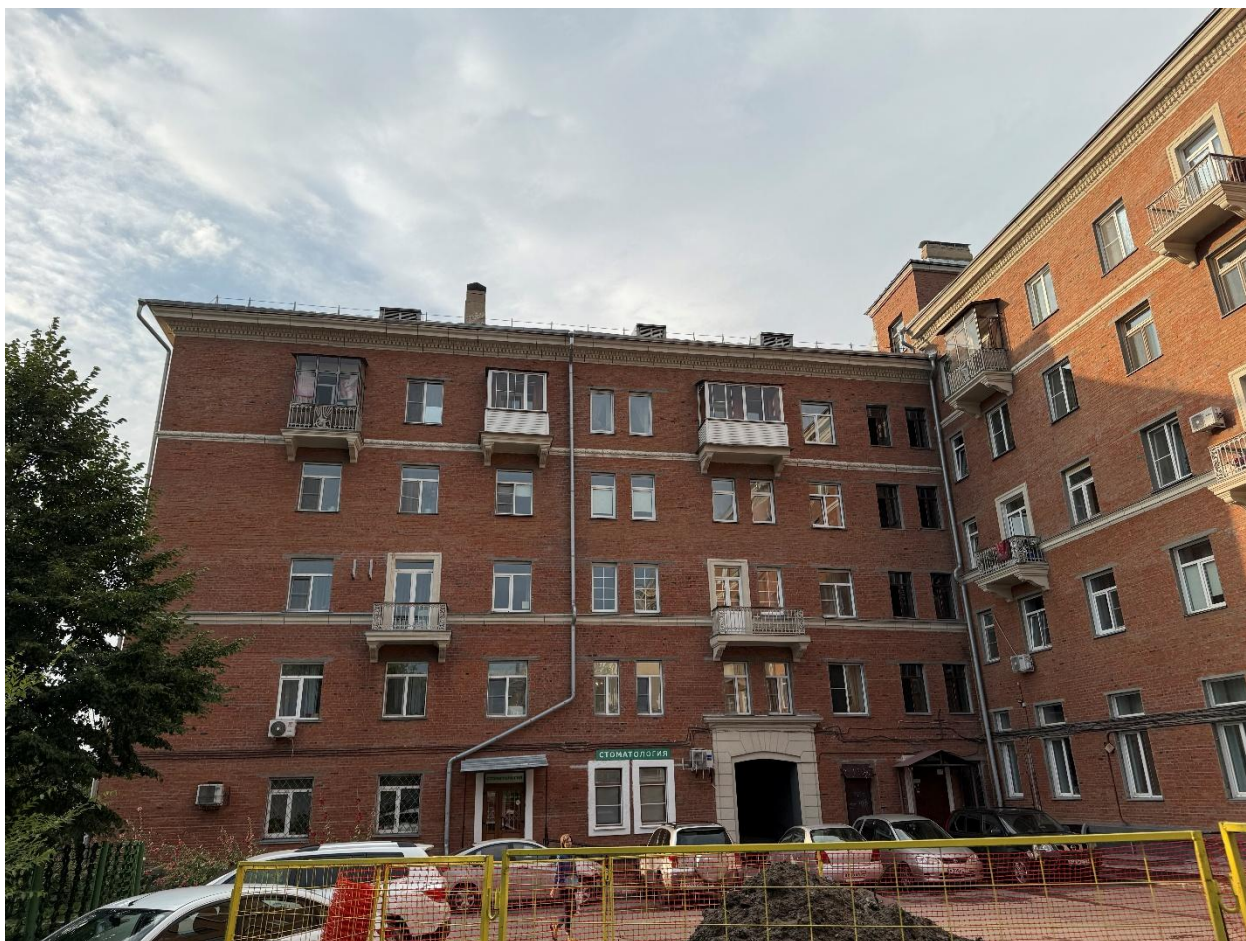
Фото 4. Южная часть западного (дворового) фасада
