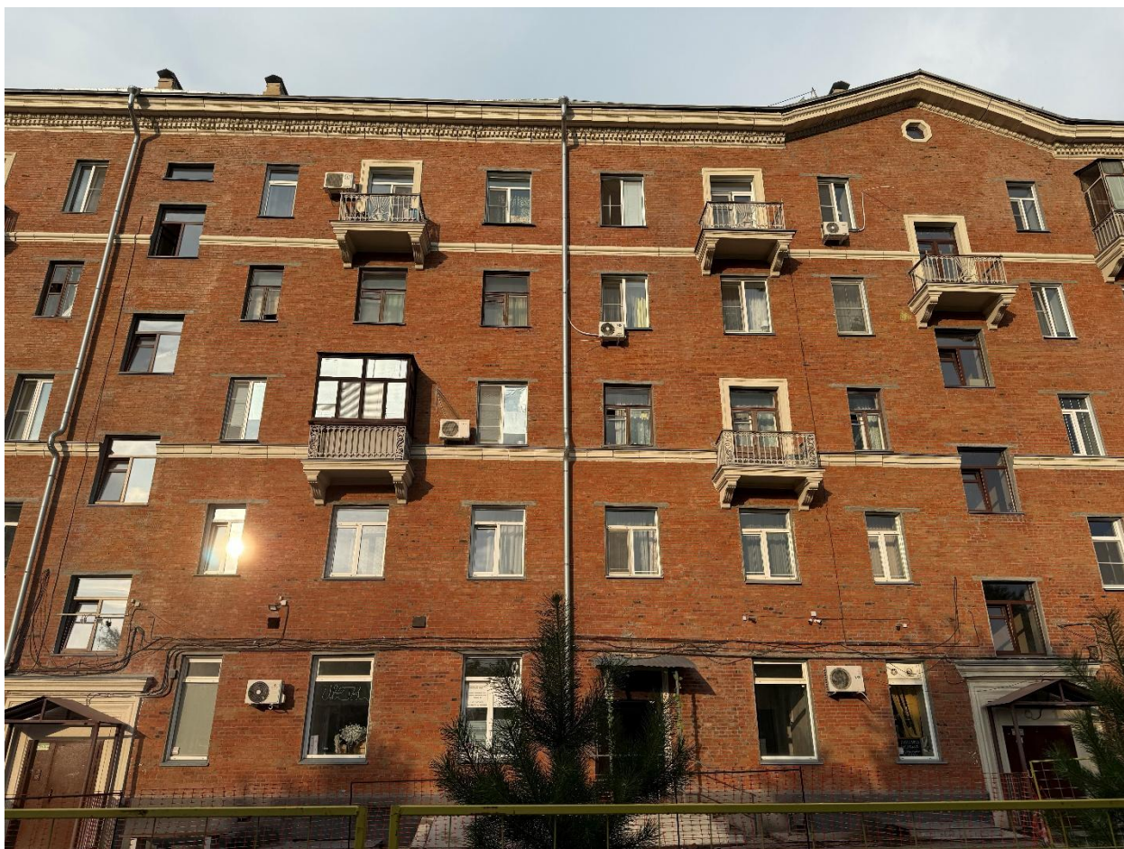
Фото 3. Южная часть западного (дворового) фасада.
