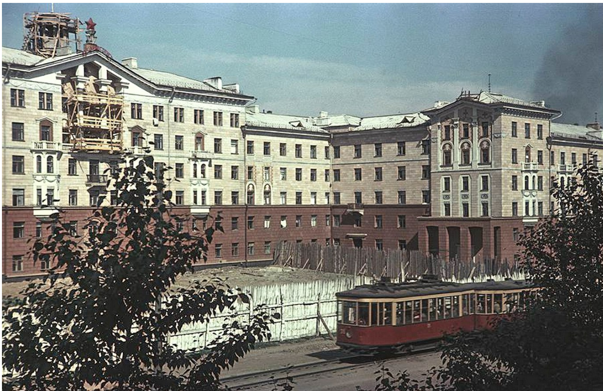
Илл. 3. Строительство дома №4 по улице Станиславского. 1951–1952 гг. //https://pastvu.com/p/634631
