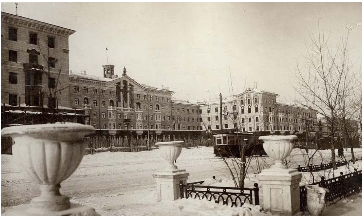
Илл. 4. Жилой дом №4 на улице Станиславского. 1952–1953 гг. // https://pastvu.com/p/550395
