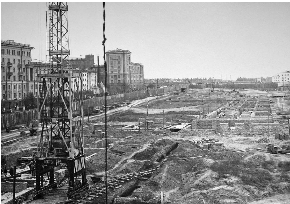
Илл. 2. Улица Станиславского. Слева дома № 3, 5 и 7, строится дом №4. 1947–1951 гг. // https://pastvu.com/p/876553
