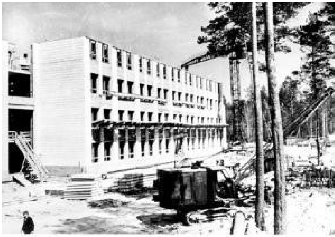
Строительство Учебно-лабораторного корпуса НГУ (ныне – Главный корпус по ул. Пирогова, 2), 1967-1968 гг. Источник: сайт http://academcity.icgbio.ru/content/kampus-ngu-10-shagov-razvitiya .
