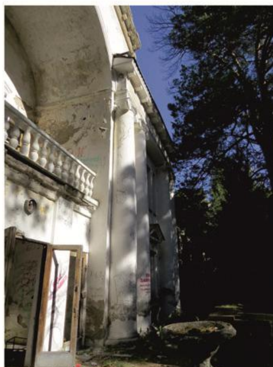
Илл. 58 – Первый корпус санатория «Речкуновский». Фрагмент главного фасада. Фото 2016 г. Источник: архив ГАУ НСО НПЦ
