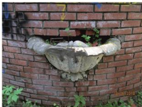
Илл. 74 – Первый корпус санатория «Речкуновский». Декоративное оформление центральной части. Фото 2018 г. Источник: архив ГАУ НСО НПЦ
