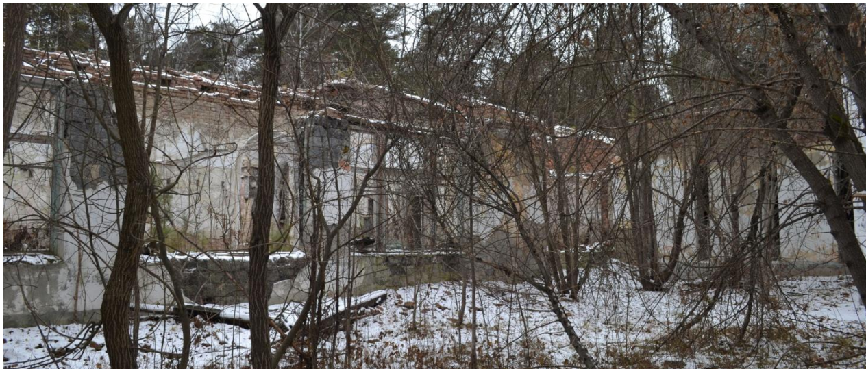
31. Вид и состояние фрагмента северо-восточного фасада примыкающего объёма и фрагмент юго-восточного фасада перехода. Ноябрь 2024 г.
