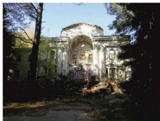
Илл. 88 – Центральная часть главного фасада. Фото Скиданенко Е. Н., 05.10.2023 г. Архив ГАУ НСО НПЦ
