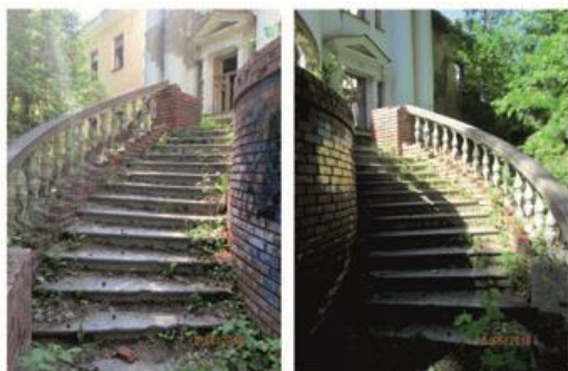
Илл. 77 – Первый корпус санатория «Речкуновский». Лестницы. Фото 2018 г. Источник: архив ГАУ НСО НПЦ
