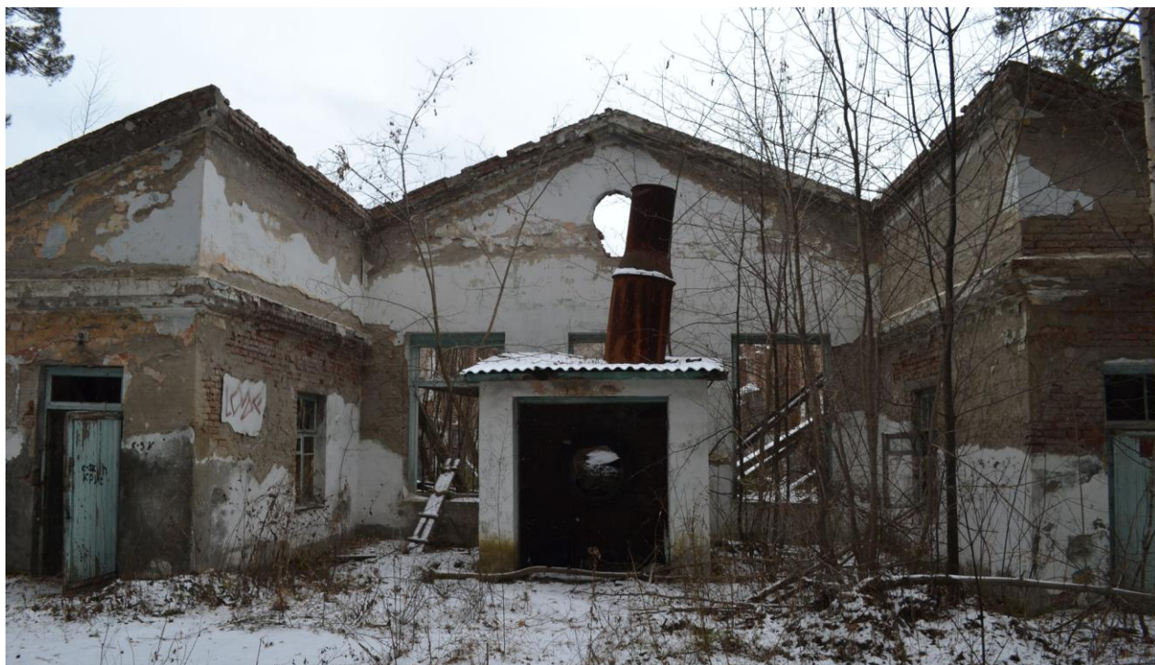
21. Вид и состояние северо-западного фасада примыкающего объёма. Ноябрь 2024 г.
