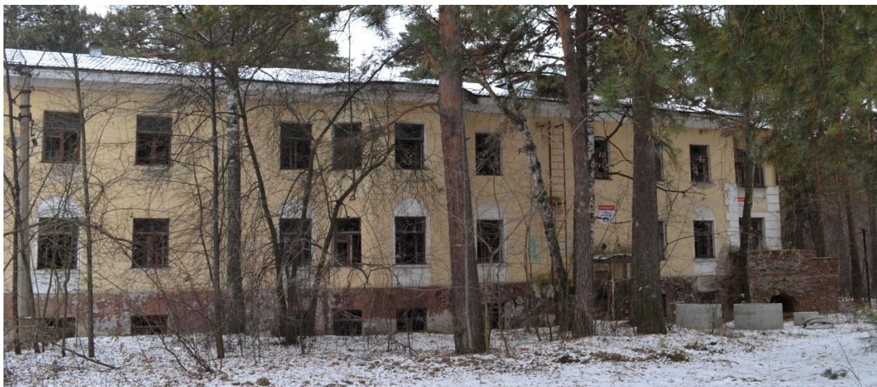
13. Вид и состояние фрагмента правой части северо-западного фасада основного объёма. Ноябрь 2024 г.
