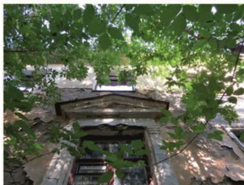
Илл. 52 – Первый корпус санатория «Речкуновский». Фрагмент главного фасада. Фото 2016 г. Источник: архив ГАУ НСО НПЦ
