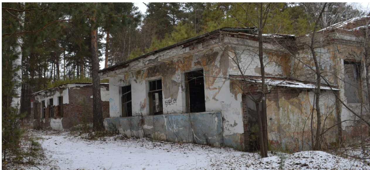
18. Вид и состояние пристроенных объёмов к юго-западному фасаду примыкающего объёма. Ноябрь 2024 г.
