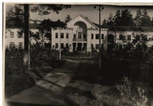
Илл. 34 – Главный корпус Бердского Дома отдыха ЦК союза работников речного транспорта. Источник: муниципальное бюджетное учреждение «Бердский историко-художественный музей»
