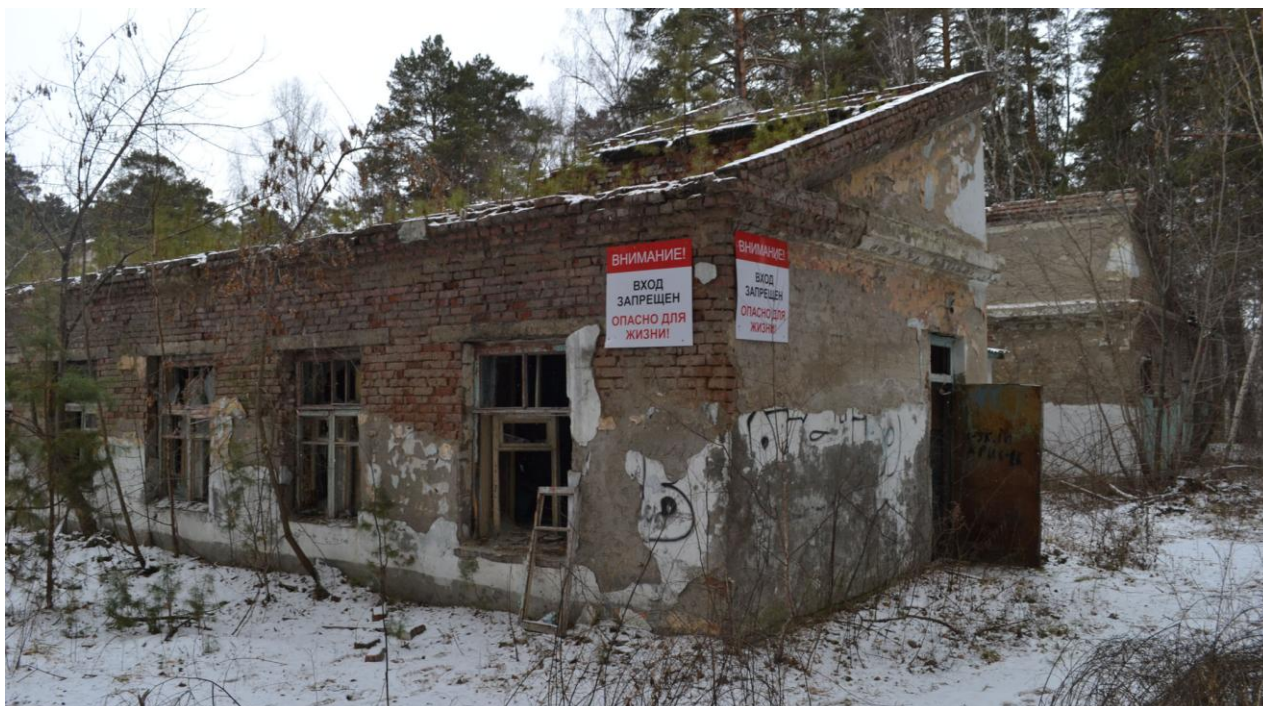
23. Вид и состояние фрагмента северо-восточного и фрагмента северо-западного фасадов. Ноябрь 2024 г.
