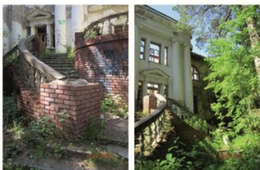
Илл. 76 – Первый корпус санатория «Речкуновский». Лестницы. Фото 2018 г. Источник: архив ГАУ НСО НПЦ
