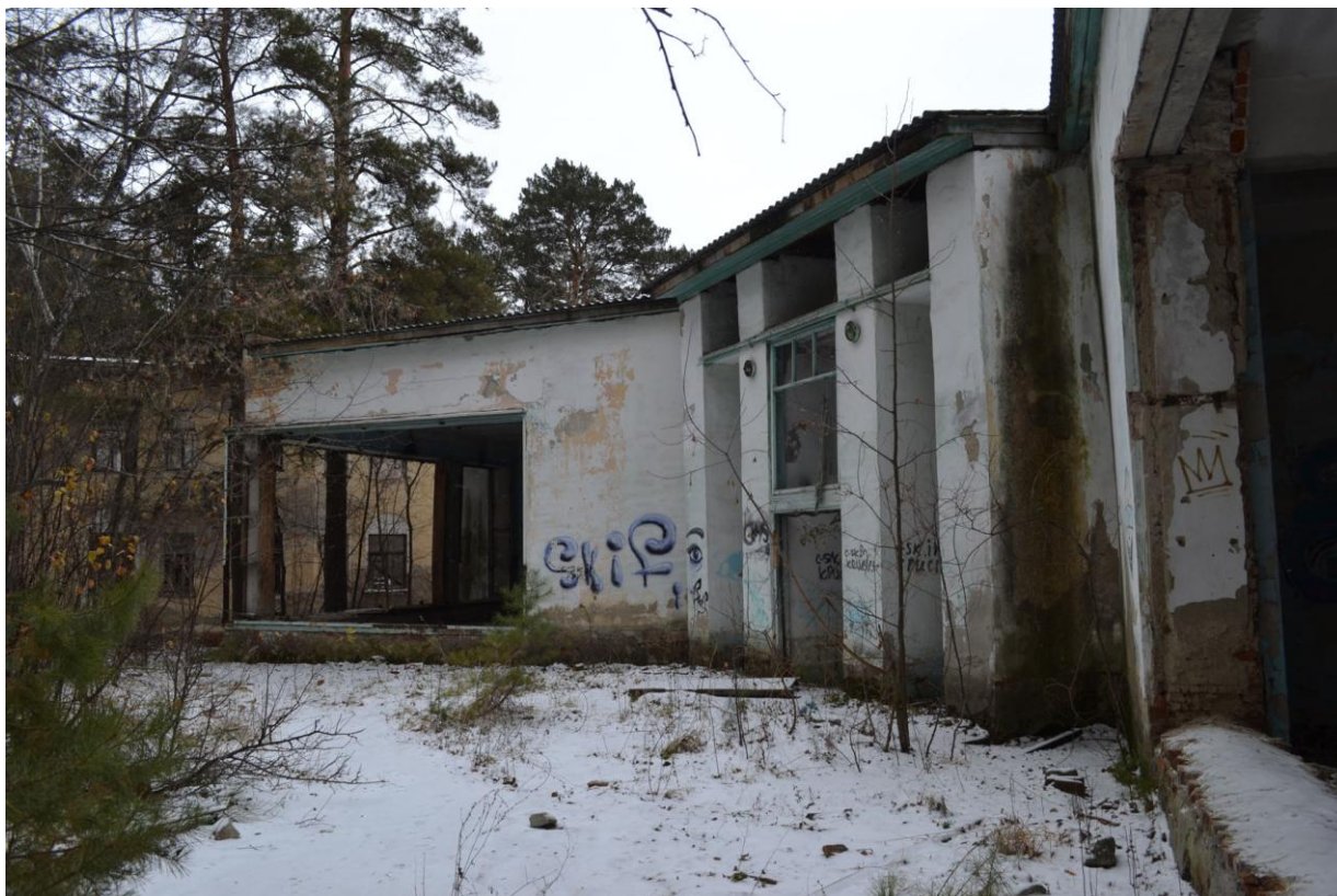
29. Вид и состояние северо-восточного фасада тамбура. Ноябрь 2024 г.
