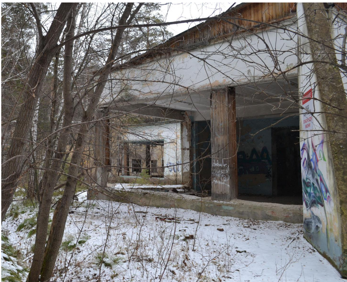
27. Вид и состояние северо-западного фасада тамбура. Ноябрь 2024 г.
