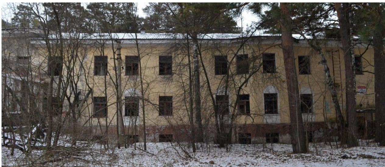
14. Вид и состояние правой части северо-западного фасада основного объёма. Ноябрь 2024 г.
