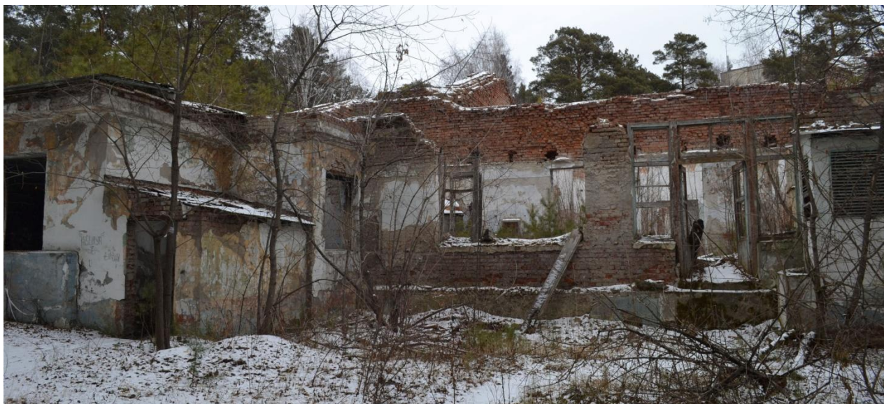
17. Вид и состояние фрагмента юго-западного фасада примыкающего объёма. Ноябрь 2024 г.
