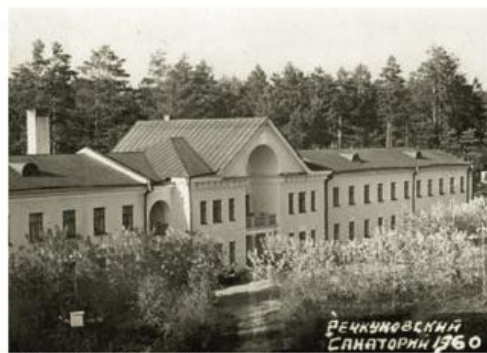
Илл. 33 – Главный корпус Бердского Дома отдыха ЦК союза работников речного транспорта. Источник: муниципальное бюджетное учреждение «Бердский историко-художественный музей»
