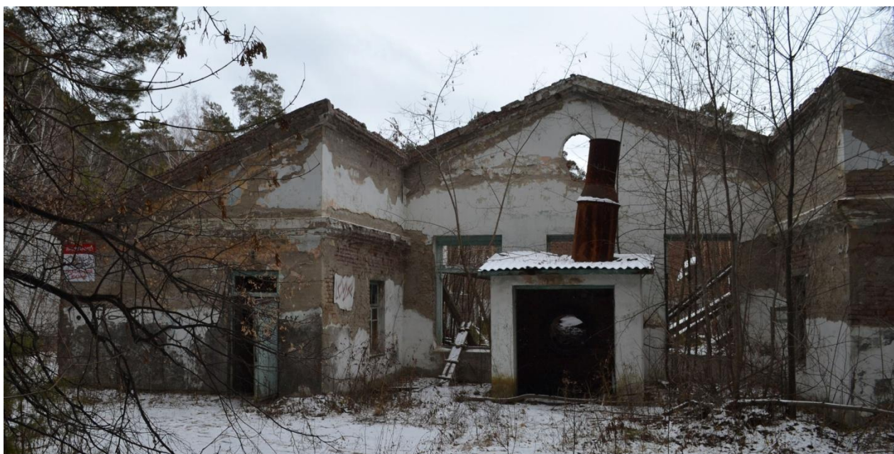
22. Вид и состояние фрагмента северо-западного фасада примыкающего объёма. Ноябрь 2024 г.
