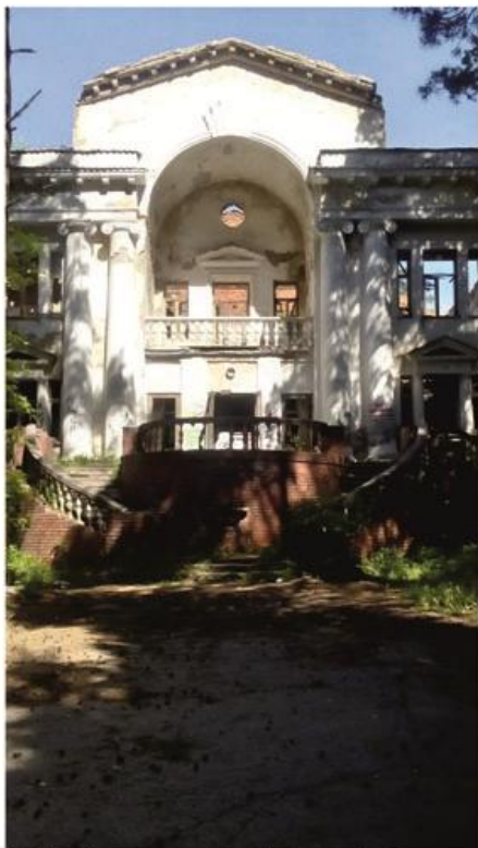
Илл. 67 – Первый корпус санатория «Речкуновский». Фрагмент главного фасада. Фото 2017 г. Источник: архив ГАУ НСО НПЦ
