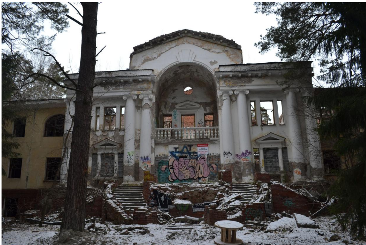
1. Вид и состояние центральной части юго-восточного фасада основного объёма. Ноябрь 2024 г.
