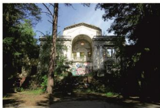
Илл. 89 – Центральная часть главного фасада. Фото Скиданенко Е. Н., 04.07.2024 г. Архив ГАУ НСО НПЦ
