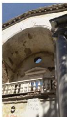
Илл. 69 – Первый корпус санатория «Речкуновский». Фрагмент главного фасада. Фото 2017 г. Источник: архив ГАУ НСО НПЦ
