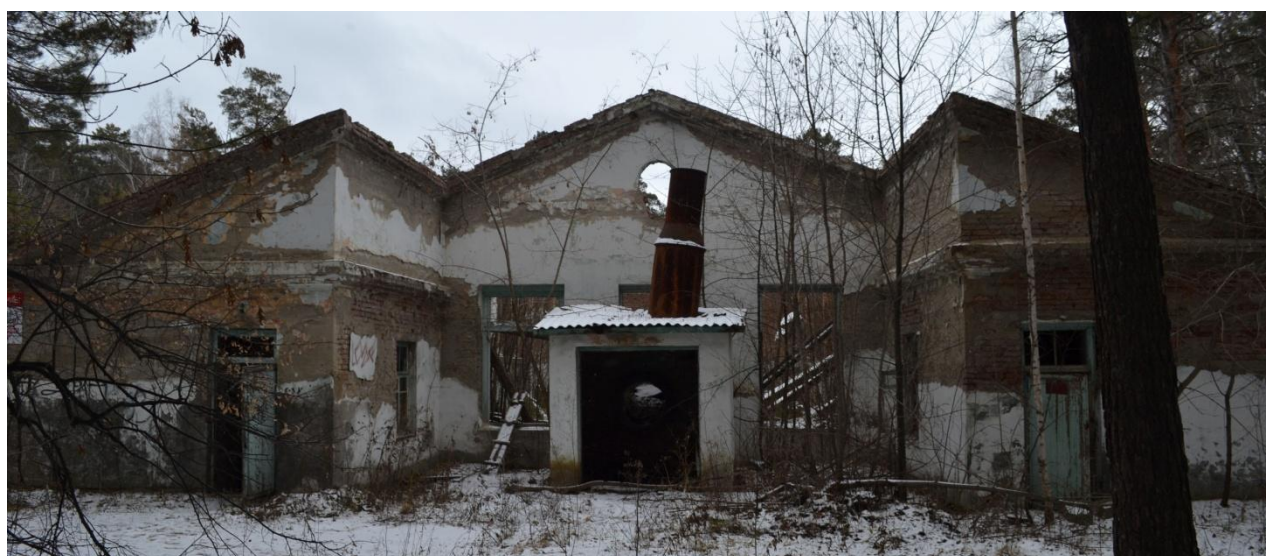
20. Вид и состояние ризалитов северо-западного фасада примыкающего объёма. Ноябрь 2024 г.
