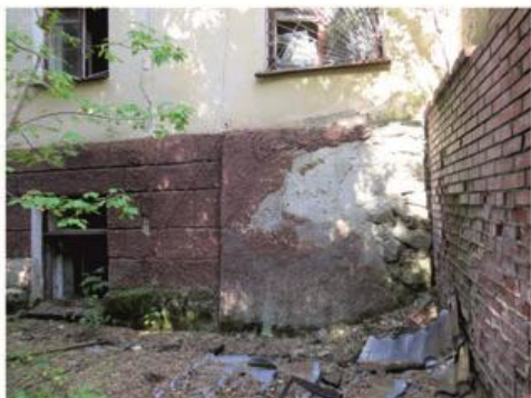
Илл. 59 – Первый корпус санатория «Речкуновский». Фрагмент главного фасада. Фото 2016 г. Источник: архив ГАУ НСО НПЦ
