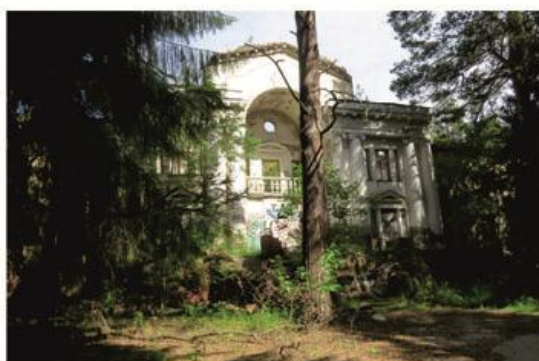
Илл. 90 – Центральная часть главного фасада. Фото Скиданенко Е. Н., 04.07.2024 г. Архив ГАУ НСО НПЦ
