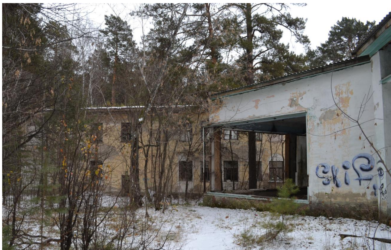
24. Вид и состояние фрагмента северо-восточного и фрагмента северо-западного фасадов. Ноябрь 2024 г.
