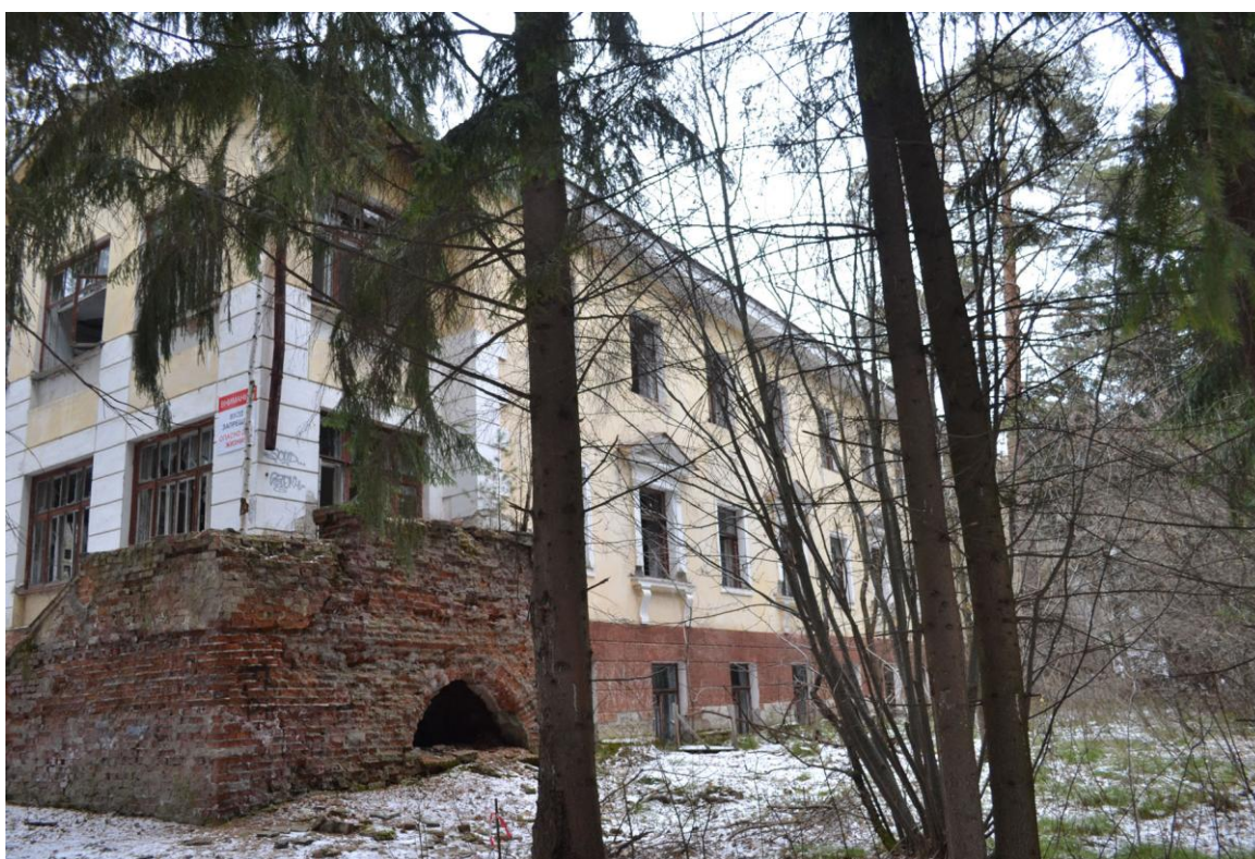
7. Вид и состояние фрагмента юго-западного и юго-восточного фасадов основного объёма. Ноябрь 2024 г.
