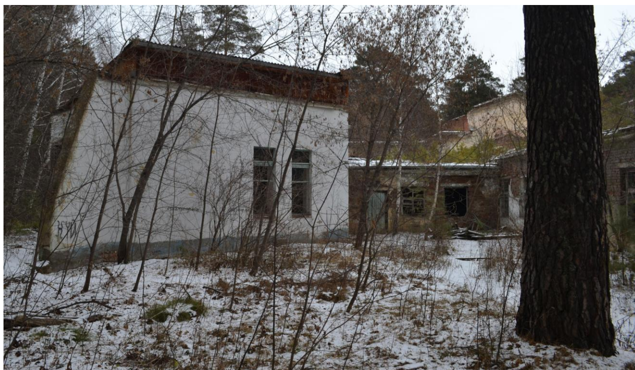
26. Вид и состояние северо-западного фасада тамбура, перехода и фрагмента северо-восточного фасада примыкающего объёма. Ноябрь 2024 г.
