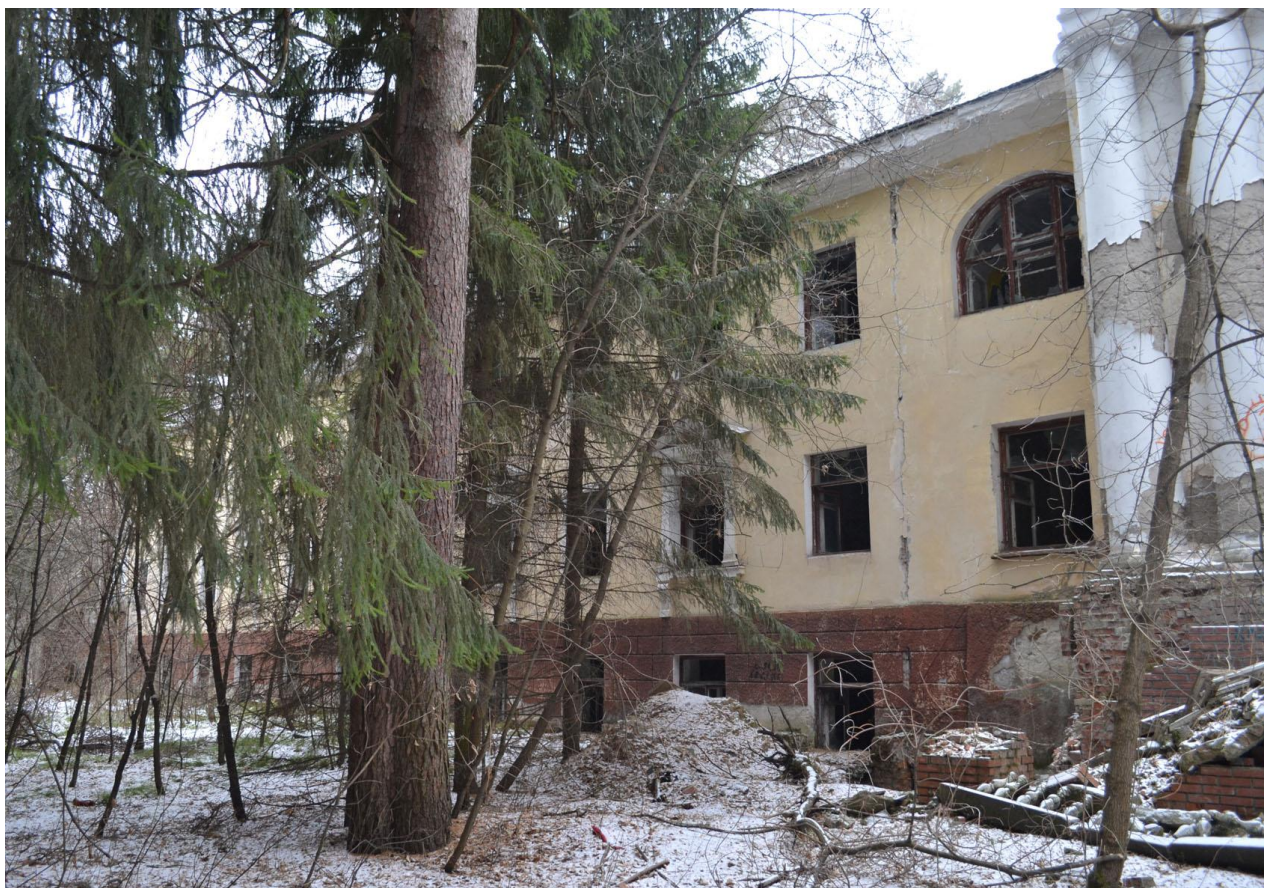
6. Вид и состояние левой части юго-восточного фасада основного объёма. Ноябрь 2024 г.
