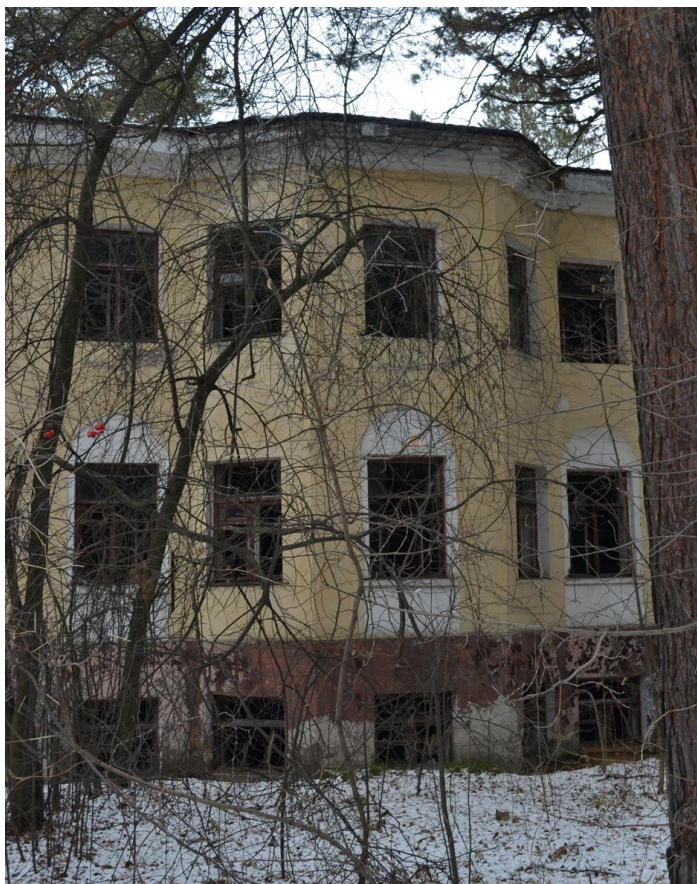
15. Вид и состояние ризалита северо-западного фасада. Ноябрь 2024 г.
