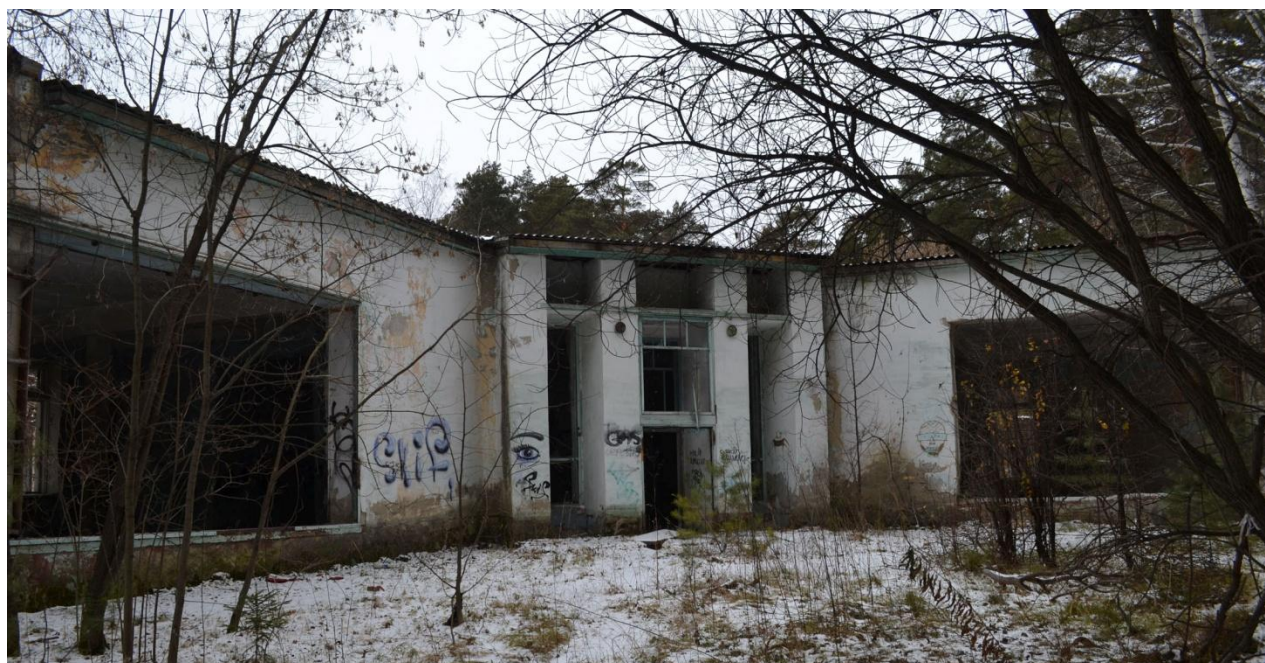
28. Вид и состояние северо-восточного фасада тамбура. Ноябрь 2024г.
