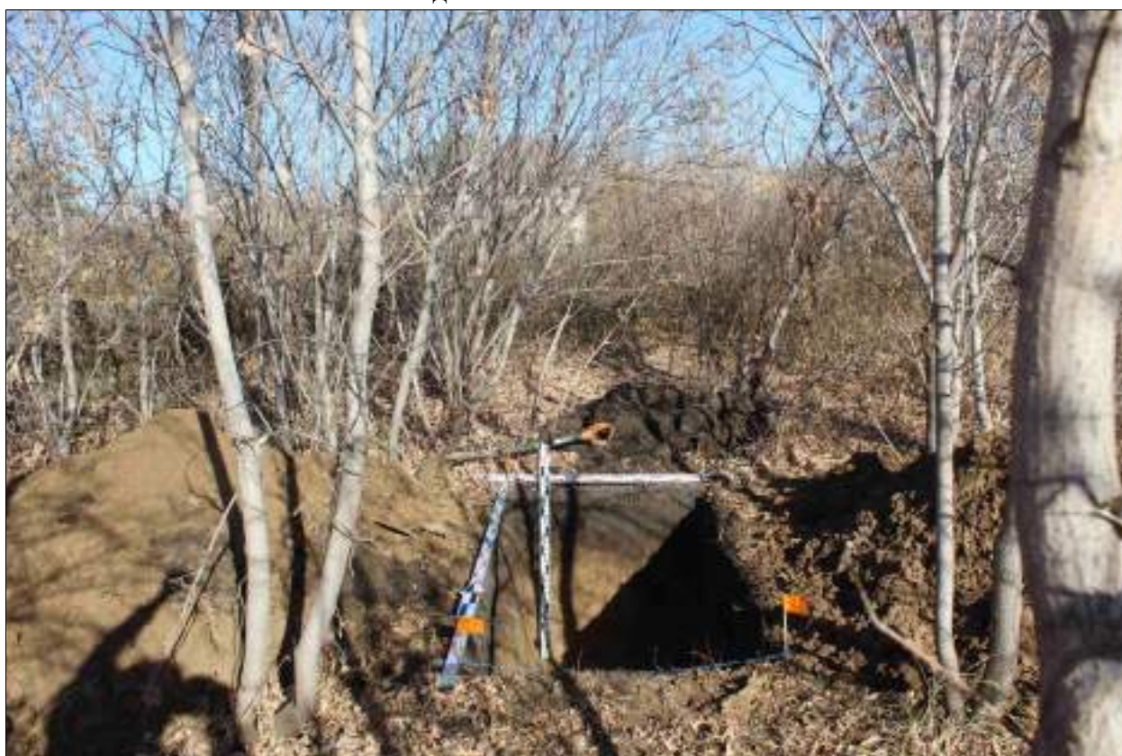
Рисунок 626 – «Распределительный газопровод р.п. Чистоозерное». Шурф №52. Общий вид выполненного шурфа. Снято с Ю.
