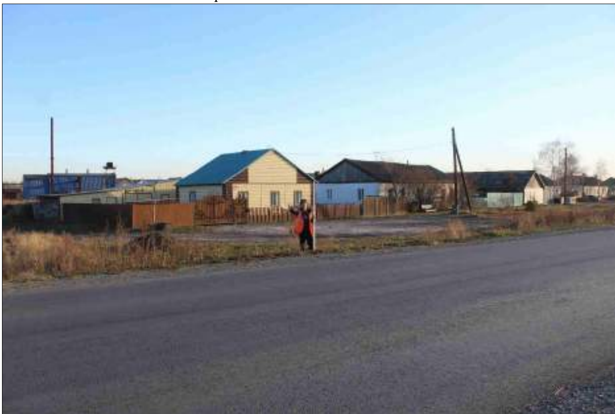
Рисунок 238 – «Распределительный газопровод р.п. Чистоозерное». Вид из точки 64 в направлении точки 65. Снято с СЗ.
