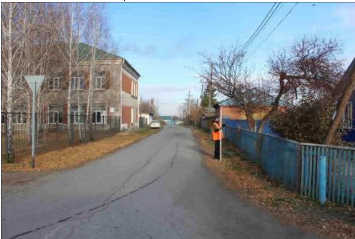
Рисунок 294 – «Распределительный газопровод р.п. Чистоозерное». Вид из точки 28 в направлении точки 26. Снято с ЮЗ.
