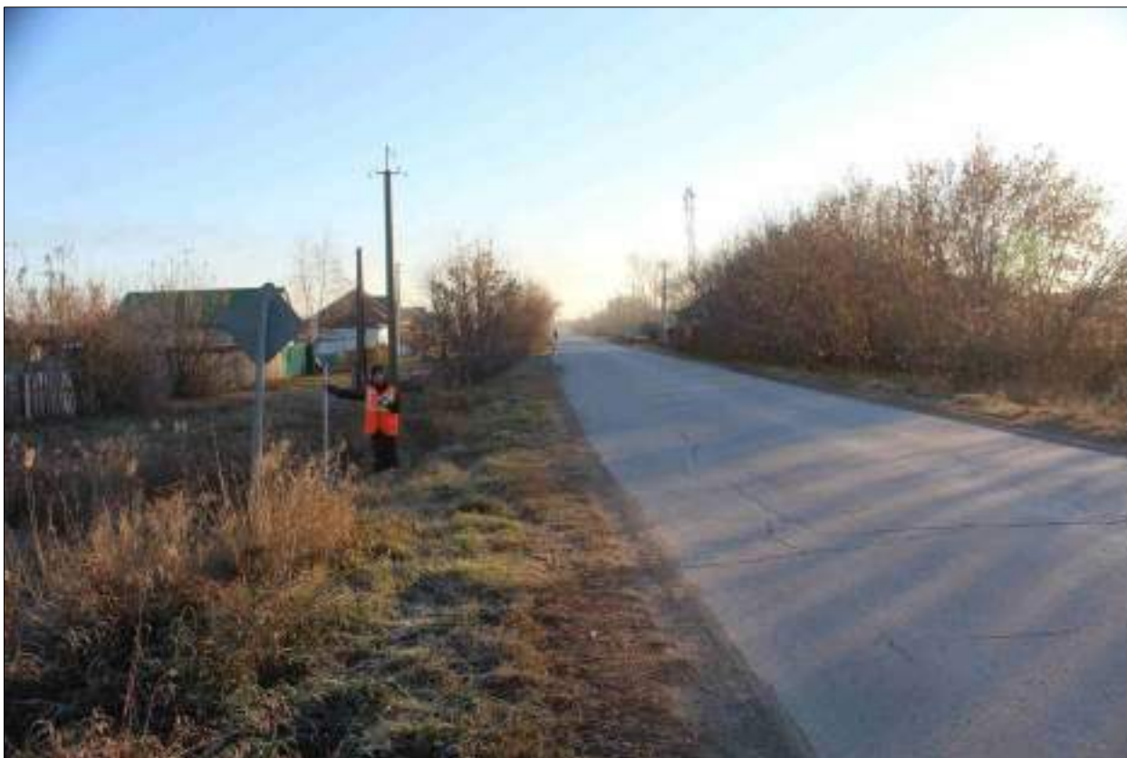
Рисунок 19 – «Распределительный газопровод р.п. Чистоозерное». Вид из точки 183 в направлении точки 149. Снято с 3.
