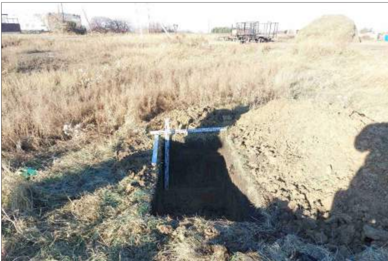
Рисунок 485 – «Распределительный газопровод р.п. Чистоозерное». Шурф №24. Общий вид выполненного шурфа. Снято с Ю.
