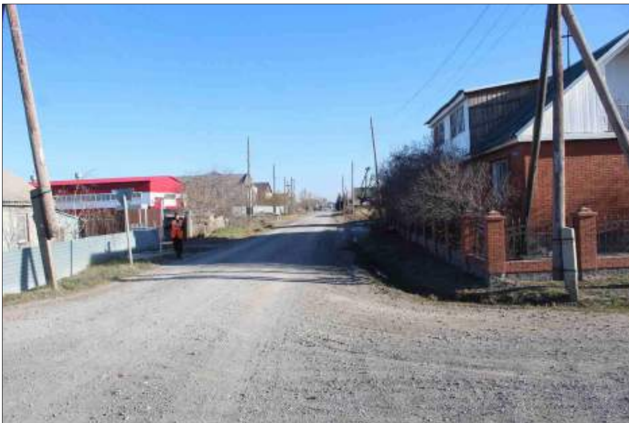
Рисунок 67 – «Распределительный газопровод р.п. Чистоозерное». Вид из точки 154 в направлении точки 153. Снято с ЮЗ.
