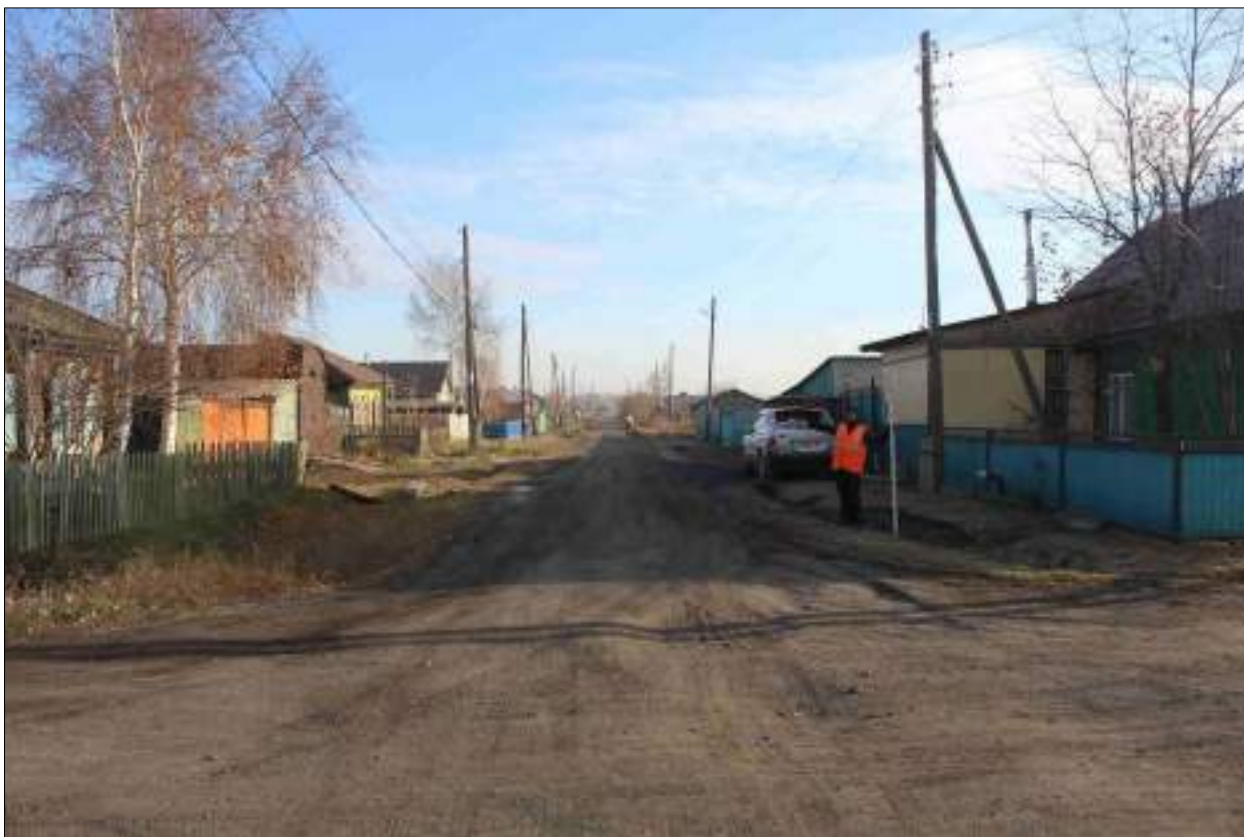
Рисунок 291 – «Распределительный газопровод р.п. Чистоозерное». Вид из точки 35 в направлении точки 30. Снято с ЮЗ.
