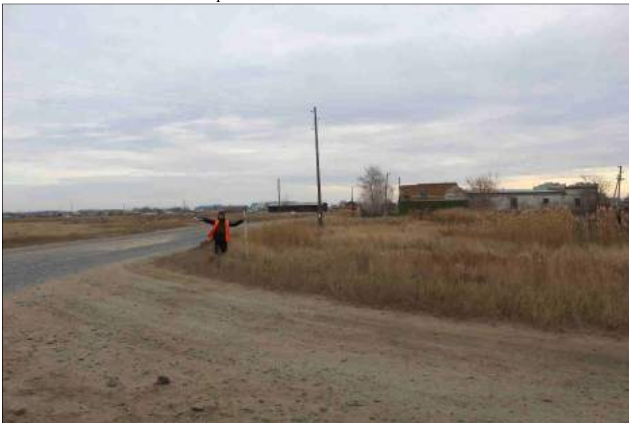
Рисунок 360 – «Распределительный газопровод р.п. Чистоозерное». Вид из точки 11 в направлении точки 10. Снято с СЗ.
