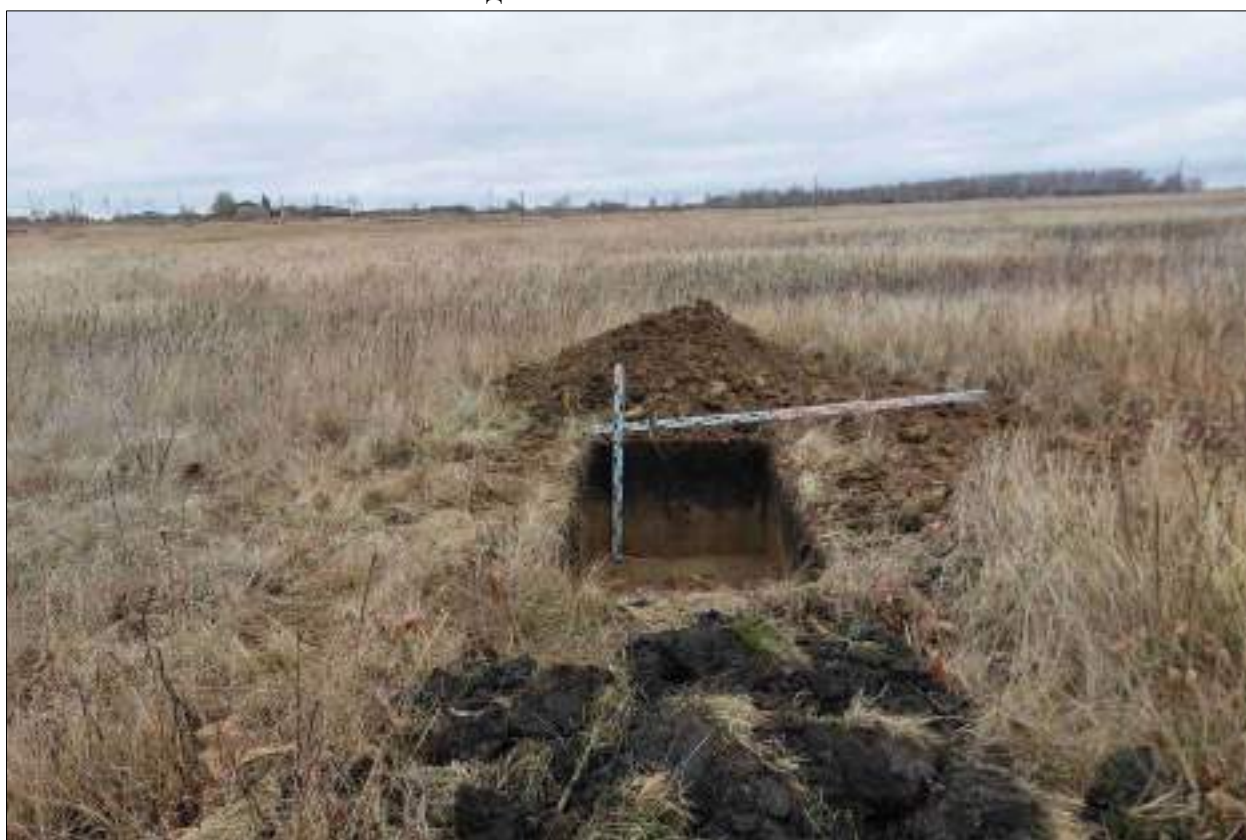
Рисунок 392 – «Распределительный газопровод р.п. Чистоозерное». Шурф №6. Общий вид выполненного шурфа. Снято с С.
