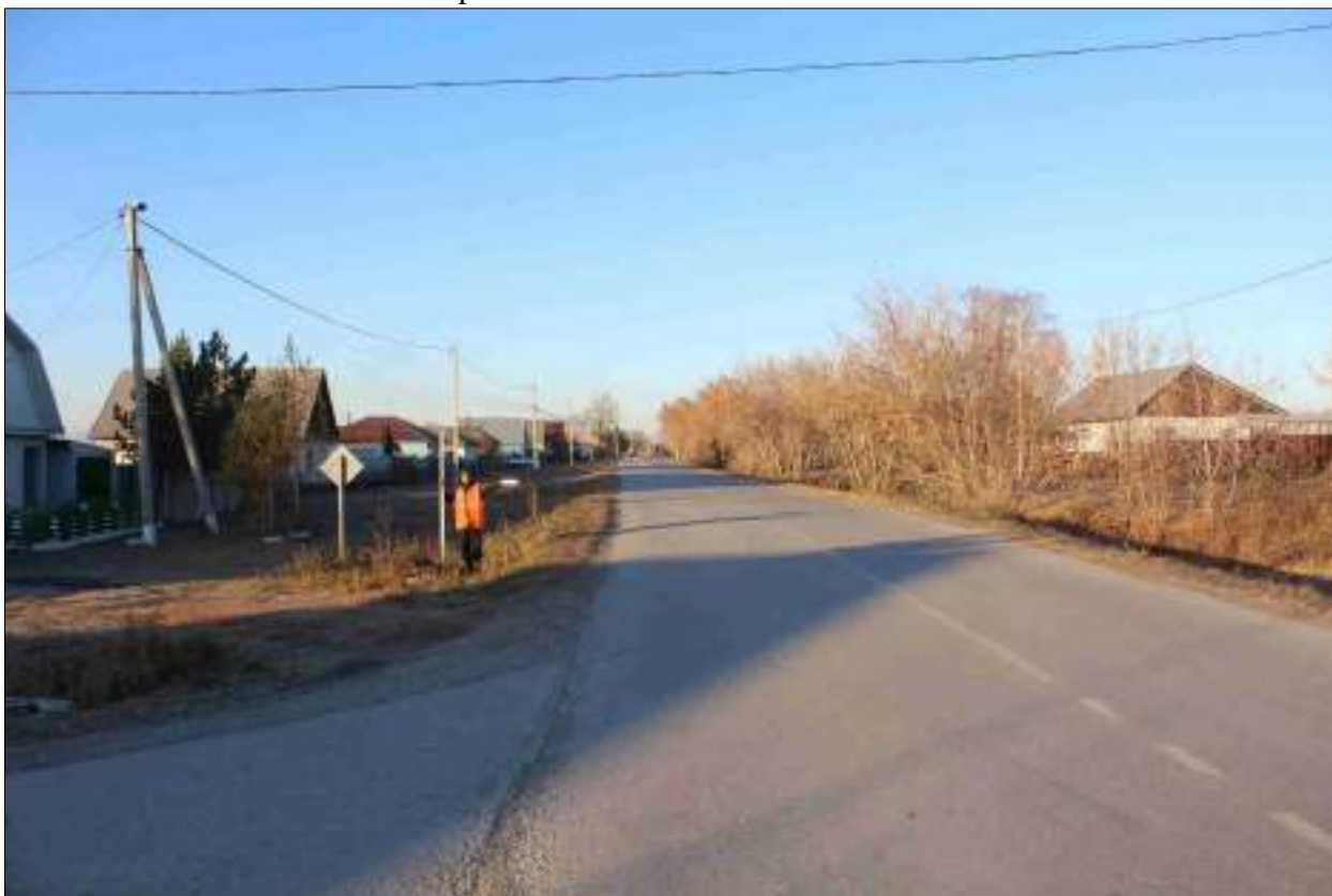
Рисунок 14 – «Распределительный газопровод р.п. Чистоозерное». Вид из точки 182 в направлении точки 175. Снято с В.
