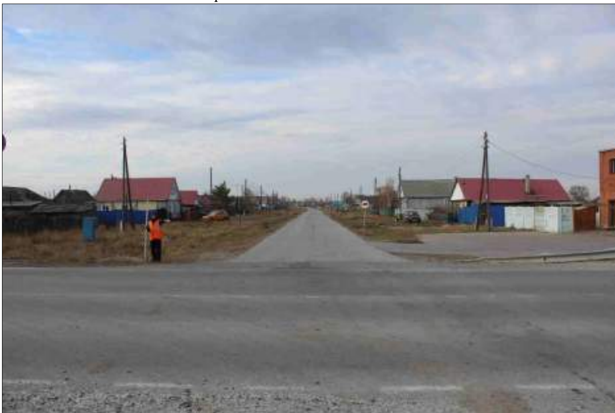
Рисунок 310 – «Распределительный газопровод р.п. Чистоозерное». Вид из точки 3 в направлении точки 25. Снято с СВ.
