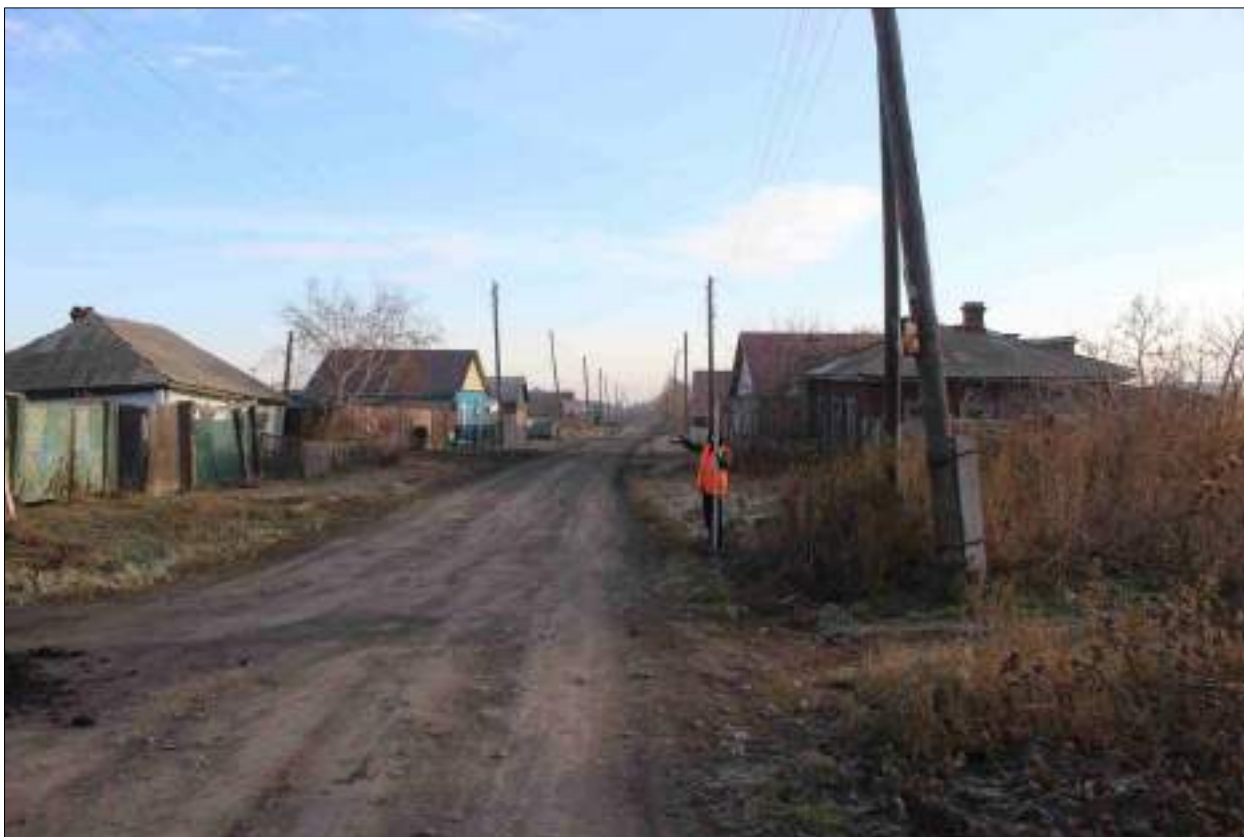
Рисунок 267 – «Распределительный газопровод р.п. Чистоозерное». Вид из точки 33 в направлении точки 32. Снято с ЮЗ.
