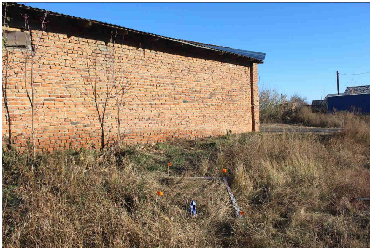
Рисунок 574 – «Распределительный газопровод р.п. Чистоозерное». Шурф №42. Общий вид. Разбивка. Снято с Ю.
