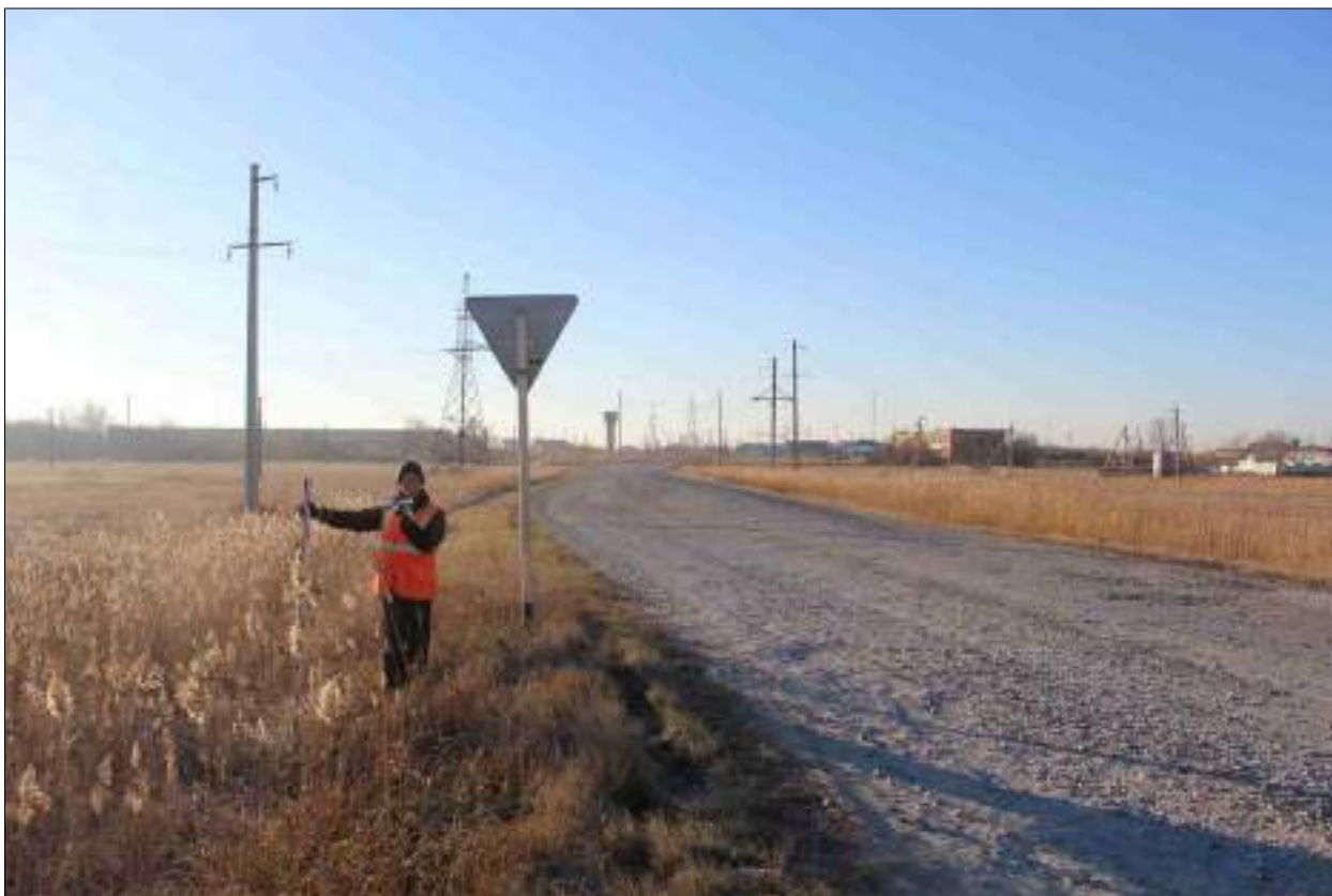
Рисунок 29 – «Распределительный газопровод р.п. Чистоозерное». Вид из точки 189 в направлении точки 188. Снято с З.
