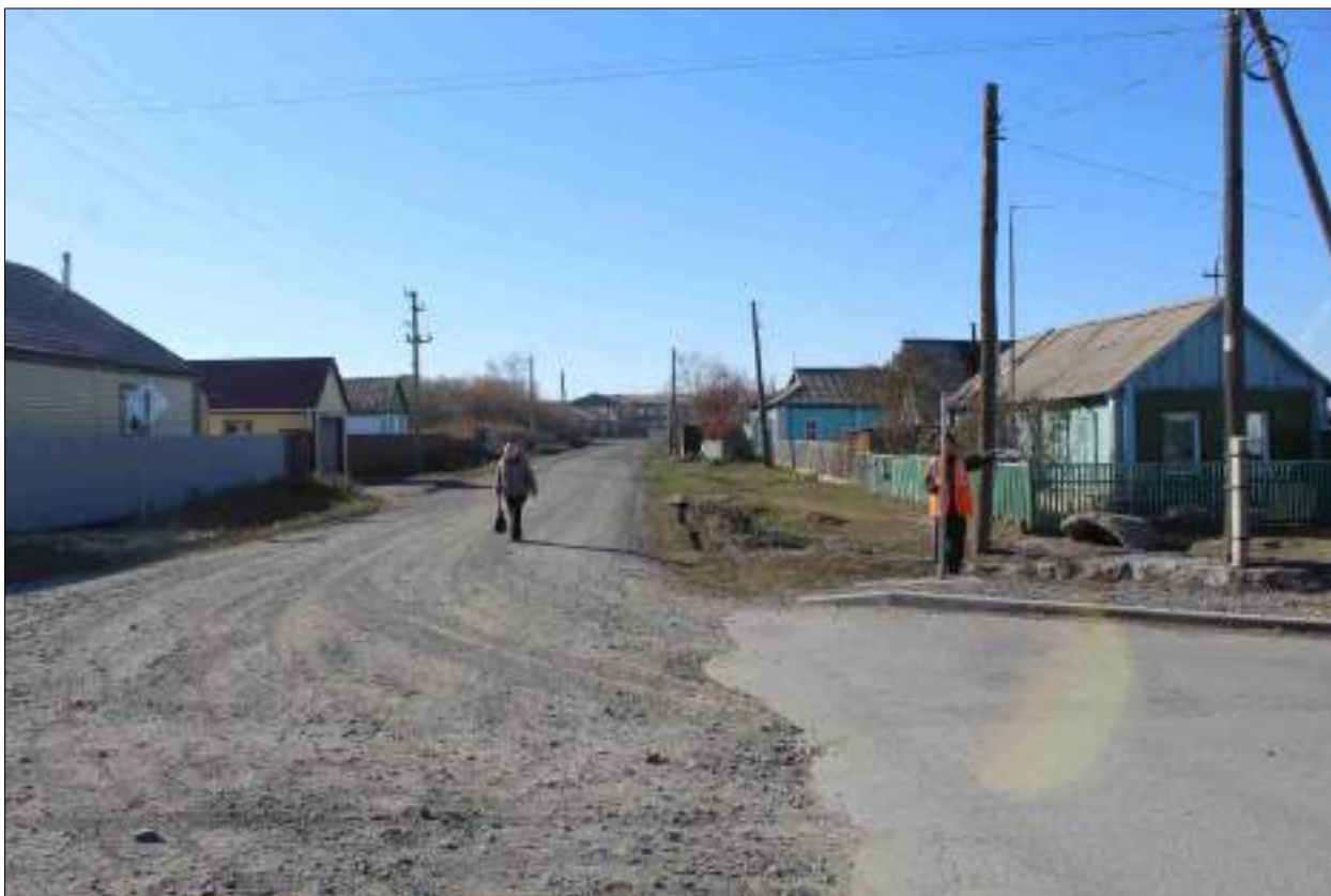
Рисунок 119 – «Распределительный газопровод р.п. Чистоозерное». Вид из точки 120 в направлении точки 121. Снято с СВ.
