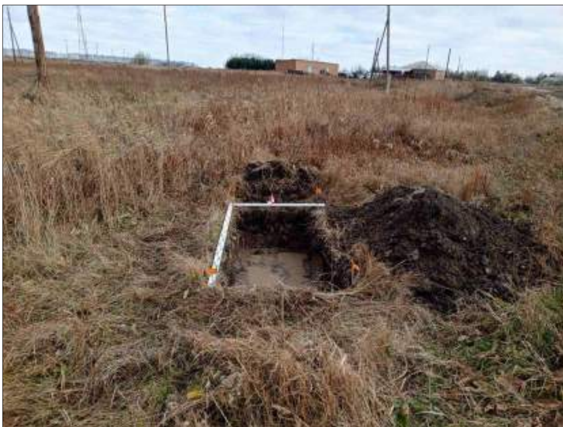
Рисунок 467 – «Распределительный газопровод р.п. Чистоозерное». Шурф №21. Общий вид выполненного шурфа. Снято с Ю.
