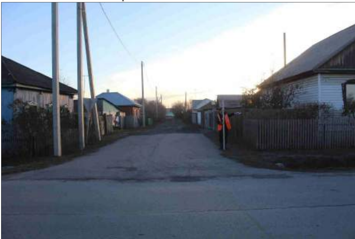
Рисунок 252 – «Распределительный газопровод р.п. Чистоозерное». Вид из точки 42 в направлении точки 43. Снято с СВ.
