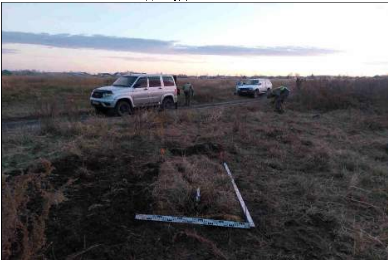
Рисунок 594 – «Распределительный газопровод р.п. Чистоозерное». Шурф №45. Рекультивация. Снято с С.
