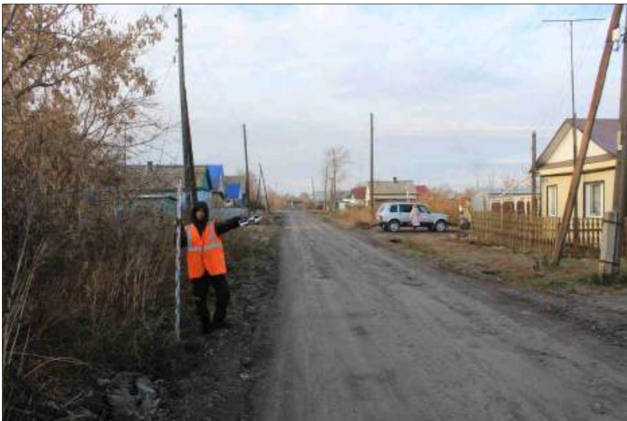
Рисунок 265 – «Распределительный газопровод р.п. Чистоозерное». Вид из точки 33 в направлении точки 40. Снято с СВ.
