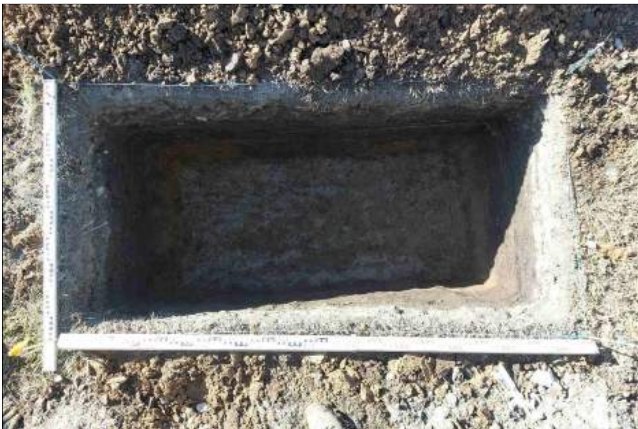
Рисунок 633 – «Распределительный газопровод р.п. Чистоозерное». Шурф №53. Дно шурфа. Снято с СВ.
