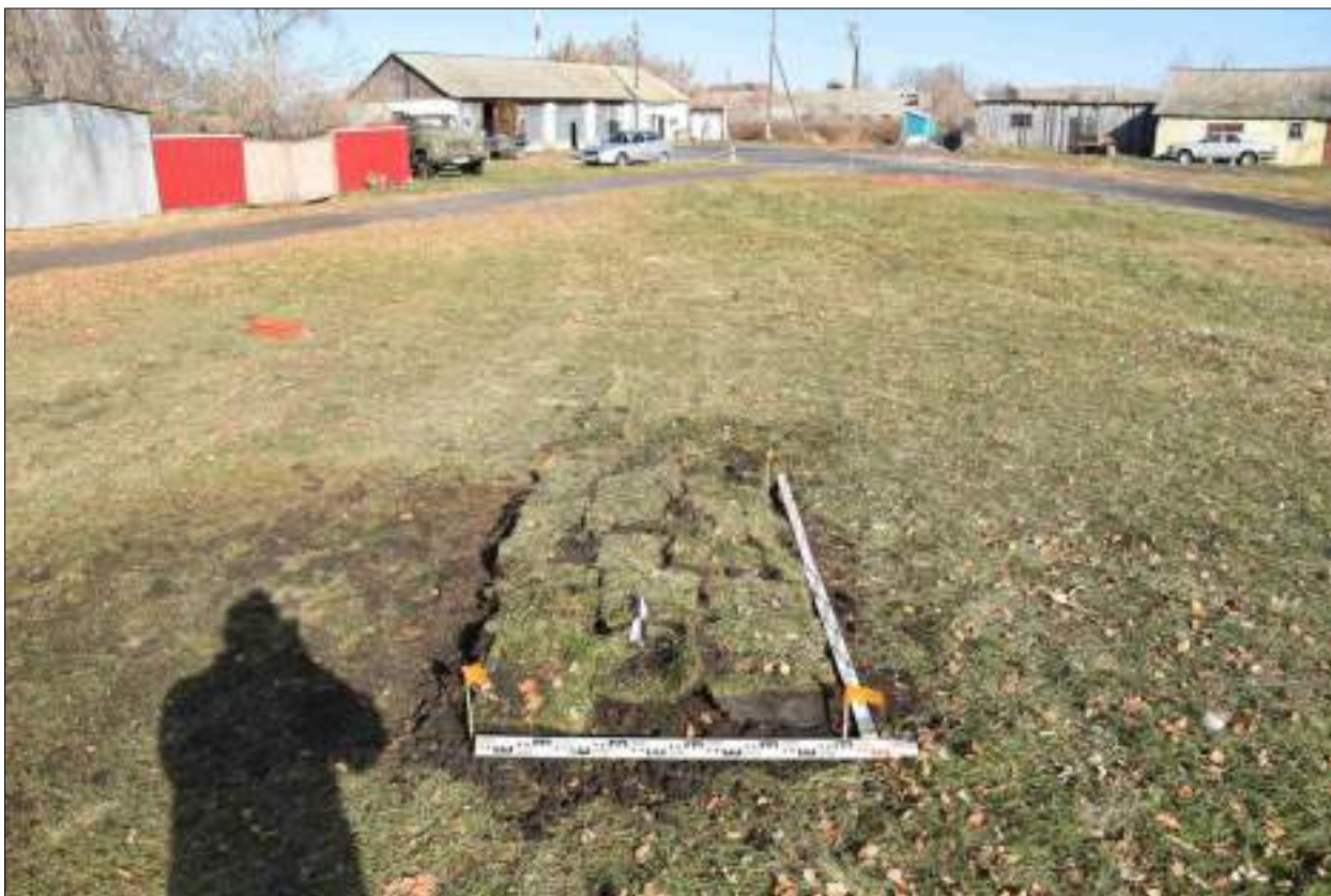
Рисунок 553 – «Распределительный газопровод р.п. Чистоозерное». Шурф №37. Рекультивация. Снято с Ю.
