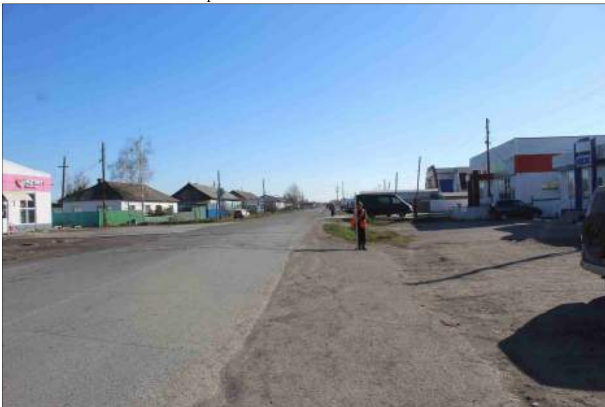
Рисунок 104 – «Распределительный газопровод р.п. Чистоозерное». Вид из точки 133 в направлении точки 130. Снято с СЗ.
