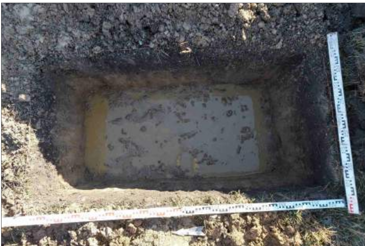
Рисунок 497 – «Распределительный газопровод р.п. Чистоозерное». Шурф №26. Дно шурфа. Снято с З.
