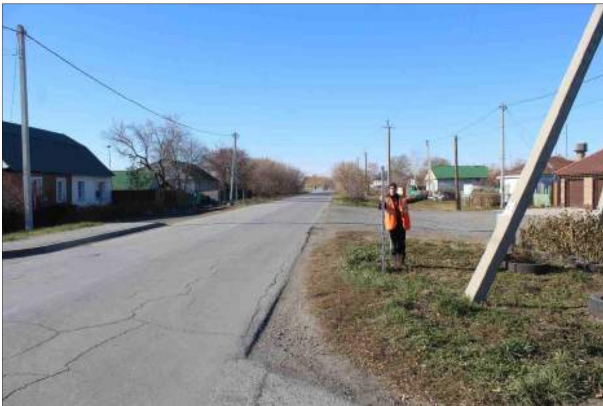
Рисунок 95 – «Распределительный газопровод р.п. Чистоозерное». Вид из точки 149 в направлении точки 183. Снято с В.
