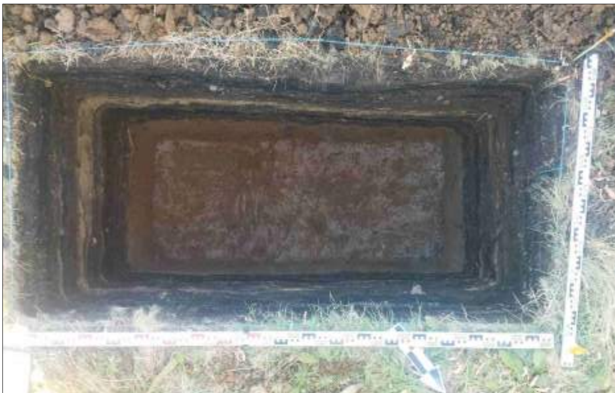
Рисунок 608 – «Распределительный газопровод р.п. Чистоозерное». Шурф №48. Дно шурфа. Снято с СВ.
