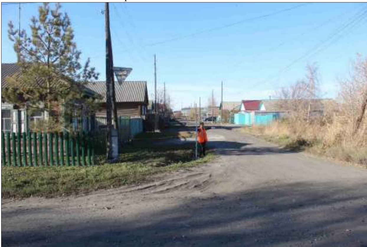
Рисунок 172 – «Распределительный газопровод р.п. Чистоозерное». Вид из точки 118 в направлении точки 128. Снято с ЮВ.
