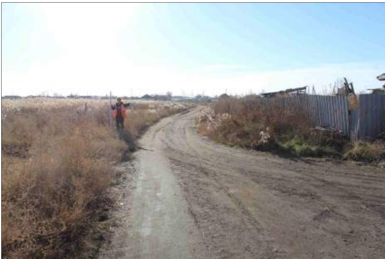
Рисунок 191 – «Распределительный газопровод р.п. Чистоозерное». Вид из точки 91 в направлении точки 92. Снято с СВ.
