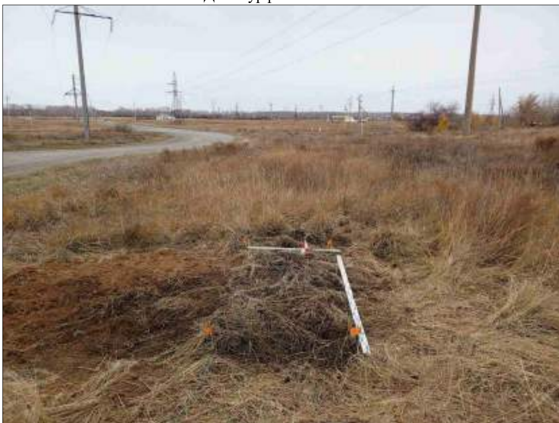
Рисунок 370 – «Распределительный газопровод р.п. Чистоозерное». Шурф №1. Рекультивация. Снято с Ю.
