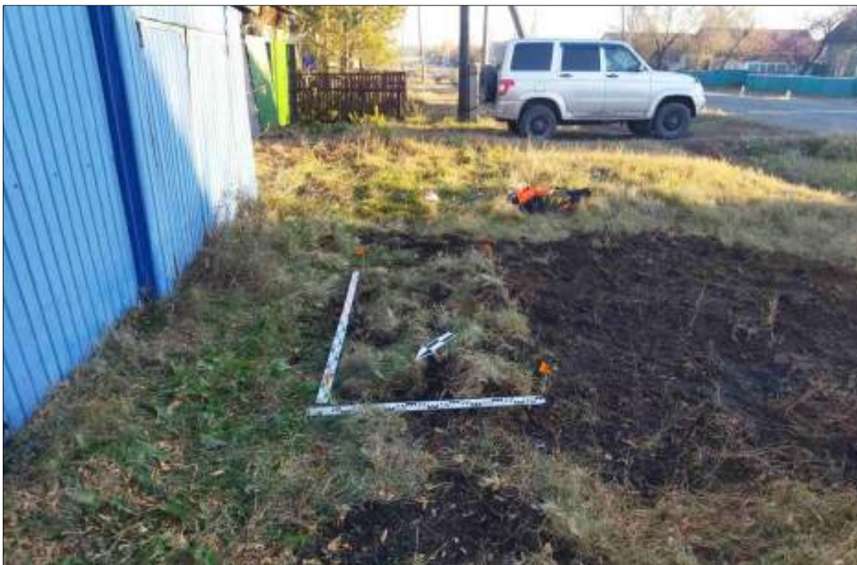
Рисунок 609 – «Распределительный газопровод р.п. Чистоозерное». Шурф №48. Рекультивация. Снято с СЗ.
