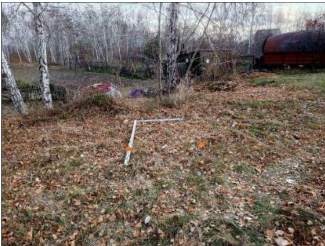
Рисунок 431 – «Распределительный газопровод р.п. Чистоозерное». Шурф №14. Общий вид. Разбивка. Снято с Ю.
