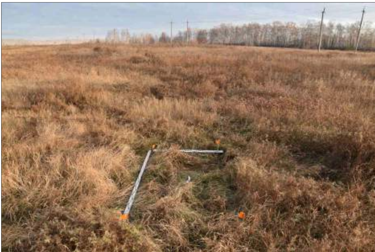
Рисунок 595 – «Распределительный газопровод р.п. Чистоозерное». Шурф №46. Общий вид. Разбивка. Снято с Ю.
