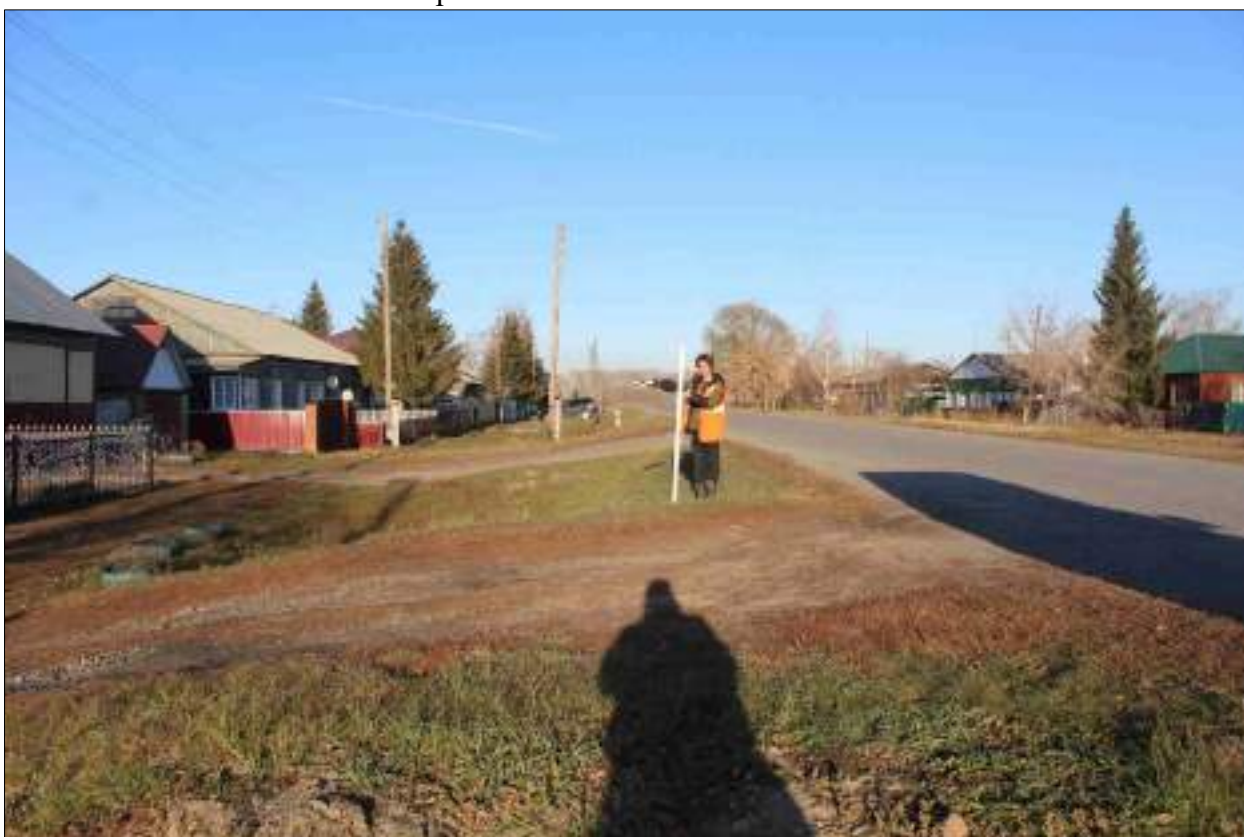
Рисунок 226 – «Распределительный газопровод р.п. Чистоозерное». Вид из точки 73 в направлении точки 78. Снято с ЮЗ.
