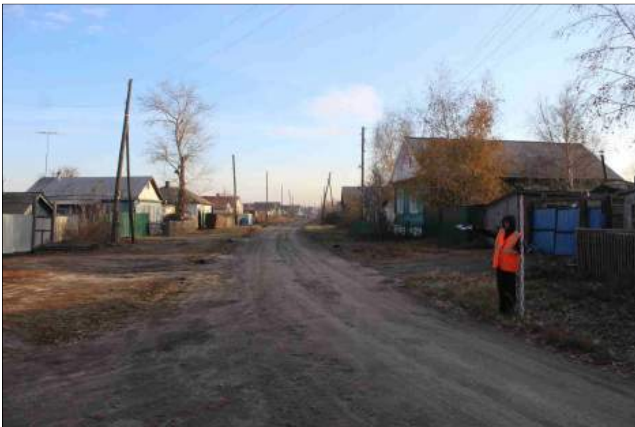
Рисунок 263 – «Распределительный газопровод р.п. Чистоозерное». Вид из точки 40 в направлении точки 33. Снято с ЮЗ.
