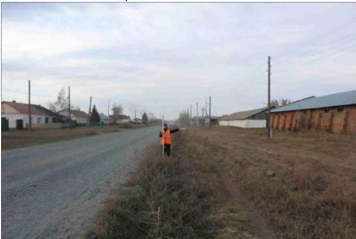
Рисунок 314 – «Распределительный газопровод р.п. Чистоозерное». Вид из Шурфа №42 в направлении точки 3. Снято с СВ.
