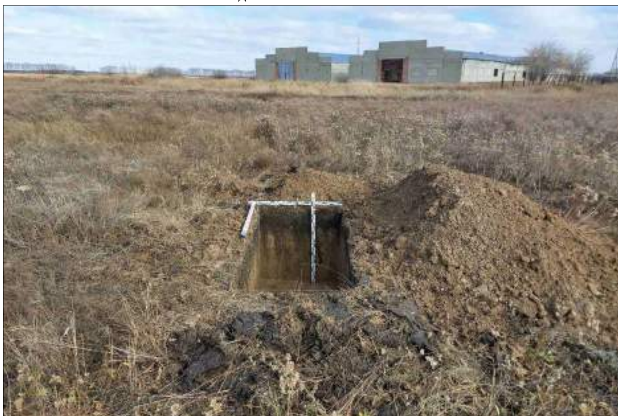
Рисунок 462 – «Распределительный газопровод р.п. Чистоозерное». Шурф №20. Общий вид выполненного шурфа. Снято с Ю.
