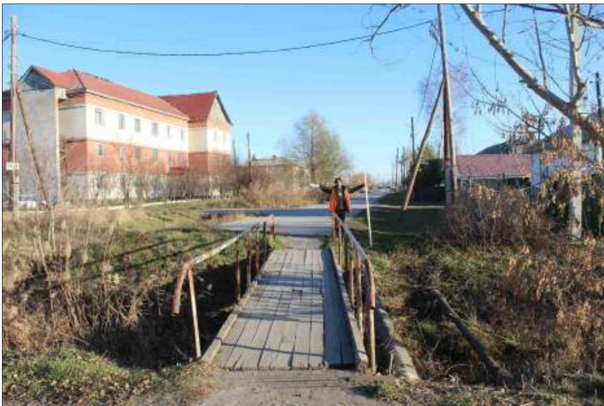
Рисунок 223 – «Распределительный газопровод р.п. Чистоозерное». Вид из точки 67 в направлении точки 196. Снято с СЗ.
