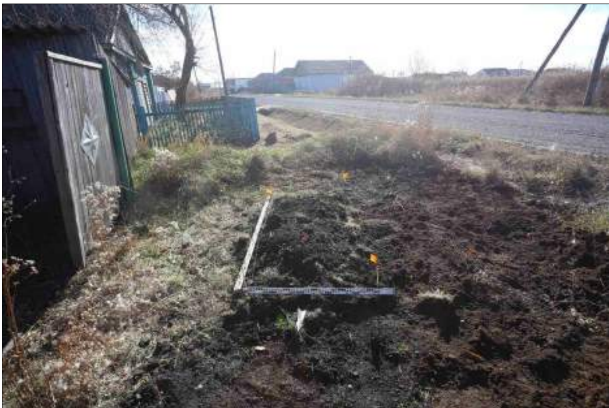
Рисунок 619 – «Распределительный газопровод р.п. Чистоозерное». Шурф №50. Рекультивация. Снято с С.
