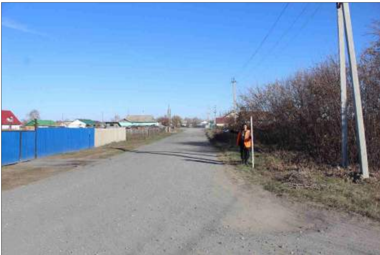
Рисунок 143 – «Распределительный газопровод р.п. Чистоозерное». Вид из точки 121 в направлении точки 120. Снято с ЮЗ.
