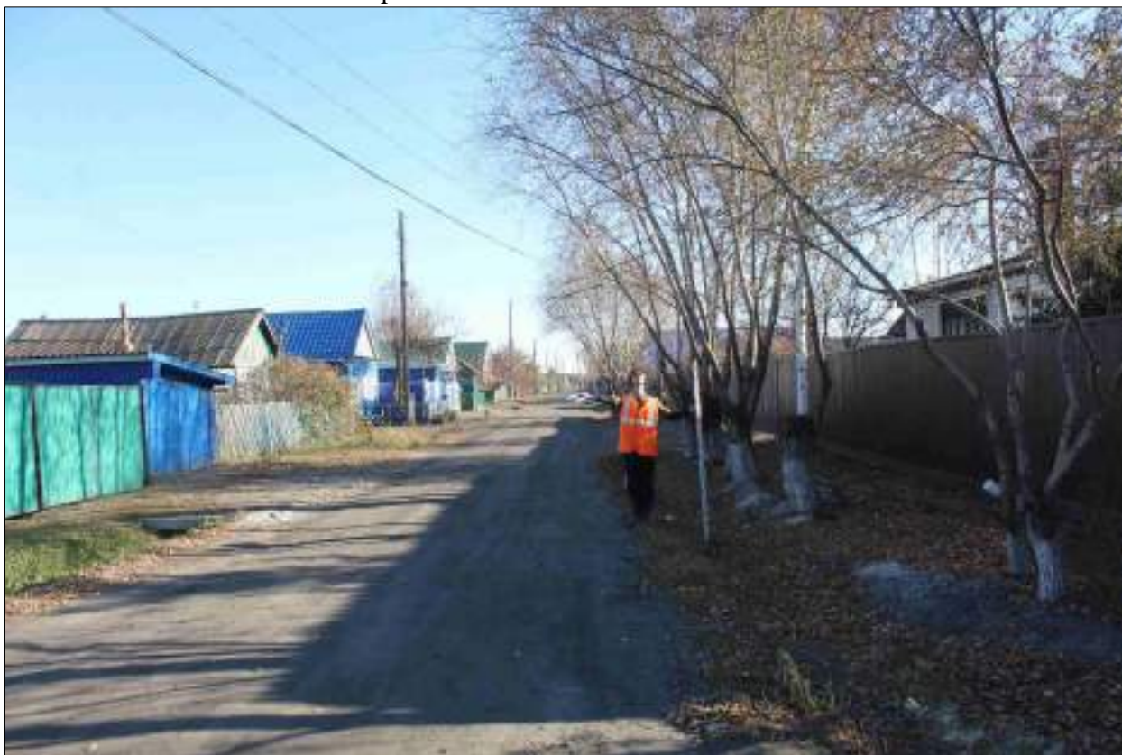
Рисунок 174 – «Распределительный газопровод р.п. Чистоозерное». Вид из точки 118 в направлении точки 113. Снято с СЗ.
