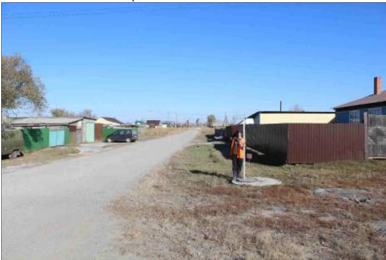
Рисунок 156 – «Распределительный газопровод р.п. Чистоозерное». Вид из точки 95 в направлении точки 94. Снято с ЮЗ.
