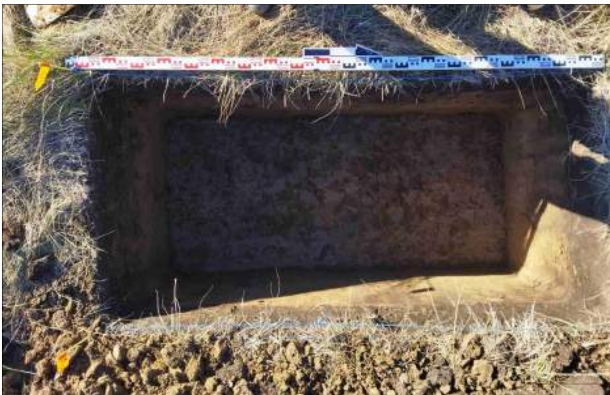
Рисунок 512 – «Распределительный газопровод р.п. Чистоозерное». Шурф №29. Дно шурфа. Снято с В.
