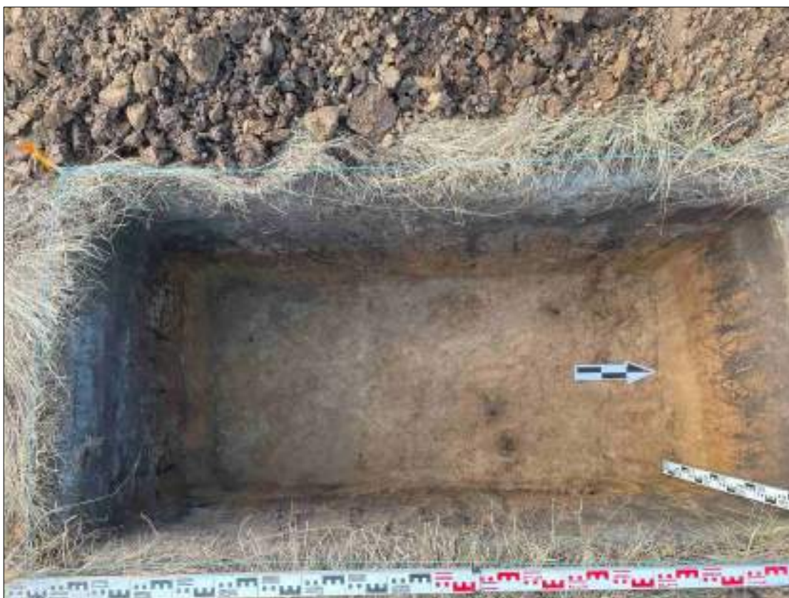
Рисунок 603 – «Распределительный газопровод р.п. Чистоозерное». Шурф №47. Дно шурфа. Снято с В.
