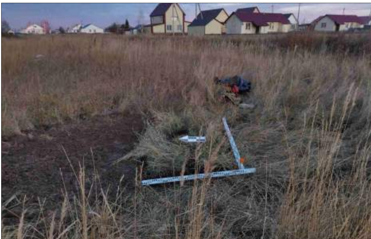
Рисунок 589 – «Распределительный газопровод р.п. Чистоозерное». Шурф №44. Рекультивация. Снято с З.
