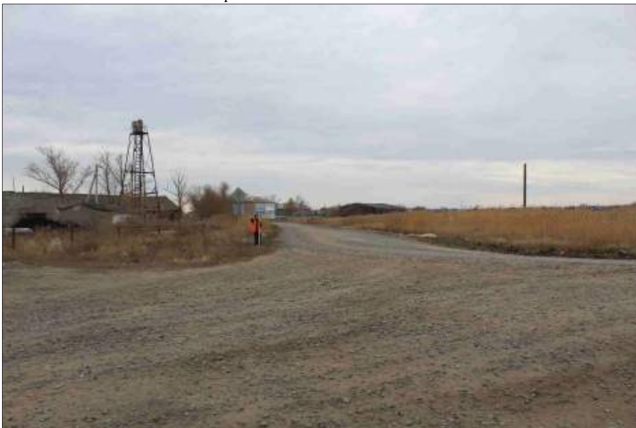
Рисунок 358 – «Распределительный газопровод р.п. Чистоозерное». Вид из точки 10 в направлении точки 14. Снято с С.
