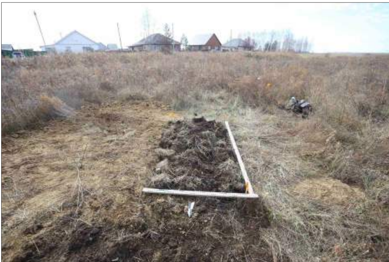
Рисунок 445 – «Распределительный газопровод р.п. Чистоозерное». Шурф №16. Рекультивация. Снято с С.
