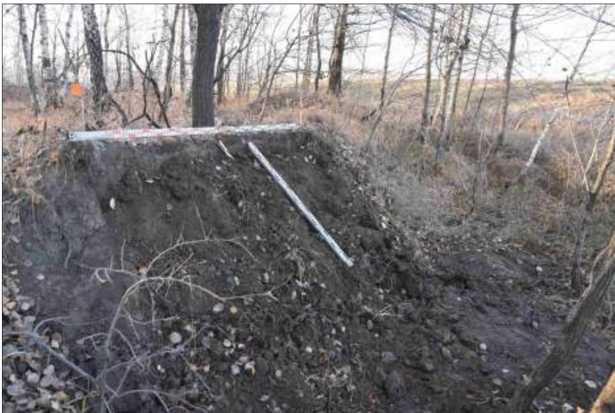
Рисунок 664 – «Распределительный газопровод р.п. Чистоозерное». Зачистка №1. Рекультивация. Снято с СВ.
