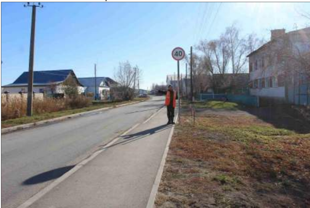
Рисунок 100 – «Распределительный газопровод р.п. Чистозерное». Вид из точки 152 в направлении точки 153. Снято с СЗ.
