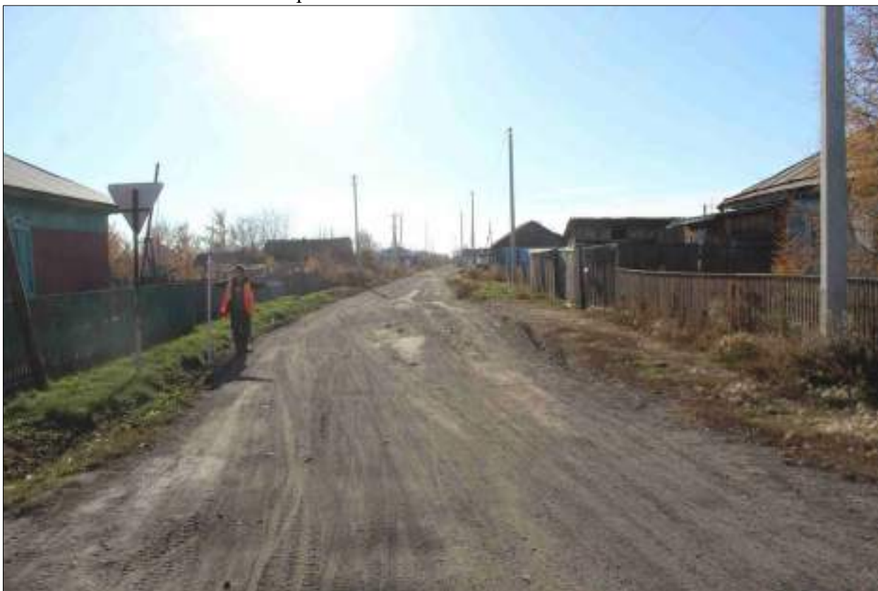
Рисунок 184 – «Распределительный газопровод р.п. Чистоозерное». Вид из точки 114 в направлении точки 113. Снято с СВ.
