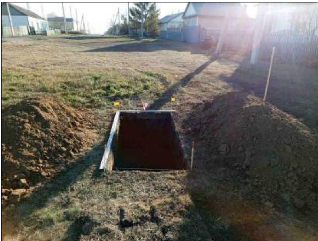
Рисунок 417 – «Распределительный газопровод р.п. Чистоозерное». Шурф №11. Общий вид выполненного шурфа. Снято с С.
