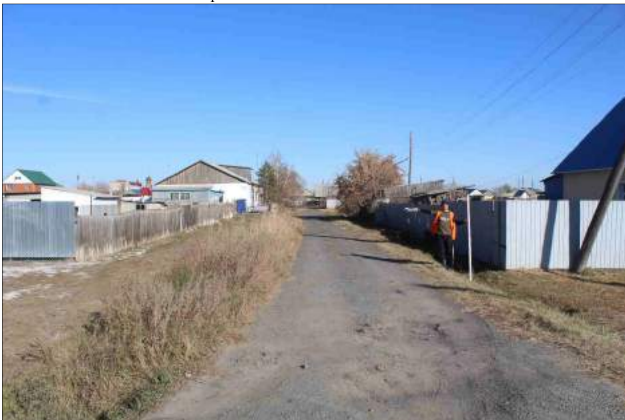
Рисунок 146 – «Распределительный газопровод р.п. Чистоозерное». Вид из точки 122 в направлении точки 123. Снято с ЮЗ.
