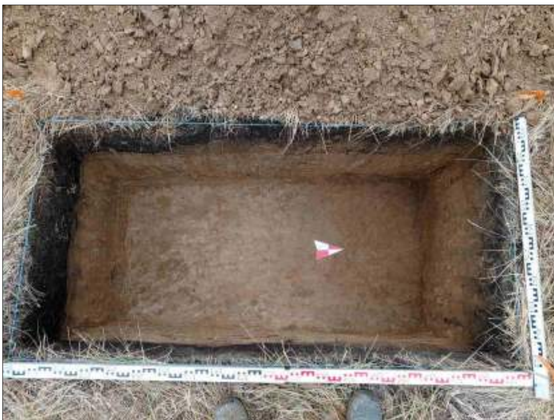
Рисунок 369 – «Распределительный газопровод р.п. Чистоозерное». Шурф №1. Дно шурфа. Снято с В.
