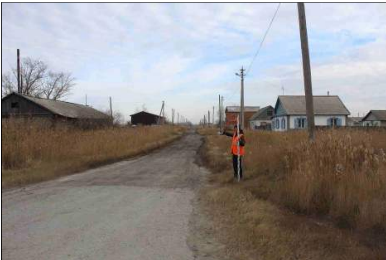
Рисунок 335 – «Распределительный газопровод р.п. Чистоозерное». Вид из точки 14 в направлении точки 15. Снято с ЮЗ.
