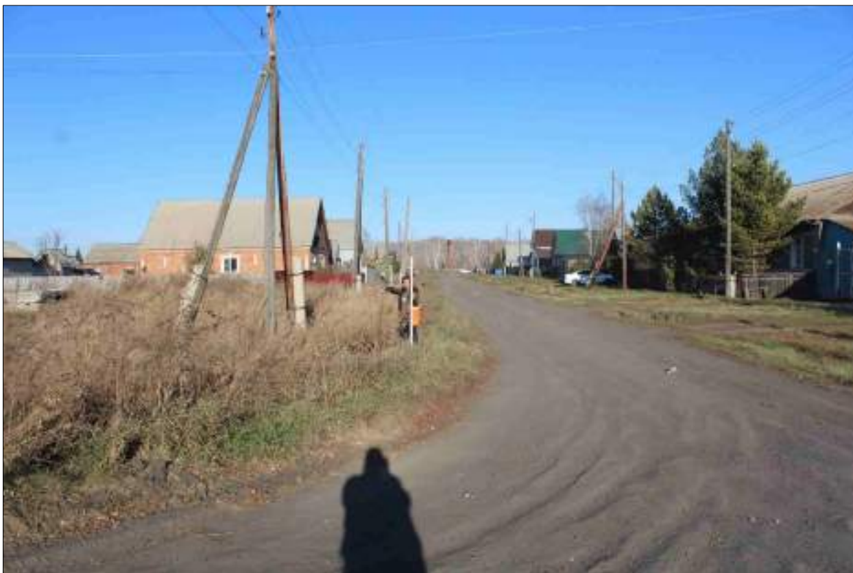
Рисунок 205 – «Распределительный газопровод р.п. Чистоозерное». Вид из точки 81 в направлении точки 80. Снято с ЮЗ.
