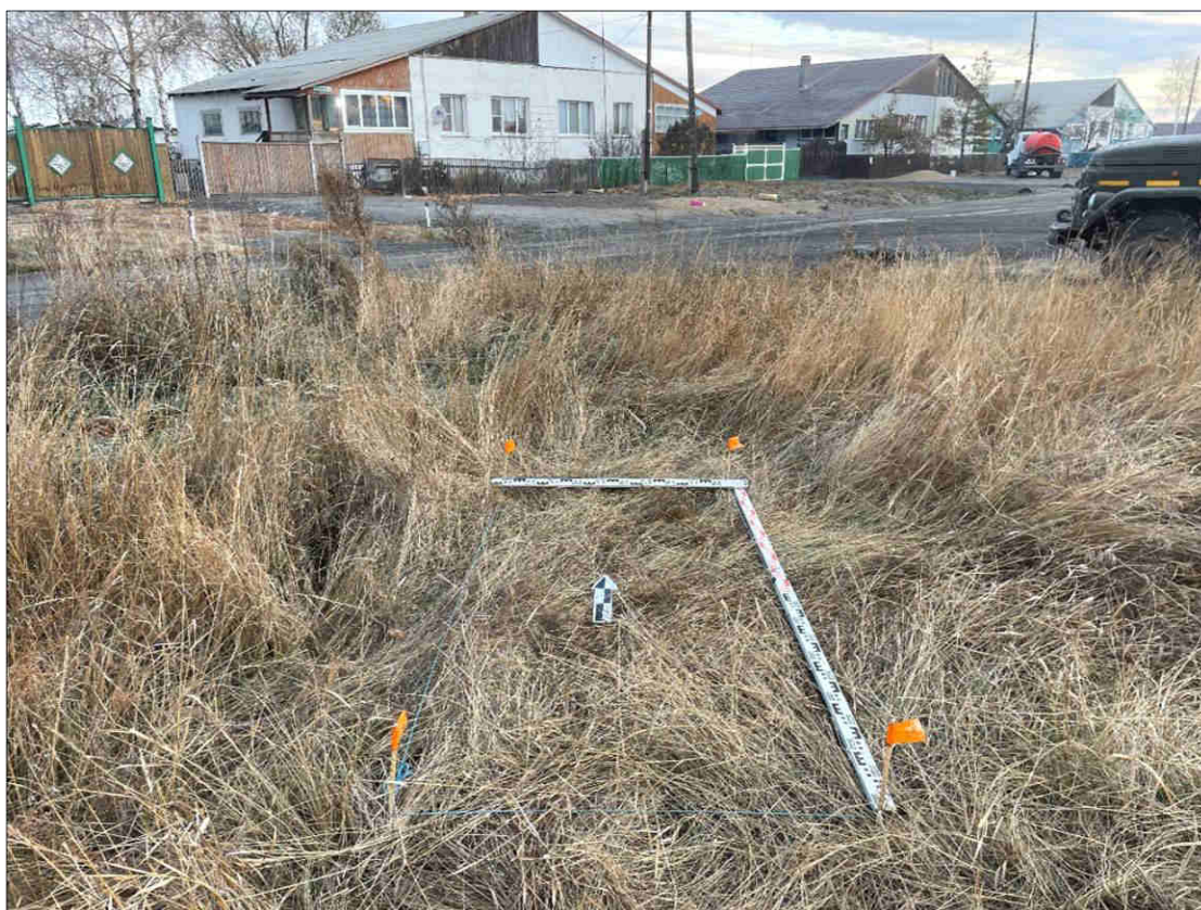
Рисунок 600 – «Распределительный газопровод р.п. Чистоозерное». Шурф №47. Общий вид. Разбивка. Снято с Ю.
