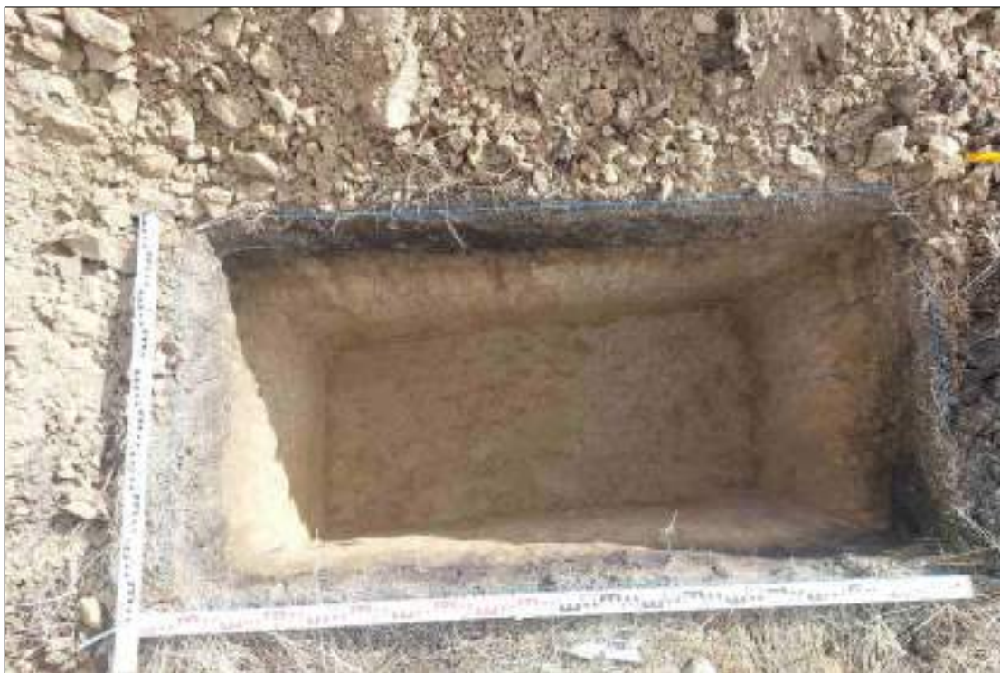
Рисунок 439 – «Распределительный газопровод р.п. Чистоозерное». Шурф №15. Дно шурфа. Снято с З.
