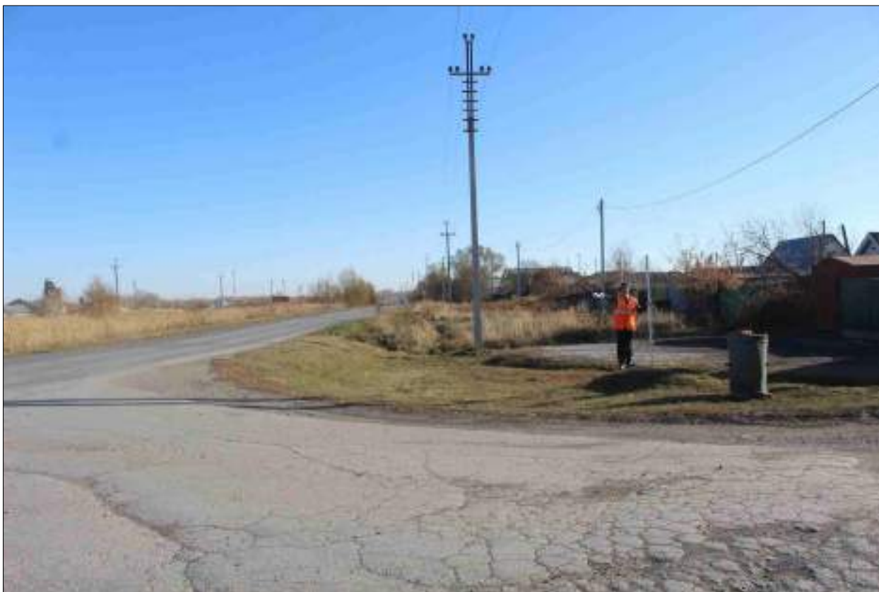
Рисунок 181 – «Распределительный газопровод р.п. Чистоозерное». Вид из точки 116 в направлении точки 115. Снято с СЗ.
