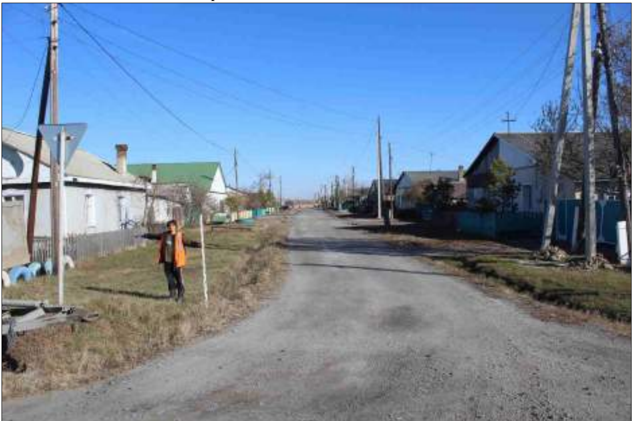
Рисунок 136 – «Распределительный газопровод р.п. Чистоозерное». Вид из точки 105 в направлении точки 106. Снято с ЮЗ.
