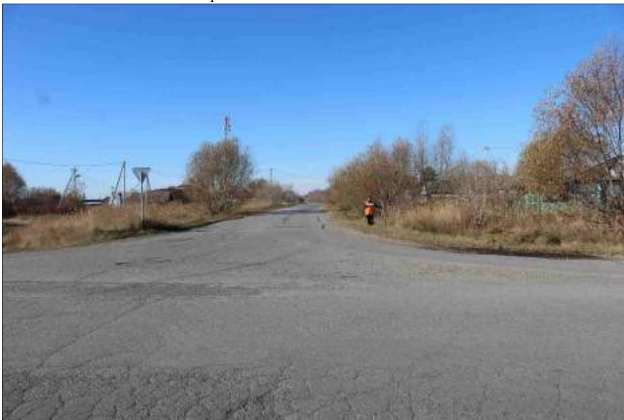
Рисунок 78 – «Распределительный газопровод р.п. Чистоозерное». Вид из точки 137 в направлении точки 150. Снято с В.
