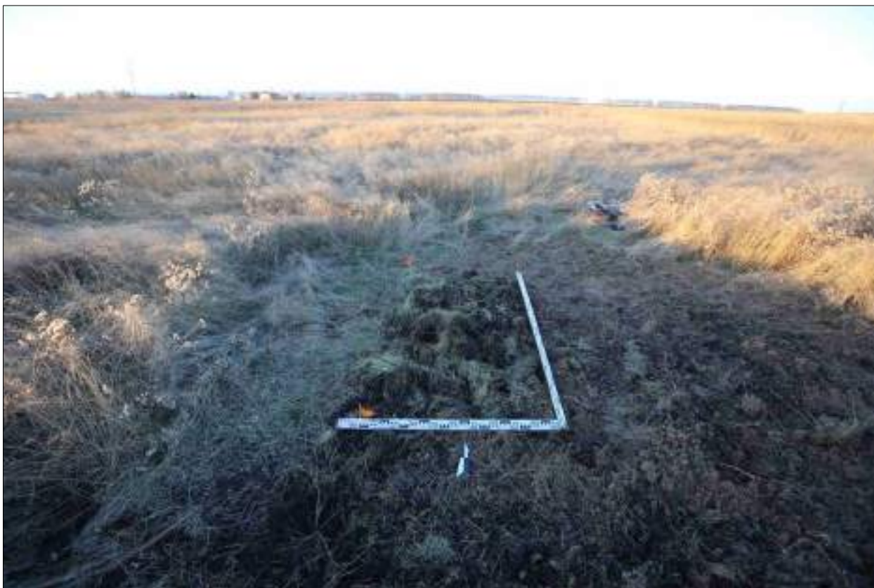
Рисунок 455 – «Распределительный газопровод р.п. Чистоозерное». Шурф №18. Рекультивация. Снято с Ю.
