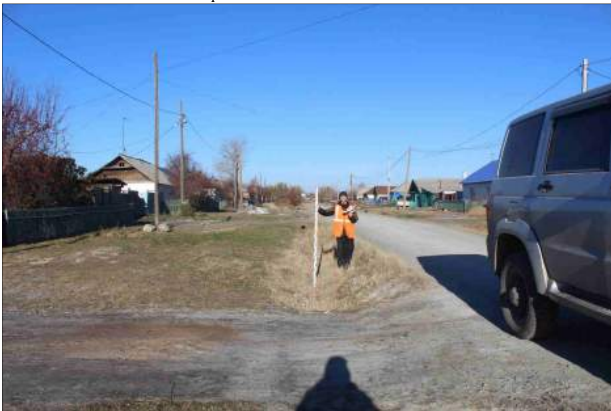
Рисунок 58 – «Распределительный газопровод р.п. Чистоозерное». Вид из точки 168 в направлении точки 169. Снято с В.
