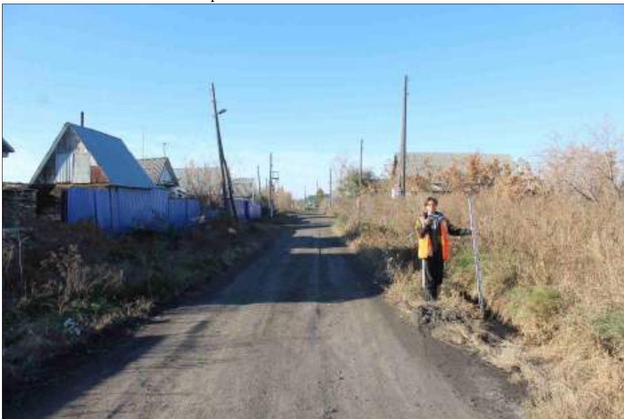
Рисунок 190 – «Распределительный газопровод р.п. Чистоозерное». Вид из точки 91 в направлении точки 113. Снято с В.
