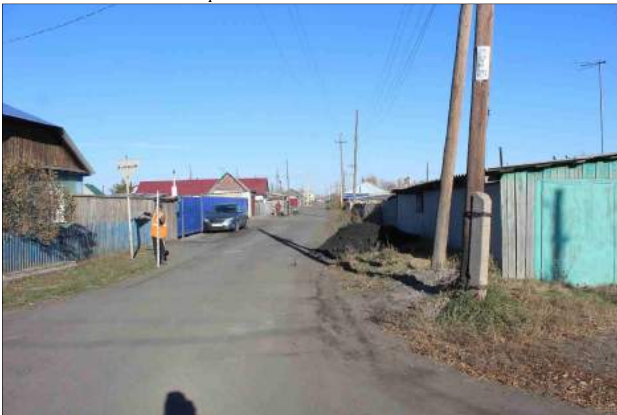
Рисунок 168 – «Распределительный газопровод р.п. Чистоозерное». Вид из точки 112 в направлении точки 113. Снято с ЮЗ.
