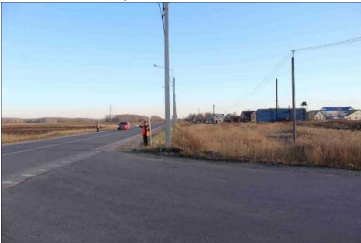
Рисунок 236 – «Распределительный газопровод р.п. Чистоозерное». Вид из точки 64 в направлении точки 197. Снято с СЗ.
