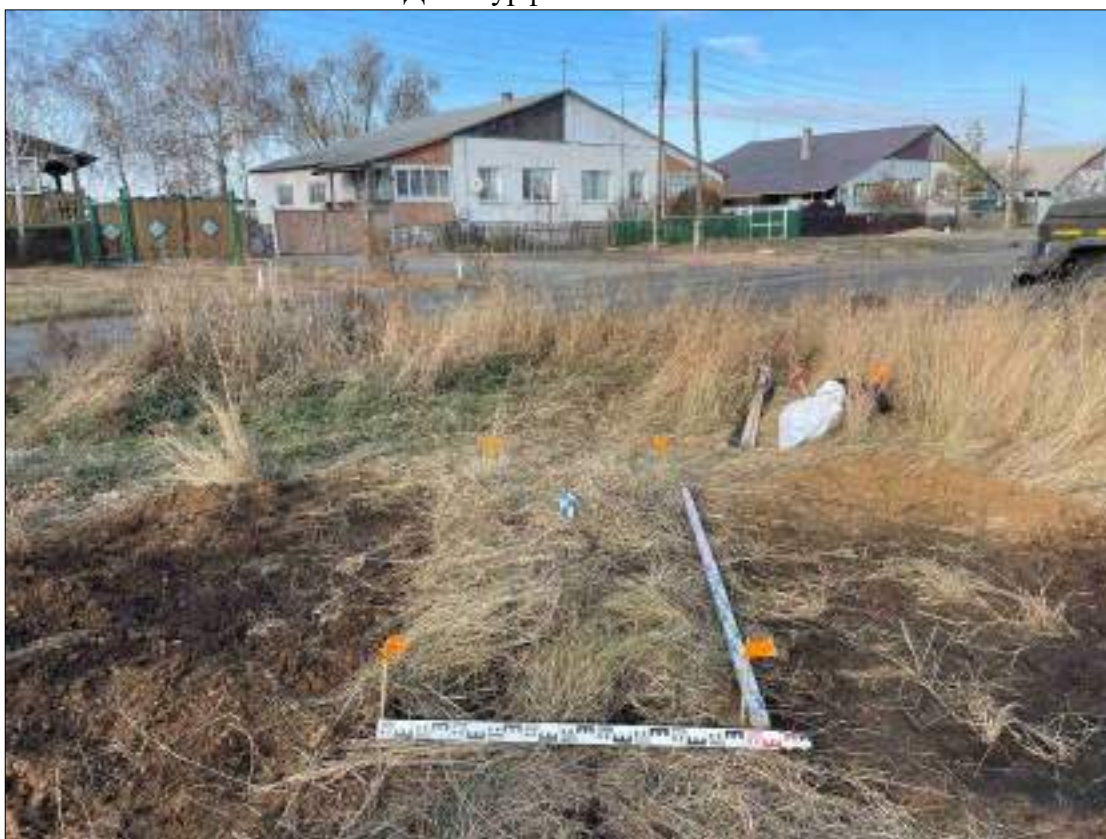
Рисунок 604 – «Распределительный газопровод р.п. Чистоозерное». Шурф №47. Рекультивация. Снято с Ю.
