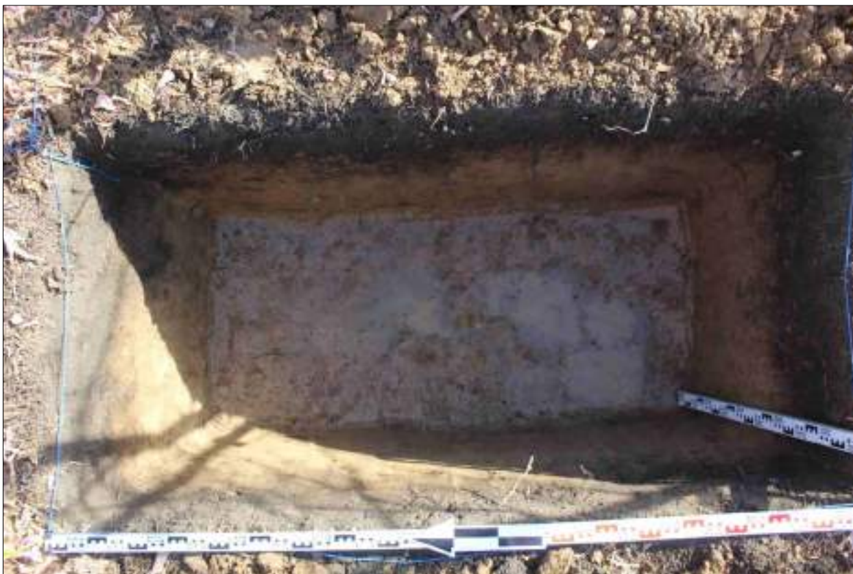
Рисунок 628 – «Распределительный газопровод р.п. Чистоозерное». Шурф №52. Дно шурфа. Снято с З.
