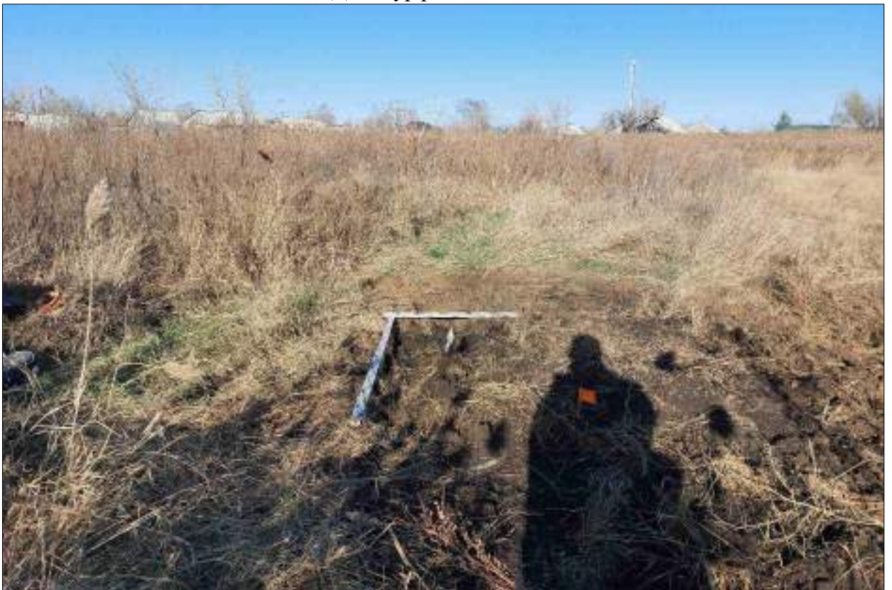
Рисунок 624 – «Распределительный газопровод р.п. Чистоозерное». Шурф №51. Рекультивация. Снято с Ю.
