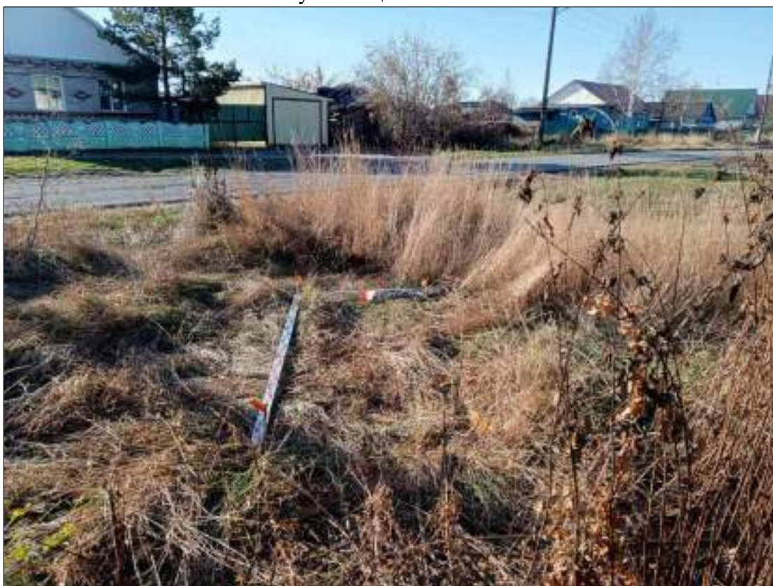
Рисунок 564 – «Распределительный газопровод р.п. Чистоозерное». Шурф №40. Общий вид. Разбивка. Снято с С.
