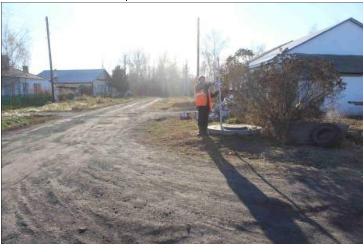
Рисунок 206 – «Распределительный газопровод р.п. Чистоозерное». Вид из точки 81 в направлении точки 82. Снято с СВ.
