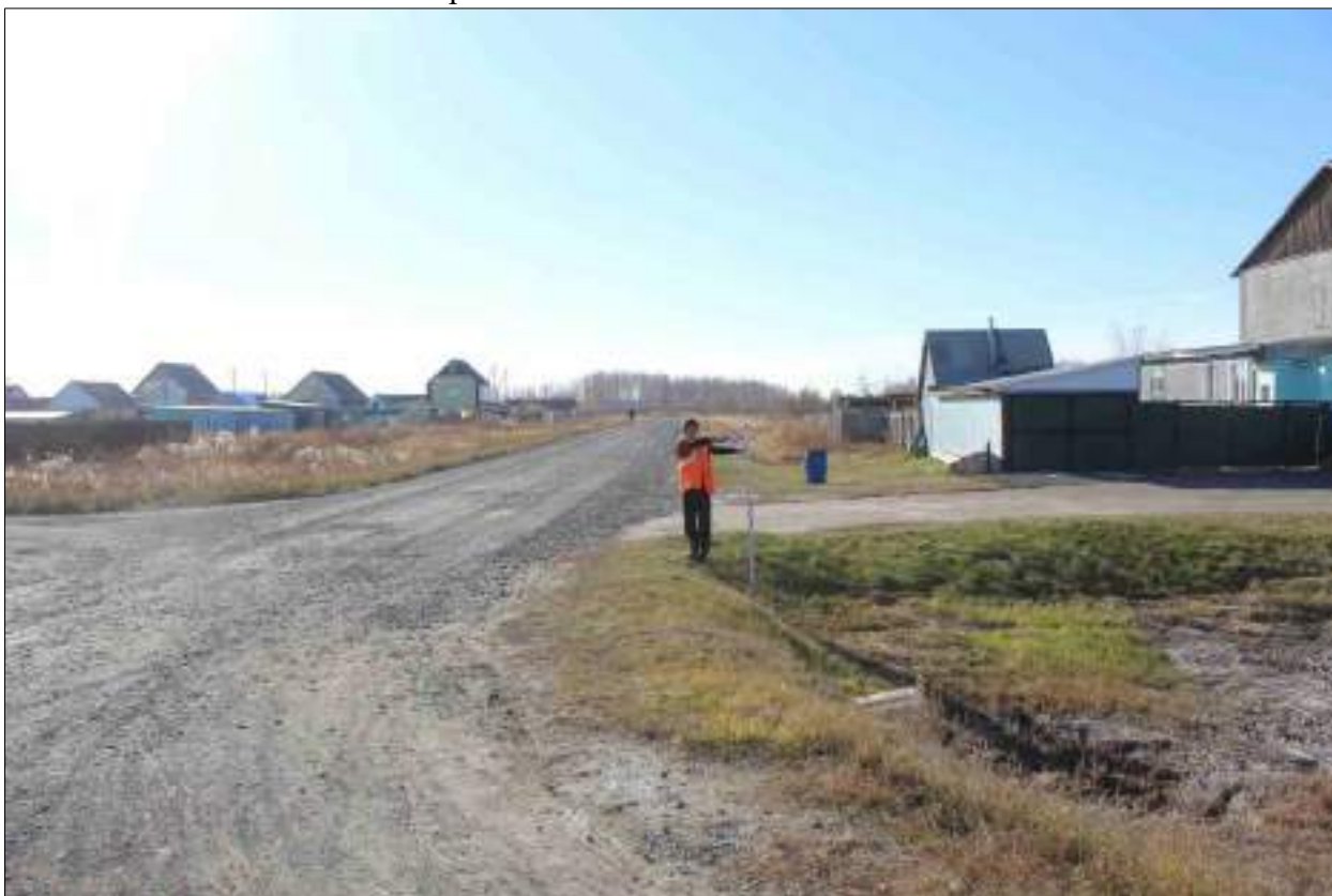
Рисунок 158 – «Распределительный газопровод р.п. Чистоозерное». Вид из точки 96 в направлении точки 97. Снято с СВ.
