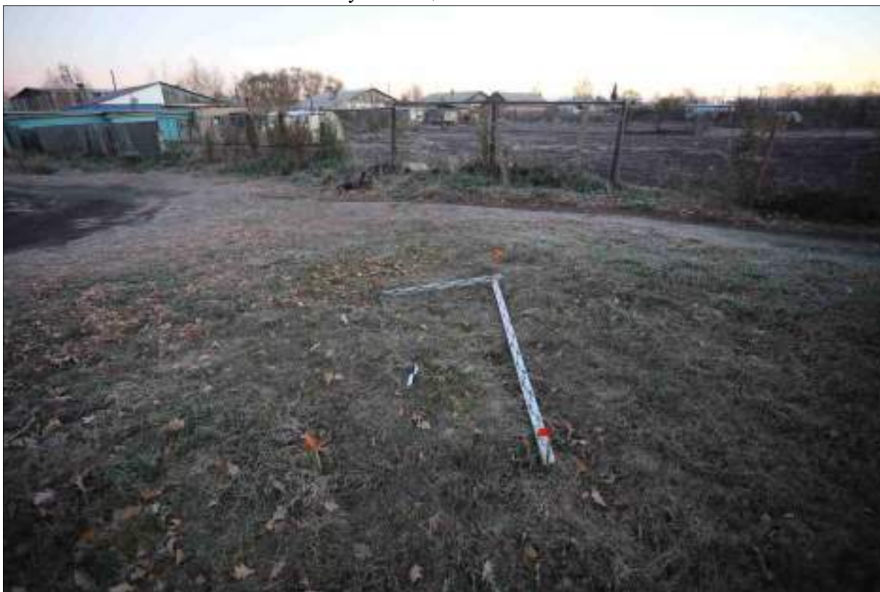
Рисунок 544 – «Распределительный газопровод р.п. Чистоозерное». Шурф №36. Общий вид. Разбивка. Снято с Ю.
