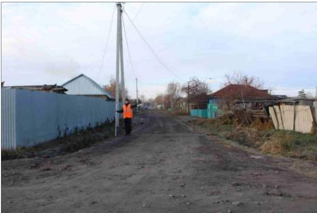
Рисунок 279 – «Распределительный газопровод р.п. Чистоозерное». Вид из точки 39 в направлении точки 48. Снято с СВ.
