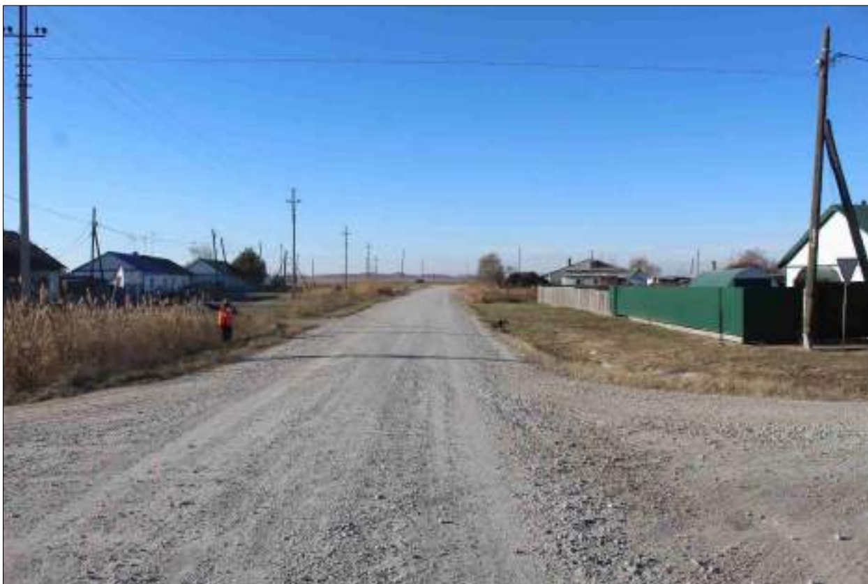
Рисунок 61 – «Распределительный газопровод р.п. Чистоозерное». Вид из точки 168 в направлении точки 167. Снято с СВ.
