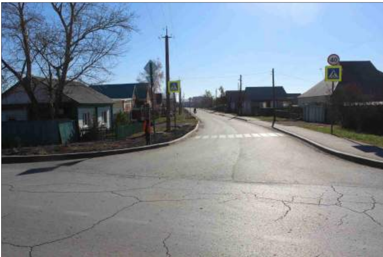
Рисунок 97 – «Распределительный газопровод р.п. Чистоозерное». Вид из точки 149 в направлении точки 152. Снято с СЗ.
