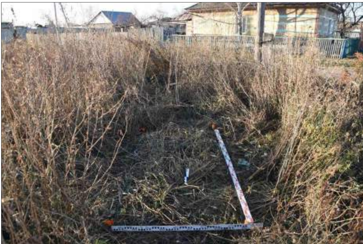
Рисунок 569 – «Распределительный газопровод р.п. Чистоозерное». Шурф №41. Общий вид. Разбивка. Снято с С.
