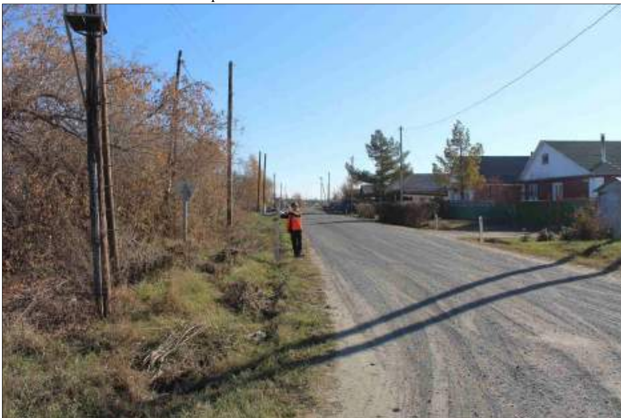
Рисунок 142 – «Распределительный газопровод р.п. Чистоозерное». Вид из точки 121 в направлении точки 110. Снято с СЗ.
