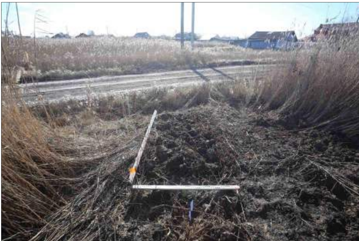
Рисунок 493 – «Распределительный газопровод р.п. Чистоозерное». Шурф №25. Рекультивация. Снято с С.
