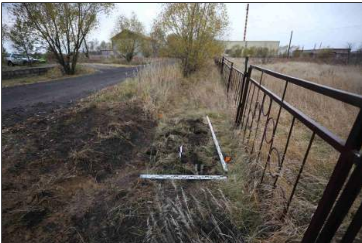
Рисунок 425 – «Распределительный газопровод р.п. Чистоозерное». Шурф №12. Рекультивация. Снято с С.
