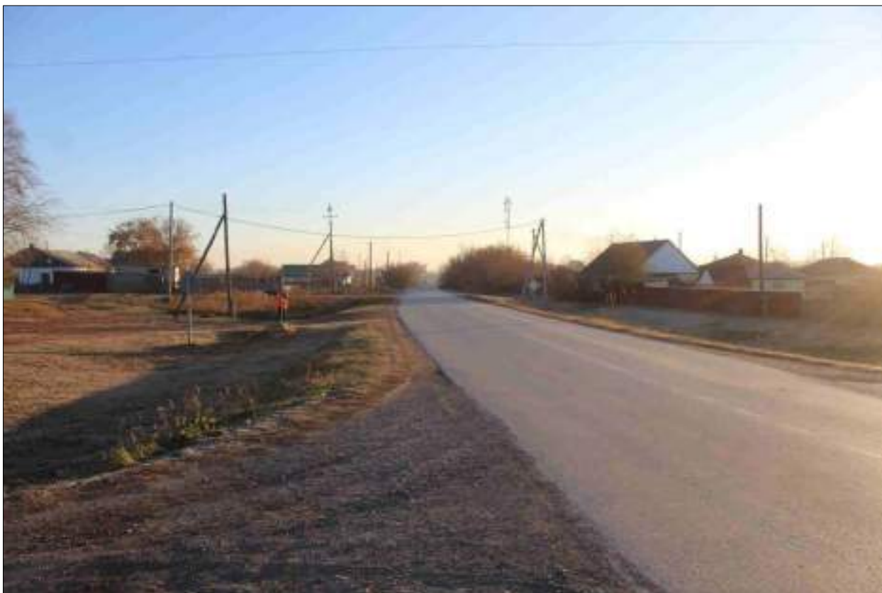
Рисунок 15 – «Распределительный газопровод р.п. Чистоозерное». Вид из точки 182 в направлении точки 183. Снято с З.
