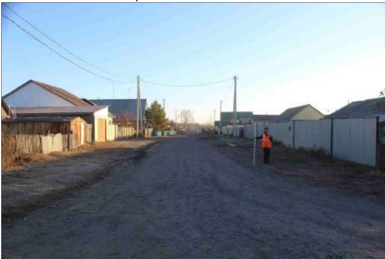
Рисунок 20 – «Распределительный газопровод р.п. Чистоозерное». Вид из точки 184 в направлении точки 148. Снято с 3.
