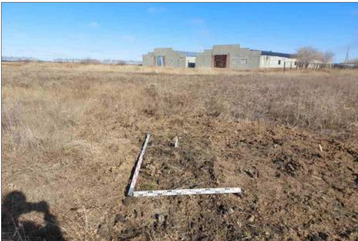
Рисунок 465 – «Распределительный газопровод р.п. Чистоозерное». Шурф №20. Рекультивация. Снято с Ю.
