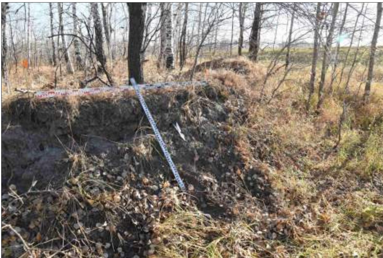
Рисунок 661 – «Распределительный газопровод р.п. Чистоозерное». Зачистка №1. Общий вид. Разбивка. Снято с СВ.
