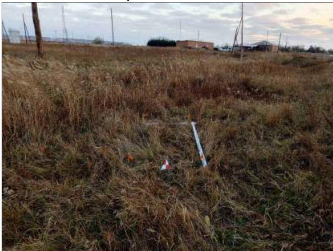
Рисунок 466 – «Распределительный газопровод р.п. Чистоозерное». Шурф №21. Общий вид. Разбивка. Снято с Ю.
