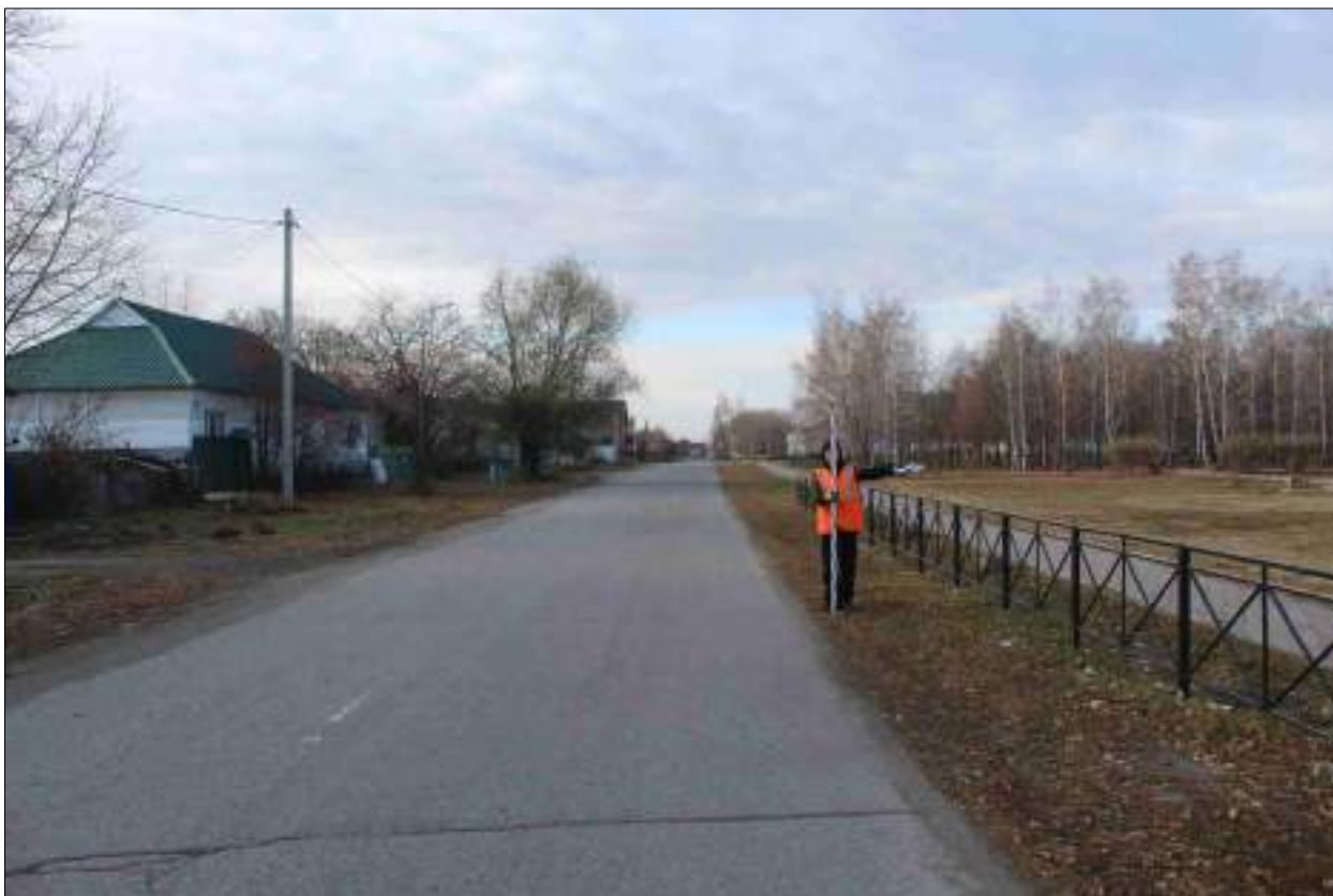
Рисунок 297 – «Распределительный газопровод р.п. Чистоозерное». Вид из точки 50 в направлении точки 45. Снято с СВ.
