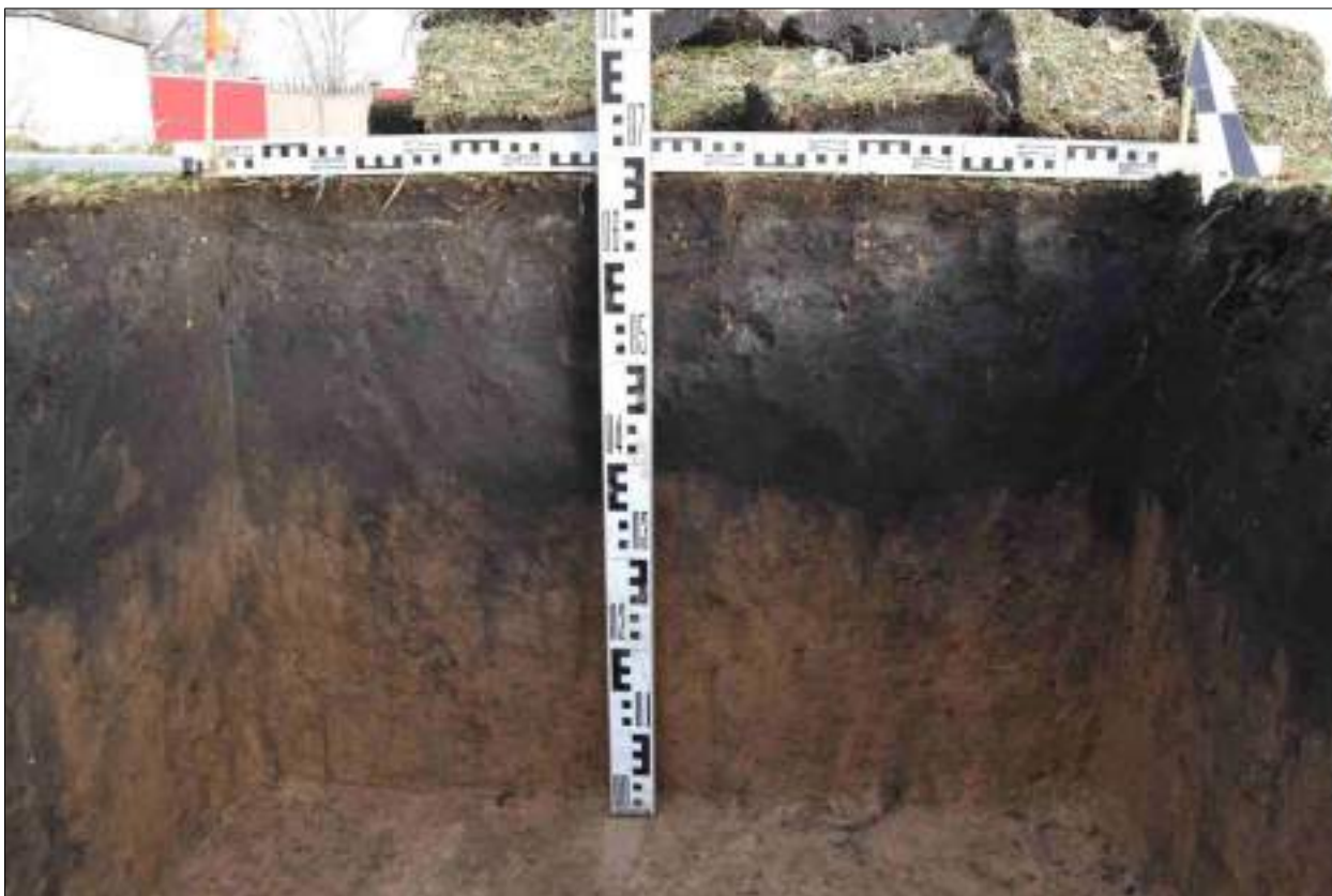
Рисунок 551 – «Распределительный газопровод р.п. Чистоозерное». Шурф №37. Северная стенка. Снято с Ю.
