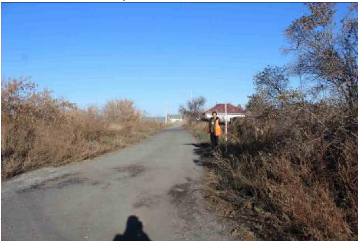
Рисунок 194 – «Распределительный газопровод р.п. Чистоозерное». Вид из точки 89 в направлении точки 88. Снято с ЮЗ.
