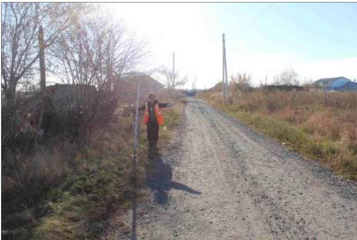
Рисунок 195 – «Распределительный газопровод р.п. Чистоозерное». Вид из точки 88 в направлении точки 89. Снято с СВ.
