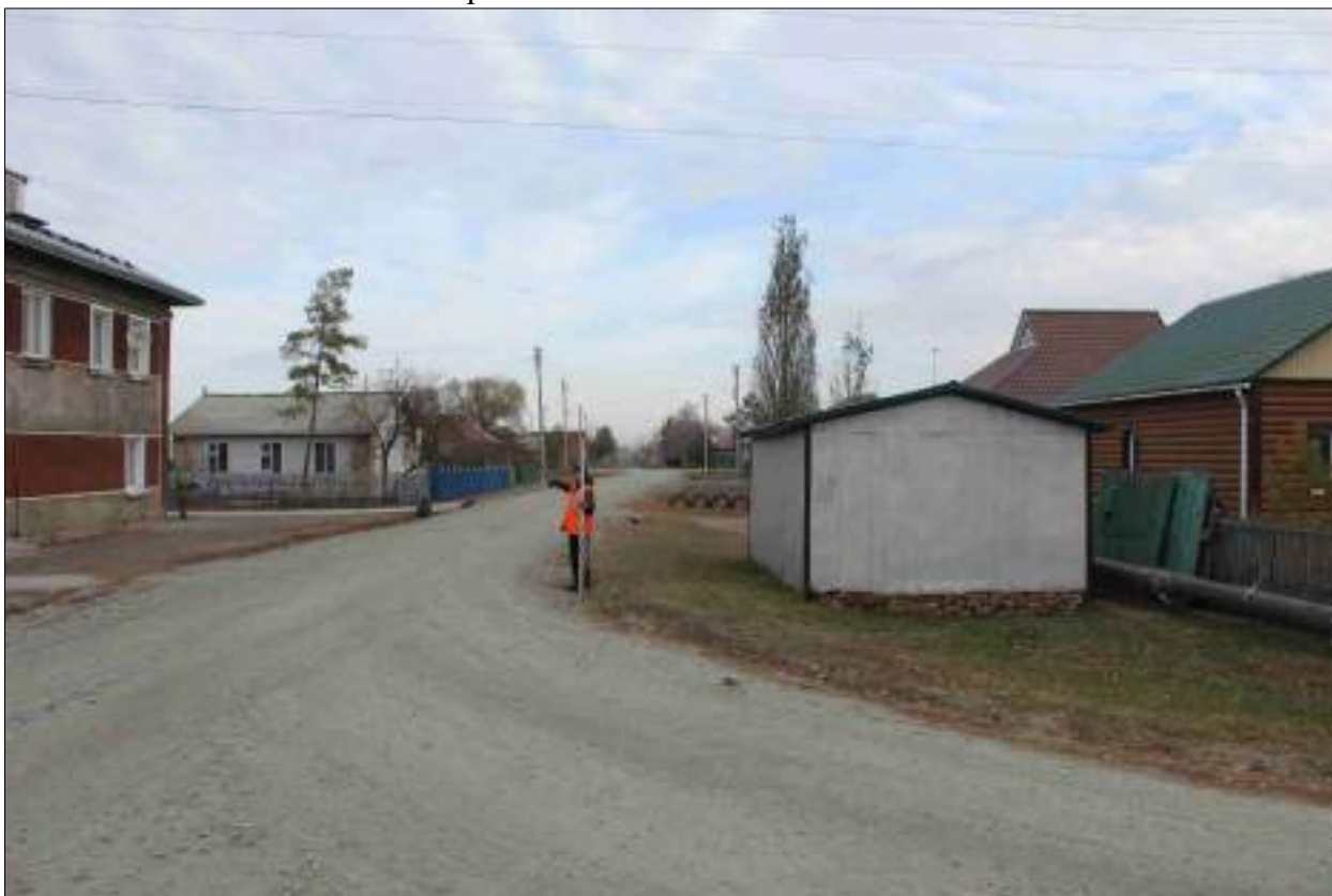
Рисунок 334 – «Распределительный газопровод р.п. Чистоозерное». Вид из точки 20 в направлении точки 19. Снято с ЮЗ.
