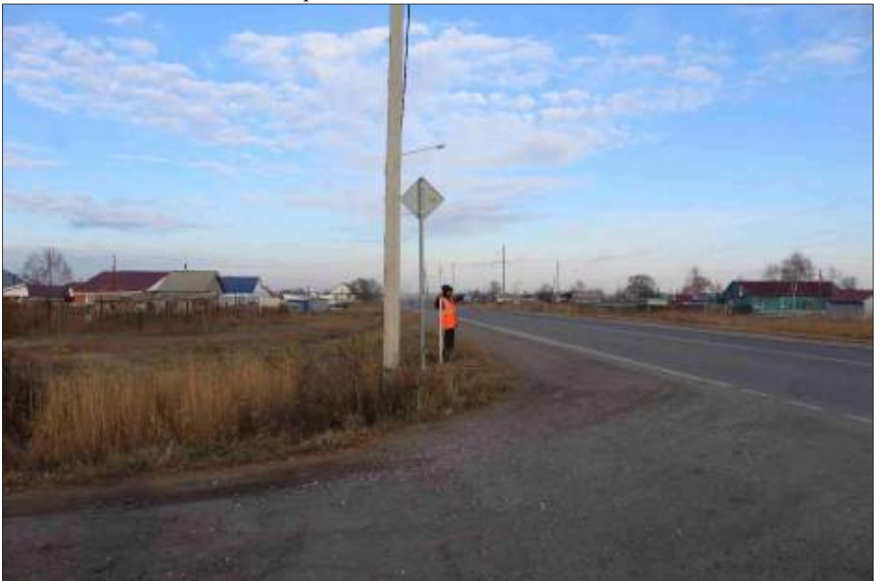
Рисунок 270 – «Распределительный газопровод р.п. Чистоозерное». Вид из точки 32 в направлении точки 31. Снято с ЮВ.
