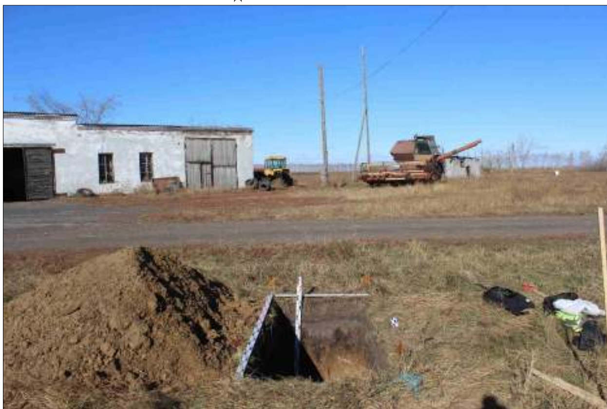
Рисунок 500 – «Распределительный газопровод р.п. Чистоозерное». Шурф №27. Общий вид выполненного шурфа. Снято с Ю.
