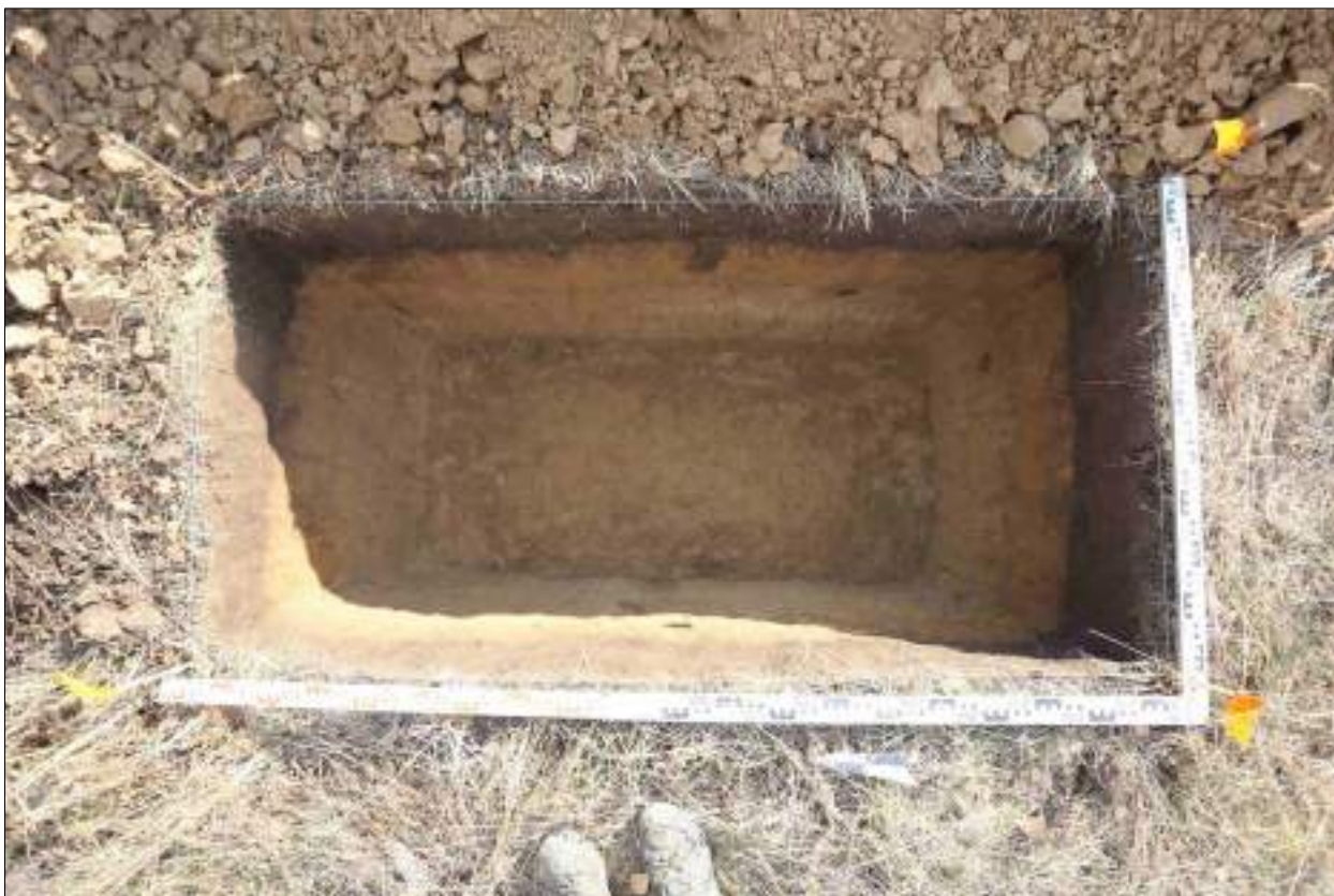
Рисунок 444 – «Распределительный газопровод р.п. Чистоозерное». Шурф №16. Дно шурфа. Снято с З.
