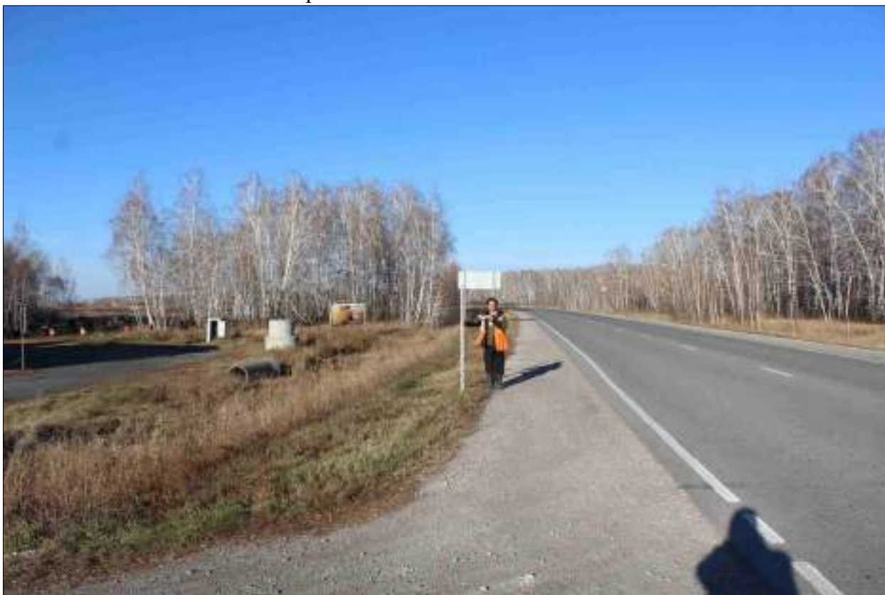
Рисунок 198 – «Распределительный газопровод р.п. Чистоозерное». Вид из точки 191 в направлении точки 86. Снято с ЮЗ.
