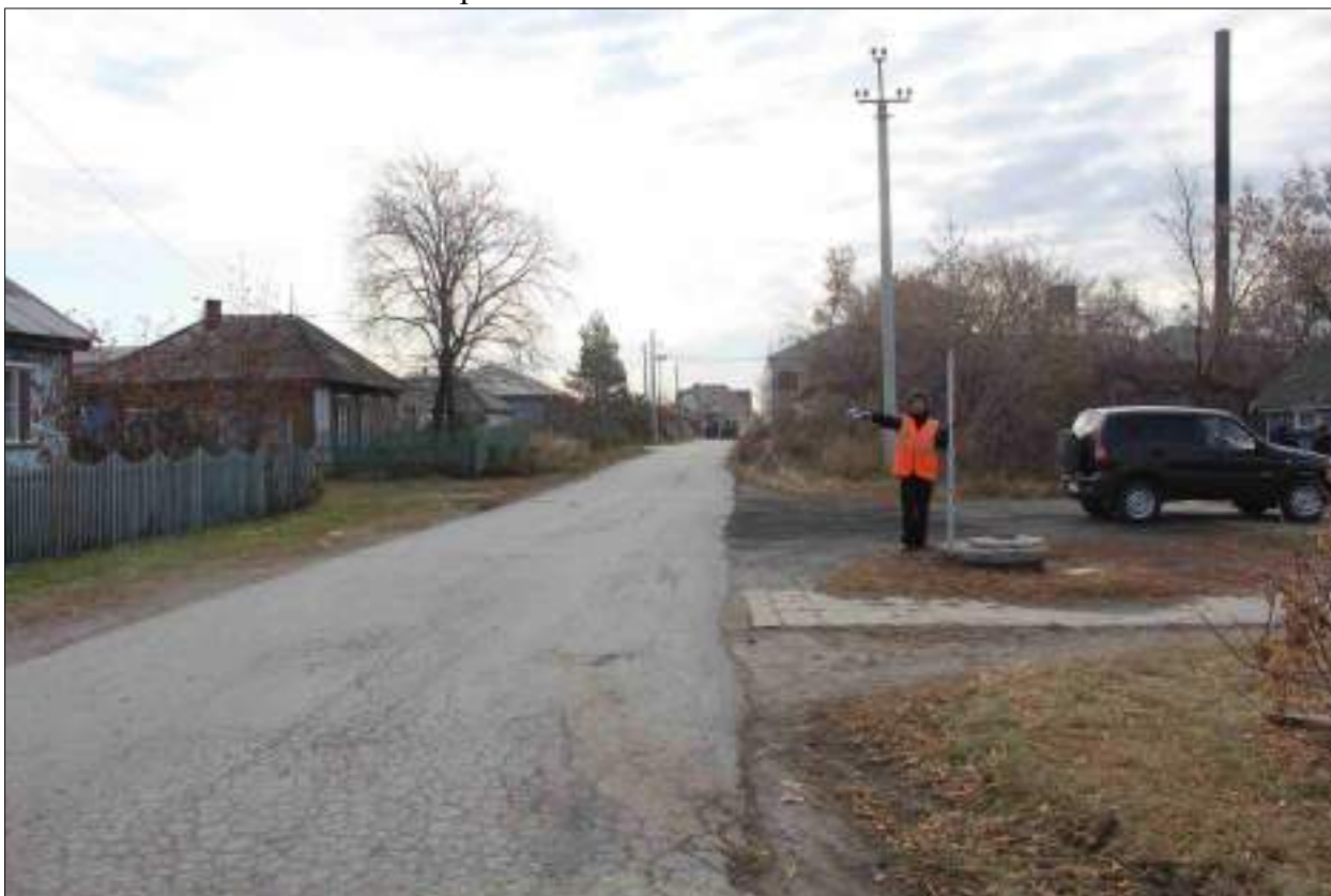
Рисунок 306 – «Распределительный газопровод р.п. Чистоозерное». Вид из точки 24 в направлении точки 26. Снято с СЗ.
