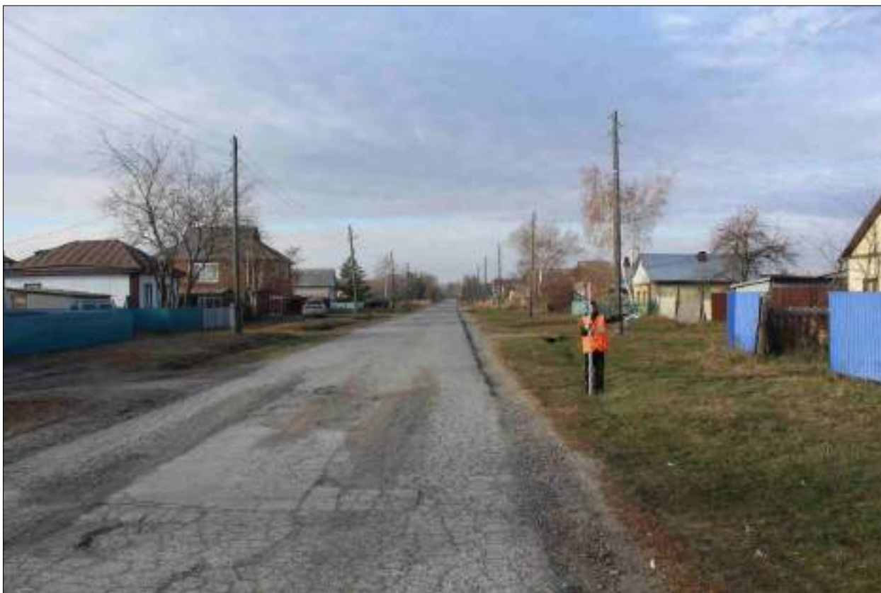
Рисунок 293 – «Распределительный газопровод р.п. Чистоозерное». Вид из точки 29 в направлении точки 36. Снято с СВ.
