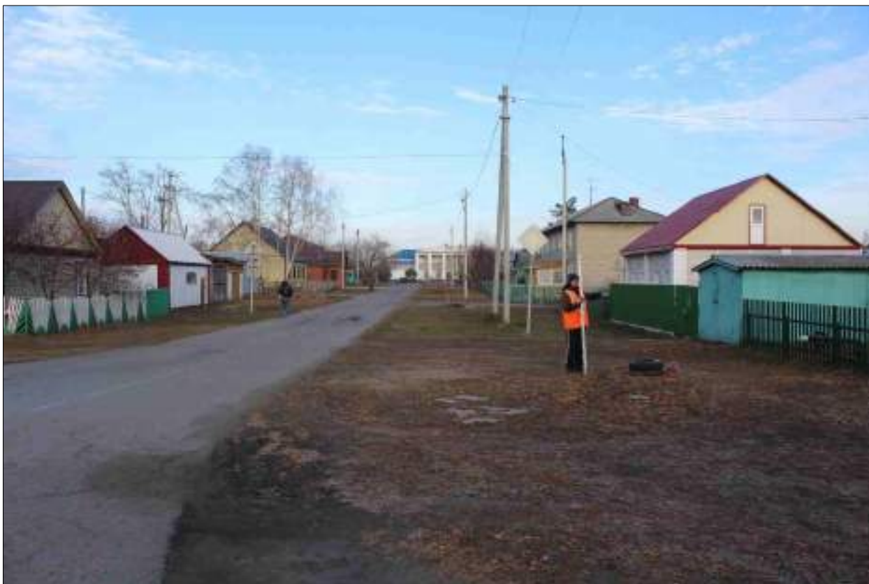
Рисунок 281 – «Распределительный газопровод р.п. Чистоозерное». Вид из точки 48 в направлении точки 49. Снято с ЮВ.
