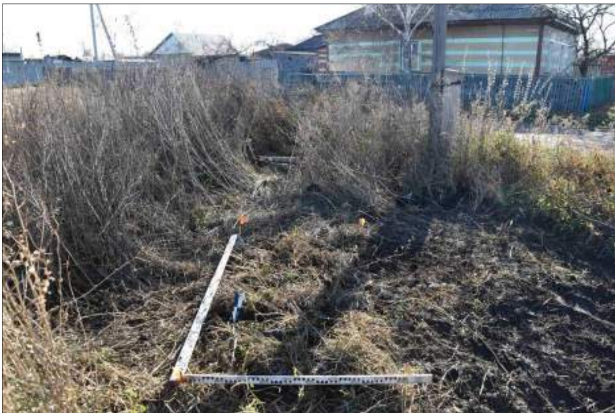
Рисунок 573 – «Распределительный газопровод р.п. Чистоозерное». Шурф №41. Рекультивация. Снято с С.
