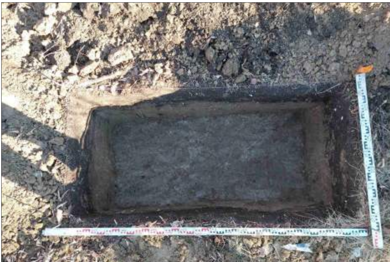
Рисунок 562 – «Распределительный газопровод р.п. Чистоозерное». Шурф №39. Дно шурфа. Снято с З.
