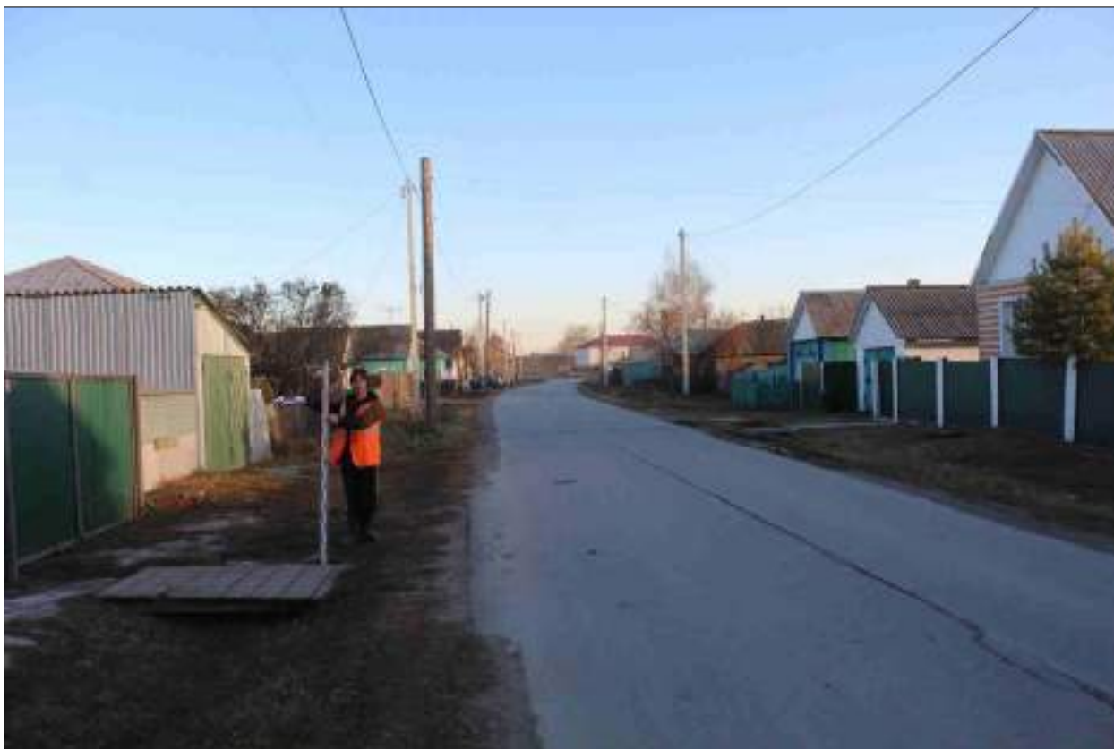
Рисунок 249 – «Распределительный газопровод р.п. Чистоозерное». Вид из точки 42 в направлении точки 54. Снято с СЗ.
