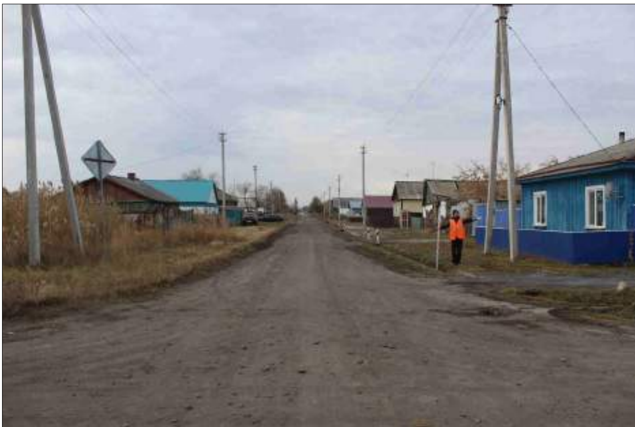
Рисунок 327 – «Распределительный газопровод р.п. Чистоозерное». Вид из точки 18 в направлении точки 19. Снято с СВ.
