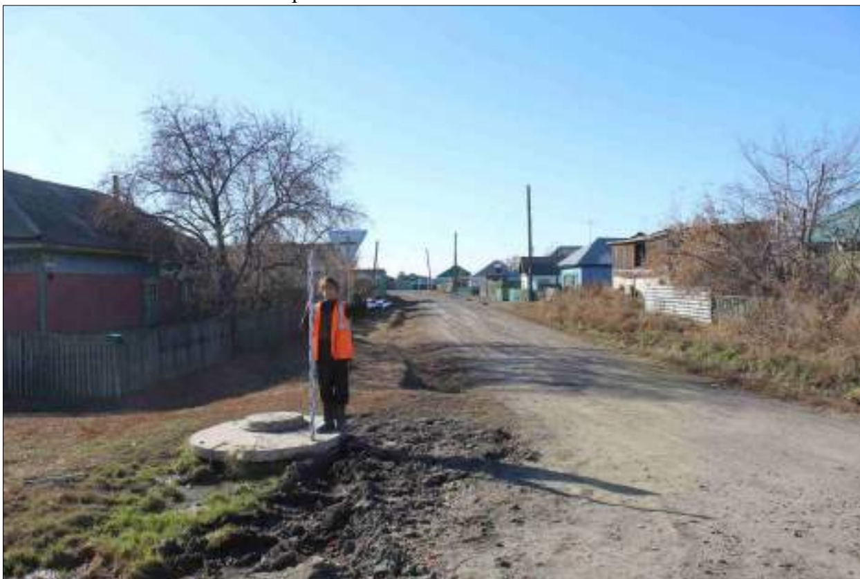
Рисунок 122 – «Распределительный газопровод р.п. Чистоозерное». Вид из точки 111 в направлении точки 110. Снято с СВ.
