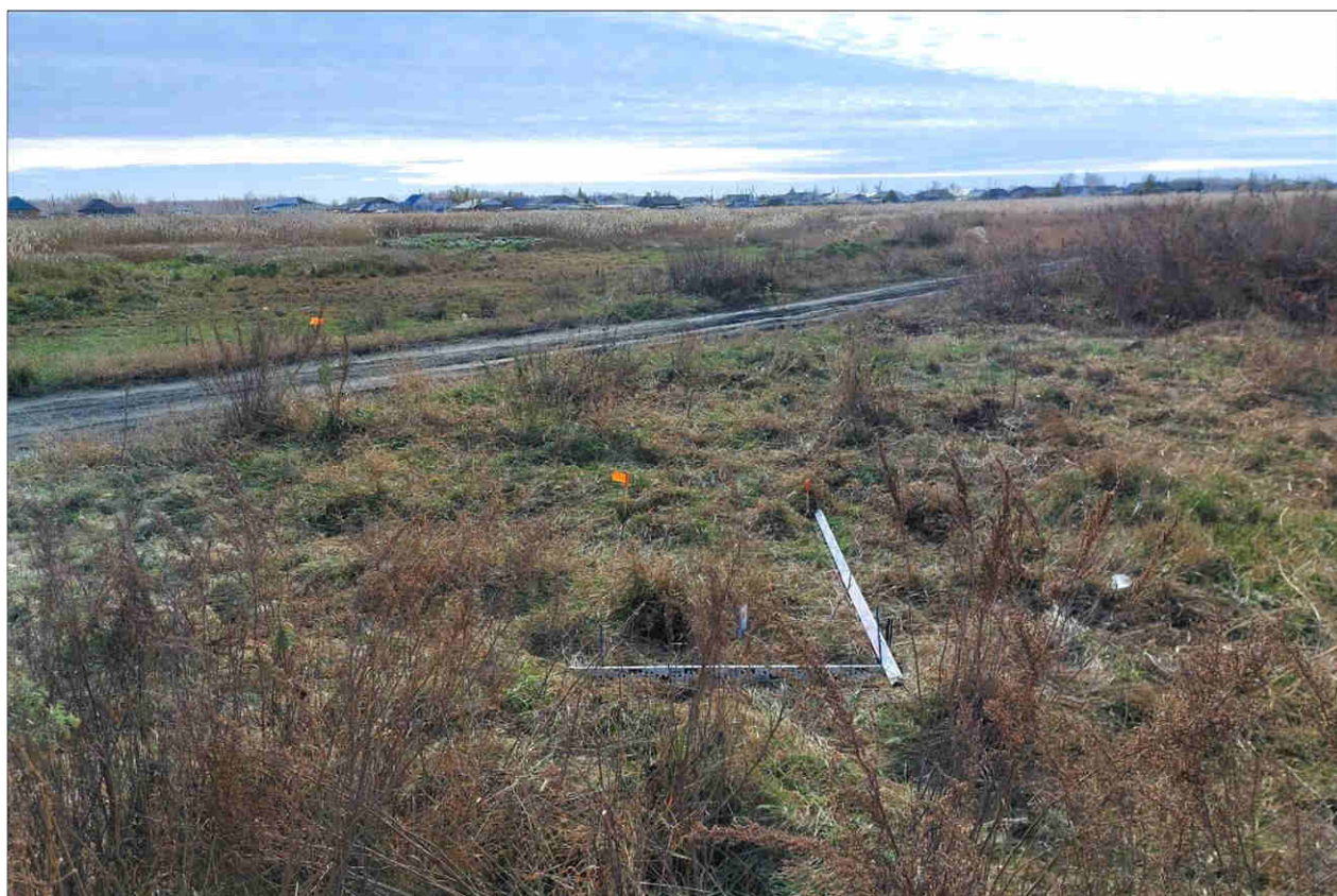
Рисунок 590 – «Распределительный газопровод р.п. Чистоозерное». Шурф №45. Общий вид. Разбивка. Снято с С.
