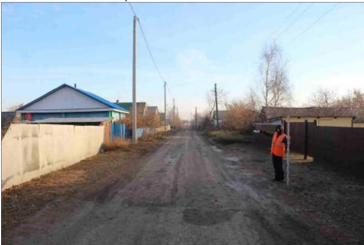
Рисунок 260 – «Распределительный газопровод р.п. Чистоозерное». Вид из точки 41 в направлении точки 40. Снято с ЮЗ.
