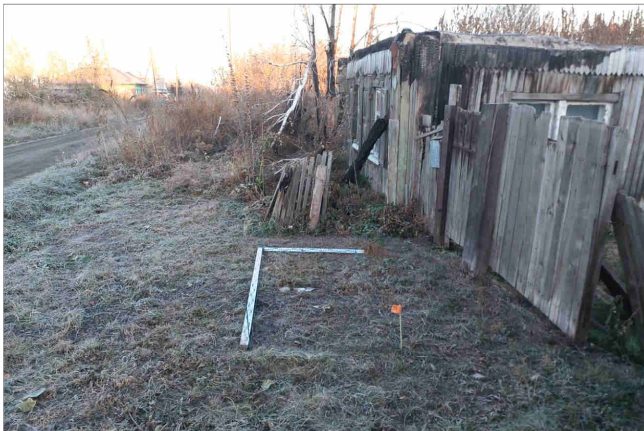
Рисунок 630 – «Распределительный газопровод р.п. Чистоозерное». Шурф №53. Общий вид. Разбивка. Снято с ЮВ.
