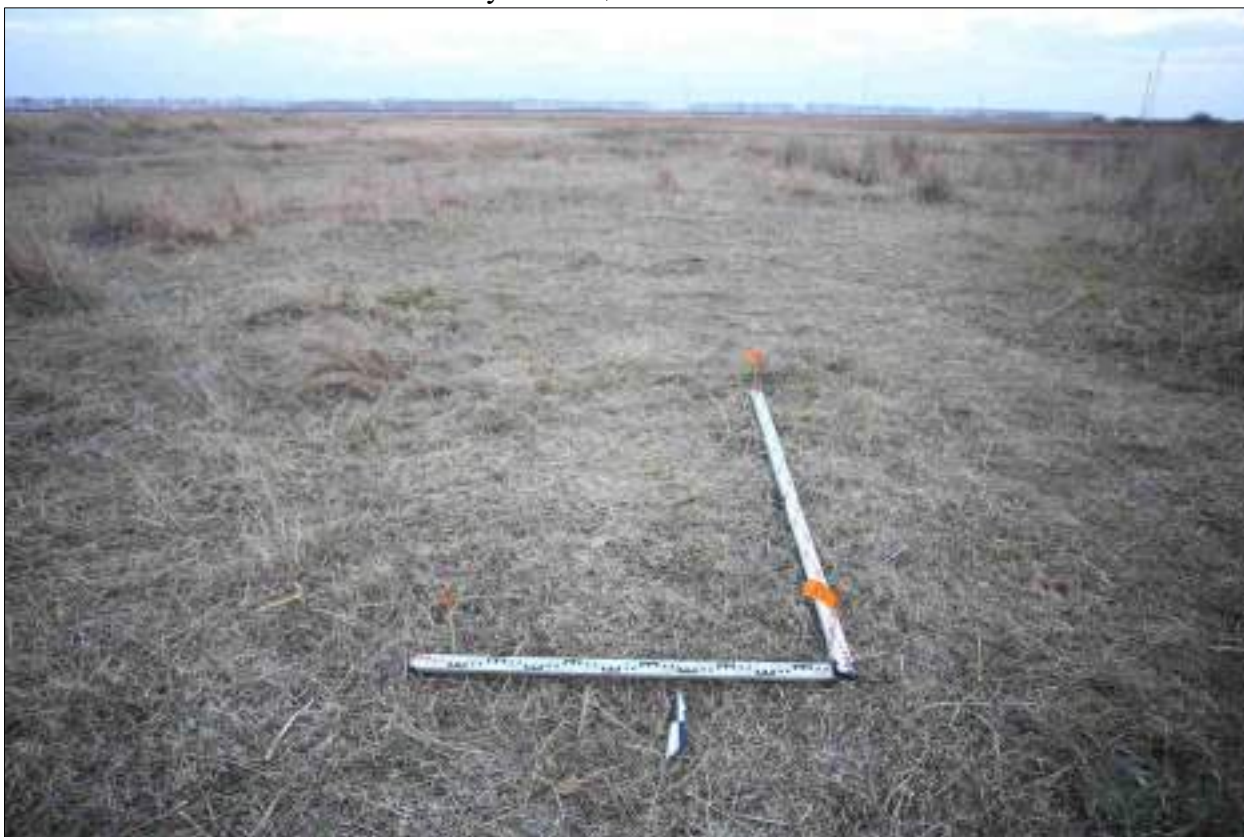
Рисунок 456 – «Распределительный газопровод р.п. Чистоозерное». Шурф №19. Общий вид. Разбивка. Снято с Ю.
