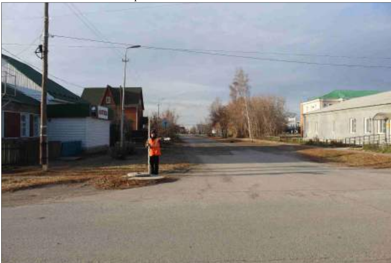
Рисунок 288 – «Распределительный газопровод р.п. Чистоозерное». Вид из точки 45 в направлении точки 44. Снято с СВ.
