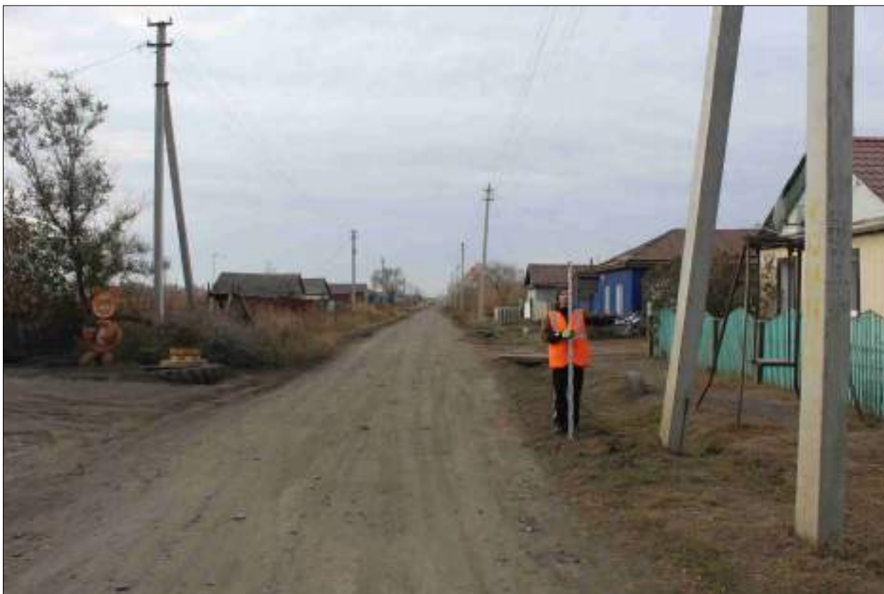
Рисунок 320 – «Распределительный газопровод р.п. Чистоозерное». Вид из точки 4 в направлении точки 17. Снято с СВ.
