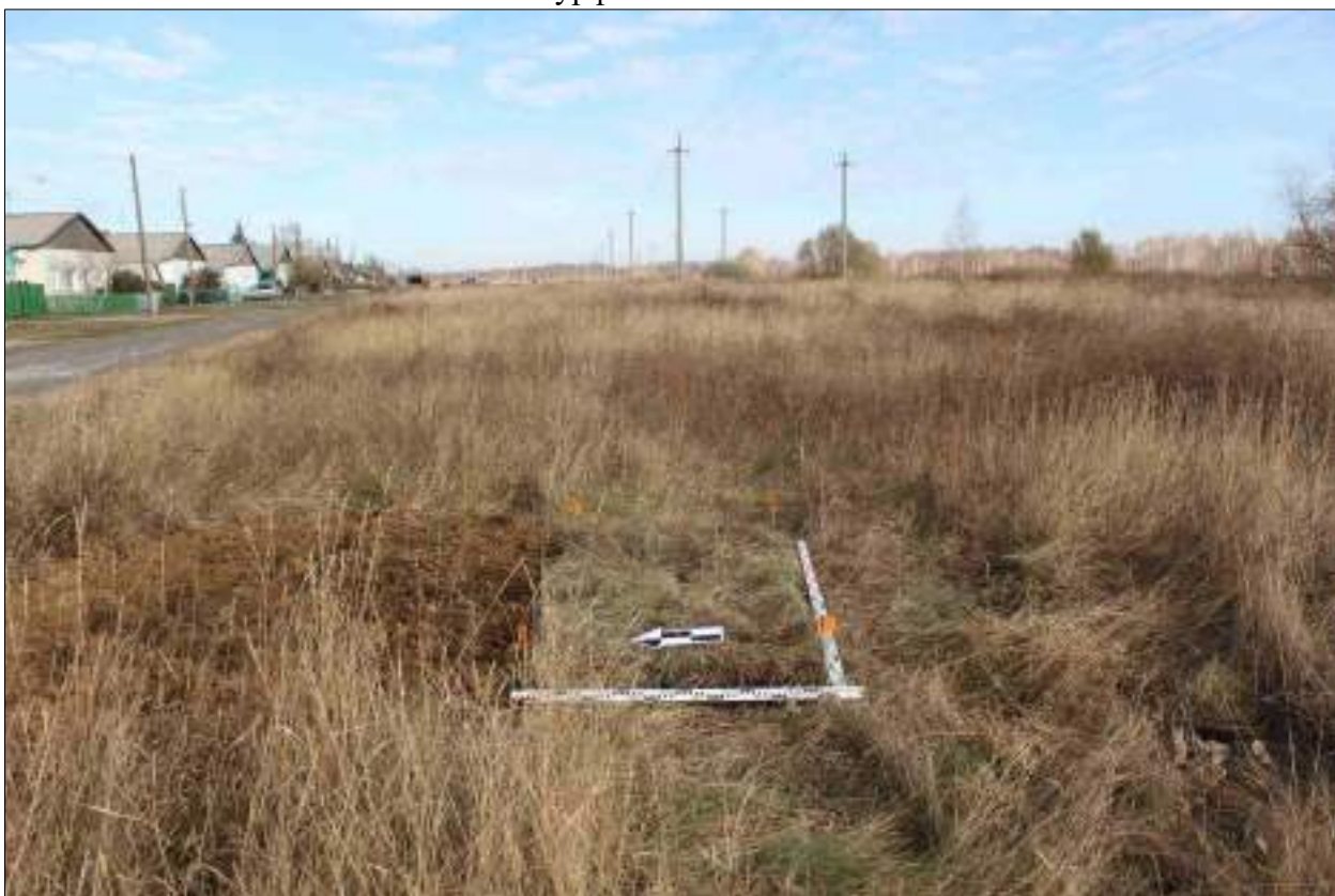
Рисунок 450 – «Распределительный газопровод р.п. Чистоозерное». Шурф №17. Рекультивация. Снято с З.
