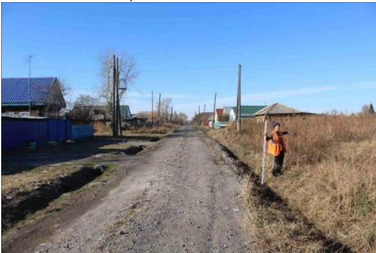
Рисунок 164 – «Распределительный газопровод р.п. Чистоозерное». Вид из точки 92 в направлении точки 112. Снято с ЮВ.
