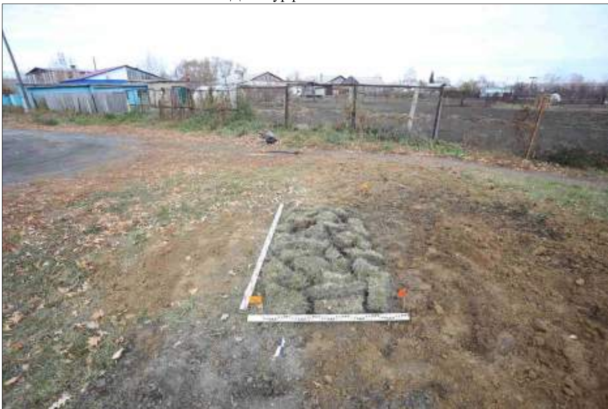
Рисунок 548 – «Распределительный газопровод р.п. Чистоозерное». Шурф №36. Рекультивация. Снято с Ю.
