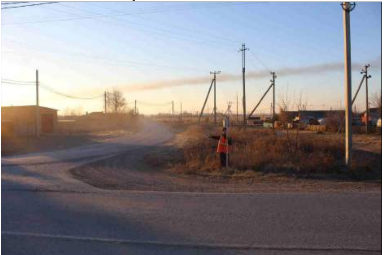
Рисунок 10 – «Распределительный газопровод р.п. Чистоозерное». Вид из точки 175 в направлении точки 173. Снято с СЗ.
