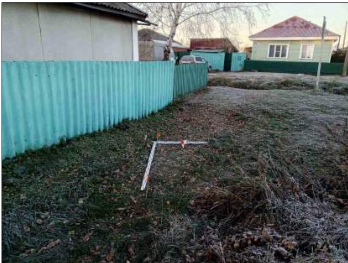
Рисунок 635 – «Распределительный газопровод р.п. Чистоозерное». Шурф №54. Общий вид. Разбивка. Снято с С.
