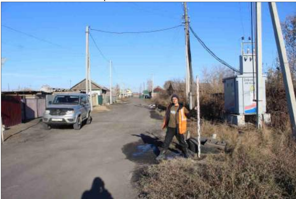
Рисунок 186 – «Распределительный газопровод р.п. Чистоозерное». Вид из точки 113 в направлении точки 114. Снято с ЮЗ.
