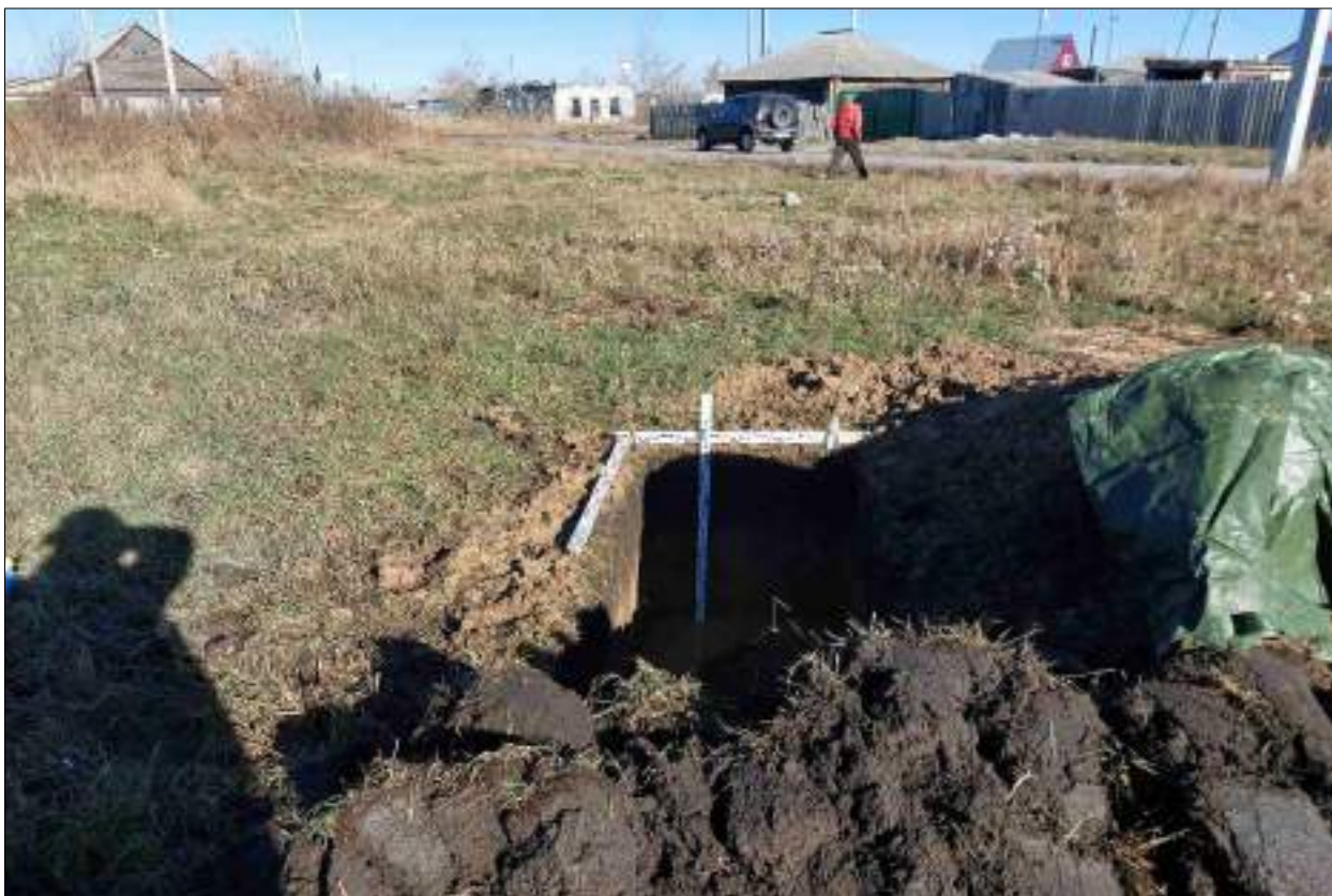
Рисунок 495 – «Распределительный газопровод р.п. Чистоозерное». Шурф №26. Общий вид выполненного шурфа. Снято с Ю.
