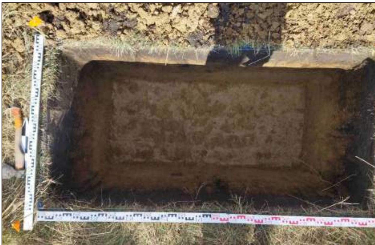
Рисунок 449 – «Распределительный газопровод р.п. Чистоозерное». Шурф №17. Дно шурфа. Снято с Ю.
