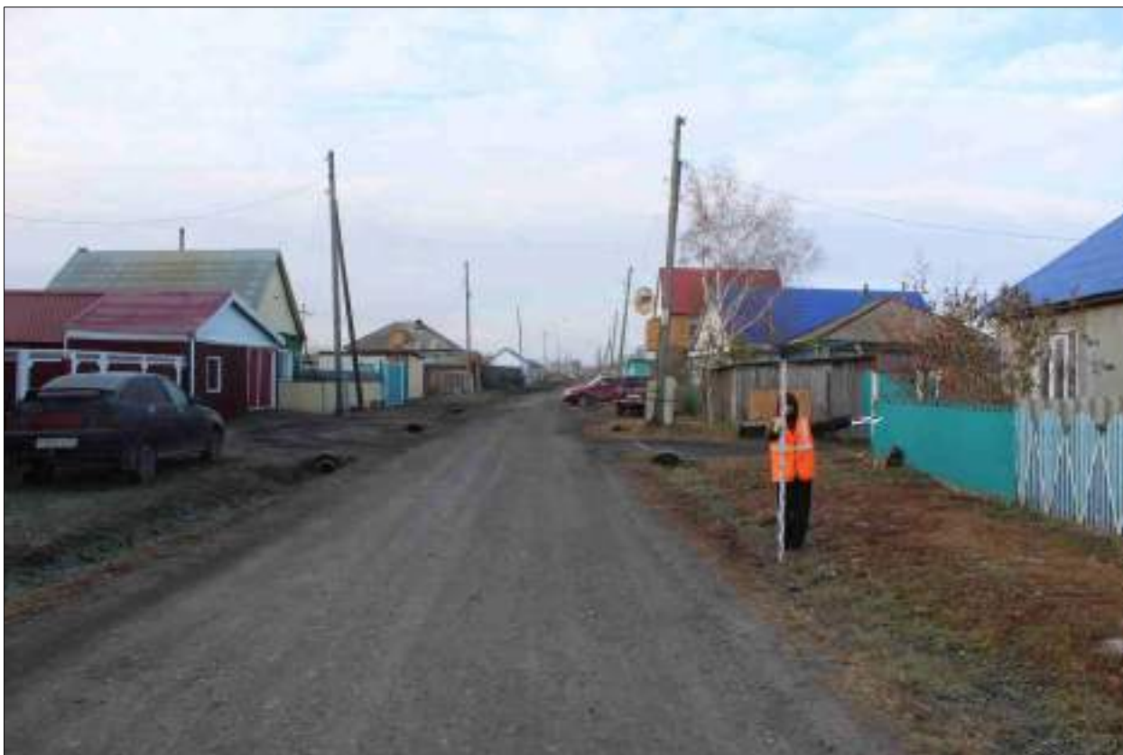
Рисунок 273 – «Распределительный газопровод р.п. Чистоозерное». Вид из точки 31 в направлении точки 34. Снято с СВ.
