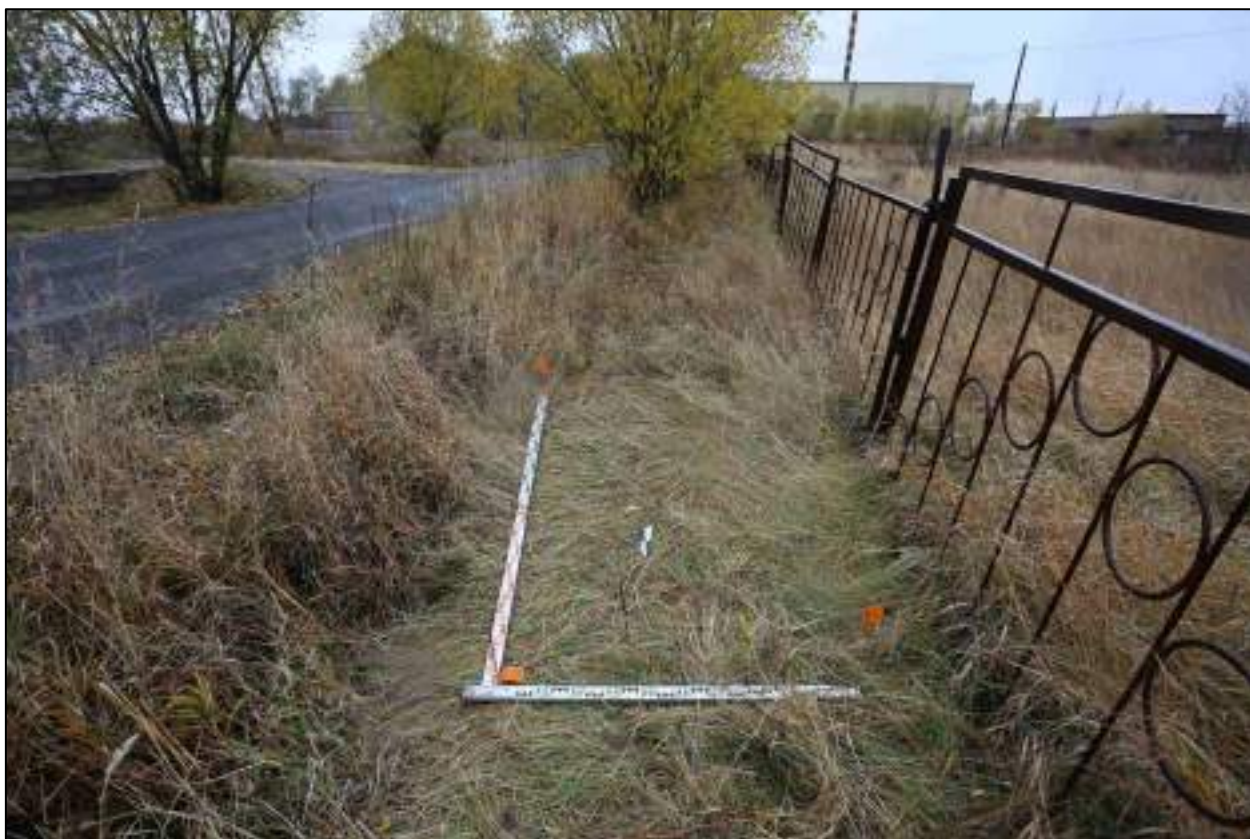
Рисунок 421 – «Распределительный газопровод р.п. Чистоозерное». Шурф №12. Общий вид. Разбивка. Снято с С.
