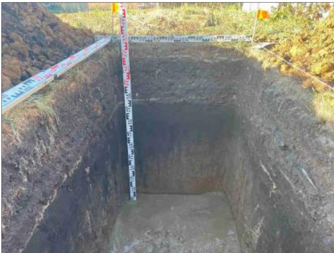
Рисунок 647 – «Распределительный газопровод р.п. Чистоозерное». Шурф №56. Северо-западная стенка. Снято с ЮВ.
