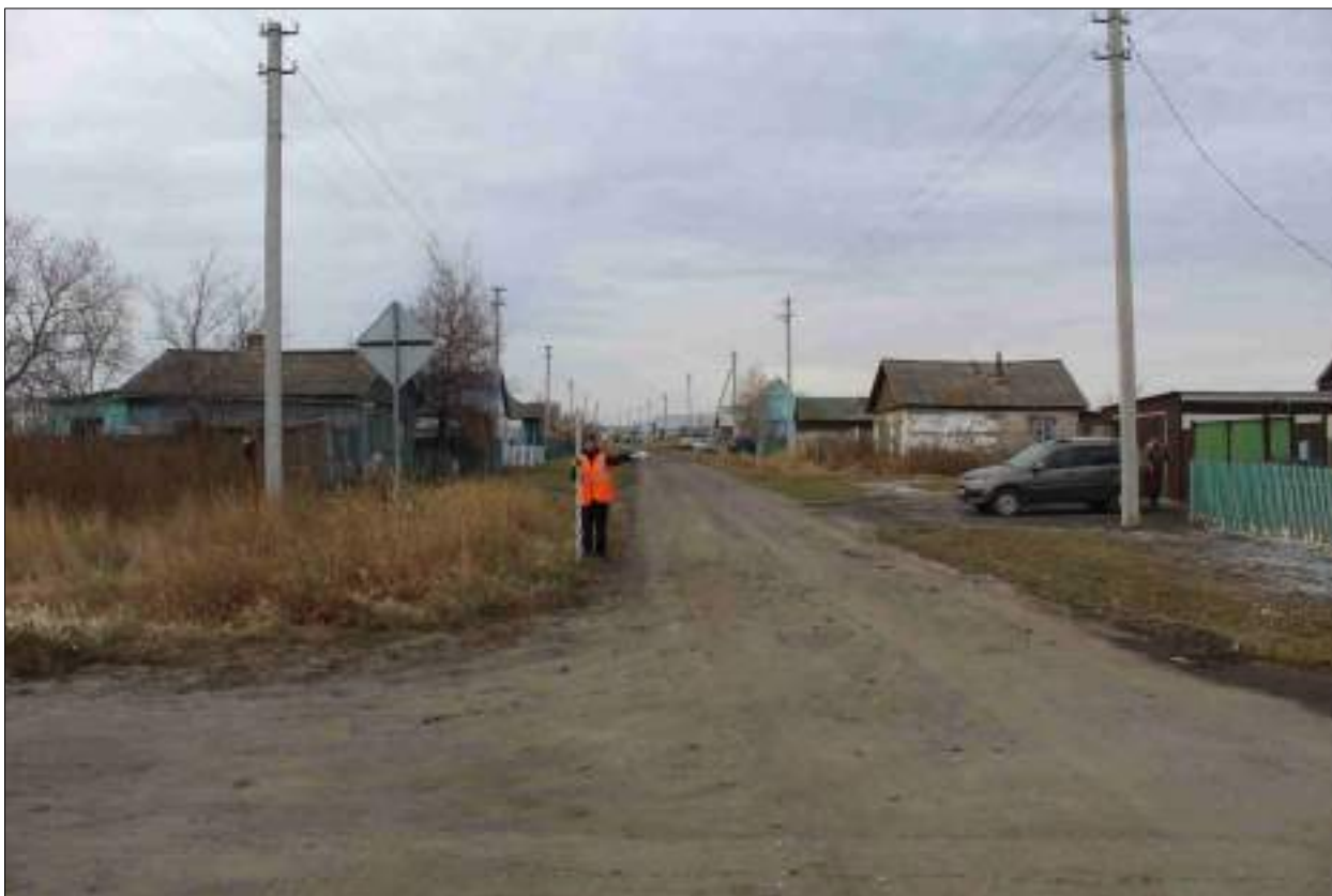
Рисунок 323 – «Распределительный газопровод р.п. Чистоозерное». Вид из точки 17 в направлении точки 18. Снято с СВ.
