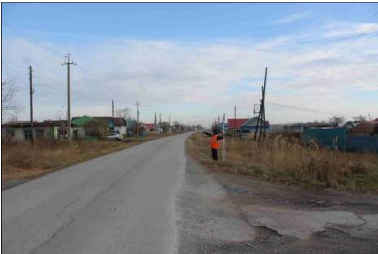
Рисунок 307 – «Распределительный газопровод р.п. Чистоозерное». Вид из точки 24 в направлении точки 25. Снято с ЮЗ.
