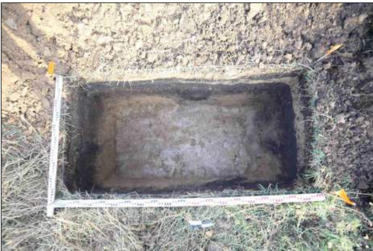
Рисунок 384 – «Распределительный газопровод р.п. Чистоозерное». Шурф №4. Дно шурфа. Снято с В.
