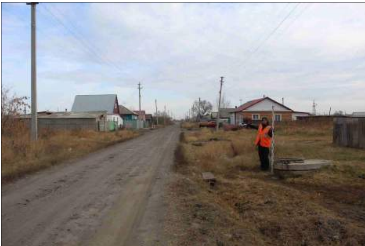
Рисунок 321 – «Распределительный газопровод р.п. Чистоозерное». Вид из точки 17 в направлении точки 4. Снято с ЮЗ.
