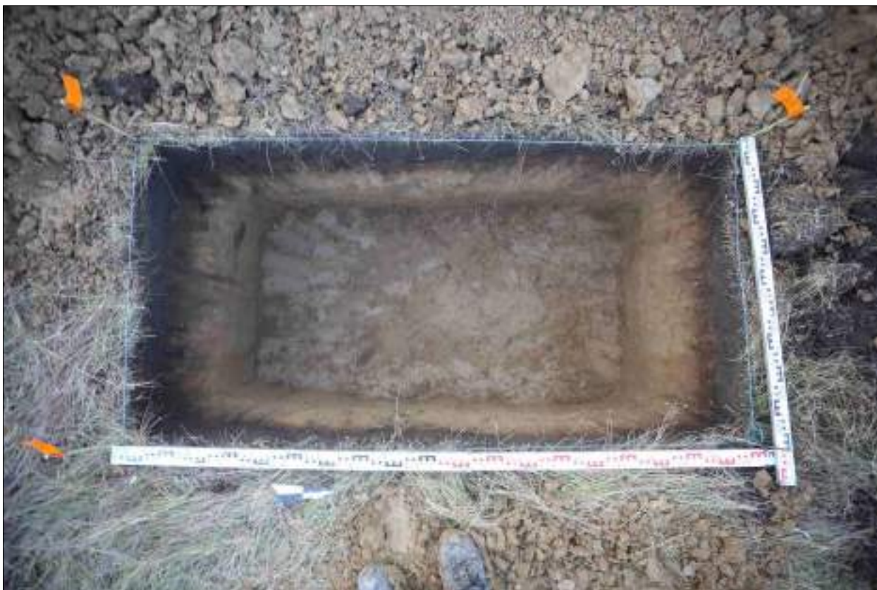
Рисунок 414 – «Распределительный газопровод р.п. Чистоозерное». Шурф №10. Дно шурфа. Снято с В.
