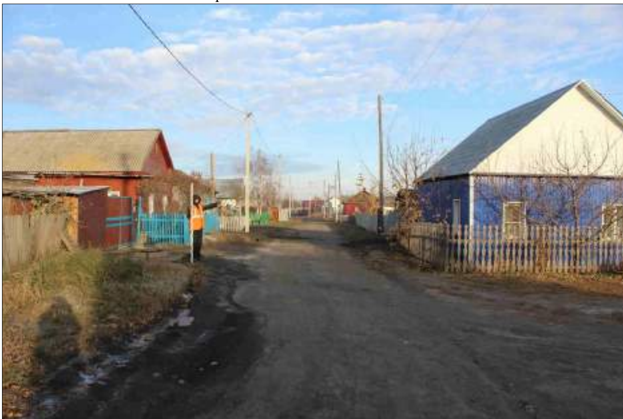
Рисунок 264 – «Распределительный газопровод р.п. Чистоозерное». Вид из точки 40 в направлении точки 39. Снято с ЮВ.
