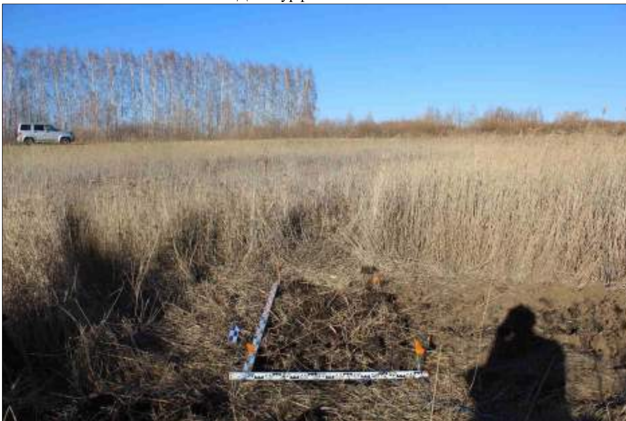
Рисунок 660 – «Распределительный газопровод р.п. Чистоозерное». Шурф №58. Рекультивация. Снято с Ю.
