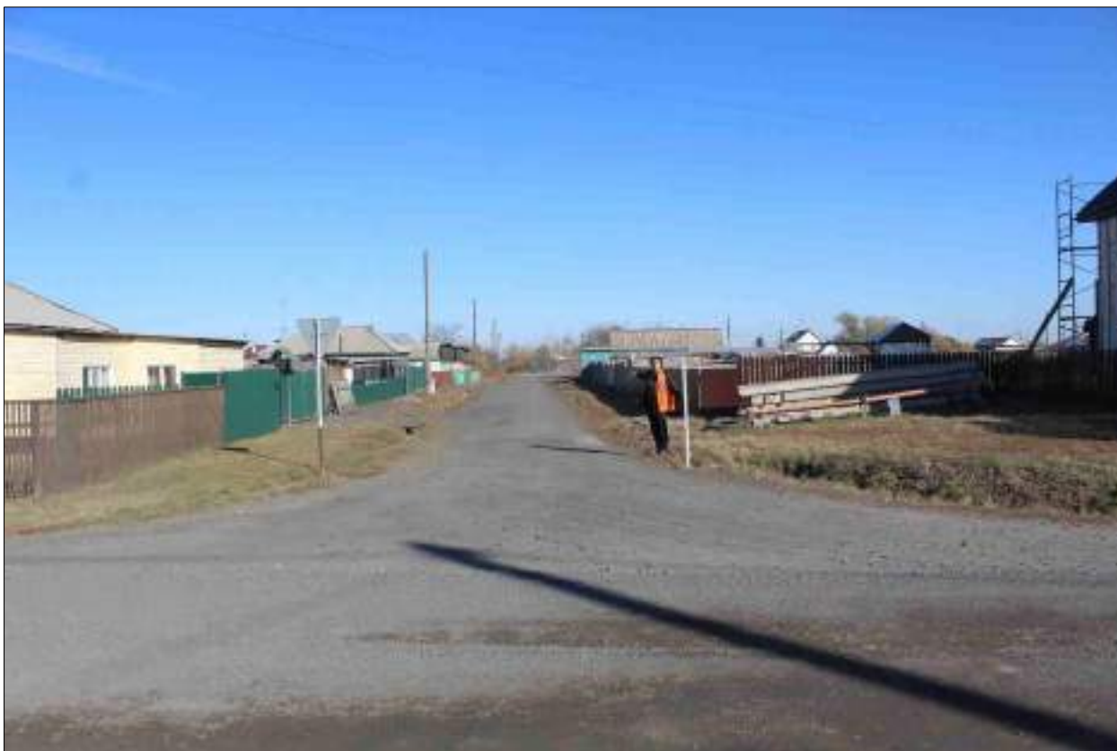
Рисунок 141 – «Распределительный газопровод р.п. Чистоозерное». Вид из точки 110 в направлении точки 111. Снято с ЮЗ.
