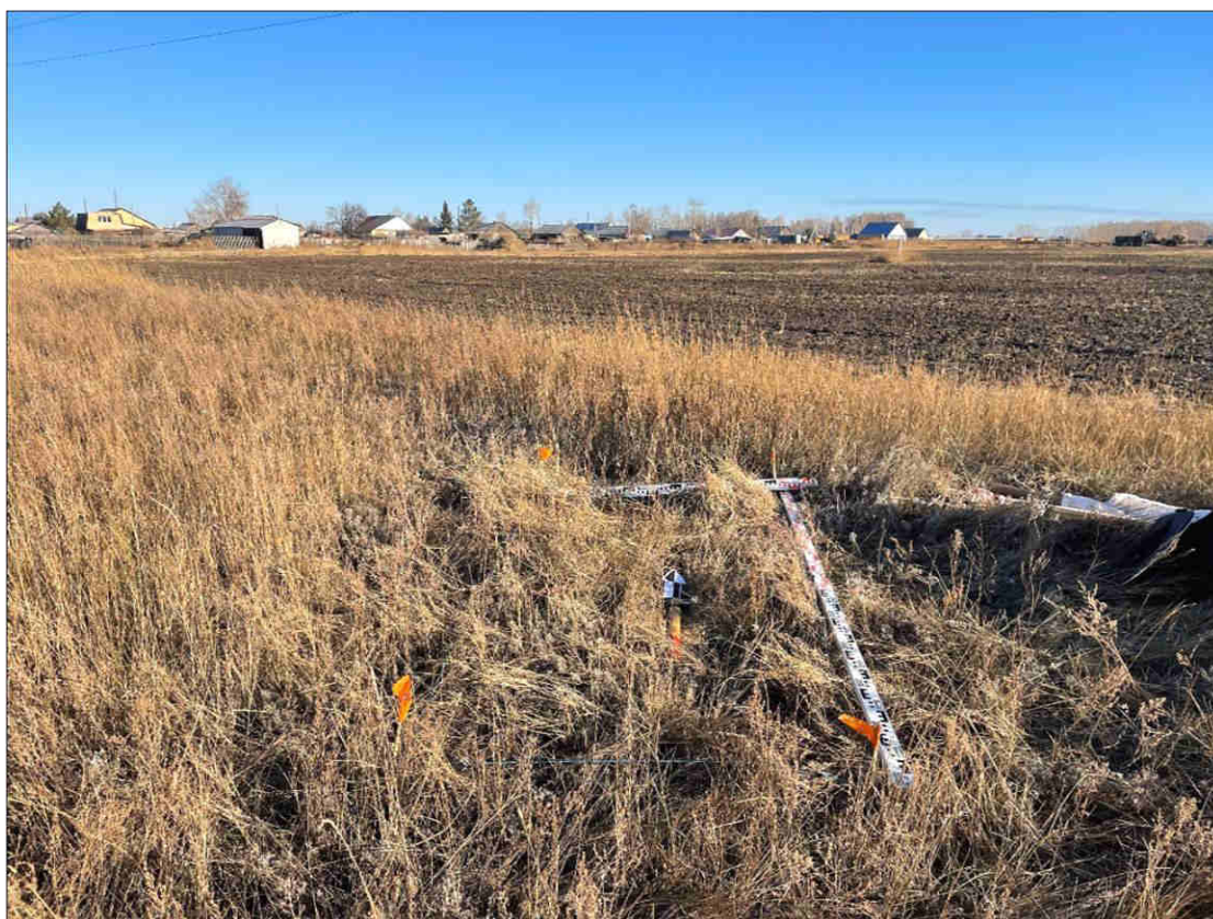
Рисунок 504 – «Распределительный газопровод р.п. Чистоозерное». Шурф №28. Общий вид. Разбивка. Снято с Ю.
