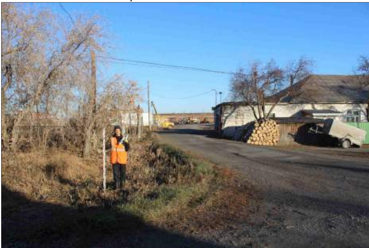
Рисунок 32 – «Распределительный газопровод р.п. Чистоозерное». Вид из точки 176 в направлении точки 177. Снято с ЮВ.
