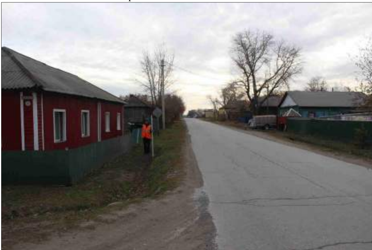
Рисунок 330 – «Распределительный газопровод р.п. Чистоозерное». Вид из точки 19 в направлении точки 22. Снято с СЗ.
