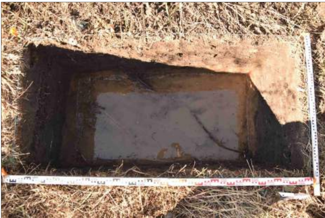
Рисунок 572 – «Распределительный газопровод р.п. Чистоозерное». Шурф №41. Дно шурфа. Снято с В.
