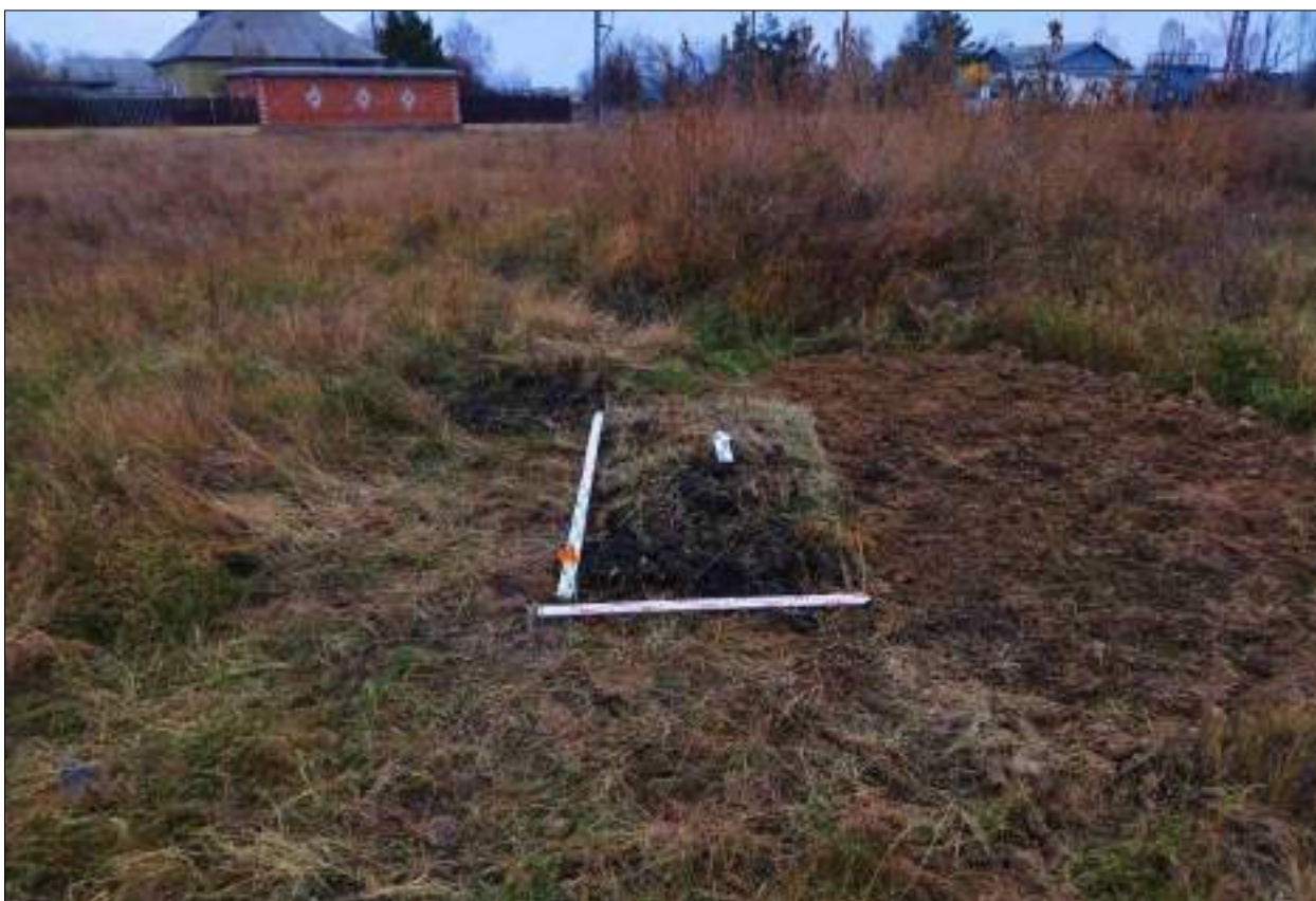
Рисунок 405 – «Распределительный газопровод р.п. Чистоозерное». Шурф №8. Рекультивация. Снято с Ю.
