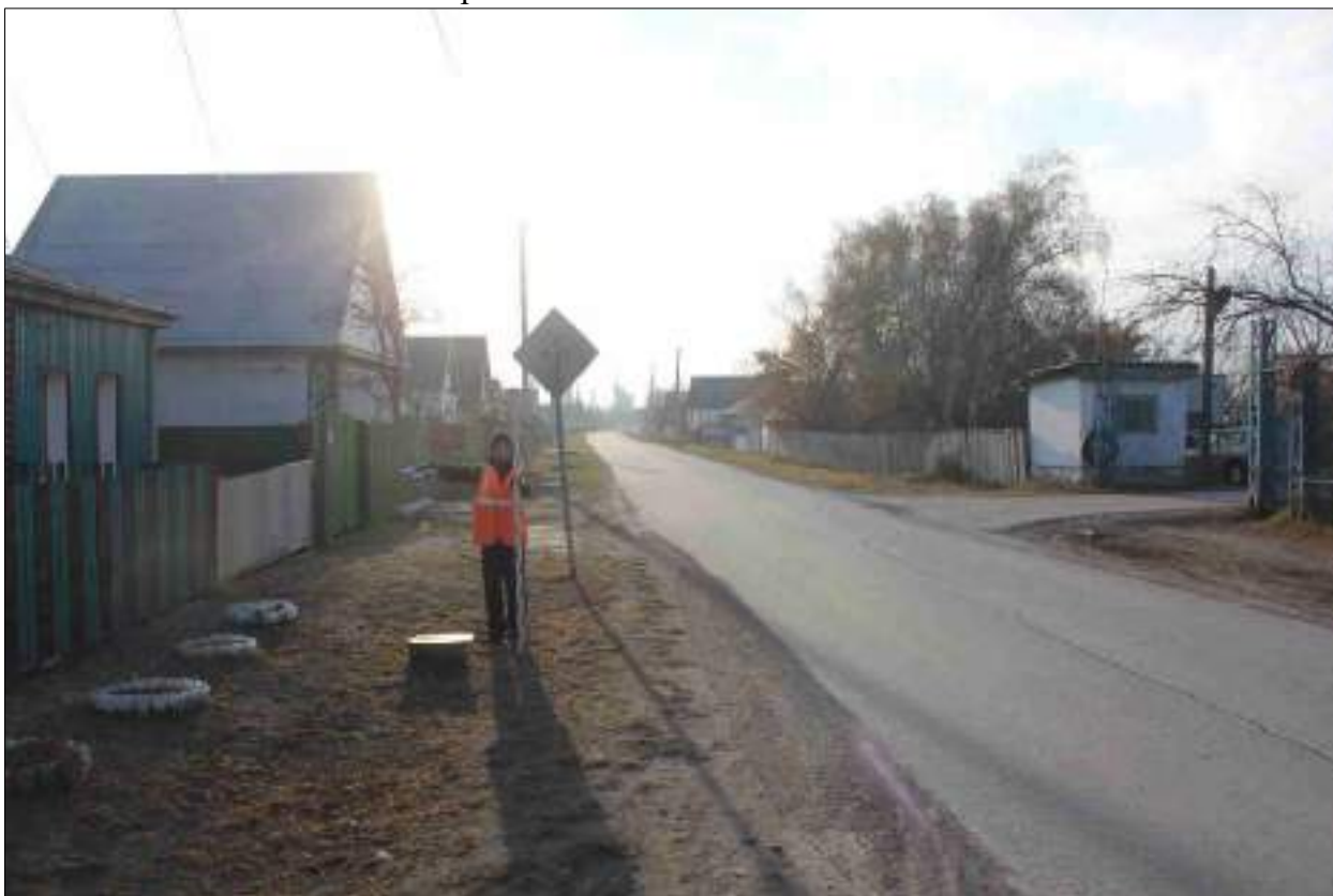
Рисунок 284 – «Распределительный газопровод р.п. Чистоозерное». Вид из точки 46 в направлении точки 42. Снято с СЗ.
