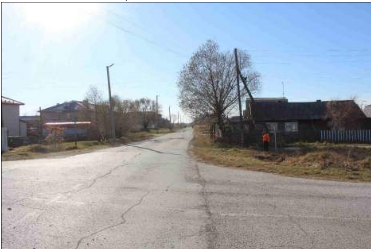
Рисунок 152 – «Распределительный газопровод р.п. Чистоозерное». Вид из точки 156 в направлении точки 160. Снято с СВ.
