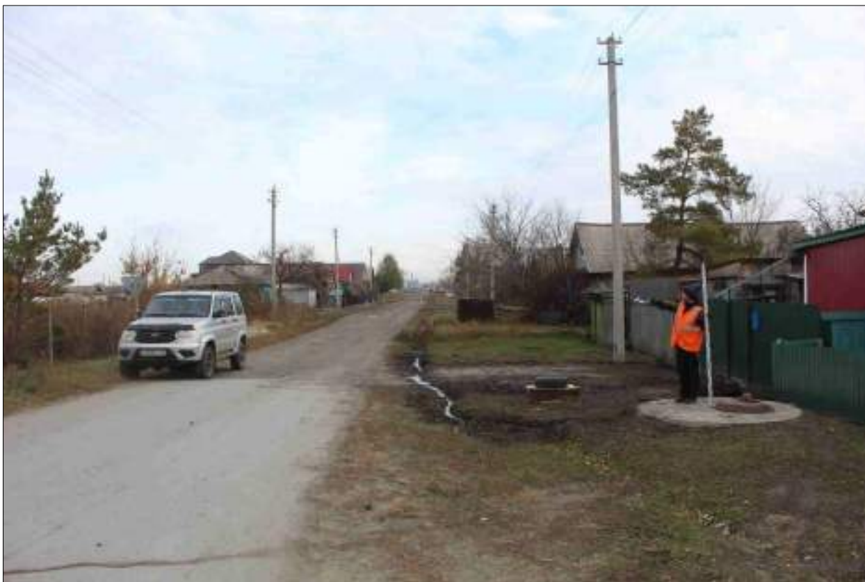
Рисунок 329 – «Распределительный газопровод р.п. Чистоозерное». Вид из точки 19 в направлении точки 18. Снято с ЮЗ.
