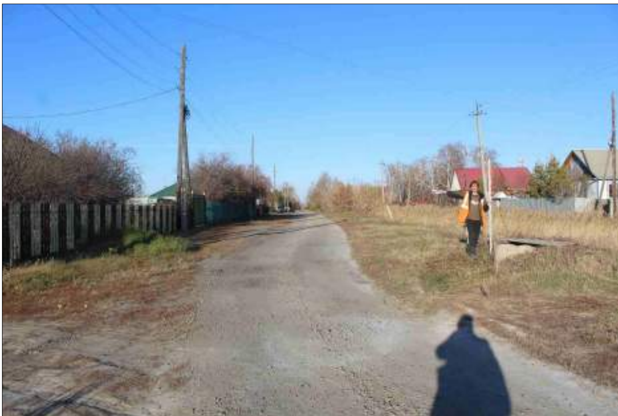
Рисунок 219 – «Распределительный газопровод р.п. Чистоозерное». Вид из точки 69 в направлении точки 68. Снято с ЮЗ.
