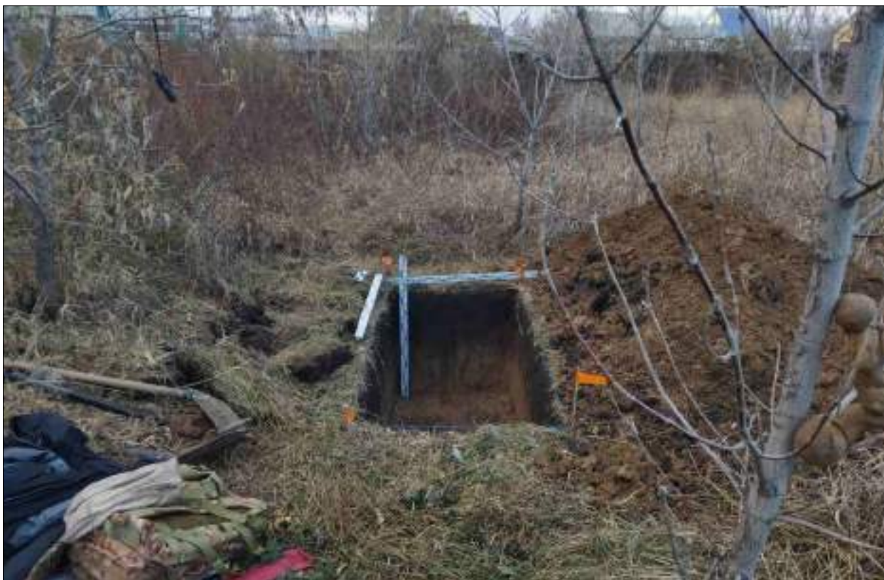
Рисунок 407 – «Распределительный газопровод р.п. Чистоозерное». Шурф №9. Общий вид выполненного шурфа. Снято с Ю.
