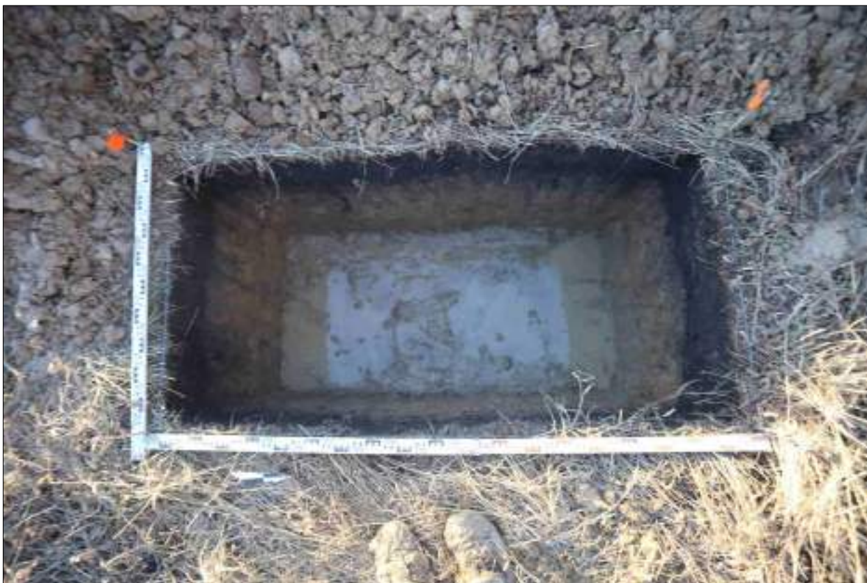
Рисунок 557 – «Распределительный газопровод р.п. Чистоозерное». Шурф №38. Дно шурфа. Снято с В.
