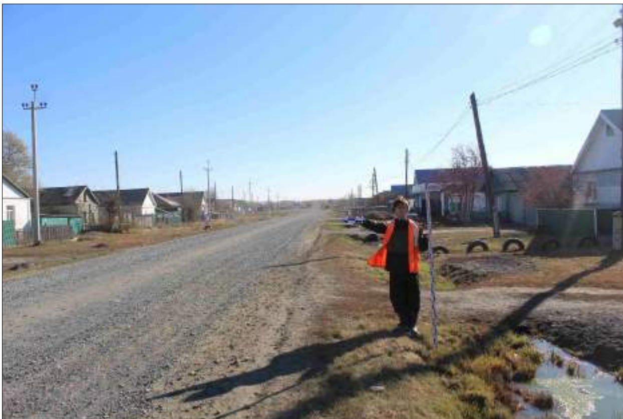
Рисунок 123 – «Распределительный газопровод р.п. Чистоозерное». Вид из точки 111 в направлении точки 93. Снято с СЗ.
