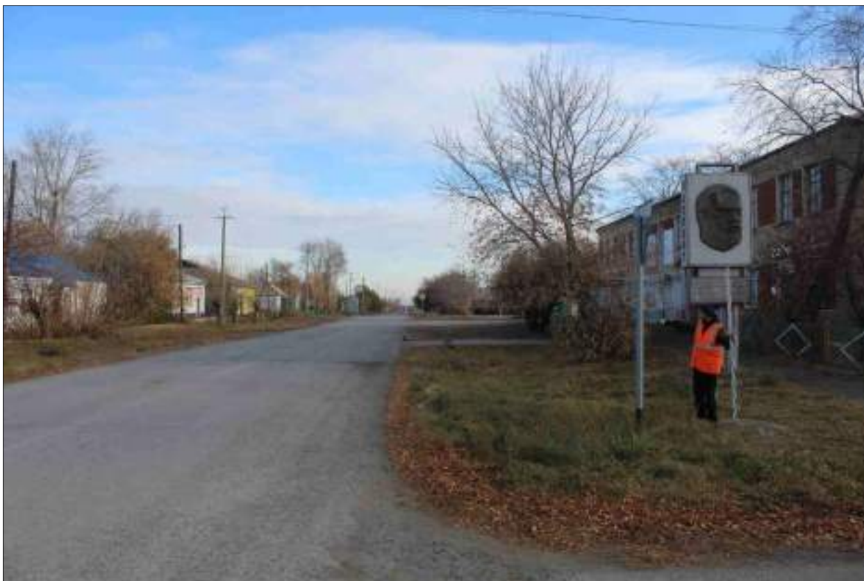
Рисунок 301 – «Распределительный газопровод р.п. Чистоозерное». Вид из точки 21 в направлении точки 22. Снято с ЮЗ.
