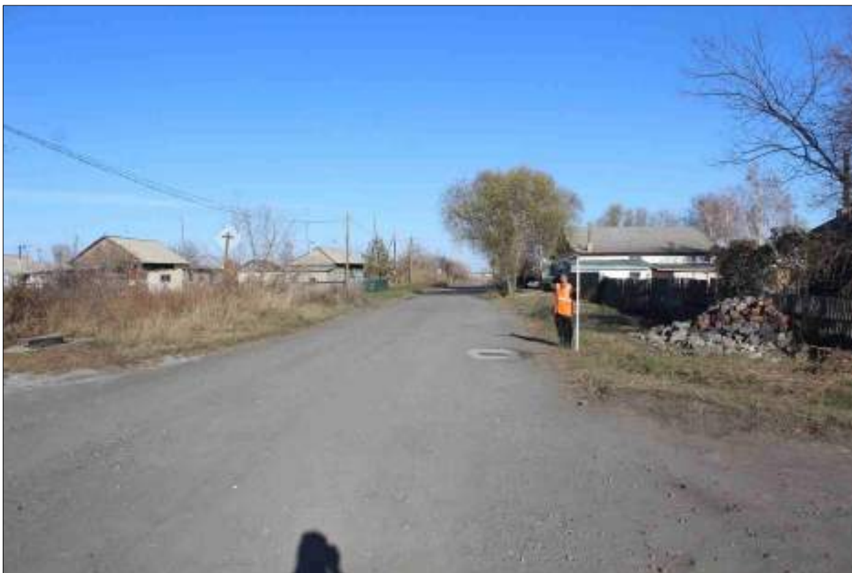
Рисунок 171 – «Распределительный газопровод р.п. Чистоозерное». Вид из точки 119 в направлении точки 118. Снято с ЮЗ.
