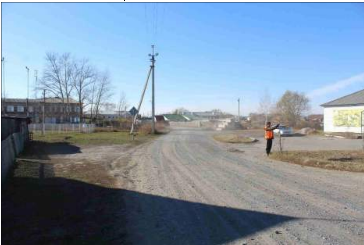
Рисунок 144 – «Распределительный газопровод р.п. Чистоозерное». Вид из точки 121 в направлении точки 157. Снято с СВ.
