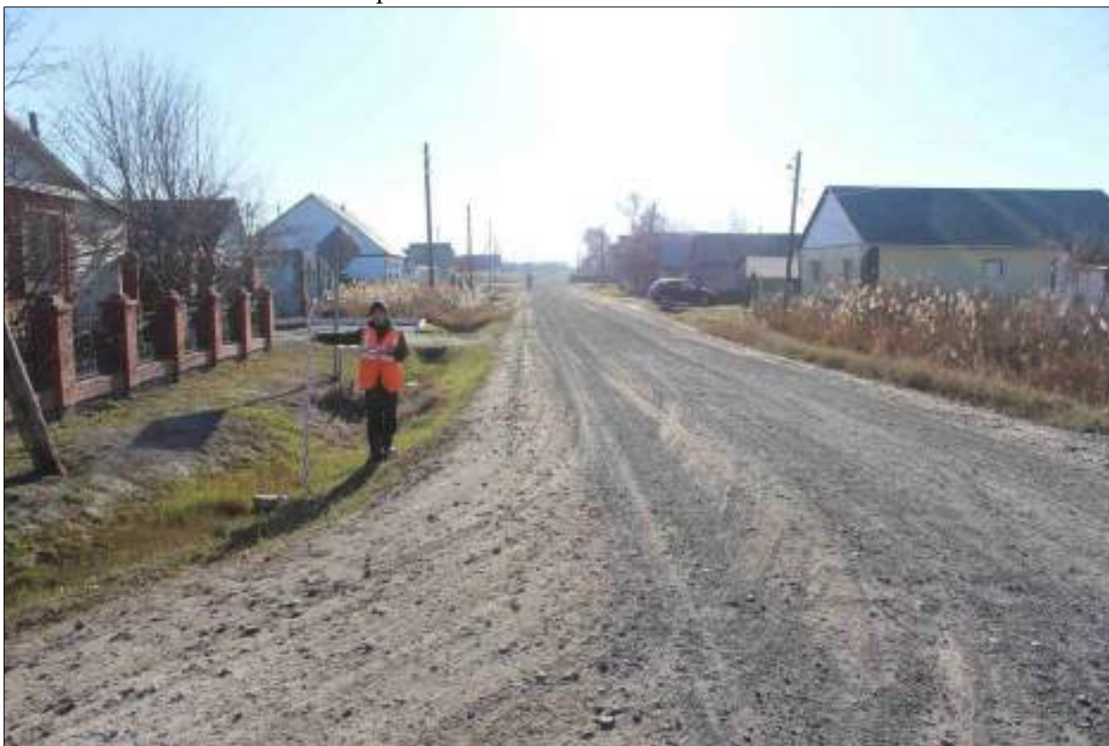
Рисунок 68 – «Распределительный газопровод р.п. Чистоозерное». Вид из точки 154 в направлении точки 124. Снято с СЗ.
