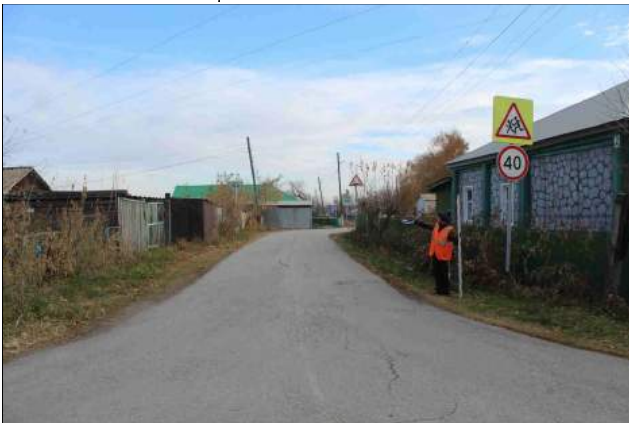
Рисунок 308 – «Распределительный газопровод р.п. Чистоозерное». Вид из точки 26 в направлении точки 27. Снято с ЮЗ.
