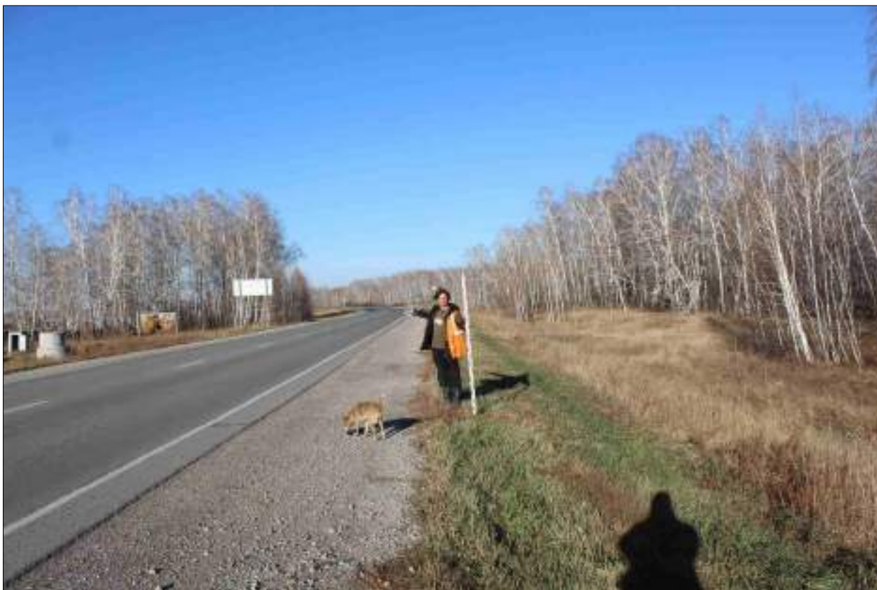
Рисунок 201 – «Распределительный газопровод р.п. Чистоозерное». Вид из точки 191 в направлении точки 86. Снято с ЮЗ.
