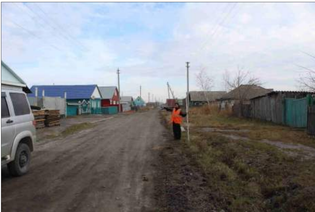
Рисунок 325 – «Распределительный газопровод р.п. Чистоозерное». Вид из точки 18 в направлении точки 17. Снято с ЮЗ.
