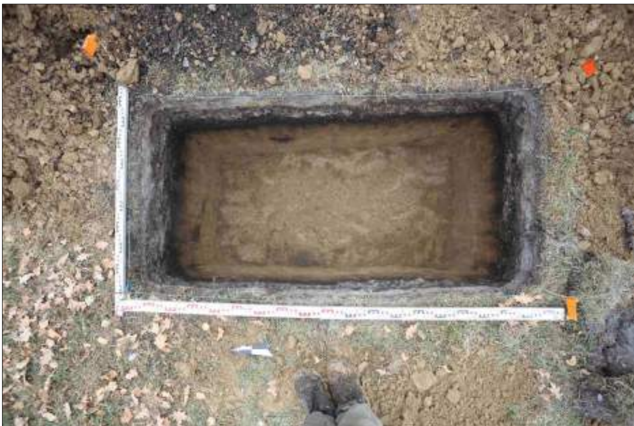
Рисунок 547 – «Распределительный газопровод р.п. Чистоозерное». Шурф №36. Дно шурфа. Снято с З.
