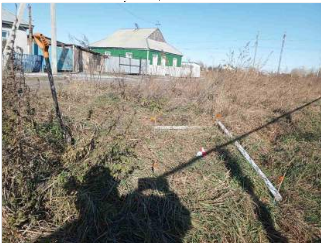
Рисунок 476 – «Распределительный газопровод р.п. Чистоозерное». Шурф №23. Общий вид. Разбивка. Снято с Ю.
