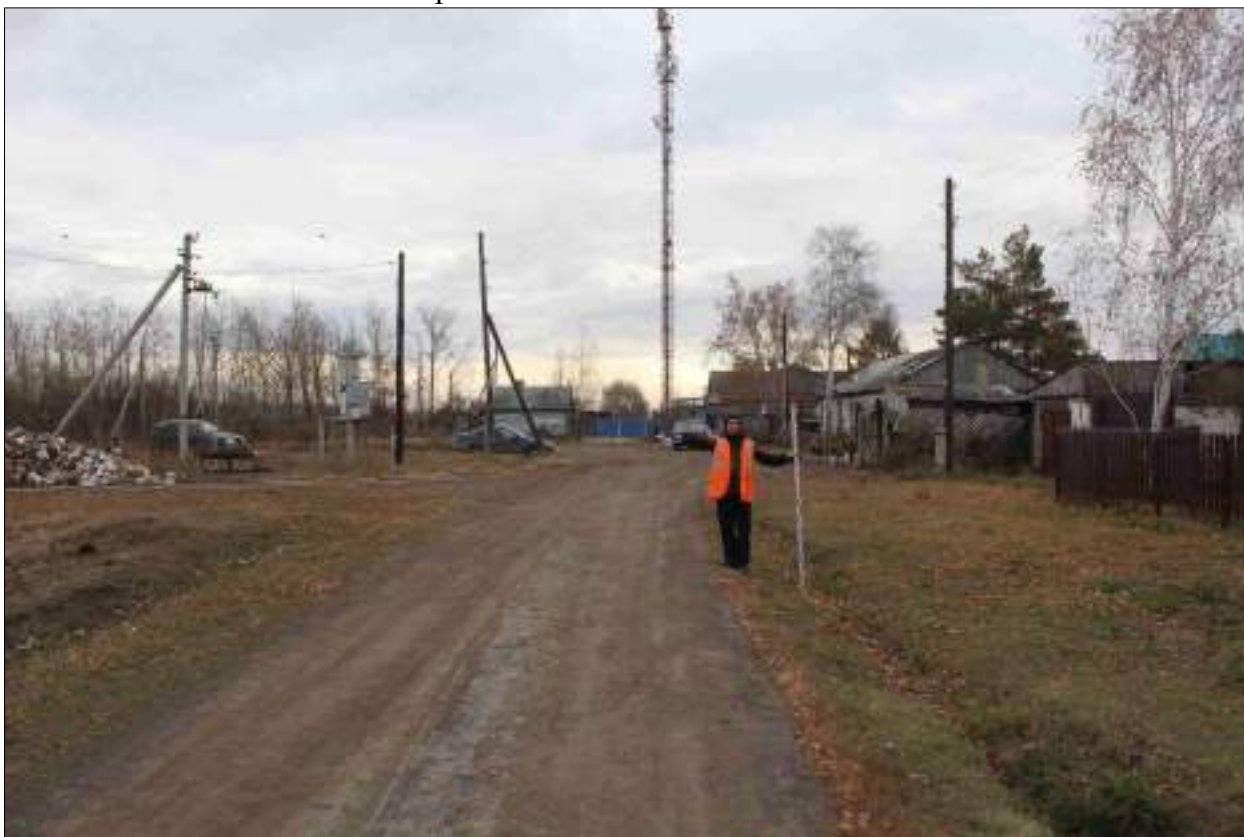
Рисунок 352 – «Распределительный газопровод р.п. Чистоозерное». Вид на точку 7. Снято с СЗ.
