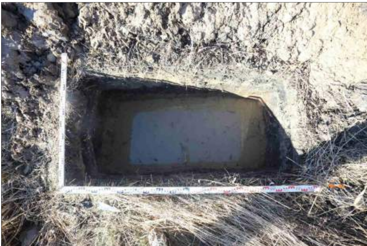
Рисунок 492 – «Распределительный газопровод р.п. Чистоозерное». Шурф №25. Дно шурфа. Снято с В.
