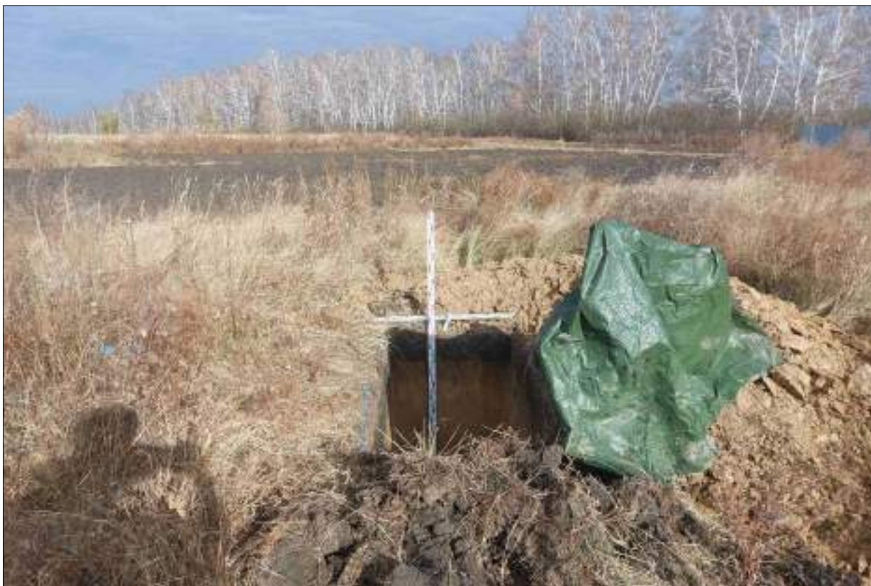
Рисунок 437 – «Распределительный газопровод р.п. Чистоозерное». Шурф №15. Общий вид выполненного шурфа. Снято с Ю.
