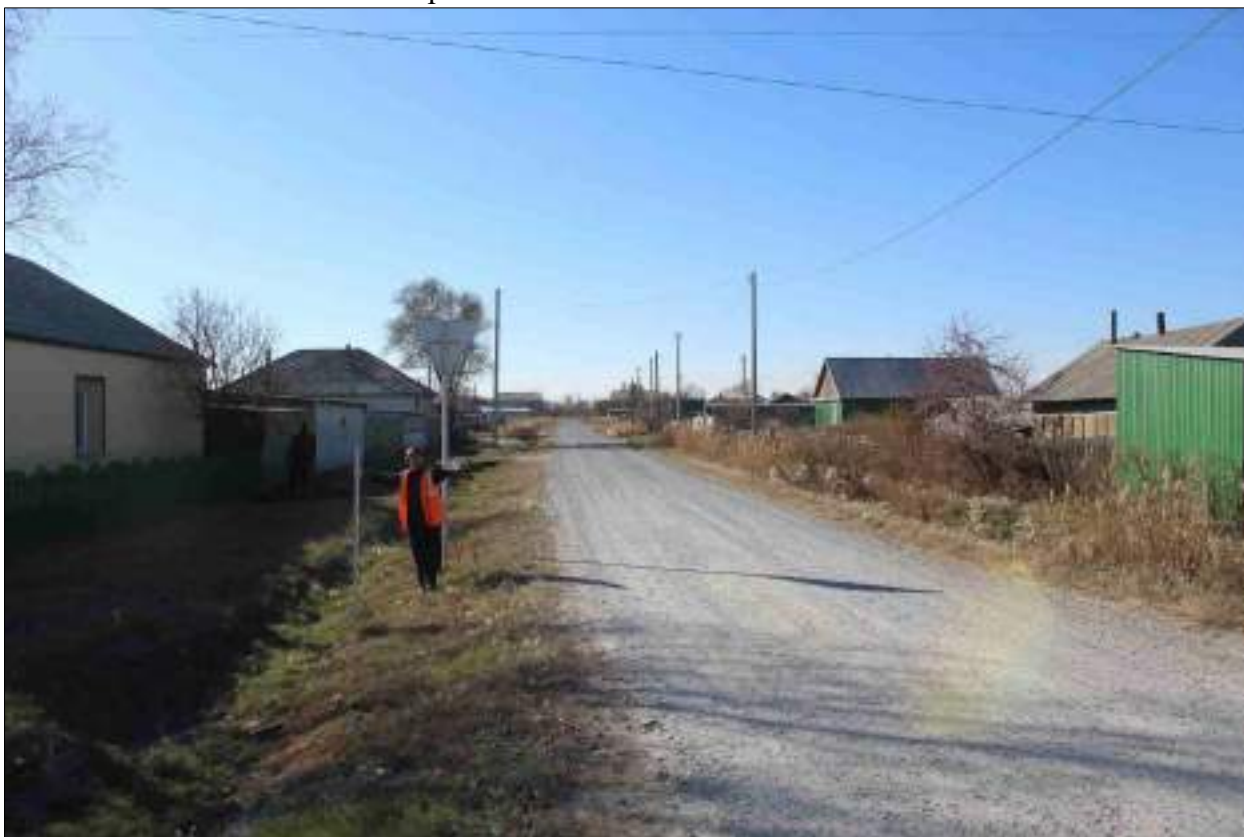
Рисунок 128 – «Распределительный газопровод р.п. Чистоозерное». Вид из точки 93 в направлении точки 94. Снято с СВ.
