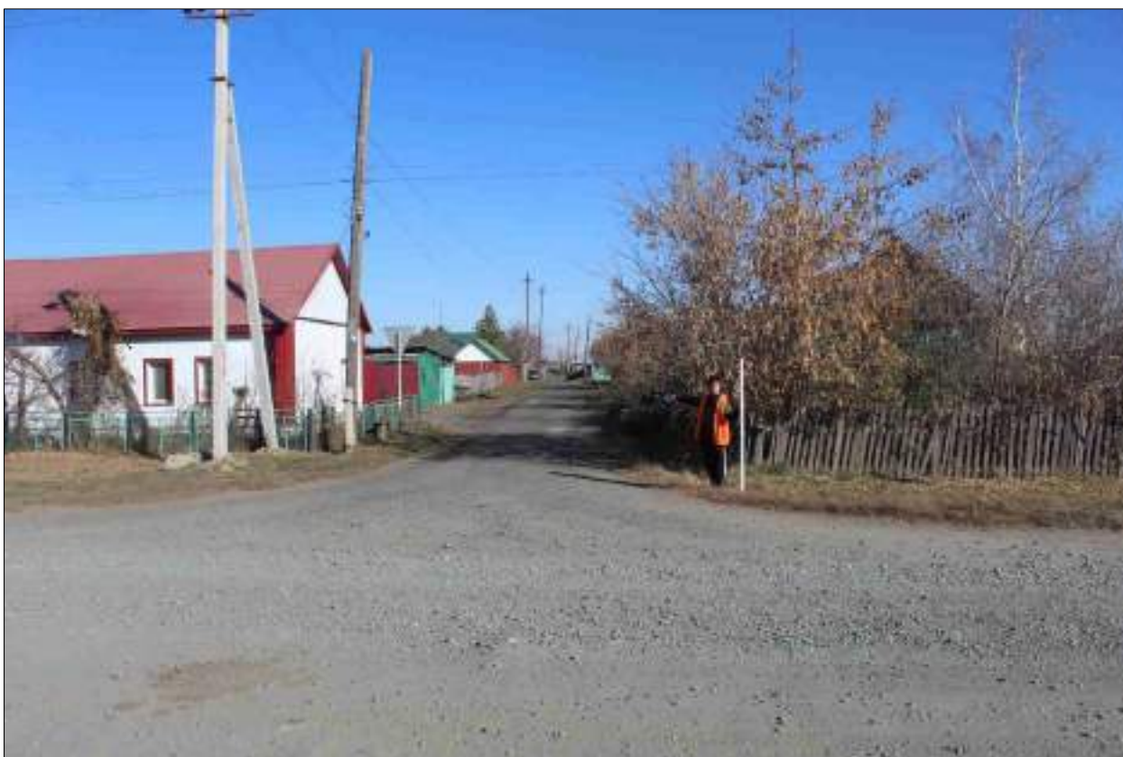
Рисунок 121 – «Распределительный газопровод р.п. Чистоозерное». Вид из точки 111 в направлении точки 112. Снято с ЮЗ.
