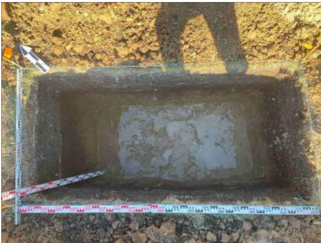
Рисунок 648 – «Распределительный газопровод р.п. Чистоозерное». Шурф №56. Дно шурфа. Снято с Ю.
