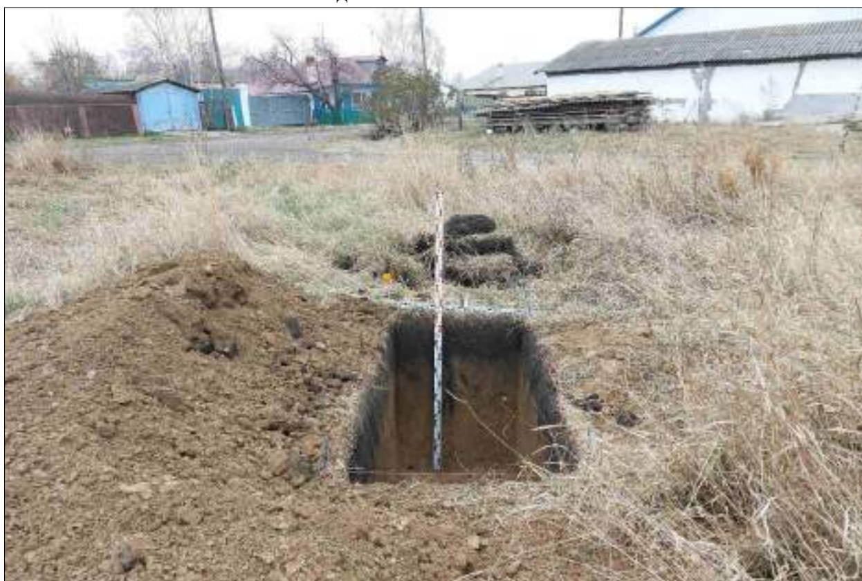
Рисунок 540 – «Распределительный газопровод р.п. Чистоозерное». Шурф №35. Общий вид выполненного шурфа. Снято с С.
