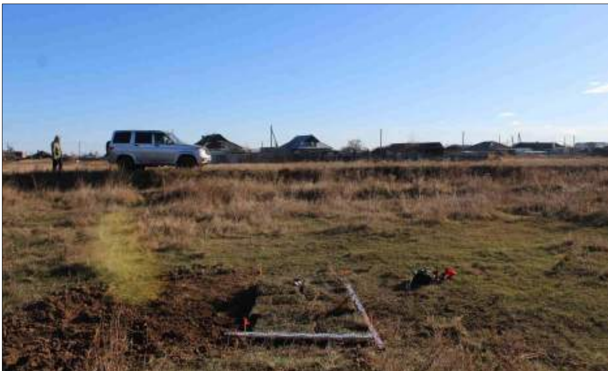
Рисунок 475 – «Распределительный газопровод р.п. Чистоозерное». Шурф №22. Рекультивация. Снято с С.
