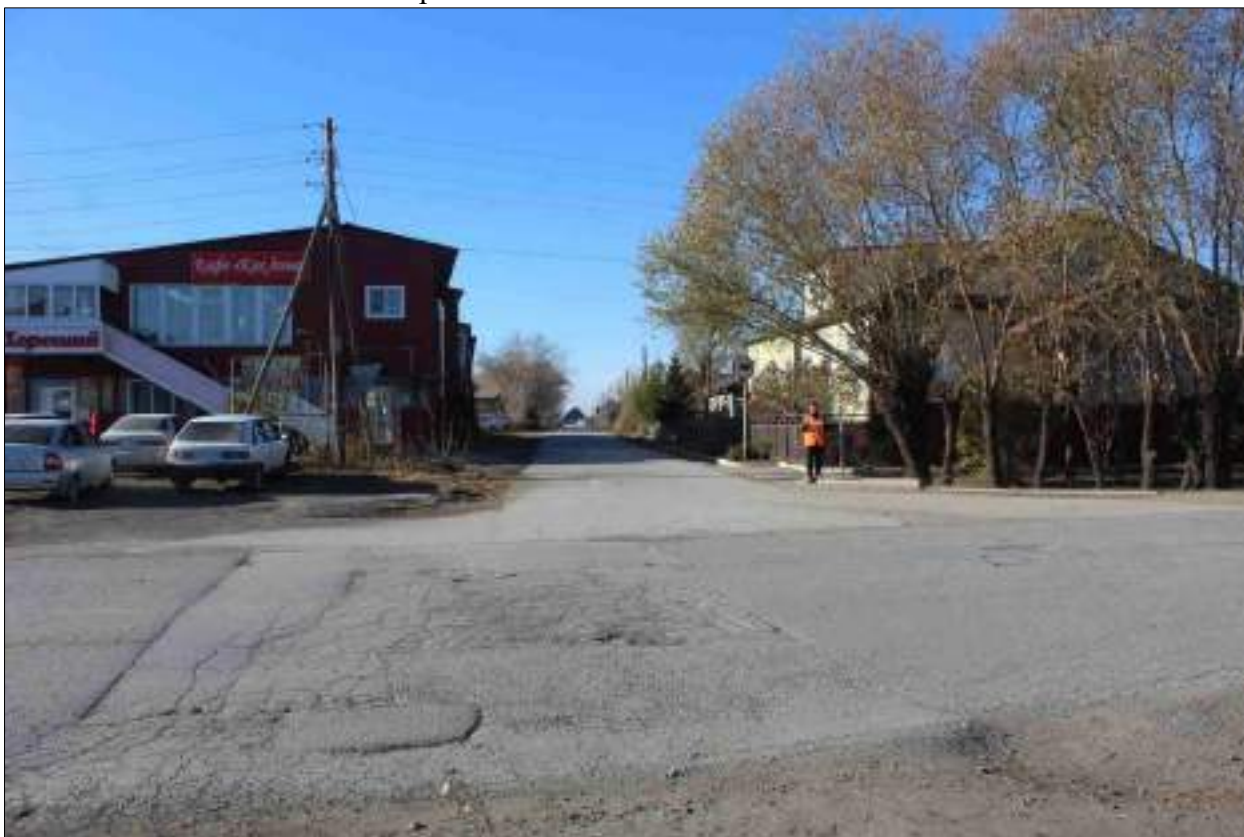
Рисунок 76 – «Распределительный газопровод р.п. Чистоозерное». Вид из точки 136 в направлении точки 152. Снято с СВ.
