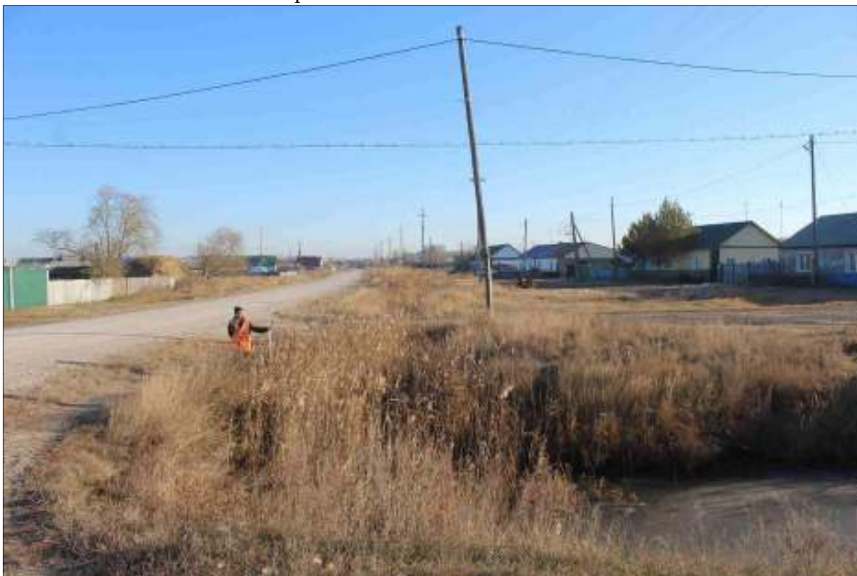
Рисунок 44 – «Распределительный газопровод р.п. Чистоозерное». Вид из точки 167 в направлении точки 168. Снято с ЮЗ.
