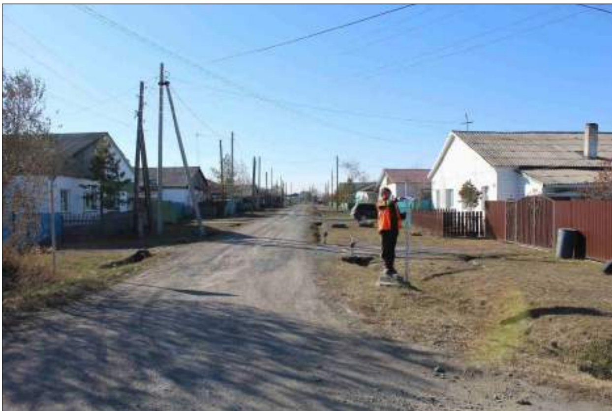
Рисунок 131 – «Распределительный газопровод р.п. Чистоозерное». Вид из точки 106 в направлении точки 105. Снято с СВ.
