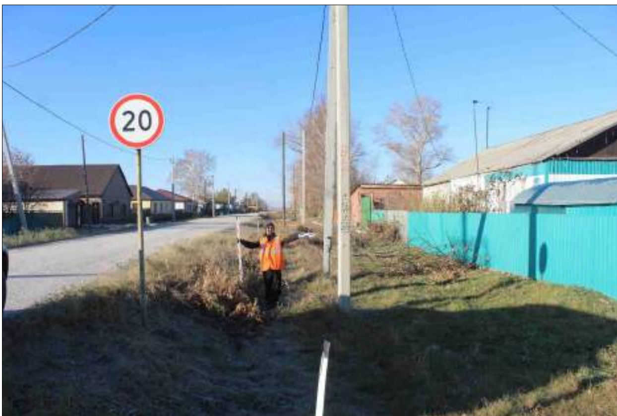
Рисунок 39 – «Распределительный газопровод р.п. Чистоозерное». Вид из точки 173 в направлении точки 174. Снято с В.
