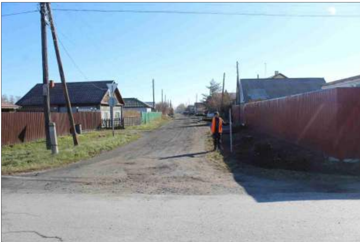
Рисунок 111 – «Распределительный газопровод р.п. Чистоозерное». Вид из точки 128 в направлении точки 118. Снято с СЗ.
