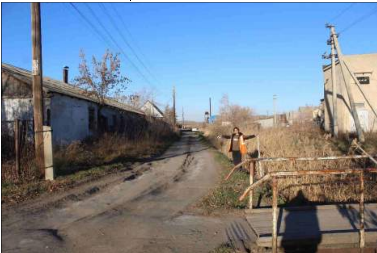
Рисунок 222 – «Распределительный газопровод р.п. Чистоозерное». Вид из точки 67 в направлении точки 66. Снято с ЮЗ.
