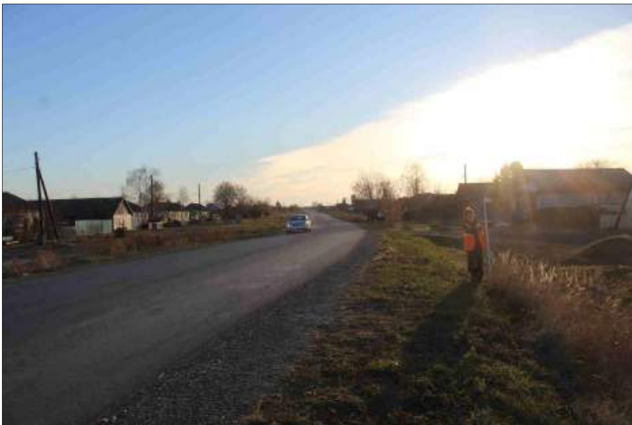
Рисунок 237 – «Распределительный газопровод р.п. Чистоозерное». Вид из точки 64 в направлении точки 63. Снято с СВ.
