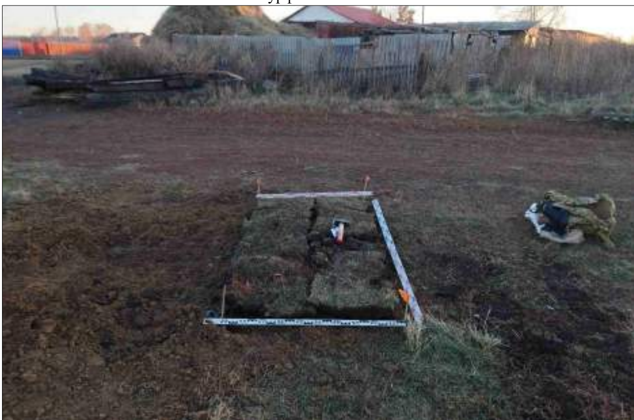
Рисунок 400 – «Распределительный газопровод р.п. Чистоозерное». Шурф №7. Рекультивация. Снято с С.
