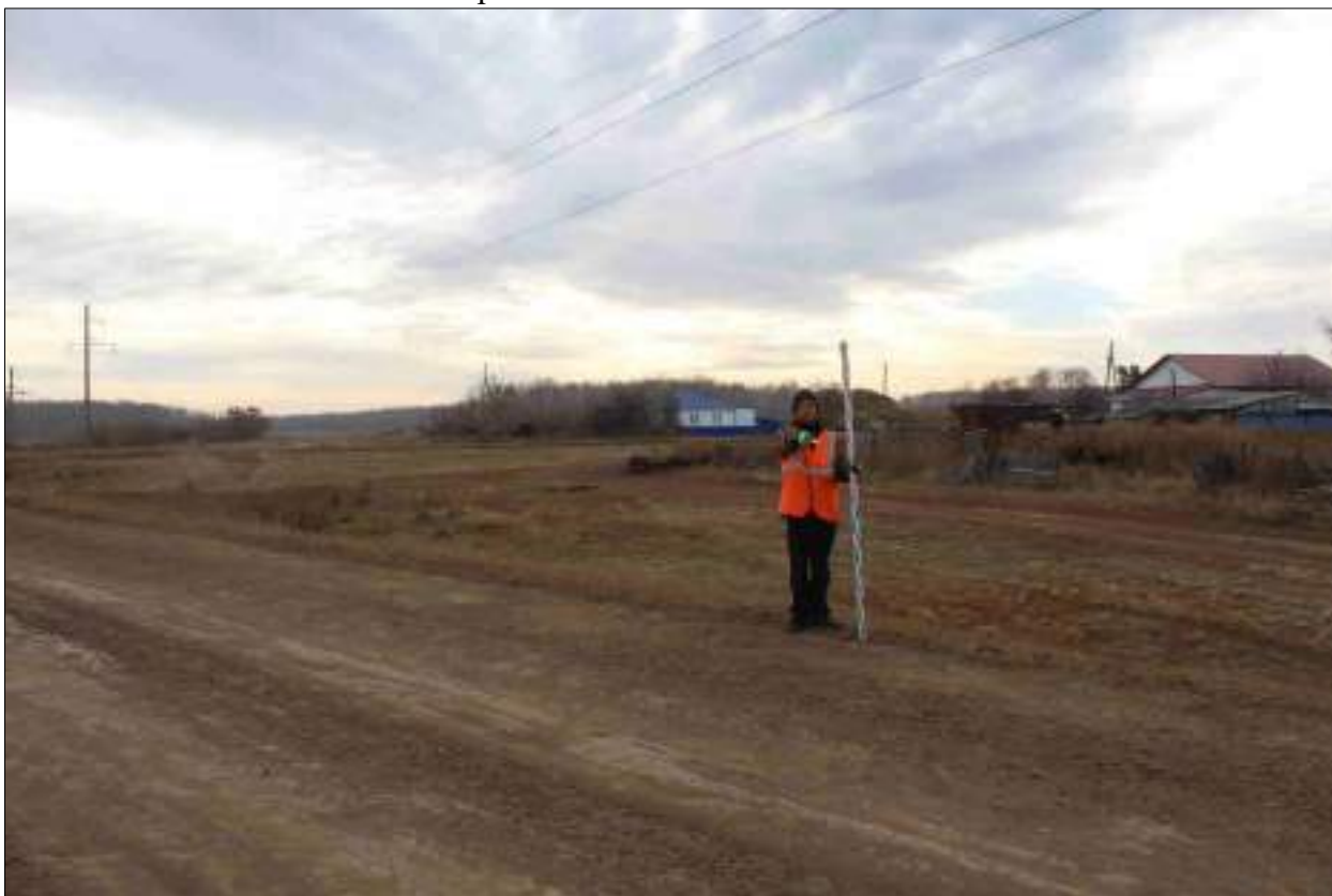
Рисунок 318 – «Распределительный газопровод р.п. Чистоозерное». Вид с грунтовой дороги в направлении точки 2. Снято с С.
