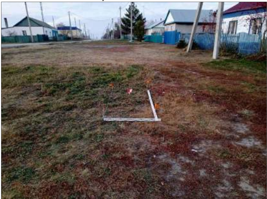
Рисунок 416 – «Распределительный газопровод р.п. Чистоозерное». Шурф №11. Общий вид. Разбивка. Снято с С.
