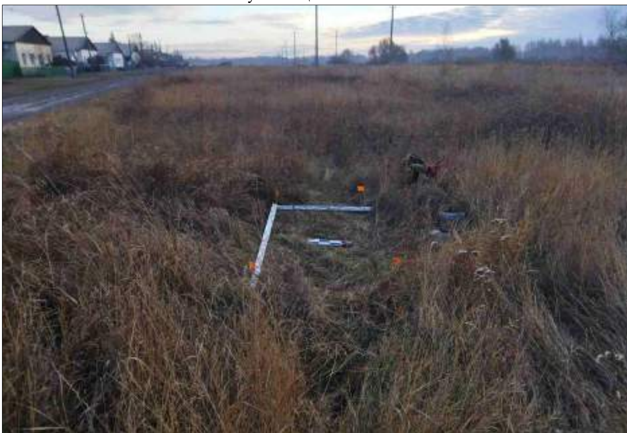
Рисунок 446 – «Распределительный газопровод р.п. Чистоозерное». Шурф №17. Общий вид. Разбивка. Снято с З.
