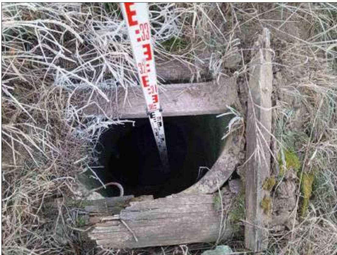
Рисунок 479 – «Распределительный газопровод р.п. Чистоозерное». Шурф №23. Колодец к северо-востоку от шурфа.
