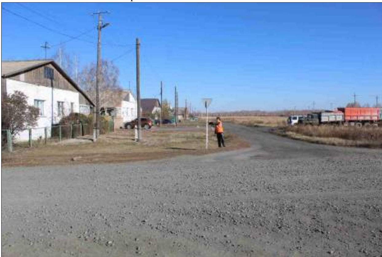
Рисунок 132 – «Распределительный газопровод р.п. Чистоозерное». Вид из точки 103 в направлении точки 104. Снято с ЮЗ.
