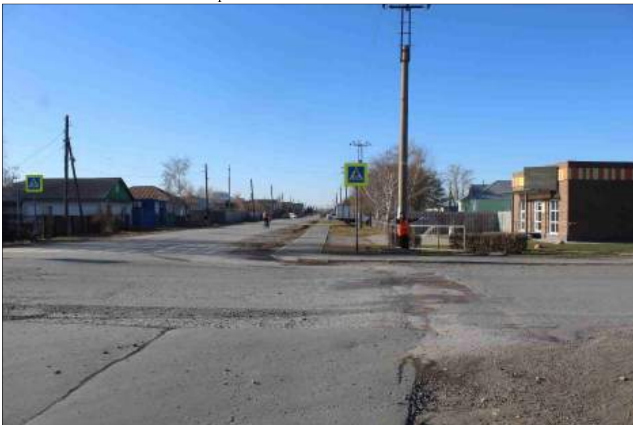
Рисунок 74 – «Распределительный газопровод р.п. Чистоозерное». Вид из точки 134 в направлении точки 153. Снято с СВ.
