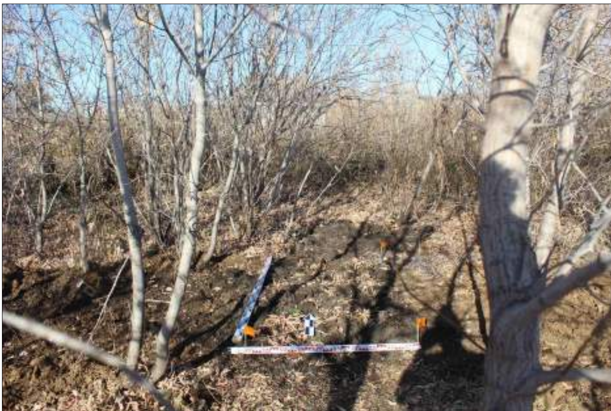
Рисунок 629 – «Распределительный газопровод р.п. Чистоозерное». Шурф №52. Рекультивация. Снято с Ю.
