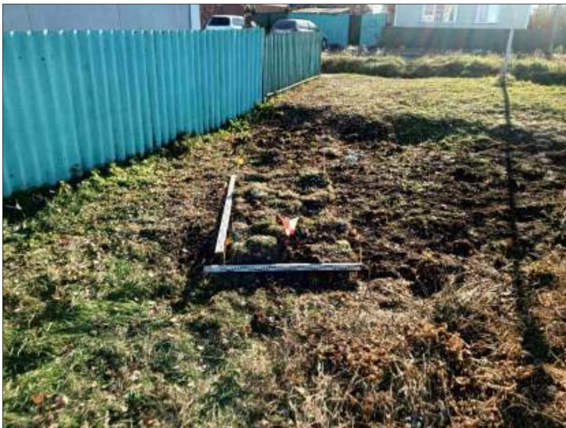
Рисунок 639 – «Распределительный газопровод р.п. Чистоозерное». Шурф №54. Рекультивация. Снято с С.
