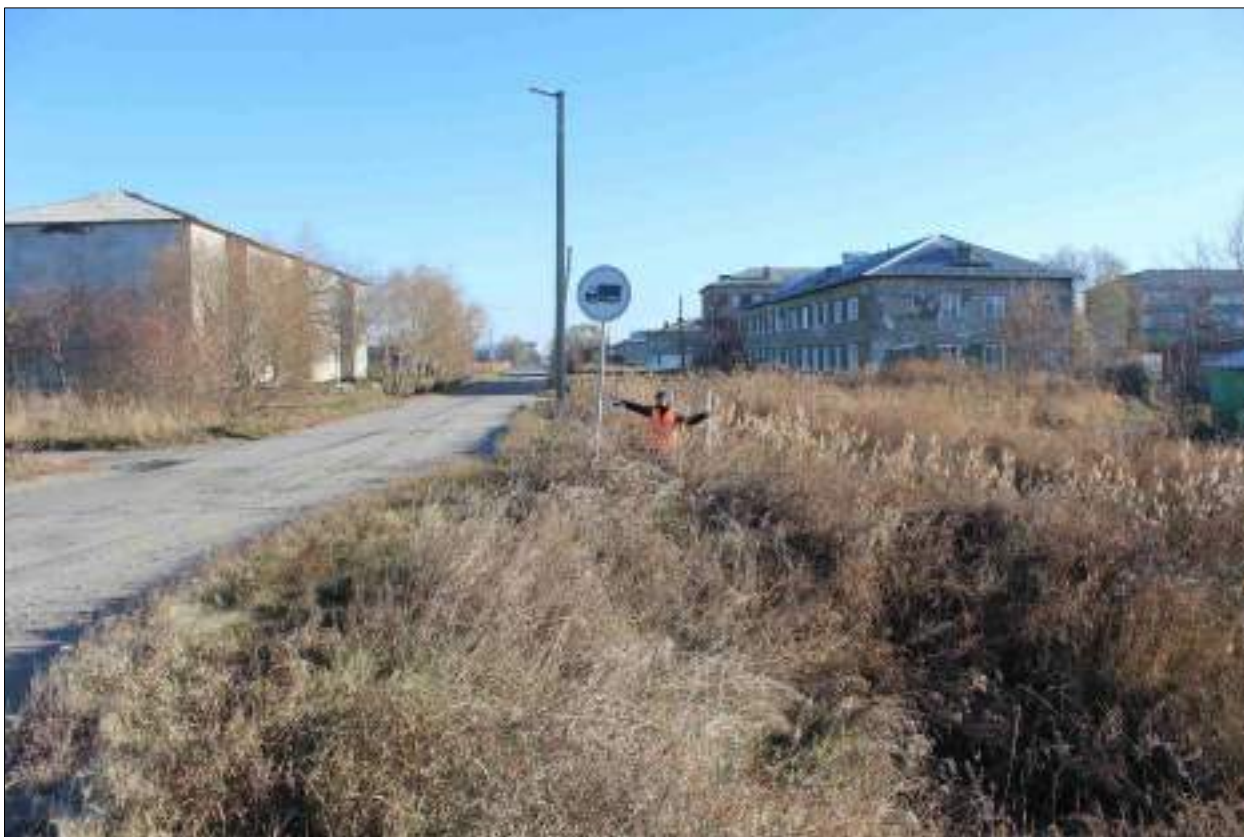
Рисунок 45 – «Распределительный газопровод р.п. Чистоозерное». Вид из точки 162 в направлении точки 160. Снято с ЮЗ.
