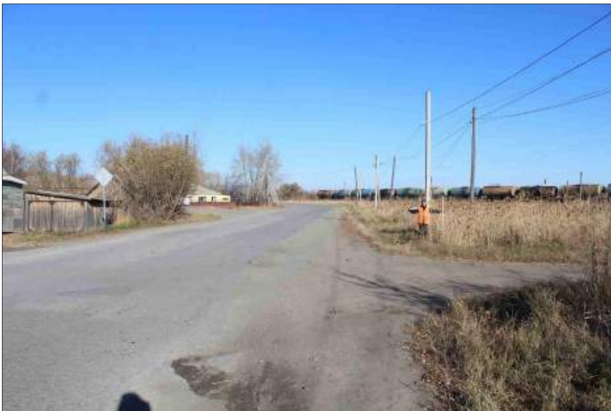
Рисунок 79 – «Распределительный газопровод р.п. Чистоозерное». Вид из точки 138 в направлении точки 140. Снято с ЮВ.
