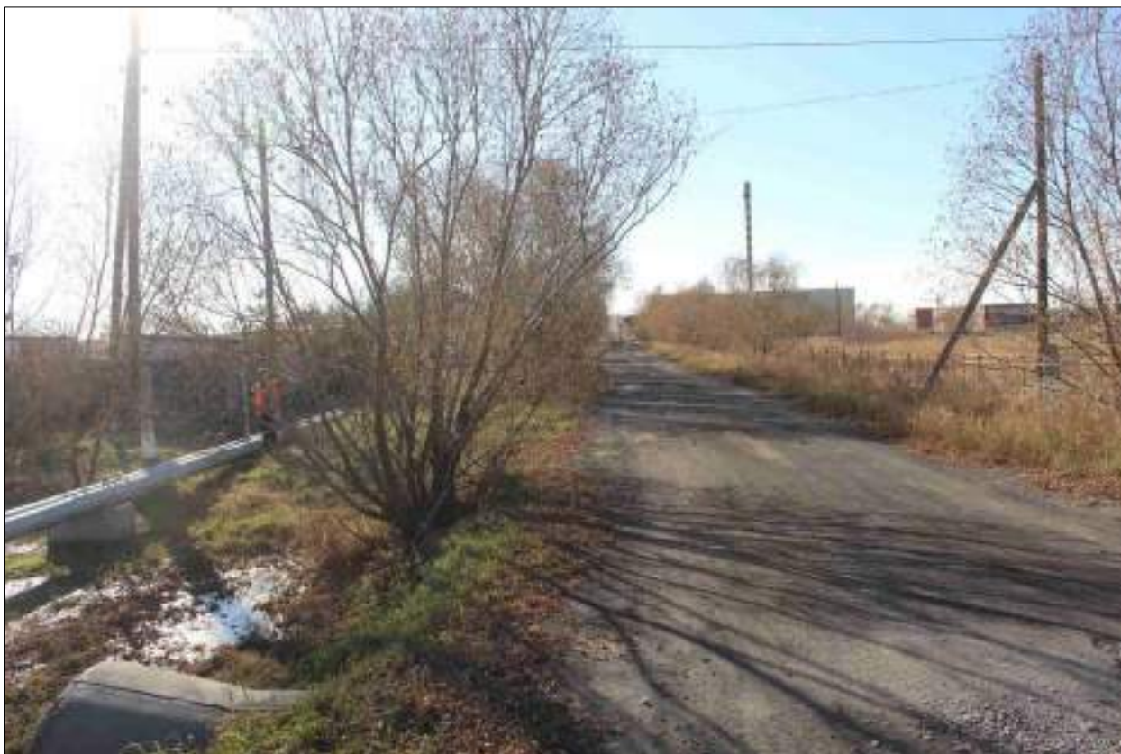
Рисунок 155 – «Распределительный газопровод р.п. Чистоозерное». Вид из точки 158 в направлении точки 159. Снято с СВ.
