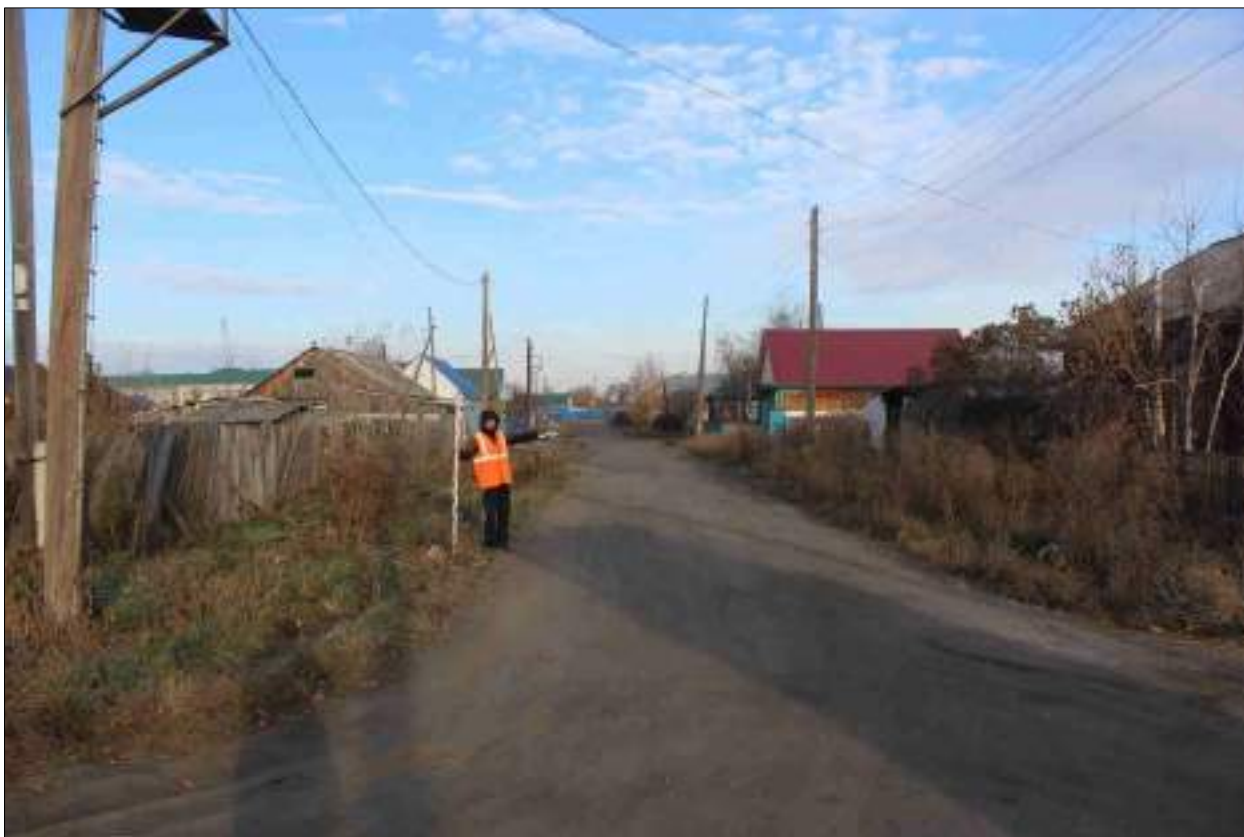
Рисунок 275 – «Распределительный газопровод р.п. Чистоозерное». Вид из точки 34 в направлении точки 35. Снято с ЮВ.
