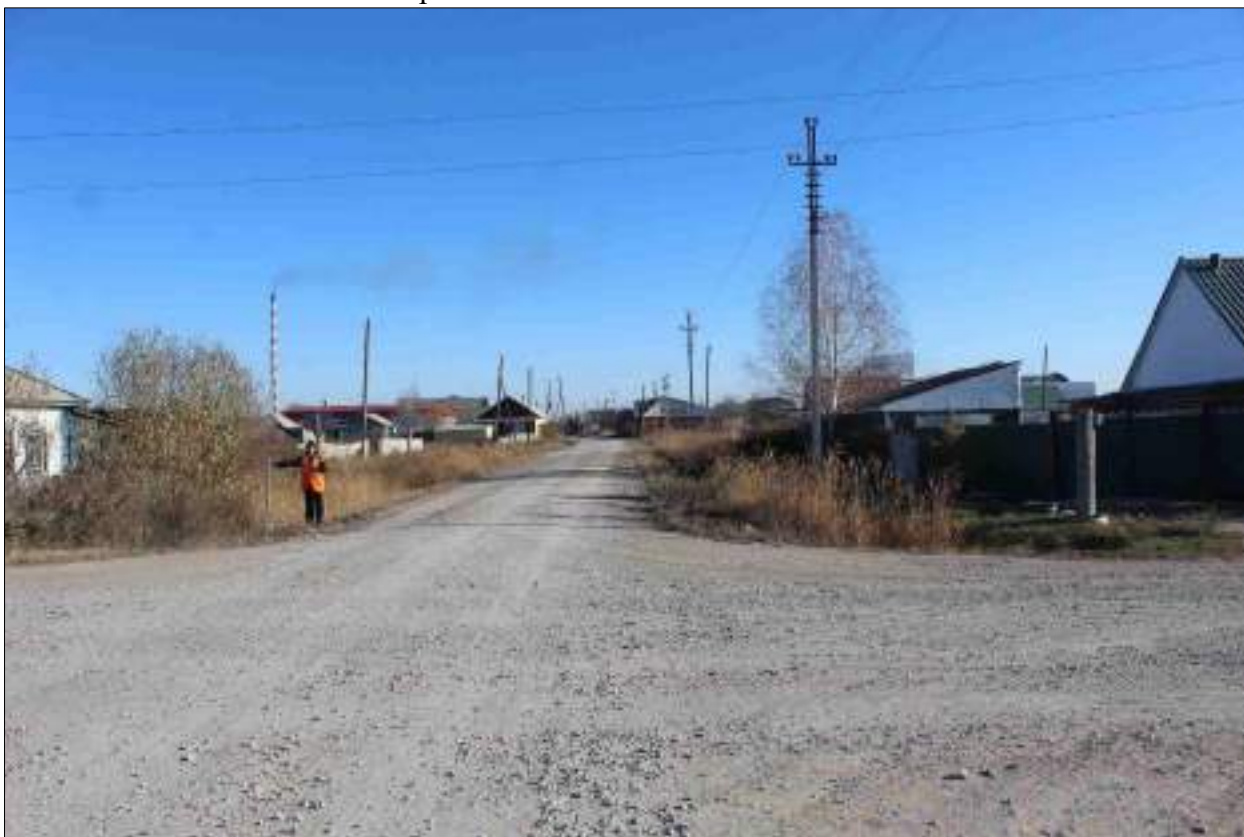
Рисунок 64 – «Распределительный газопровод р.п. Чистоозерное». Вид из точки 155 в направлении точки 154. Снято с З.
