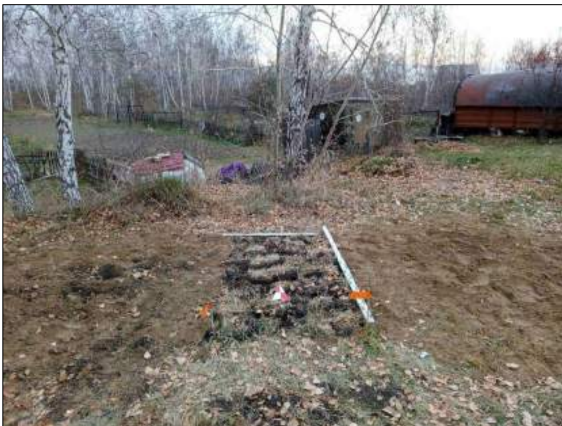
Рисунок 435 – «Распределительный газопровод р.п. Чистоозерное». Шурф №14. Рекультивация. Снято с Ю.
