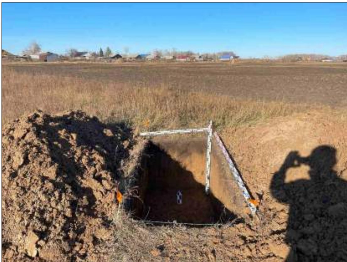
Рисунок 505 – «Распределительный газопровод р.п. Чистоозерное». Шурф №28. Общий вид выполненного шурфа. Снято с Ю.
