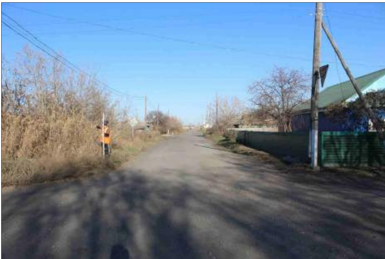
Рисунок 173 – «Распределительный газопровод р.п. Чистоозерное». Вид из точки 118 в направлении точки 117. Снято с ЮЗ.
