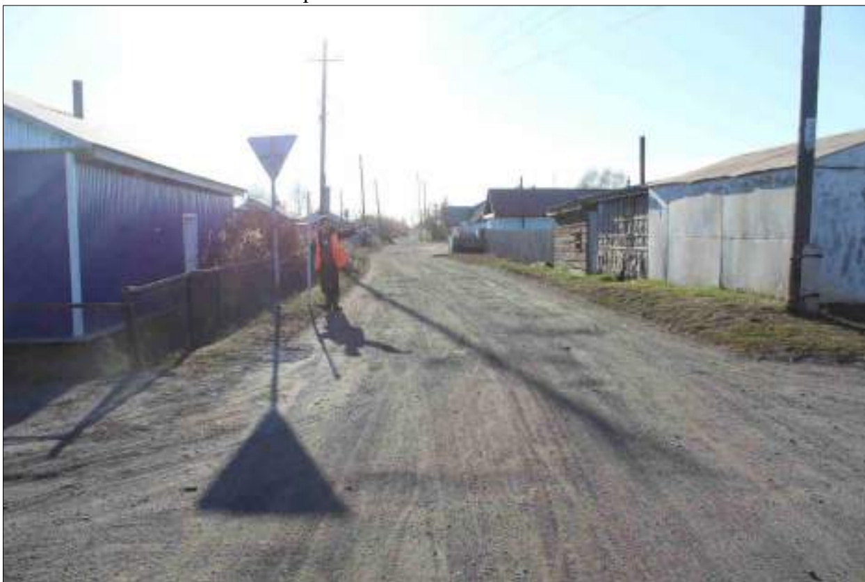
Рисунок 188 – «Распределительный газопровод р.п. Чистоозерное». Вид из точки 113 в направлении точки 112. Снято с СВ.
