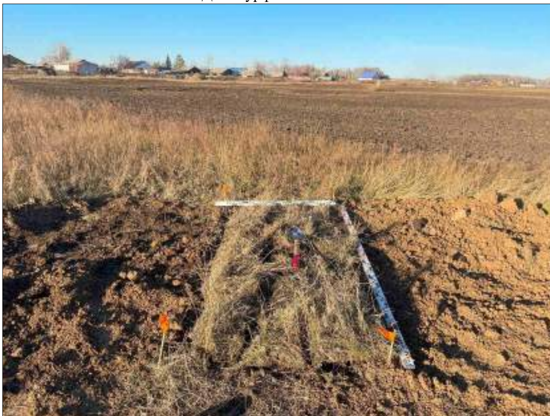
Рисунок 508 – «Распределительный газопровод р.п. Чистоозерное». Шурф №28. Рекультивация. Снято с Ю.
