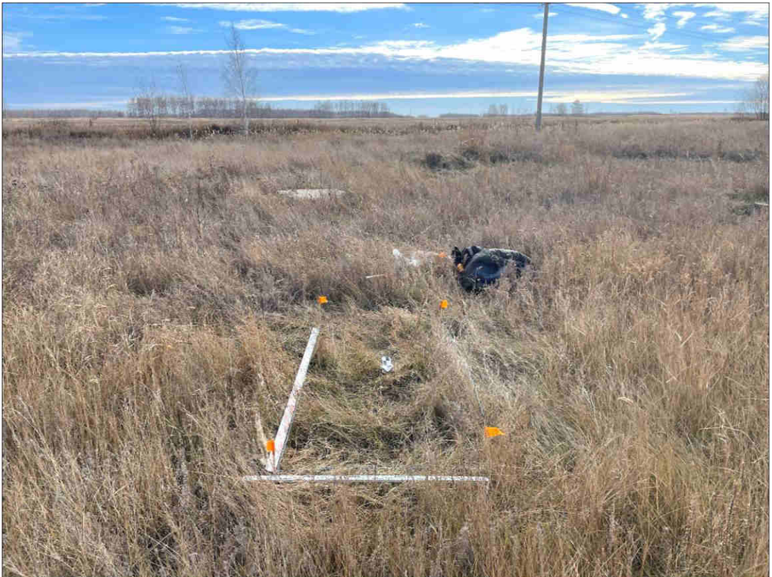
Рисунок 580 – «Распределительный газопровод р.п. Чистоозерное». Шурф №43. Общий вид. Разбивка. Снято с С.
