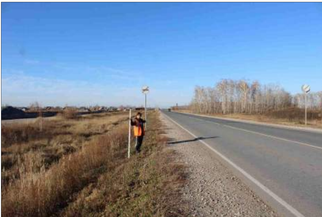
Рисунок 203 – «Распределительный газопровод р.п. Чистоозерное». Вид из точки 86 в направлении точки 80. Снято с Ю.
