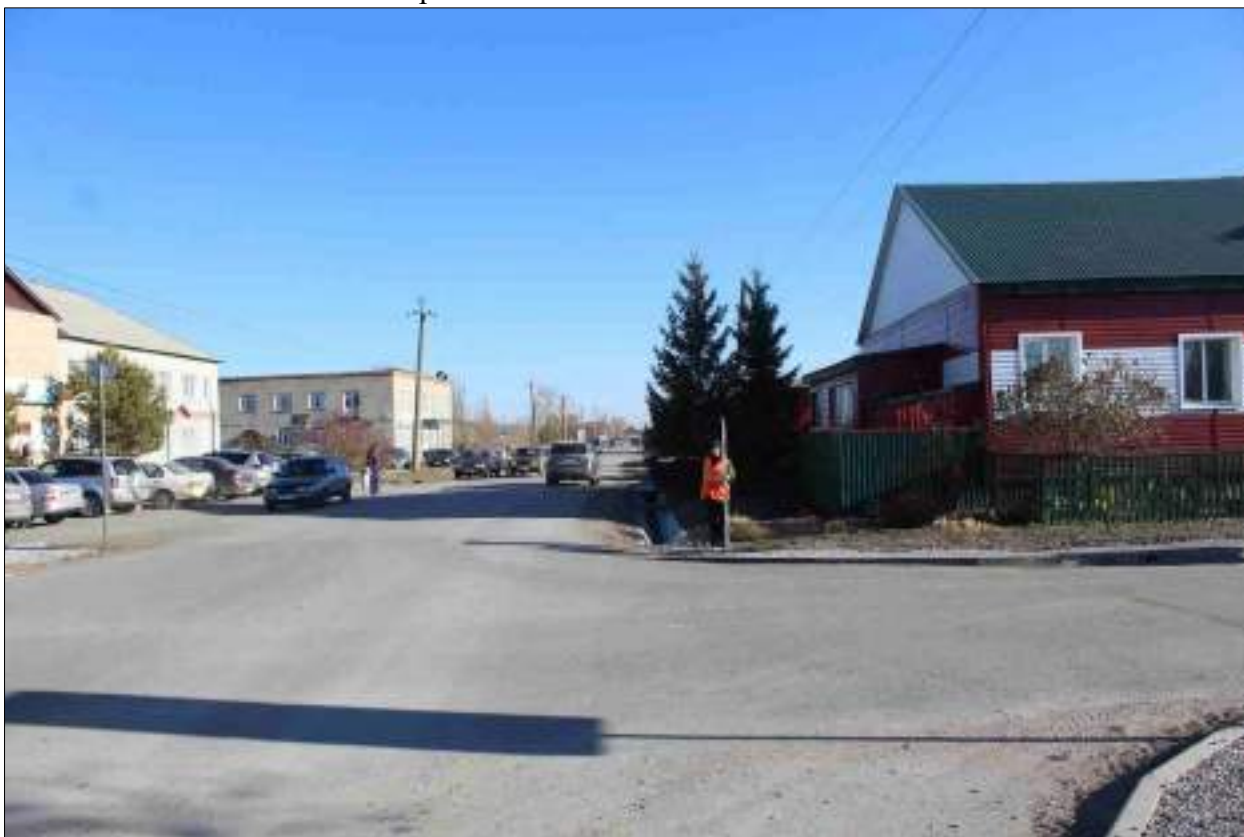
Рисунок 70 – «Распределительный газопровод р.п. Чистоозерное». Вид из точки 153 в направлении точки 134. Снято с ЮЗ.
