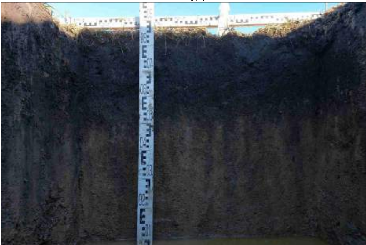
Рисунок 496 – «Распределительный газопровод р.п. Чистоозерное». Шурф №26. Северная стенка. Снято с Ю.
