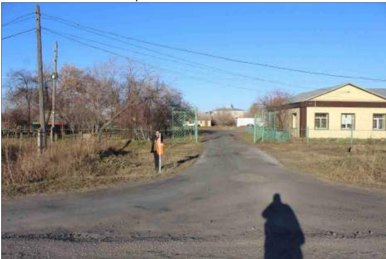
Рисунок 216 – «Распределительный газопровод р.п. Чистоозерное». Вид из точки 194 в направлении точки 195. Снято с ЮЗ.
