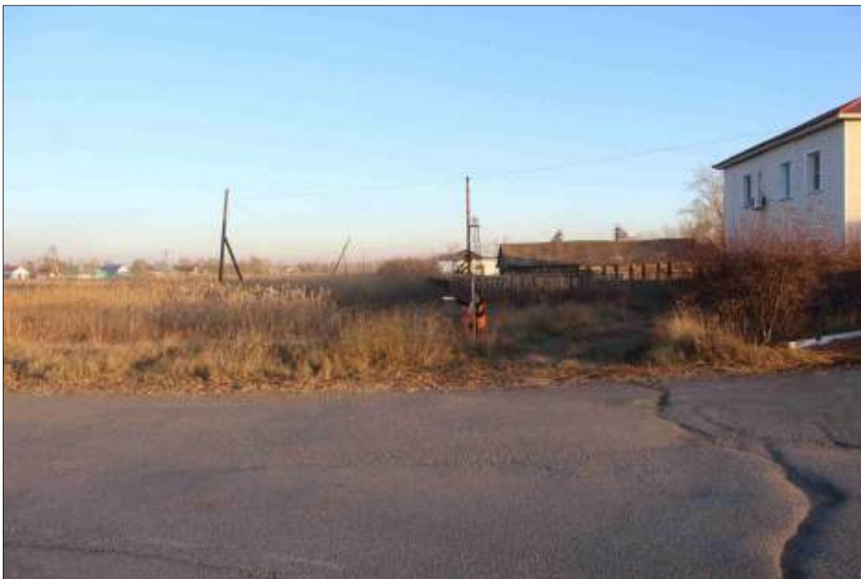
Рисунок 257 – «Распределительный газопровод р.п. Чистоозерное». Вид из точки 52 в направлении точки 53. Снято с СЗ.
