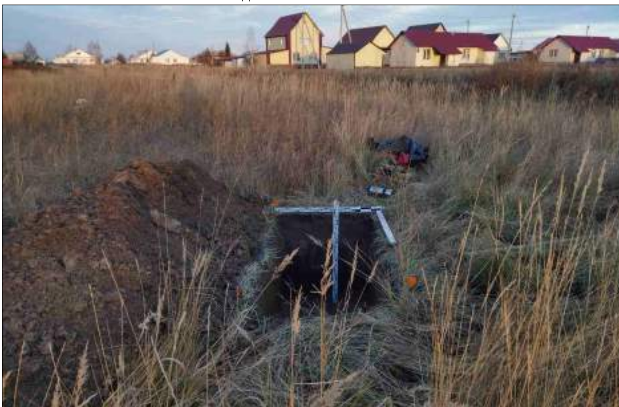
Рисунок 586 – «Распределительный газопровод р.п. Чистоозерное». Шурф №44. Общий вид выполненного шурфа. Снято с 3.
