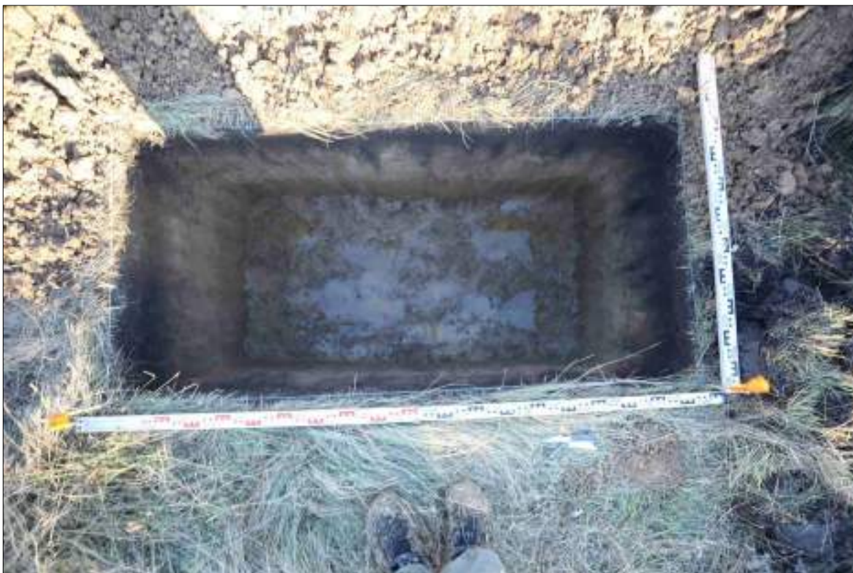
Рисунок 454 – «Распределительный газопровод р.п. Чистоозерное». Шурф №18. Дно шурфа. Снято с З.
