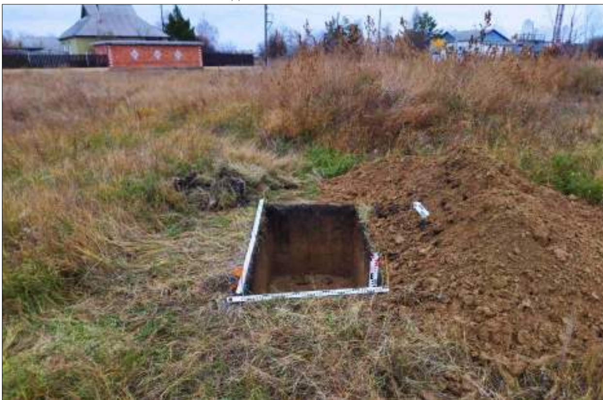
Рисунок 402 – «Распределительный газопровод р.п. Чистоозерное». Шурф №8. Общий вид выполненного шурфа. Снято с Ю.
