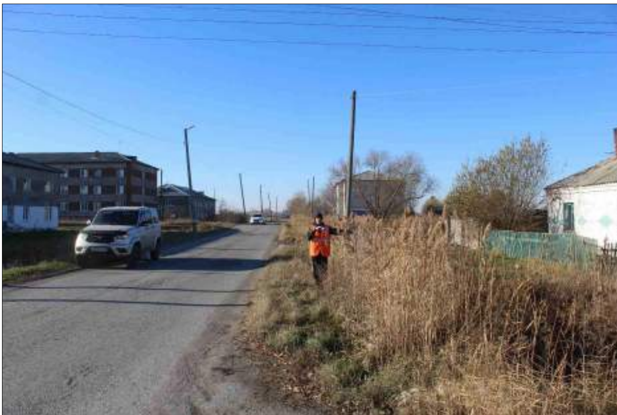
Рисунок 55 – «Распределительный газопровод р.п. Чистоозерное». Вид из точки 160 в направлении точки 162. Снято с В.
