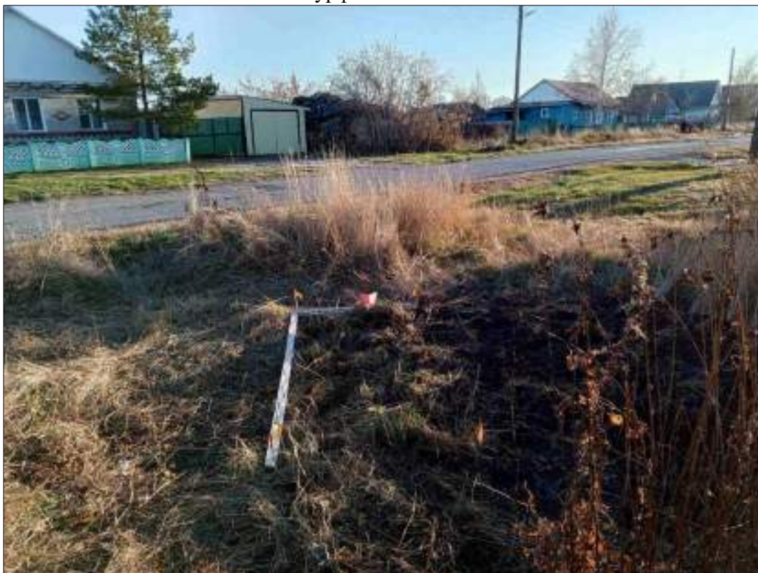
Рисунок 568 – «Распределительный газопровод р.п. Чистоозерное». Шурф №40. Рекультивация. Снято с С.
