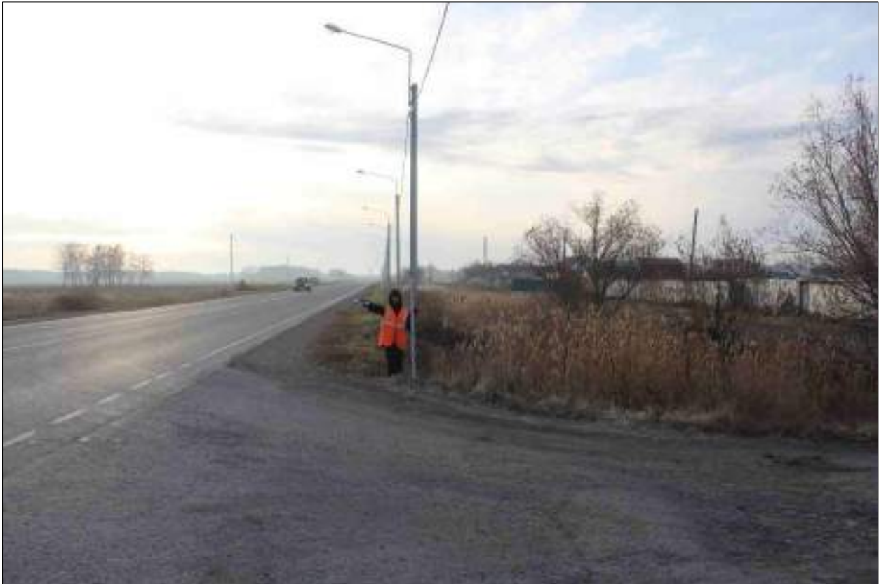
Рисунок 269 – «Распределительный газопровод р.п. Чистоозерное». Вид из точки 32 в направлении точки 64. Снято с СЗ.
