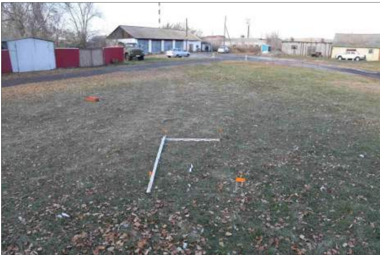
Рисунок 549 – «Распределительный газопровод р.п. Чистоозерное». Шурф №37. Общий вид. Разбивка. Снято с Ю.
