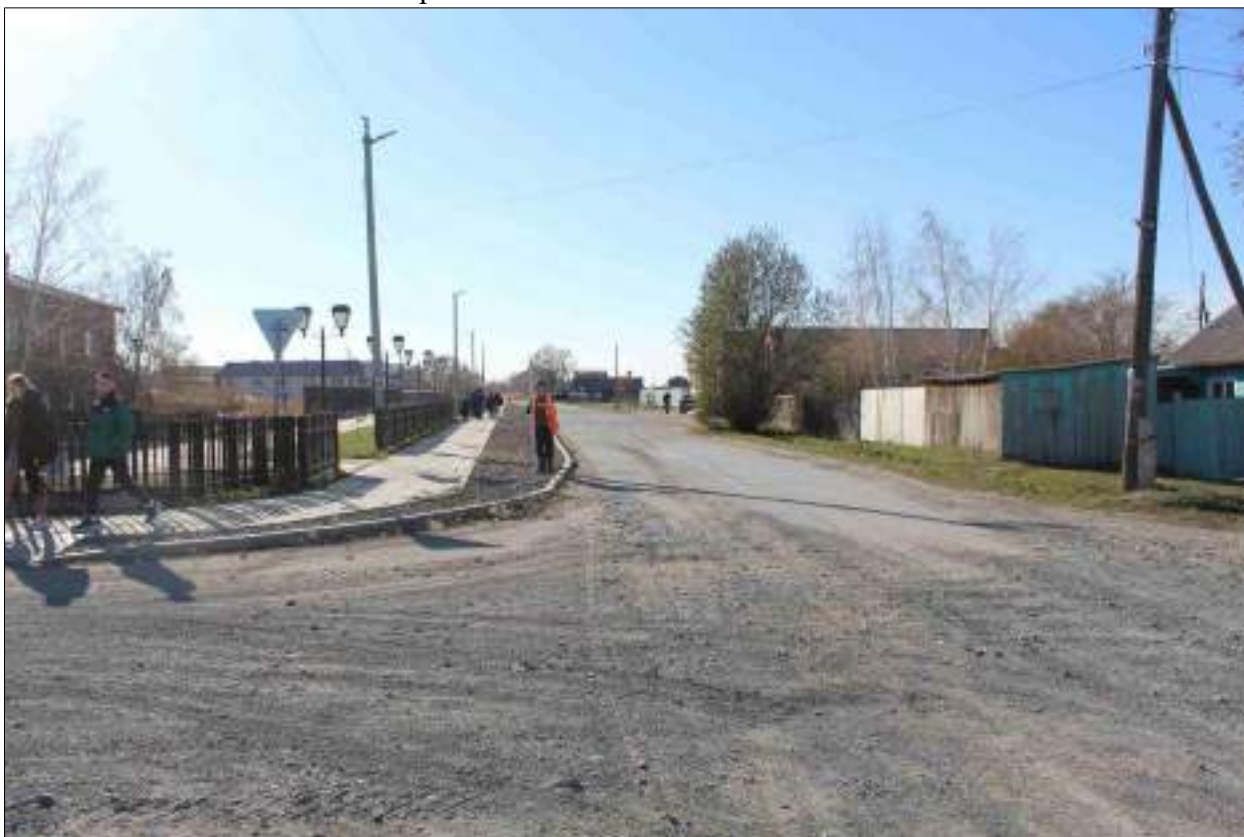
Рисунок 150 – «Распределительный газопровод р.п. Чистоозерное». Вид из точки 124 в направлении точки 156. Снято с СВ.
