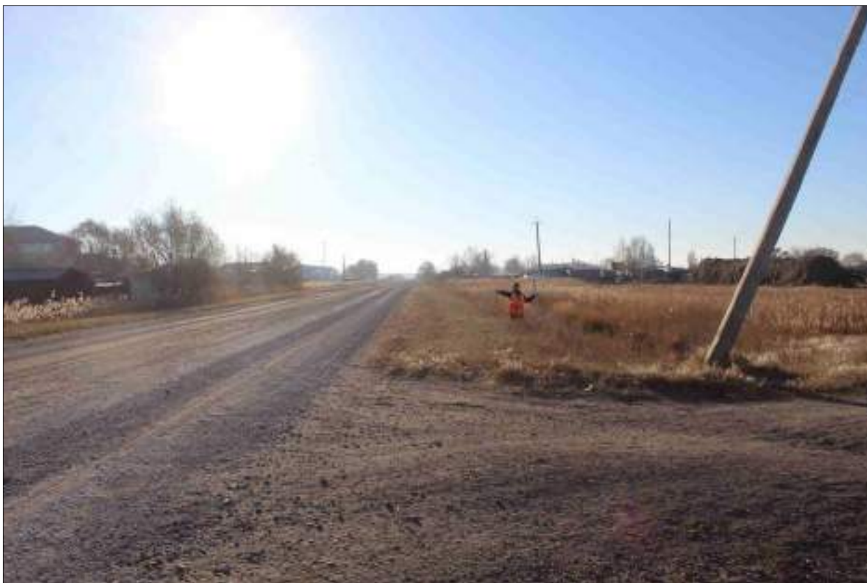
Рисунок 43 – «Распределительный газопровод р.п. Чистоозерное». Вид из точки 167 в направлении точки 162. Снято с СЗ.
