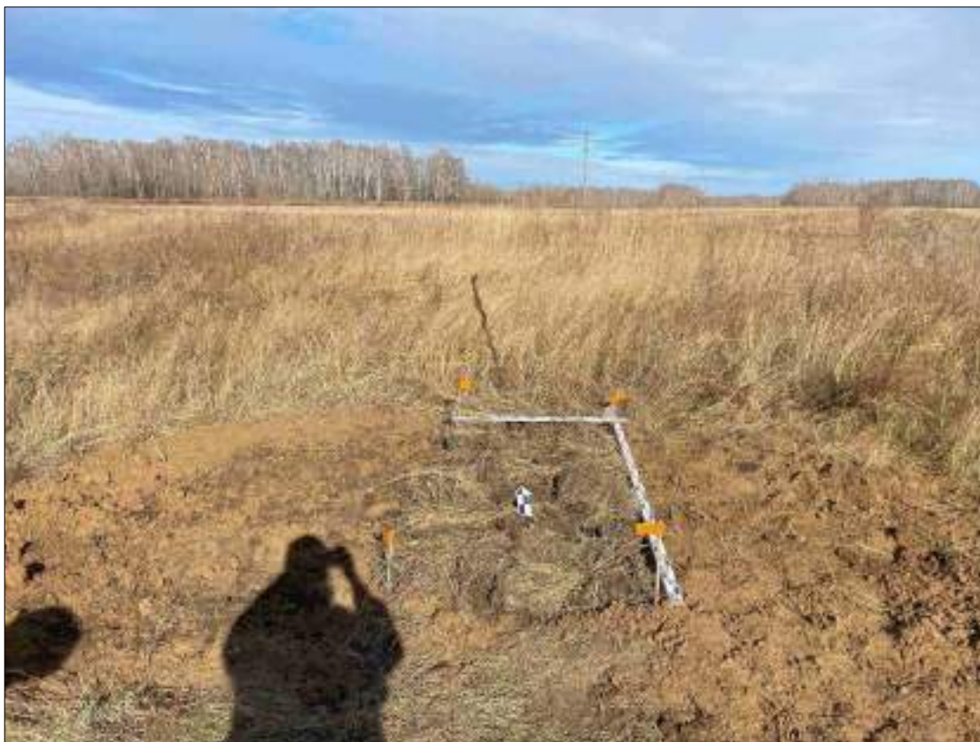
Рисунок 523 – «Распределительный газопровод р.п. Чистоозерное». Шурф №31. Рекультивация. Снято с Ю.
