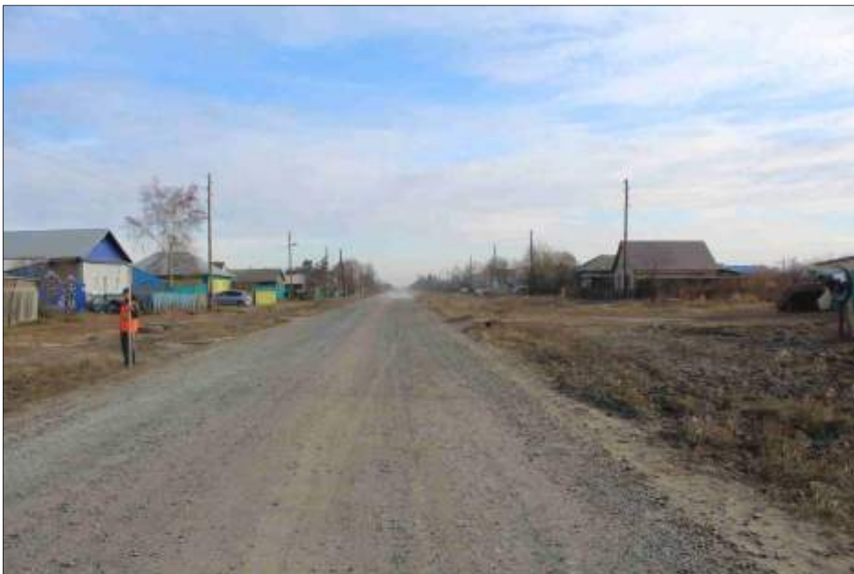
Рисунок 313 – «Распределительный газопровод р.п. Чистоозерное». Вид из точки 3 в направлении точки 2. Снято с ЮЗ.
