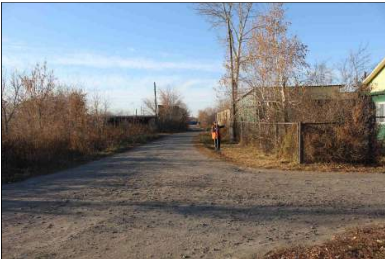
Рисунок 221 – «Распределительный газопровод р.п. Чистоозерное». Вид из точки 68 в направлении точки 60. Снято с ЮВ.
