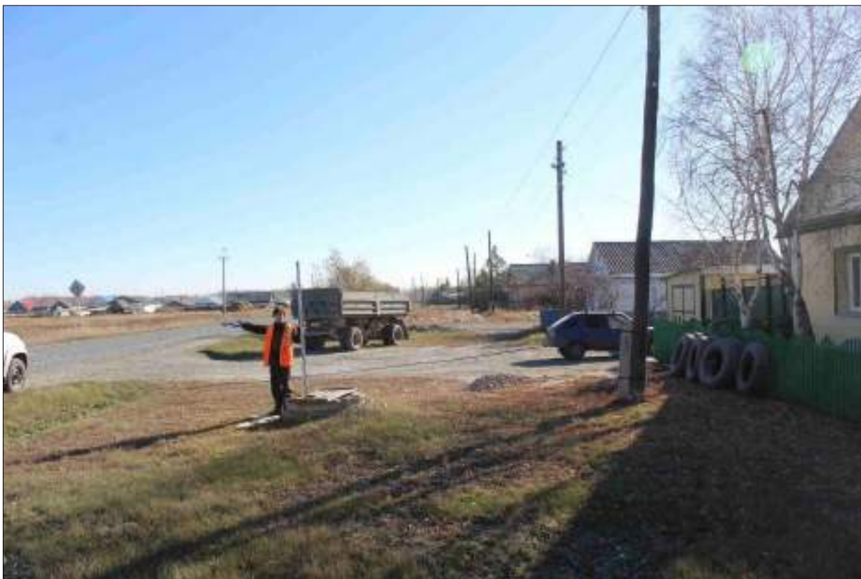
Рисунок 127 – «Распределительный газопровод р.п. Чистоозерное». Вид из точки 93 в направлении точки 106. Снято с СЗ.
