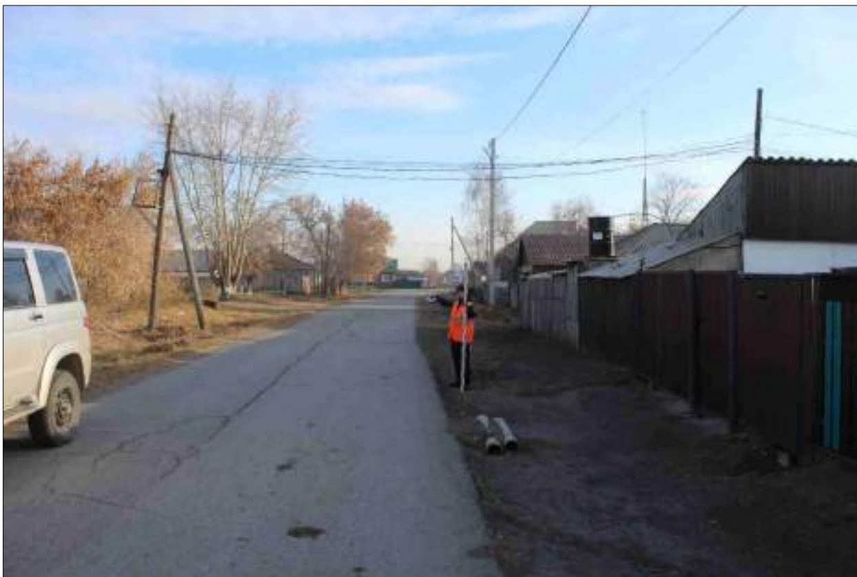
Рисунок 283 – «Распределительный газопровод р.п. Чистоозерное». Вид из точки 46 в направлении точки 47. Снято с ЮЗ.
