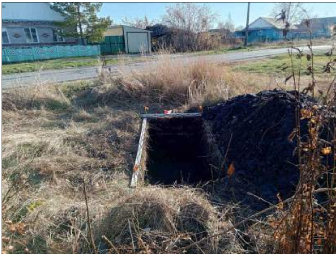
Рисунок 565 – «Распределительный газопровод р.п. Чистоозерное». Шурф №40. Общий вид выполненного шурфа. Снято с С.
