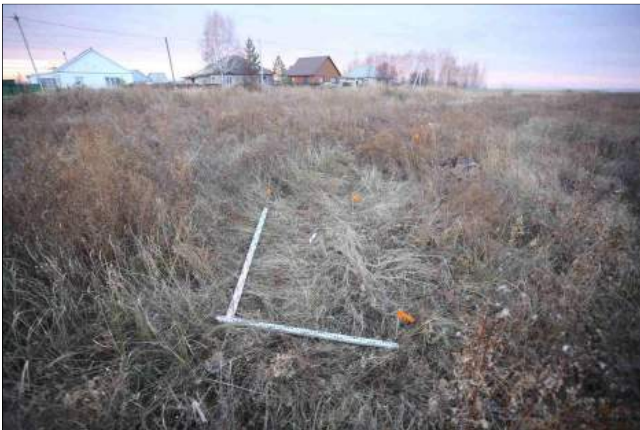
Рисунок 441 – «Распределительный газопровод р.п. Чистоозерное». Шурф №16. Общий вид. Разбивка. Снято с С.
