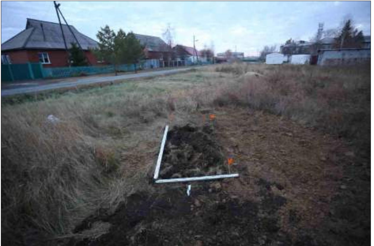
Рисунок 415 – «Распределительный газопровод р.п. Чистоозерное». Шурф №10. Рекультивация. Снято с С.
