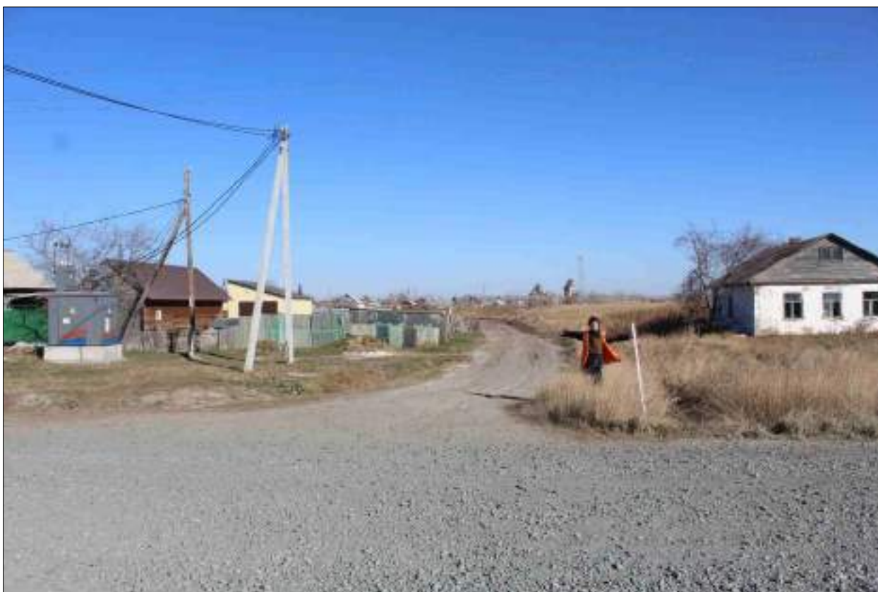
Рисунок 125 – «Распределительный газопровод р.п. Чистоозерное». Вид из точки 93 в направлении точки 92. Снято с ЮЗ.
