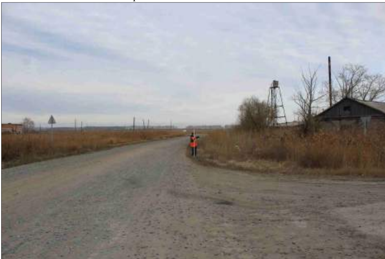
Рисунок 336 – «Распределительный газопровод р.п. Чистоозерное». Вид из точки 14 в направлении точки 10. Снято с ЮВ.
