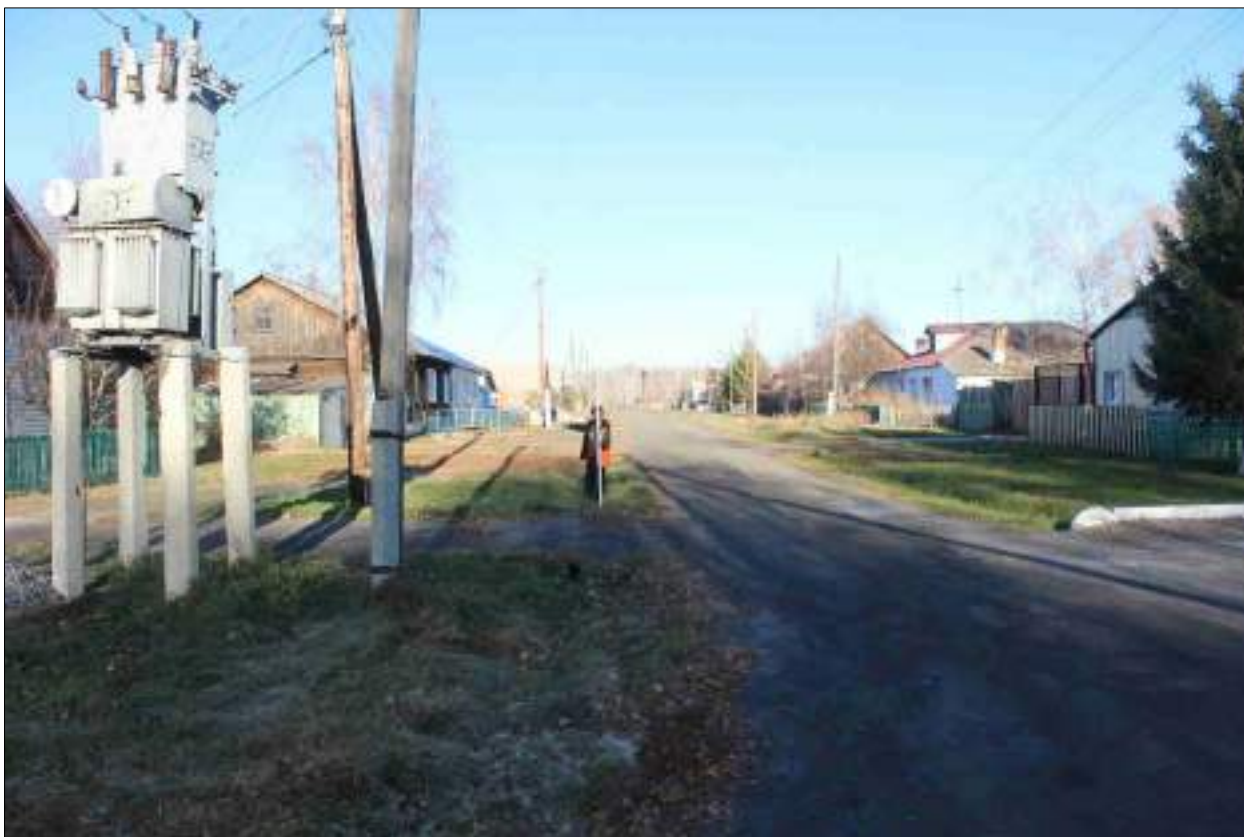
Рисунок 207 – «Распределительный газопровод р.п. Чистоозерное». Вид из точки 82 в направлении точки 81. Снято с ЮЗ.
