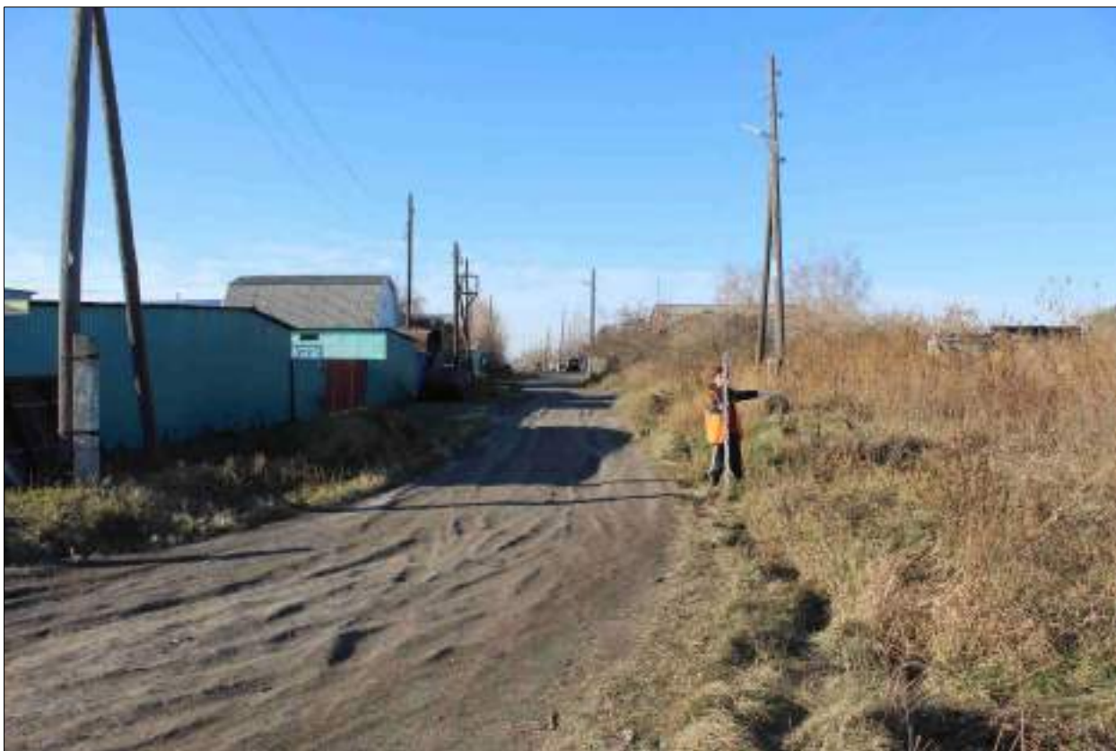
Рисунок 193 – «Распределительный газопровод р.п. Чистоозерное». Вид из точки 90 в направлении точки 89. Снято с ЮВ.
