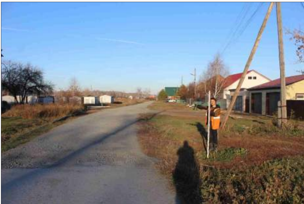
Рисунок 231 – «Распределительный газопровод р.п. Чистоозерное». Вид из точки 71 в направлении точки 72. Снято с ЮЗ.
