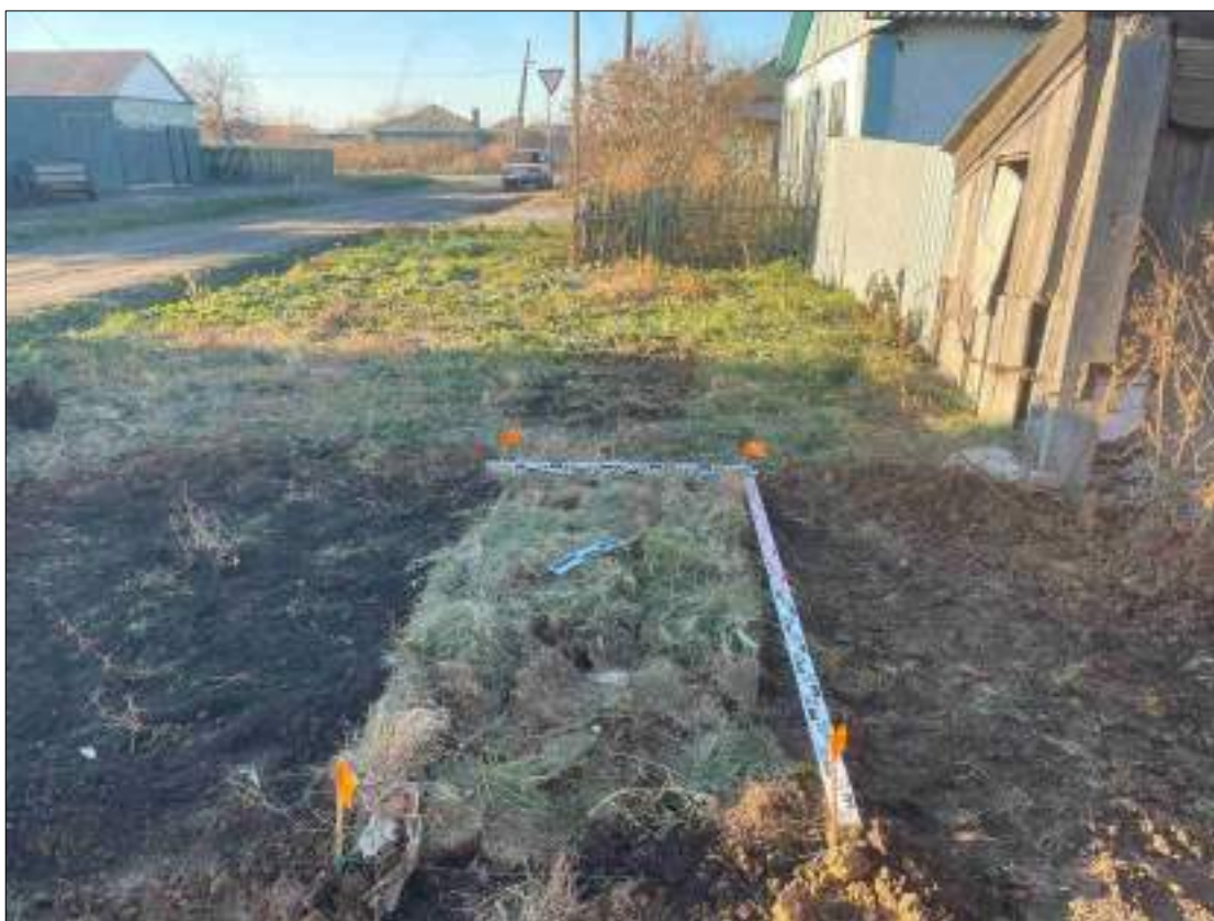
Рисунок 649 – «Распределительный газопровод р.п. Чистоозерное». Шурф №56. Рекультивация. Снято с ЮЗ.
