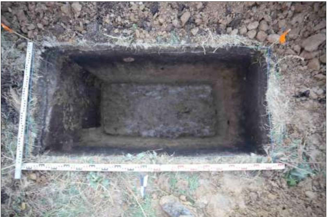
Рисунок 654 – «Распределительный газопровод р.п. Чистоозерное». Шурф №57. Дно шурфа. Снято с С.
