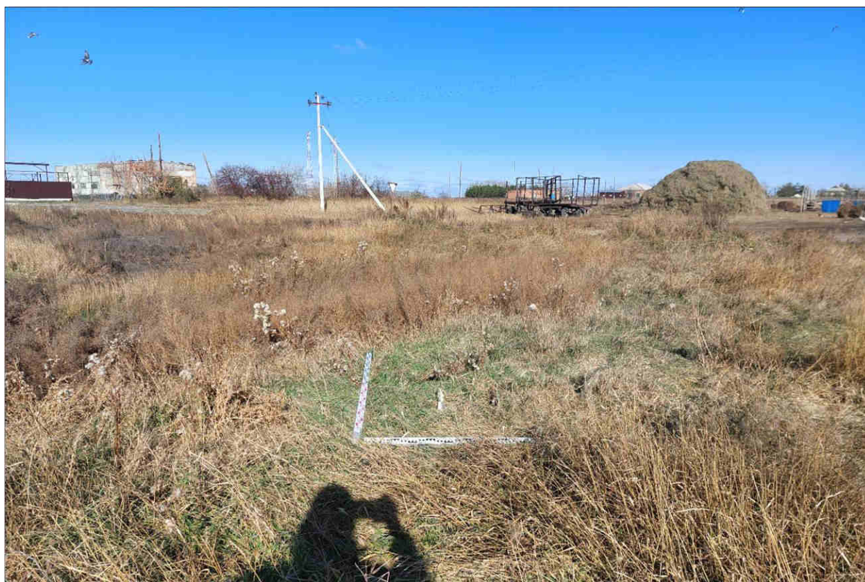
Рисунок 484 – «Распределительный газопровод р.п. Чистоозерное». Шурф №24. Общий вид. Разбивка. Снято с Ю.
