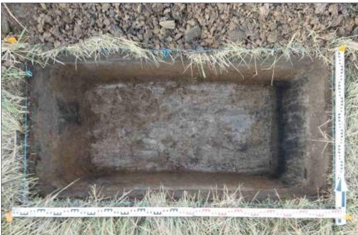
Рисунок 588 – «Распределительный газопровод р.п. Чистоозерное». Шурф №44. Дно шурфа. Снято с Ю.
