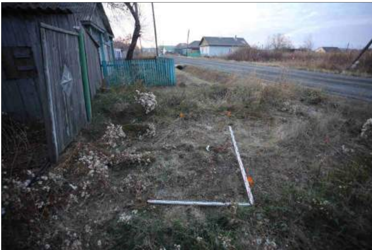
Рисунок 615 – «Распределительный газопровод р.п. Чистоозерное». Шурф №50. Общий вид. Разбивка. Снято с С.
