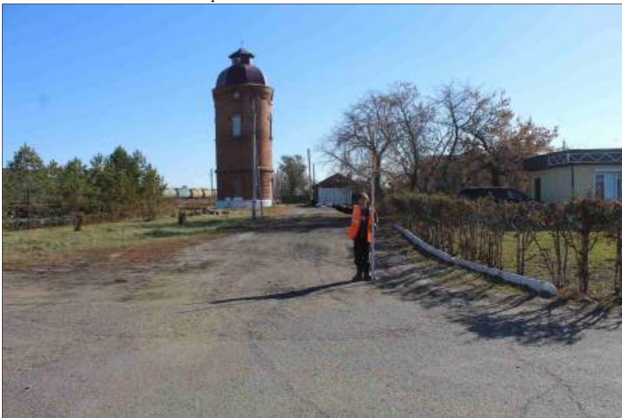
Рисунок 106 – «Распределительный газопровод р.п. Чистоозерное». Вид из точки 132 в направлении точки 131. Снято с СЗ.
