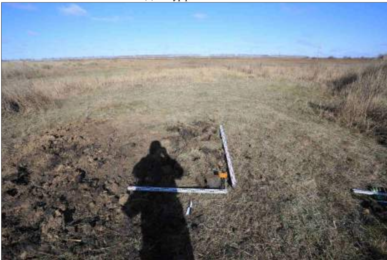
Рисунок 460 – «Распределительный газопровод р.п. Чистоозерное». Шурф №19. Рекультивация. Снято с Ю.
