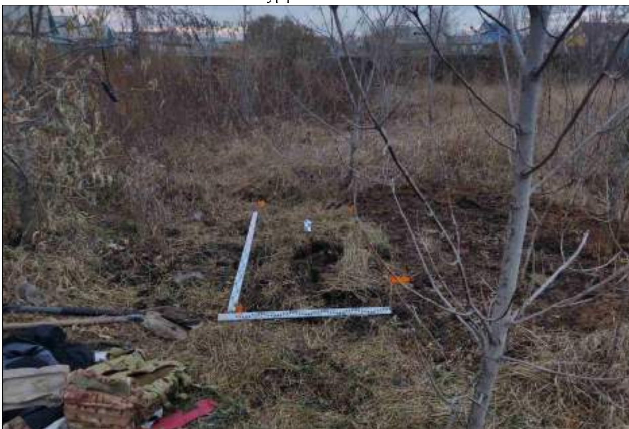
Рисунок 410 – «Распределительный газопровод р.п. Чистоозерное». Шурф №9. Рекультивация. Снято с Ю.
