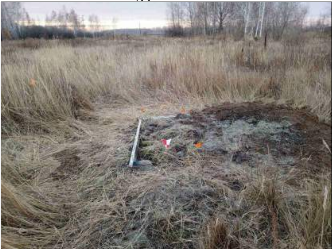
Рисунок 538 – «Распределительный газопровод р.п. Чистоозерное». Шурф №34. Рекультивация. Снято с С.
