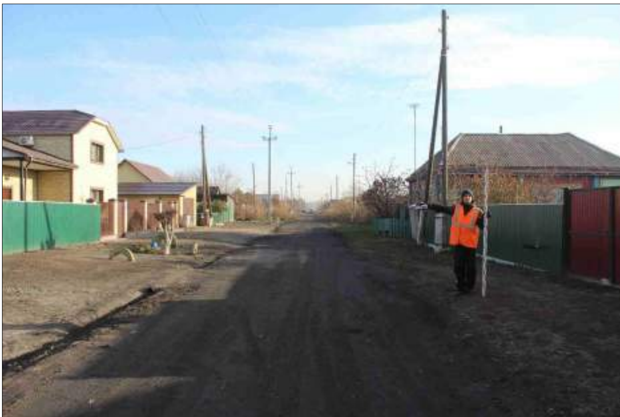
Рисунок 289 – «Распределительный газопровод р.п. Чистоозерное». Вид из точки 49 в направлении точки 38. Снято с ЮЗ.
