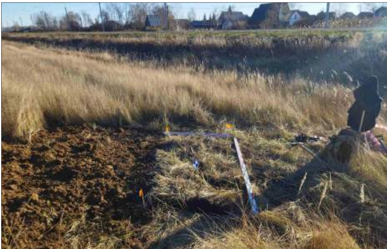
Рисунок 513 – «Распределительный газопровод р.п. Чистоозерное». Шурф №29. Рекультивация. Снято с С.
