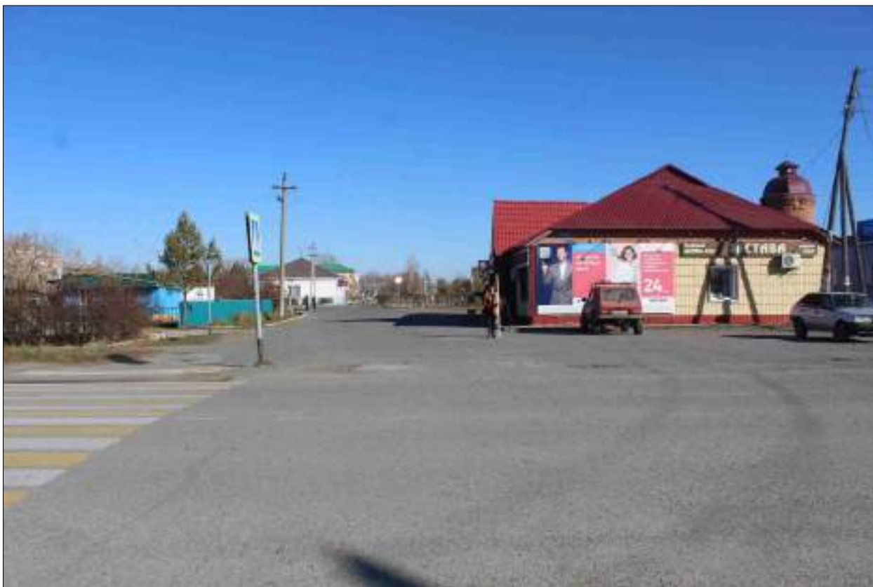
Рисунок 105 – «Распределительный газопровод р.п. Чистоозерное». Вид из точки 133 в направлении точки 132. Снято с ЮЗ.
