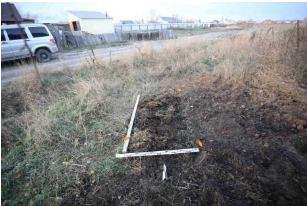
Рисунок 385 – «Распределительный газопровод р.п. Чистоозерное». Шурф №4. Рекультивация. Снято с Ю.
