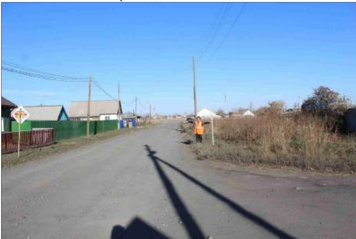
Рисунок 176 – «Распределительный газопровод р.п. Чистоозерное». Вид из точки 117 в направлении точки 116. Снято с ЮЗ.
