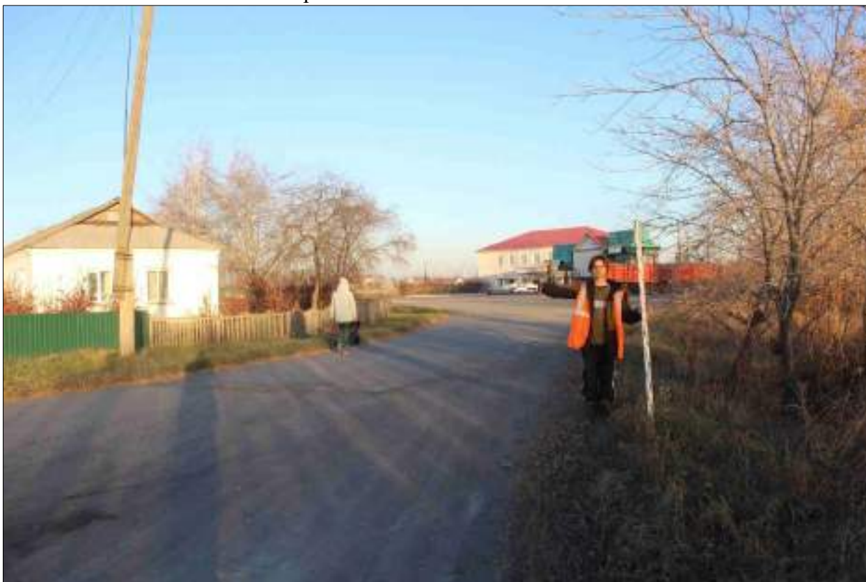
Рисунок 256 – «Распределительный газопровод р.п. Чистоозерное». Вид из точки 51 в направлении точки 52. Снято с З.
