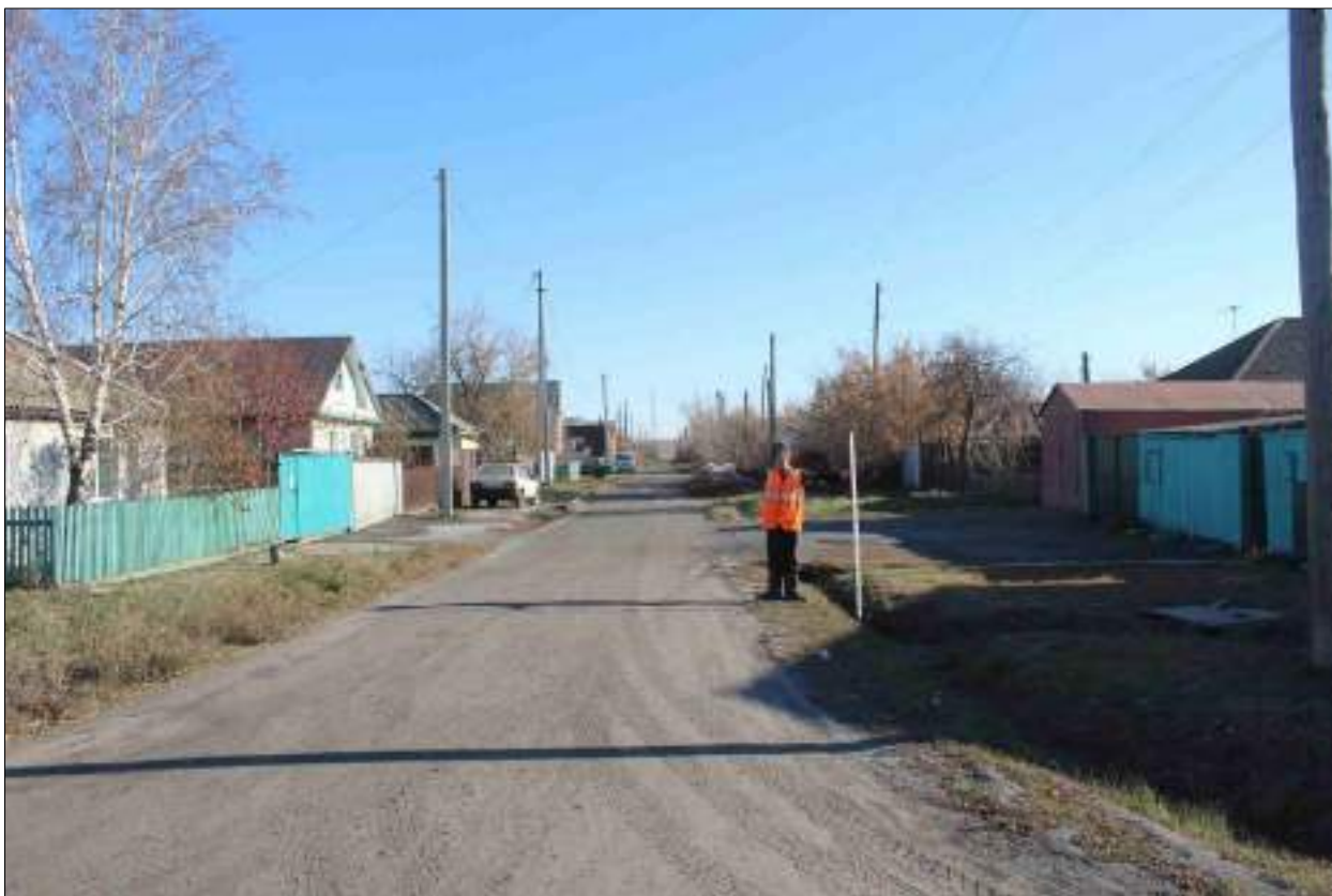
Рисунок 177 – «Распределительный газопровод р.п. Чистоозерное». Вид из точки 117 в направлении точки 114. Снято с СЗ.
