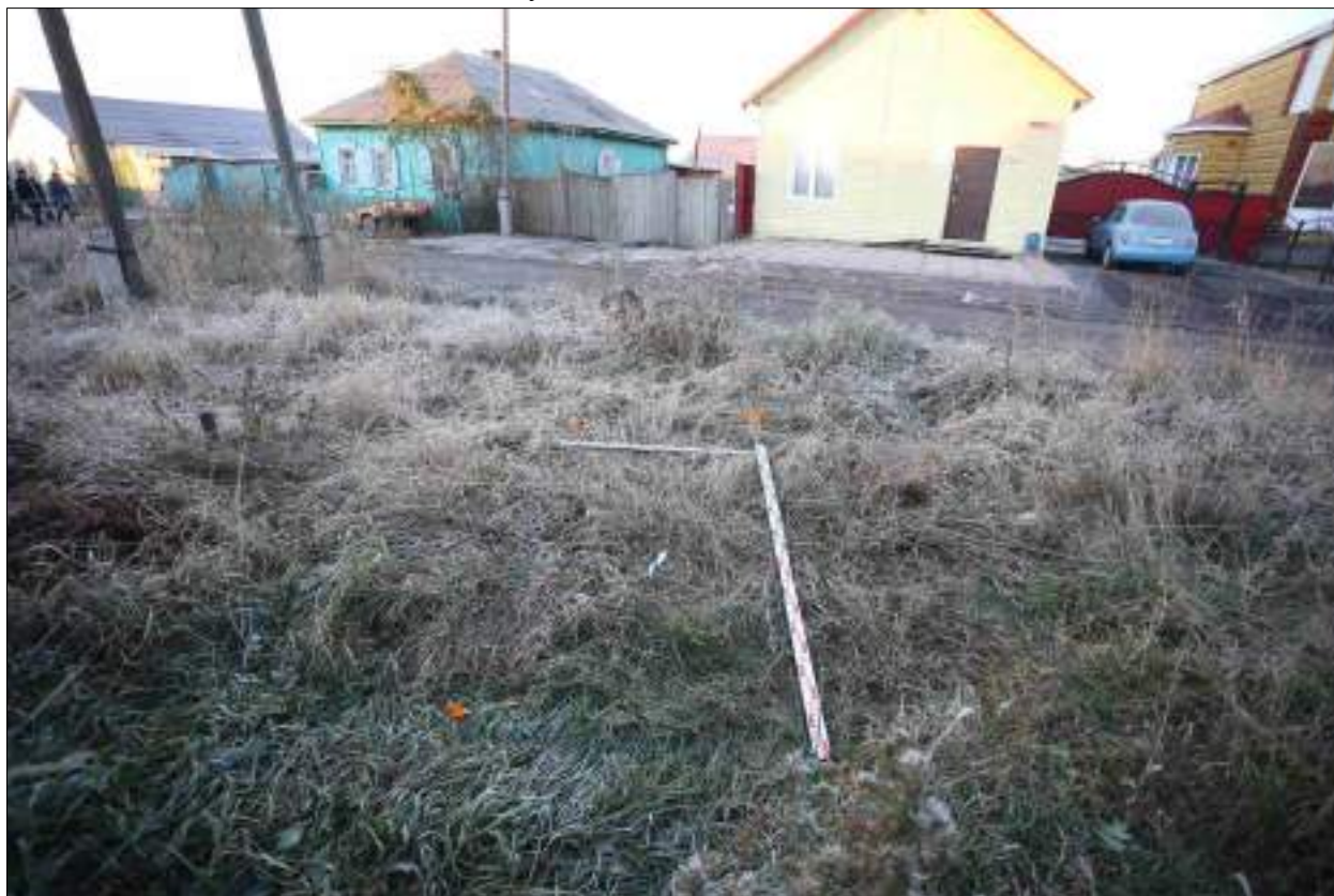
Рисунок 640 – «Распределительный газопровод р.п. Чистоозерное». Шурф №55. Общий вид. Разбивка. Снято с С.
