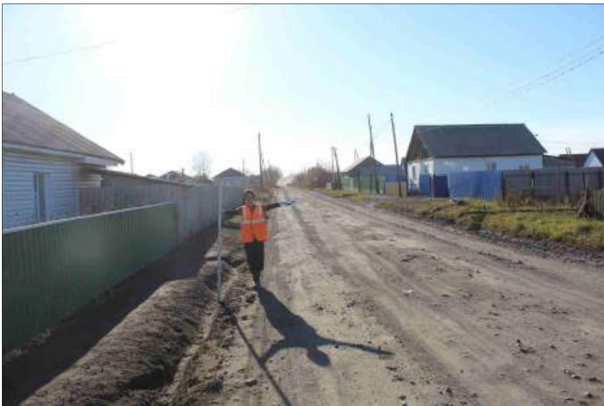
Рисунок 179 – «Распределительный газопровод р.п. Чистоозерное». Вид из точки 116 в направлении точки 117. Снято с СВ.
