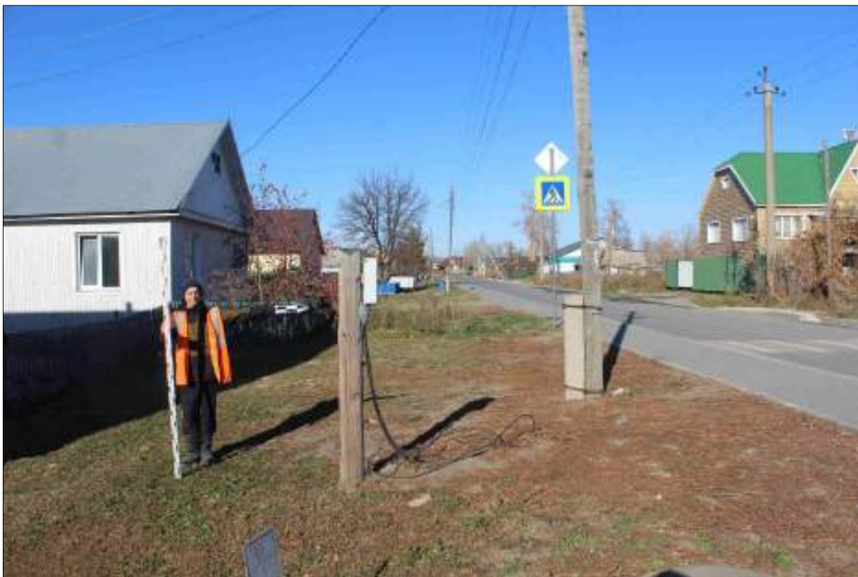
Рисунок 101 – «Распределительный газопровод р.п. Чистоозерное». Вид из точки 152 в направлении точки 149. Снято с ЮВ.
