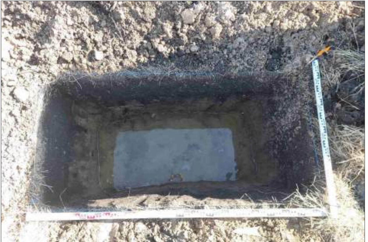
Рисунок 623 – «Распределительный газопровод р.п. Чистоозерное». Шурф №51. Дно шурфа. Снято с З.
