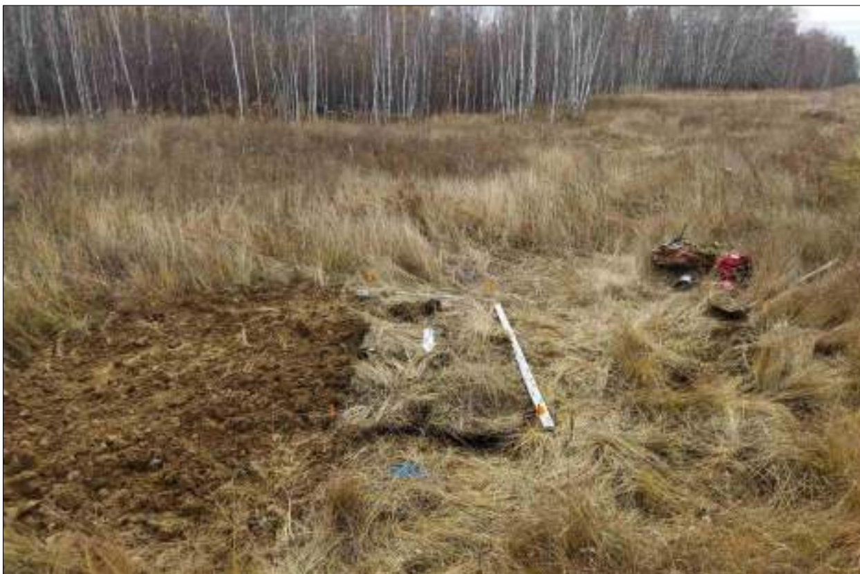
Рисунок 533 – «Распределительный газопровод р.п. Чистоозерное». Шурф №33. Рекультивация. Снято с С.
