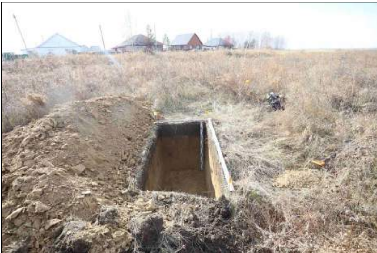
Рисунок 442 – «Распределительный газопровод р.п. Чистоозерное». Шурф №16. Общий вид выполненного шурфа. Снято с С.
