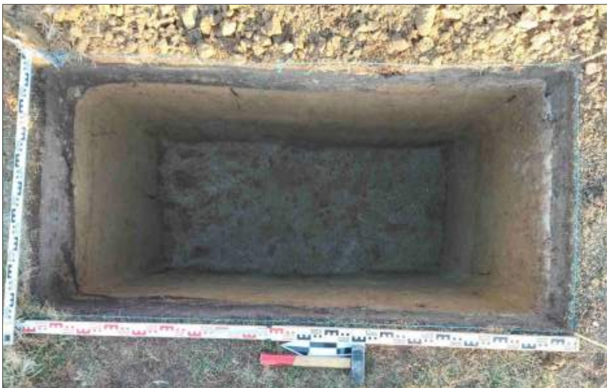
Рисунок 399 – «Распределительный газопровод р.п. Чистоозерное». Шурф №7. Дно шурфа. Снято с З.
