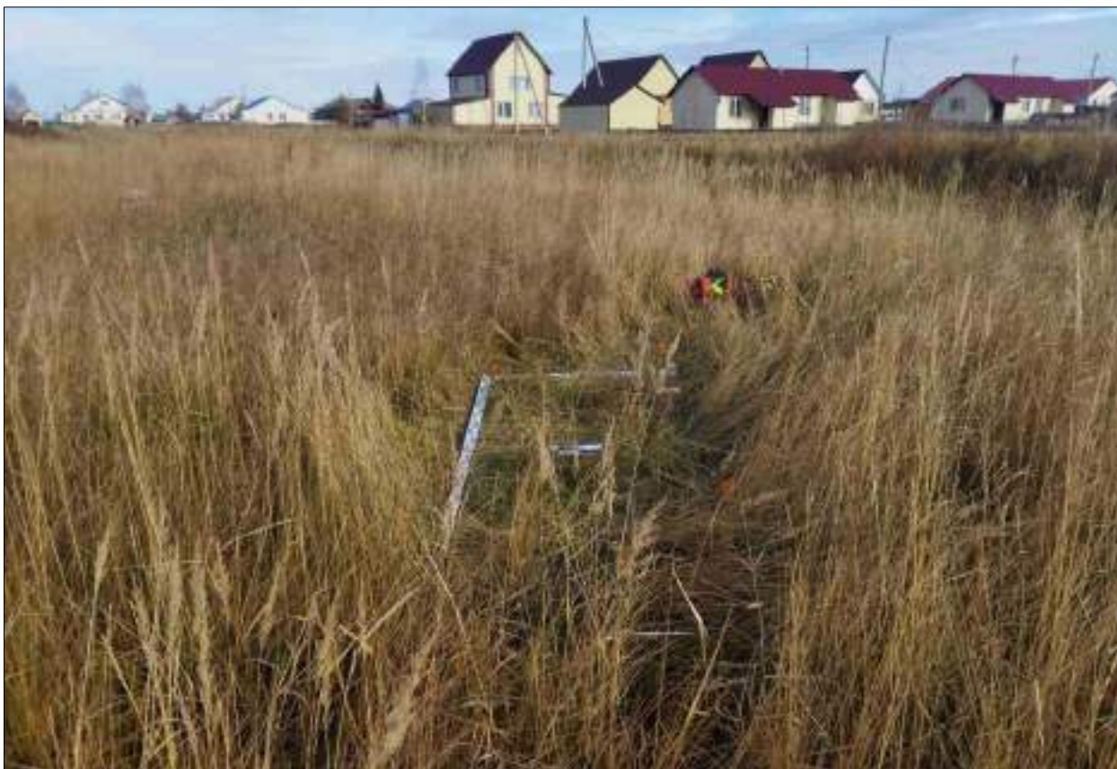
Рисунок 585 – «Распределительный газопровод р.п. Чистоозерное». Шурф №44. Общий вид. Разбивка. Снято с 3.
