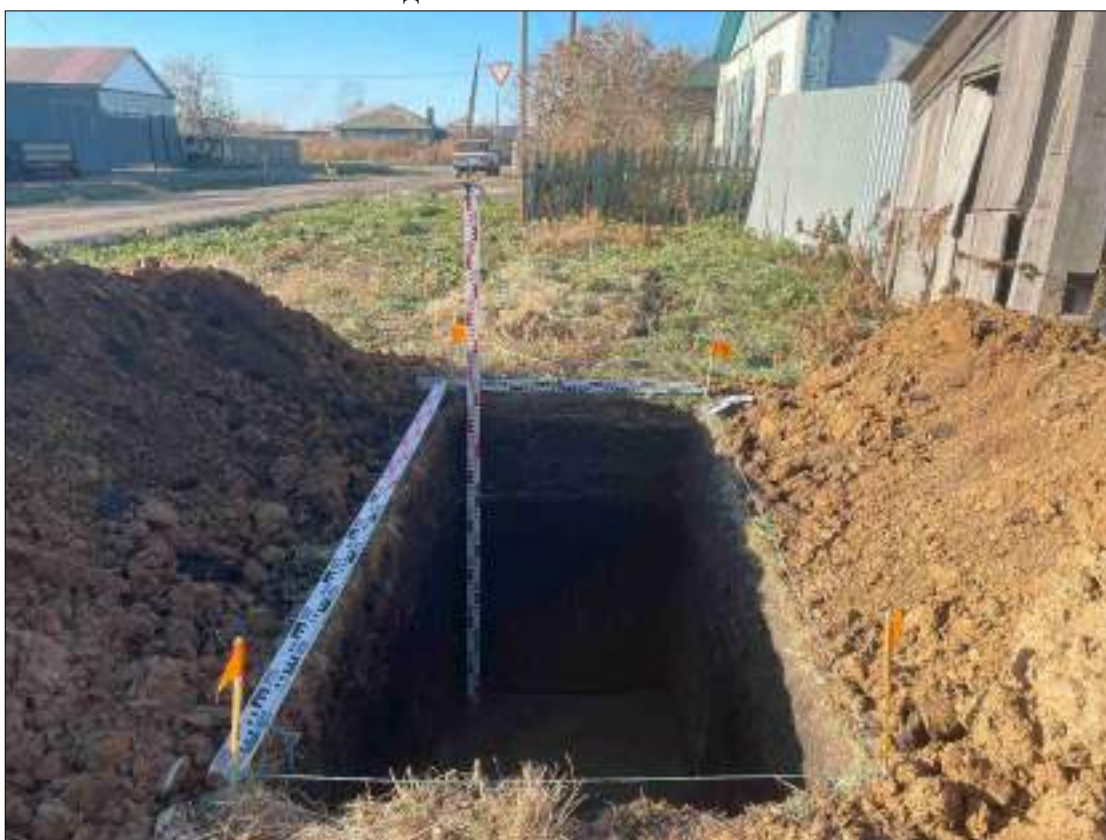
Рисунок 646 – «Распределительный газопровод р.п. Чистоозерное». Шурф №56. Общий вид выполненного шурфа. Снято с ЮВ.
