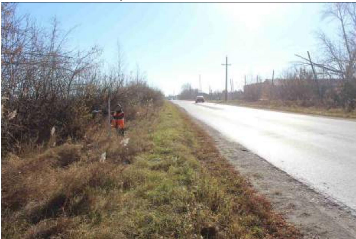
Рисунок 84 – «Распределительный газопровод р.п. Чистоозерное». Вид из точки 141 в направлении точки 140. Снято с СЗ.
