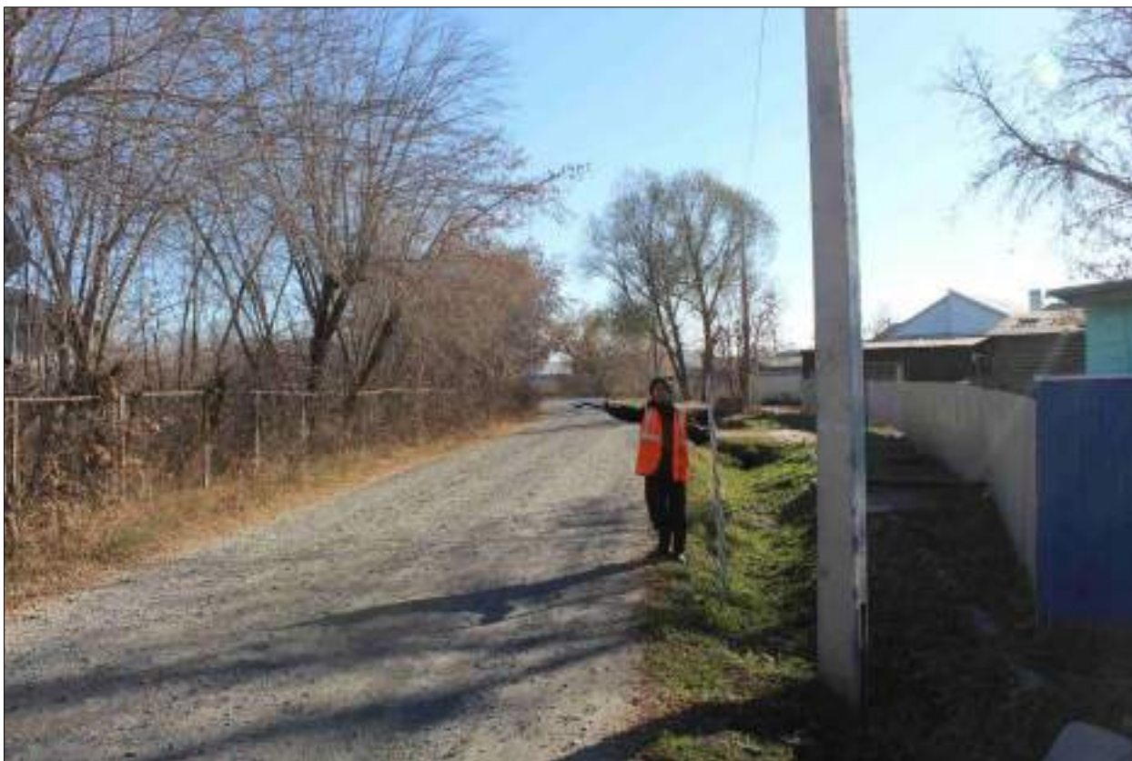
Рисунок 93 – «Распределительный газопровод р.п. Чистоозерное». Вид из точки 147 в направлении точки 140. Снято с СЗ.
