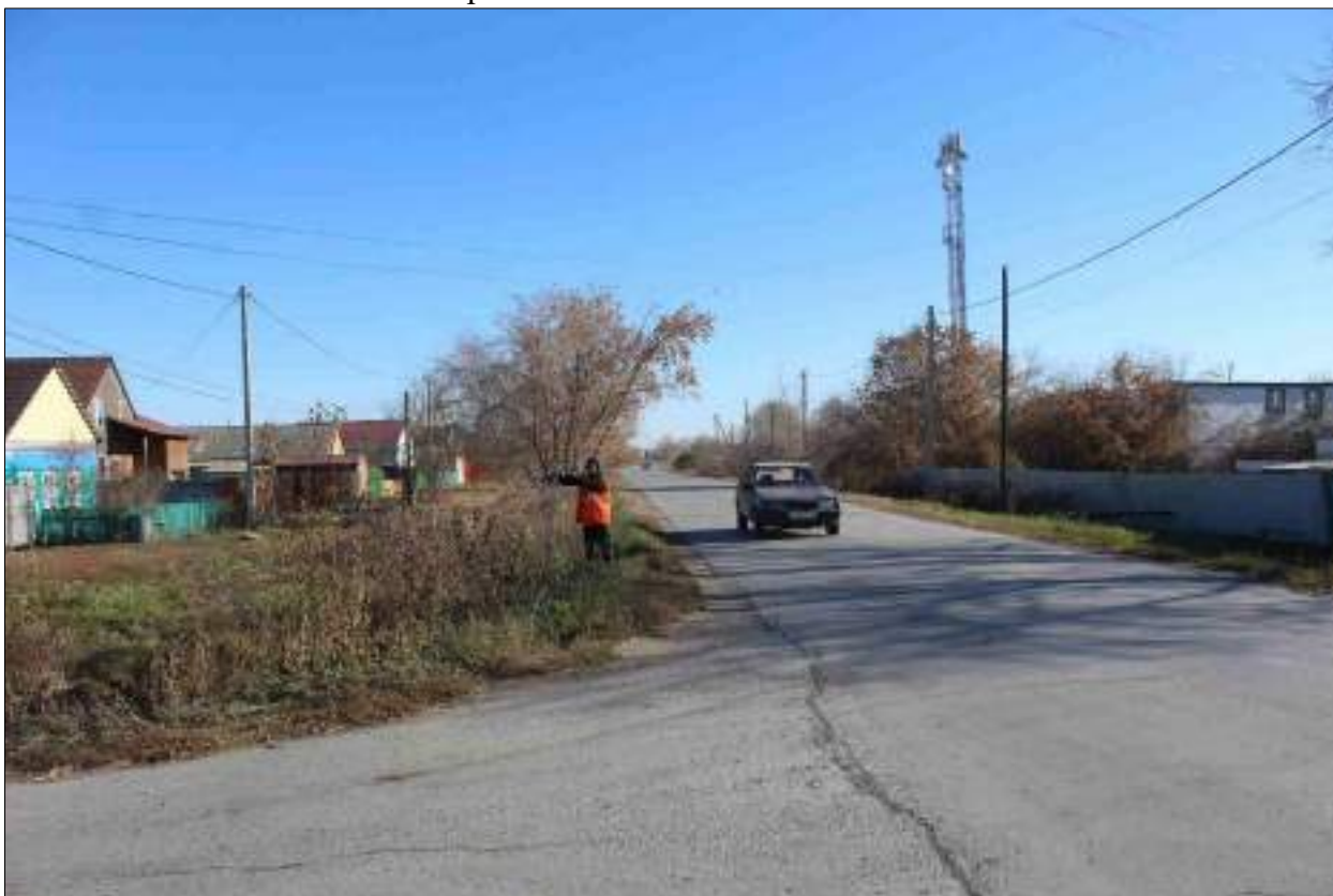
Рисунок 96 – «Распределительный газопровод р.п. Чистоозерное». Вид из точки 149 в направлении точки 150. Снято с З.
