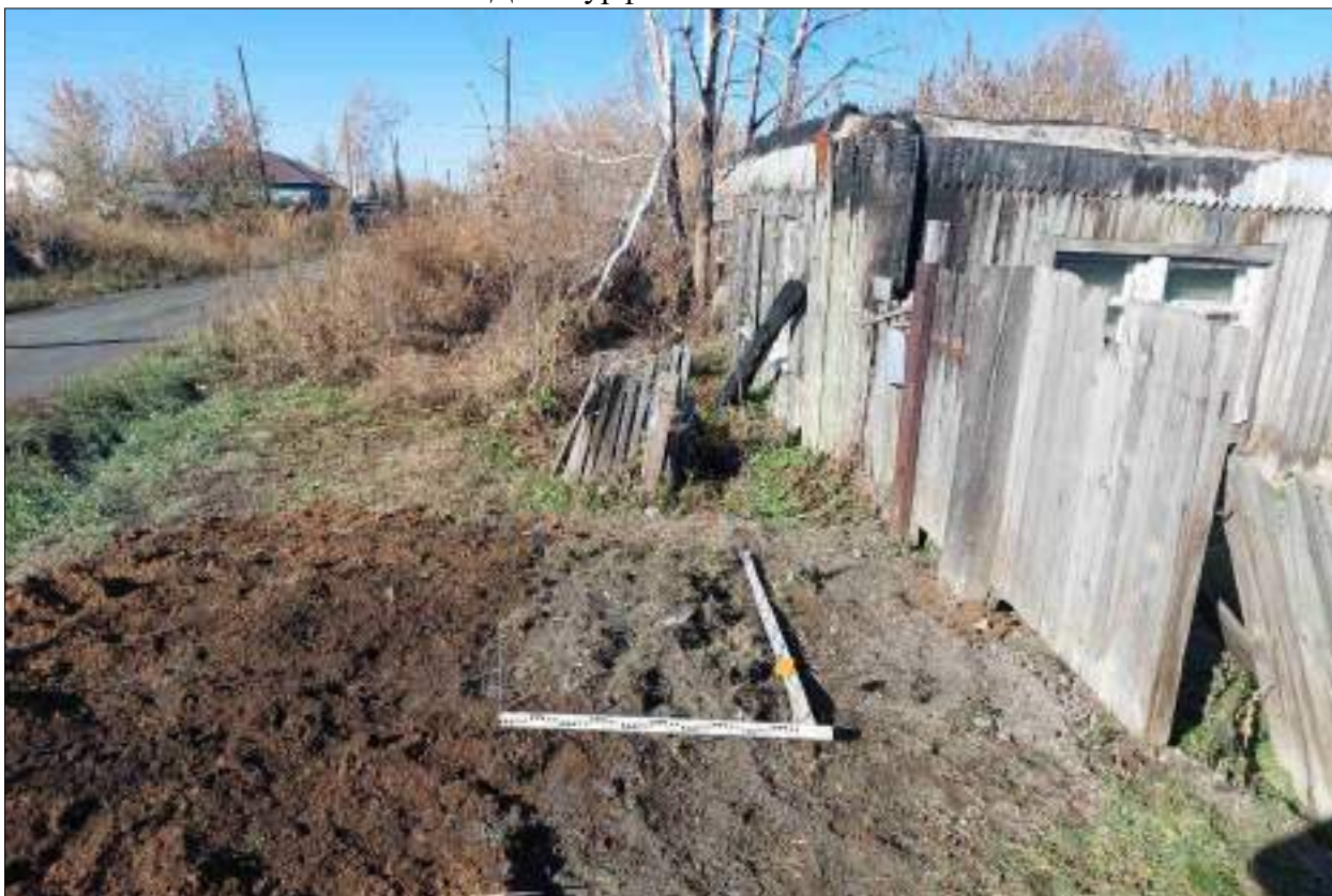
Рисунок 634 – «Распределительный газопровод р.п. Чистоозерное». Шурф №53. Рекультивация. Снято с ЮВ.
