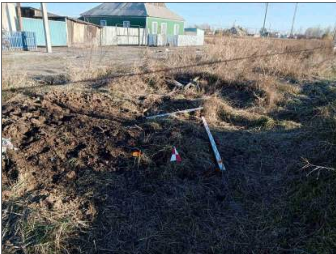
Рисунок 483 – «Распределительный газопровод р.п. Чистоозерное». Шурф №23. Рекультивация. Снято с Ю.
