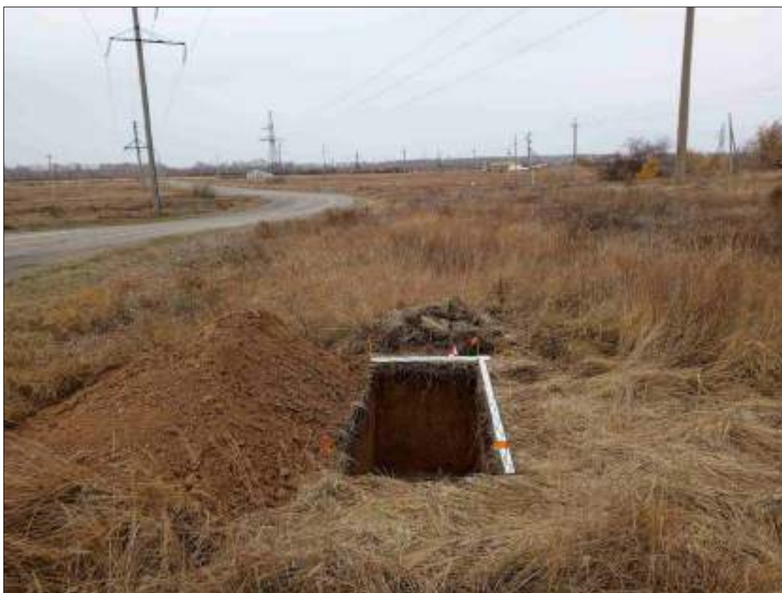
Рисунок 367 – «Распределительный газопровод р.п. Чистоозерное». Шурф №1. Общий вид выполненного шурфа. Снято с Ю.
