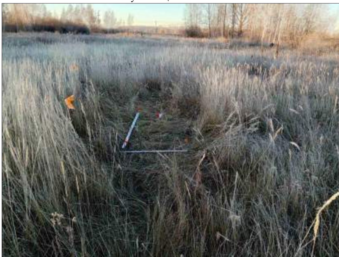
Рисунок 534 – «Распределительный газопровод р.п. Чистоозерное». Шурф №34. Общий вид. Разбивка. Снято с С.
