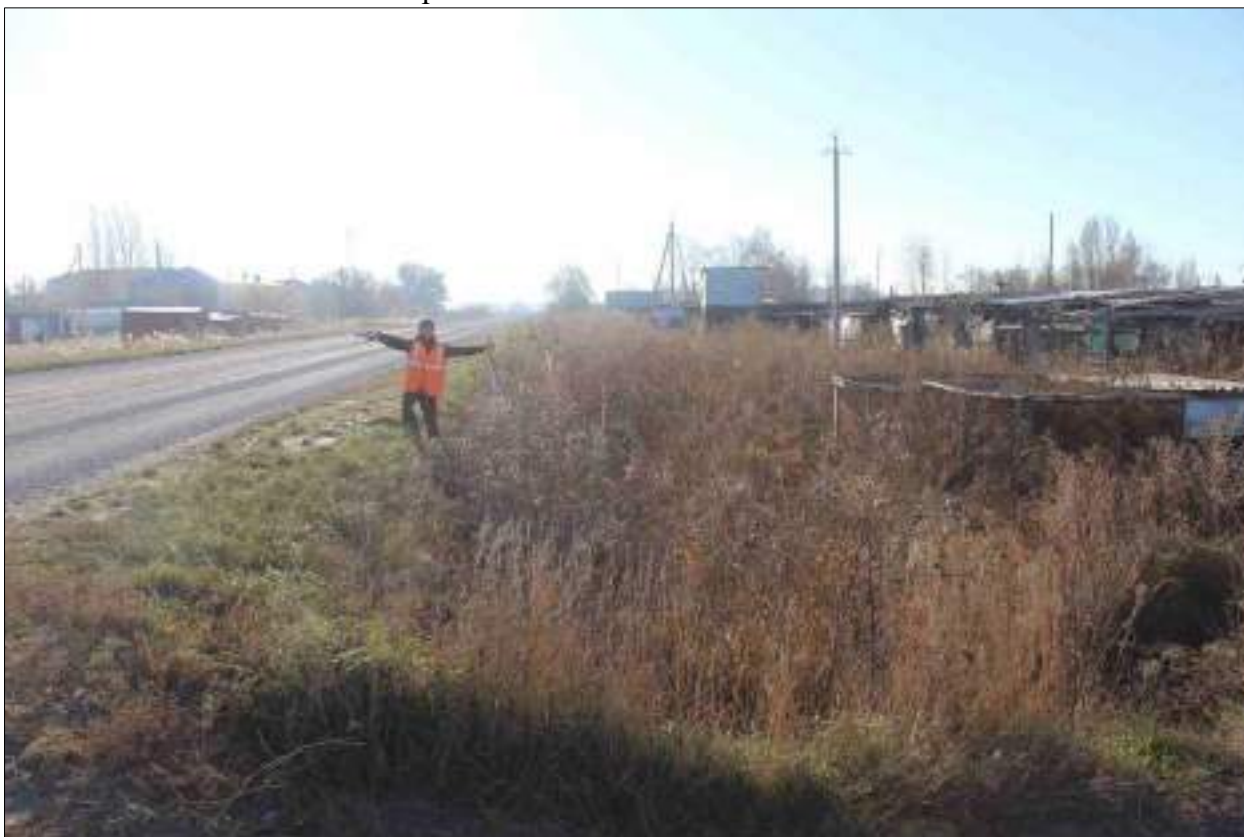
Рисунок 46 – «Распределительный газопровод р.п. Чистоозерное». Вид из точки 162 в направлении точки 163. Снято с СЗ.
