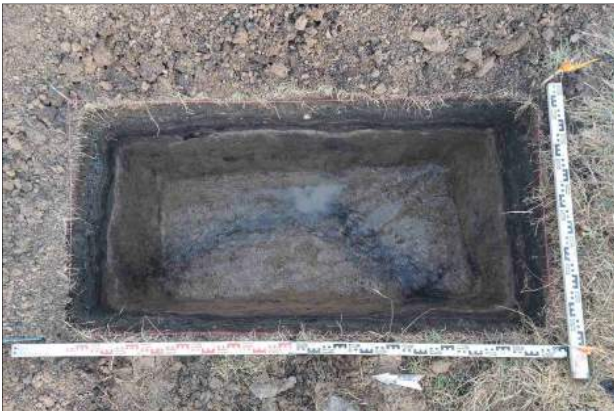
Рисунок 593 – «Распределительный газопровод р.п. Чистоозерное». Шурф №45. Дно шурфа. Снято с З.
