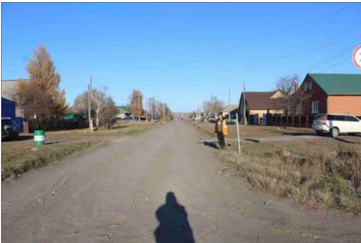
Рисунок 209 – «Распределительный газопровод р.п. Чистоозерное». Вид из точки 83 в направлении точки 79. Снято с ЮЗ.
