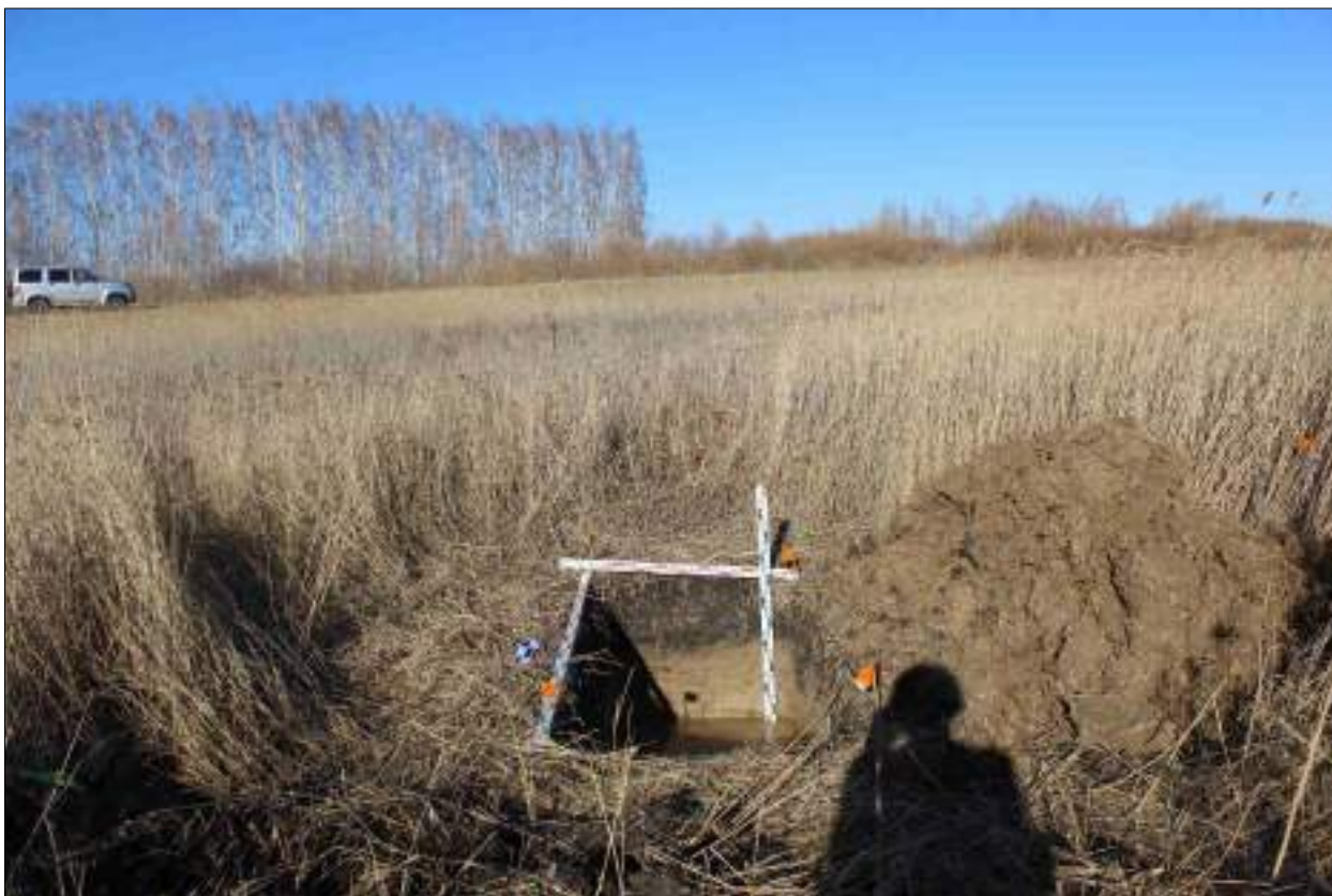
Рисунок 657 – «Распределительный газопровод р.п. Чистоозерное». Шурф №58. Общий вид выполненного шурфа. Снято с Ю.
