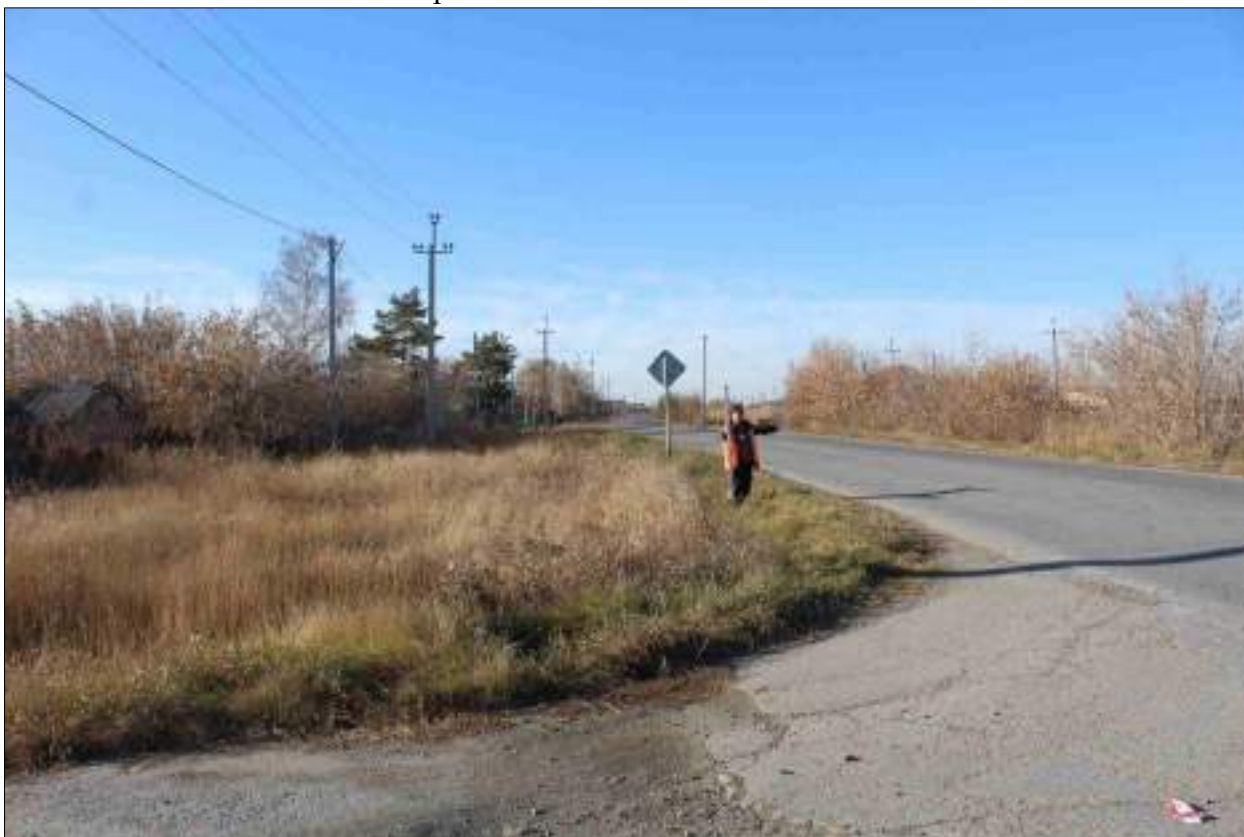
Рисунок 196 – «Распределительный газопровод р.п. Чистоозерное». Вид из точки 88 в направлении точки 115. Снято с ЮВ.
