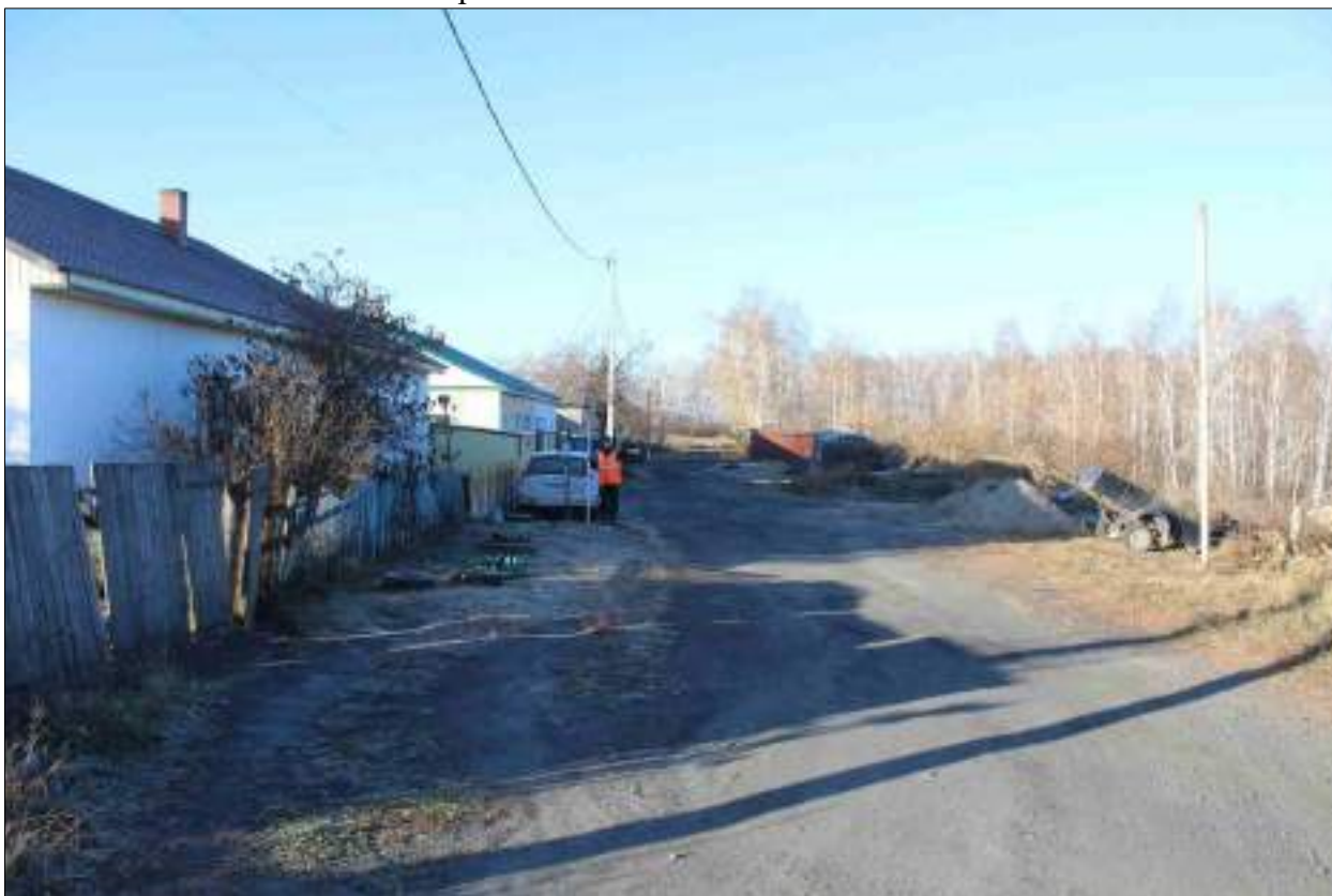
Рисунок 34 – «Распределительный газопровод р.п. Чистоозерное». Вид из точки 179 в направлении точки 180. Снято с В.
