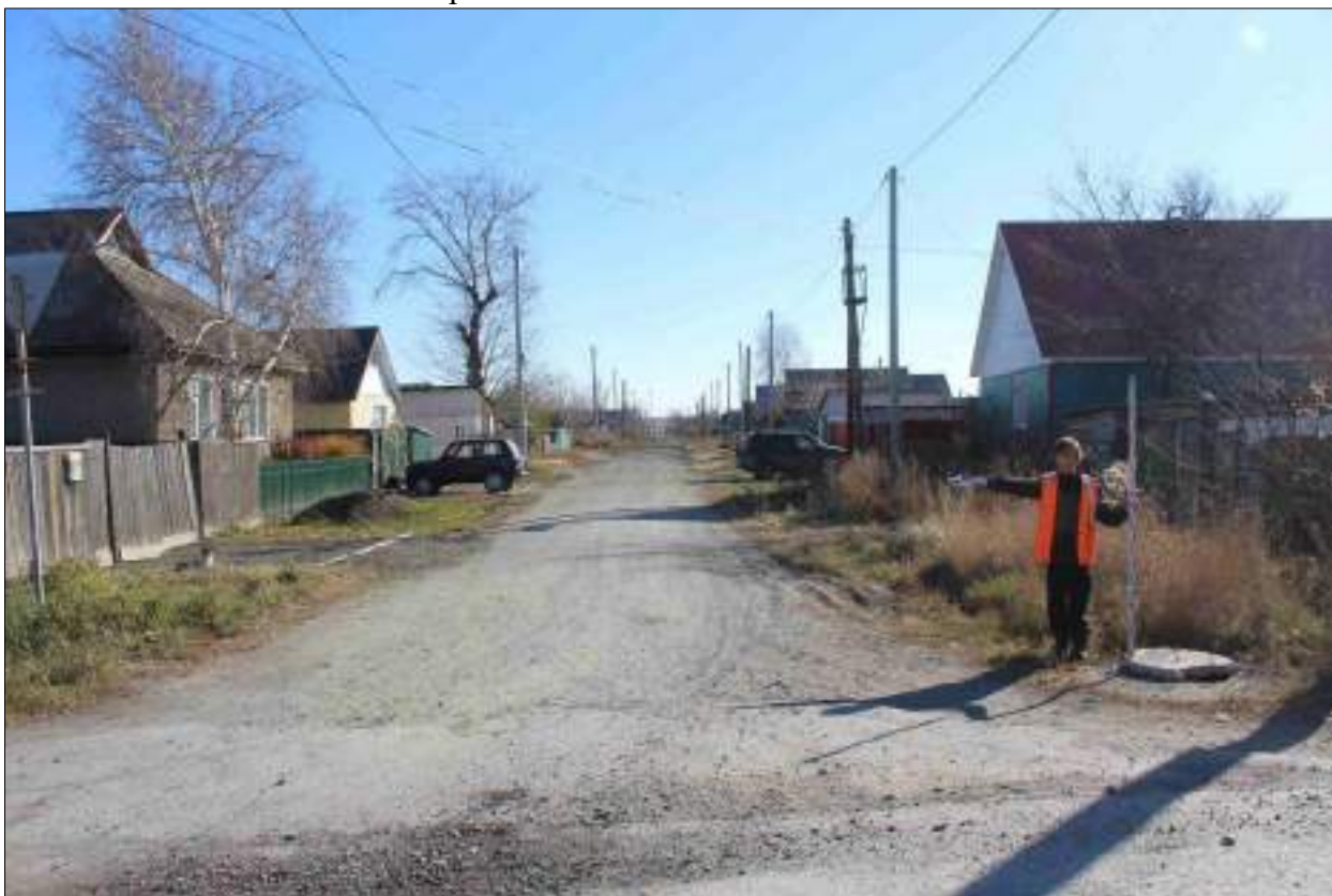
Рисунок 110 – «Распределительный газопровод р.п. Чистоозерное». Вид из точки 129 в направлении точки 117. Снято с СЗ.
