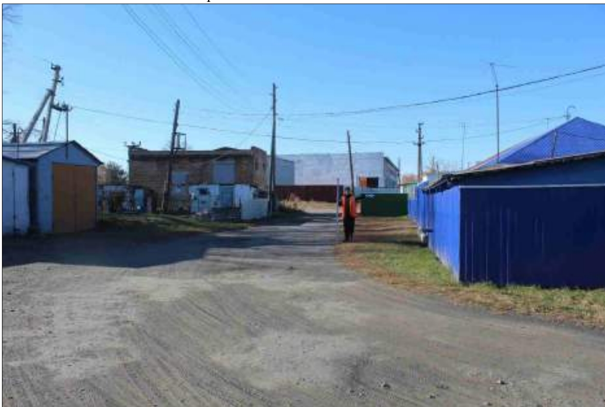
Рисунок 88 – «Распределительный газопровод р.п. Чистоозерное». Вид из точки 143 в направлении точки 144. Снято с В.
