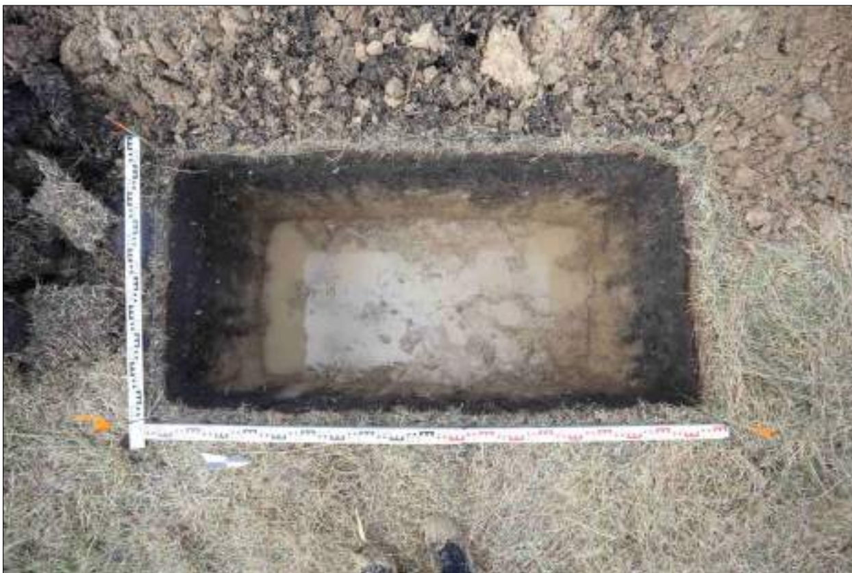
Рисунок 459 – «Распределительный газопровод р.п. Чистоозерное». Шурф №19. Дно шурфа. Снято с В.
