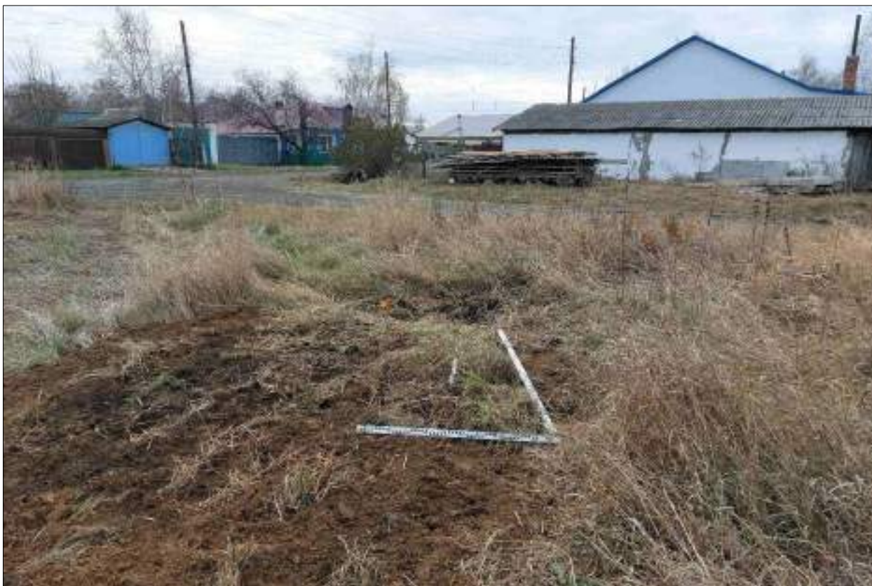
Рисунок 543 – «Распределительный газопровод р.п. Чистоозерное». Шурф №35. Рекультивация. Снято с С.
