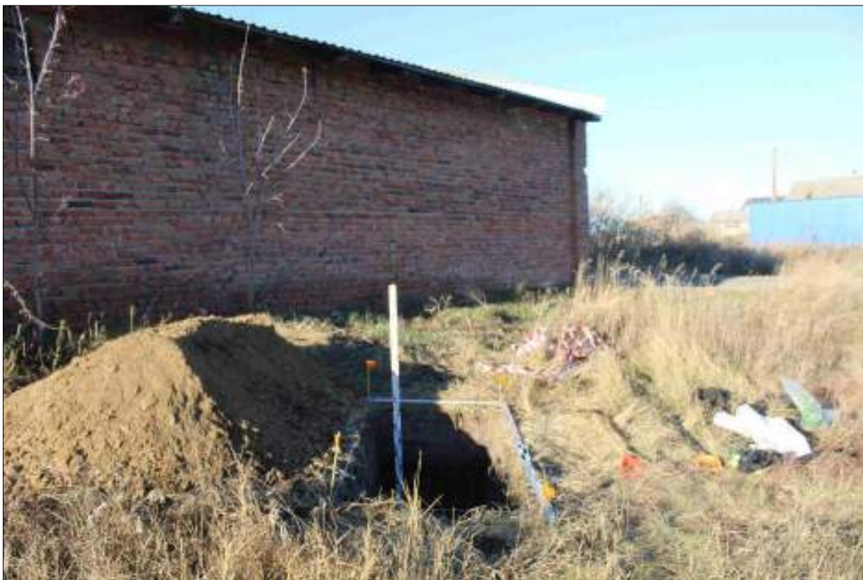
Рисунок 575 – «Распределительный газопровод р.п. Чистоозерное». Шурф №42. Общий вид выполненного шурфа. Снято с Ю.
