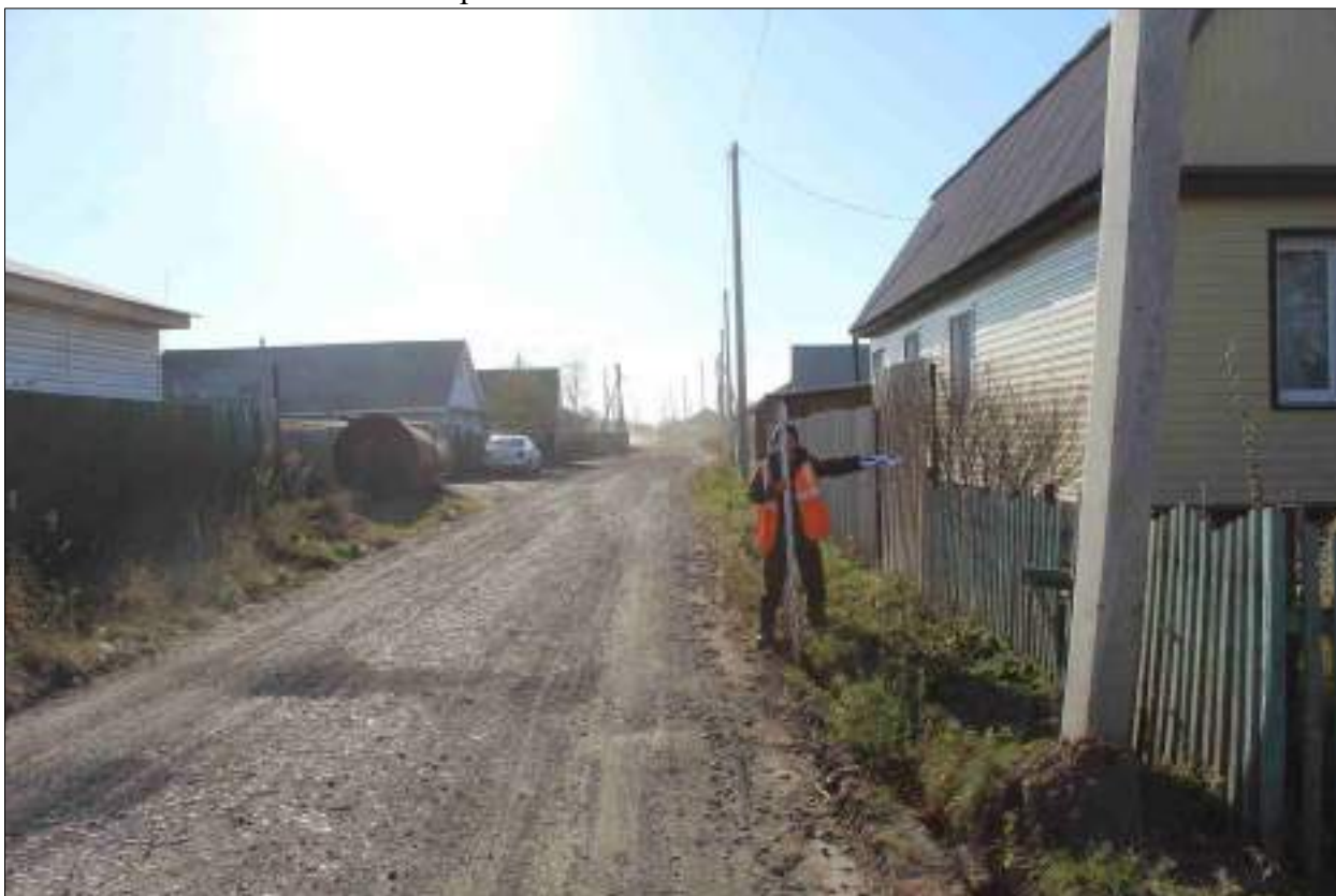
Рисунок 182 – «Распределительный газопровод р.п. Чистоозерное». Вид из точки 115 в направлении точки 114. Снято с СВ.
