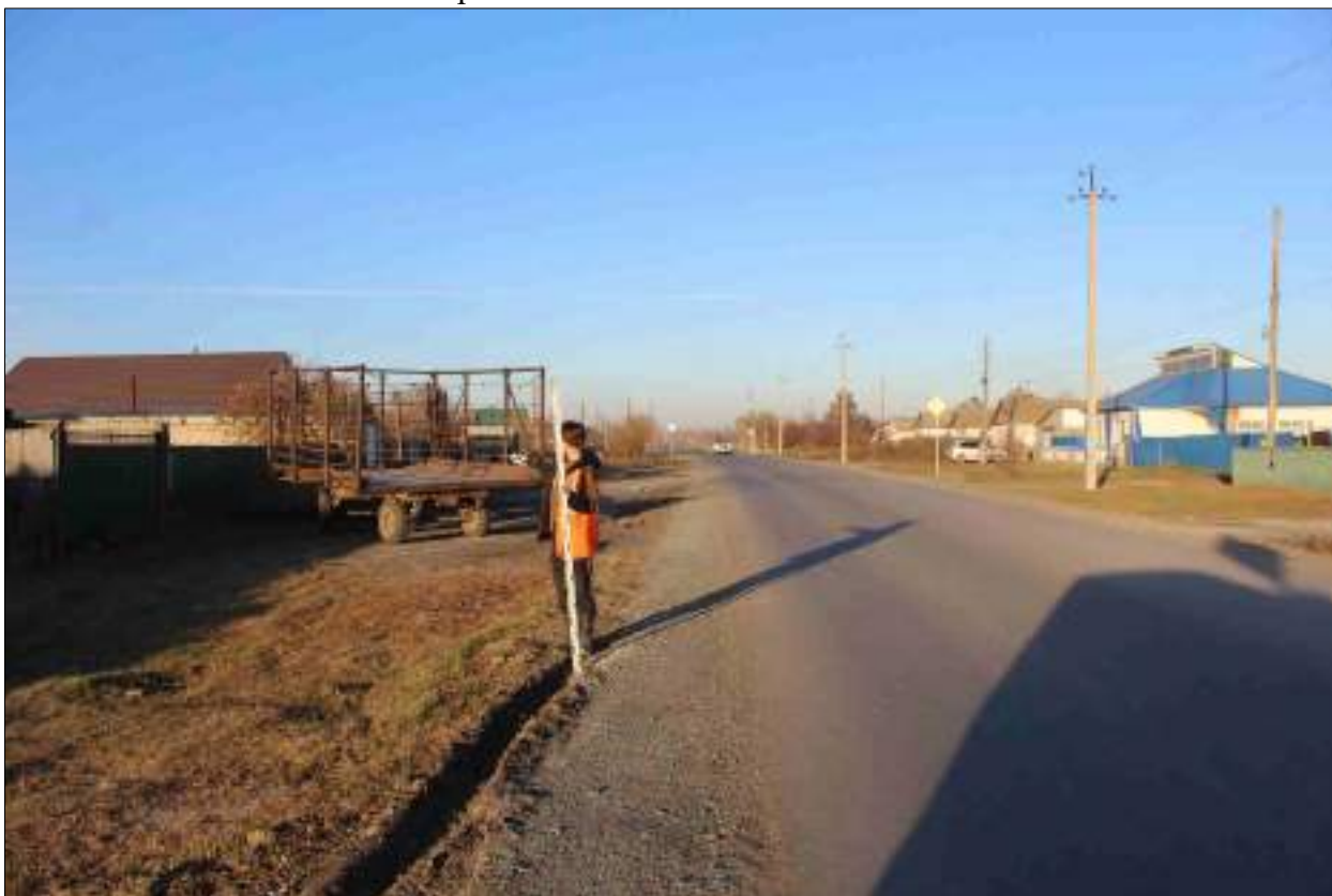
Рисунок 244 – «Распределительный газопровод р.п. Чистоозерное». Вид из точки 56 в направлении точки 57. Снято с ЮЗ.
