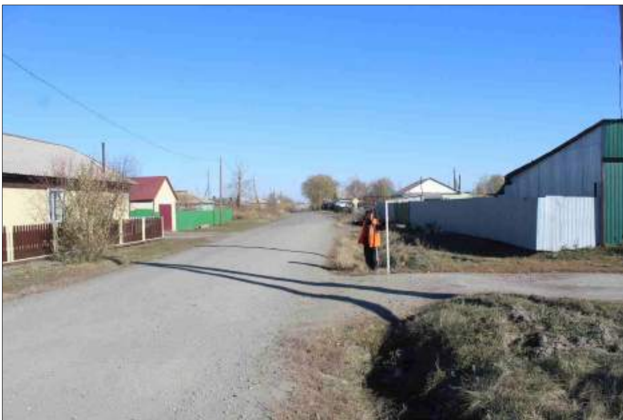
Рисунок 117 – «Распределительный газопровод р.п. Чистоозерное». Вид из точки 120 в направлении точки 119. Снято с ЮЗ.
