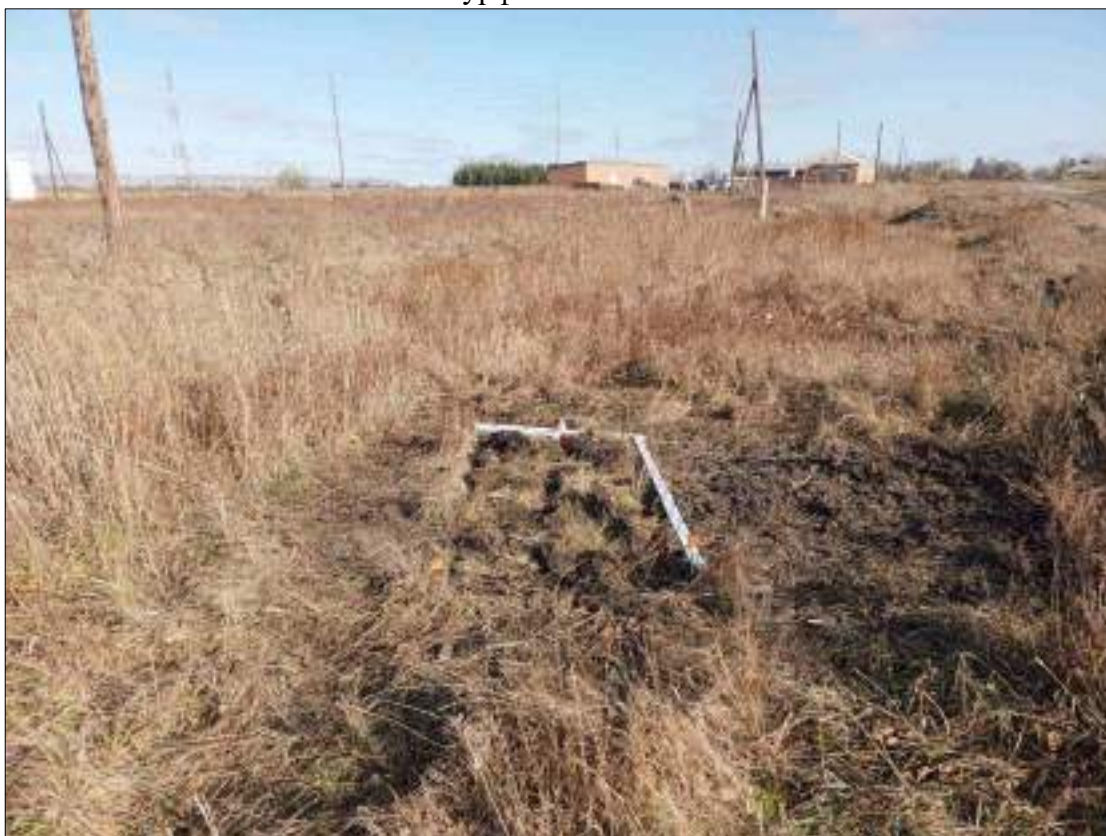
Рисунок 470 – «Распределительный газопровод р.п. Чистоозерное». Шурф №21. Рекультивация. Снято с Ю.
