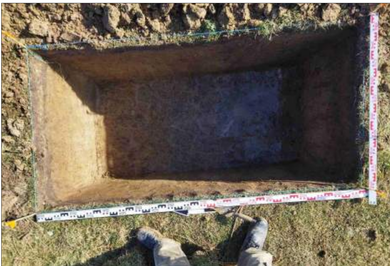
Рисунок 474 – «Распределительный газопровод р.п. Чистоозерное». Шурф №22. Дно шурфа. Снято с З.
