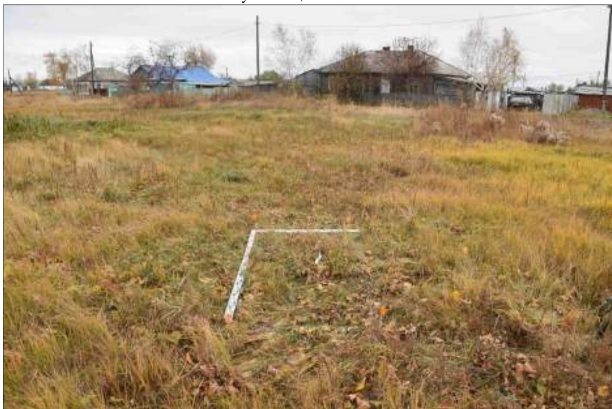
Рисунок 426 – «Распределительный газопровод р.п. Чистоозерное». Шурф №13. Общий вид. Разбивка. Снято с Ю.
