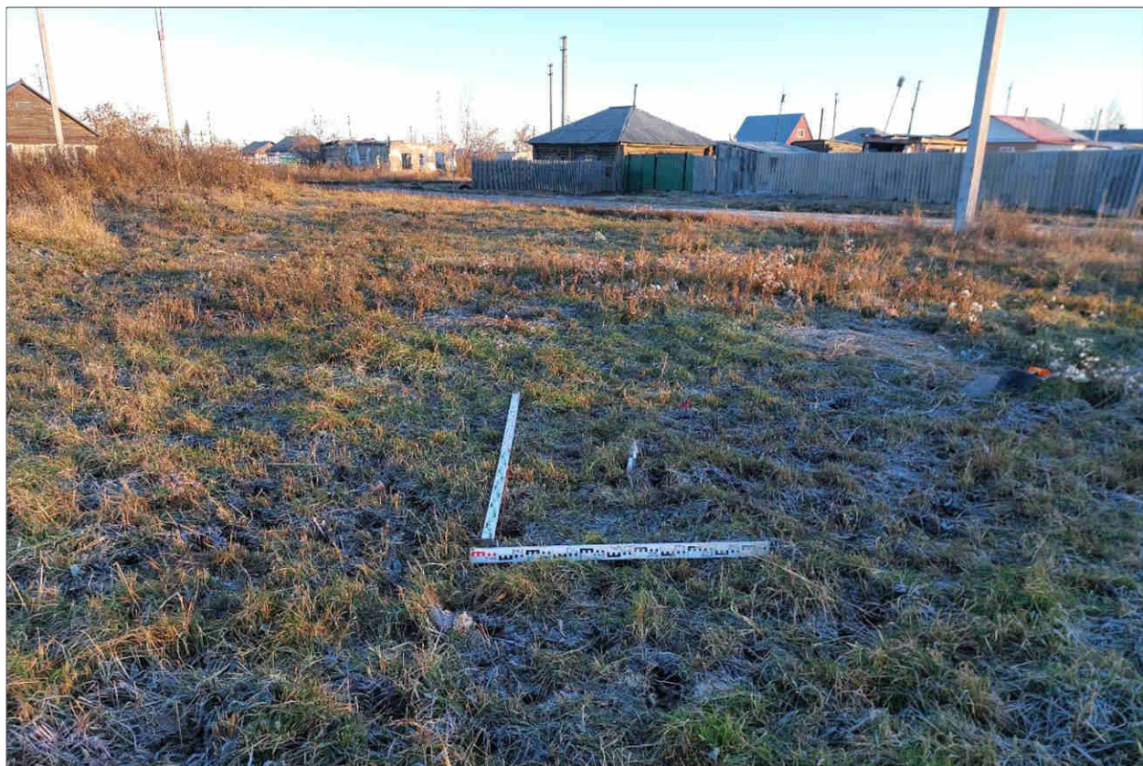
Рисунок 494 – «Распределительный газопровод р.п. Чистоозерное». Шурф №26. Общий вид. Разбивка. Снято с Ю.
