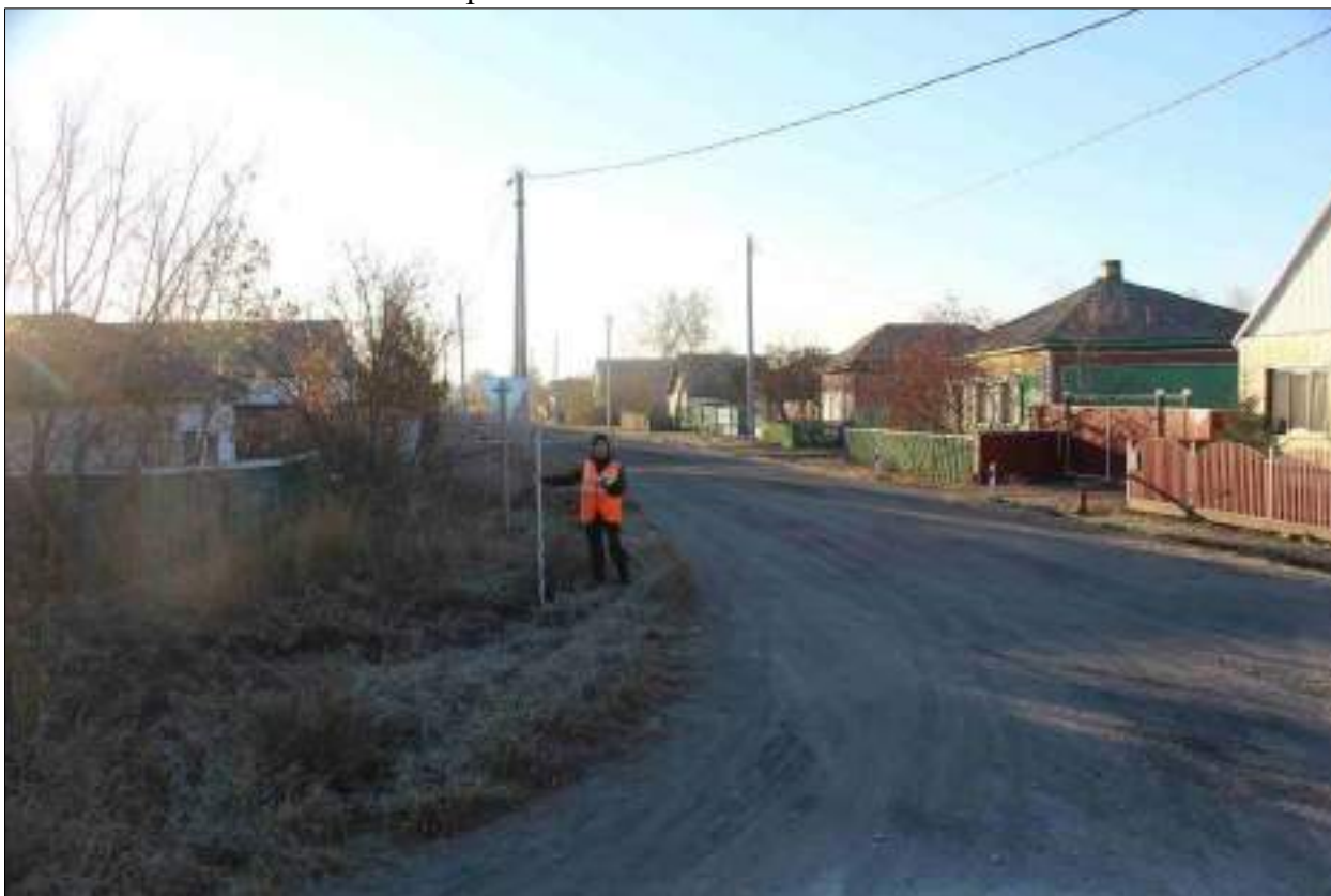
Рисунок 18 – «Распределительный газопровод р.п. Чистоозерное». Вид из точки 183 в направлении точки 154. Снято с СЗ.
