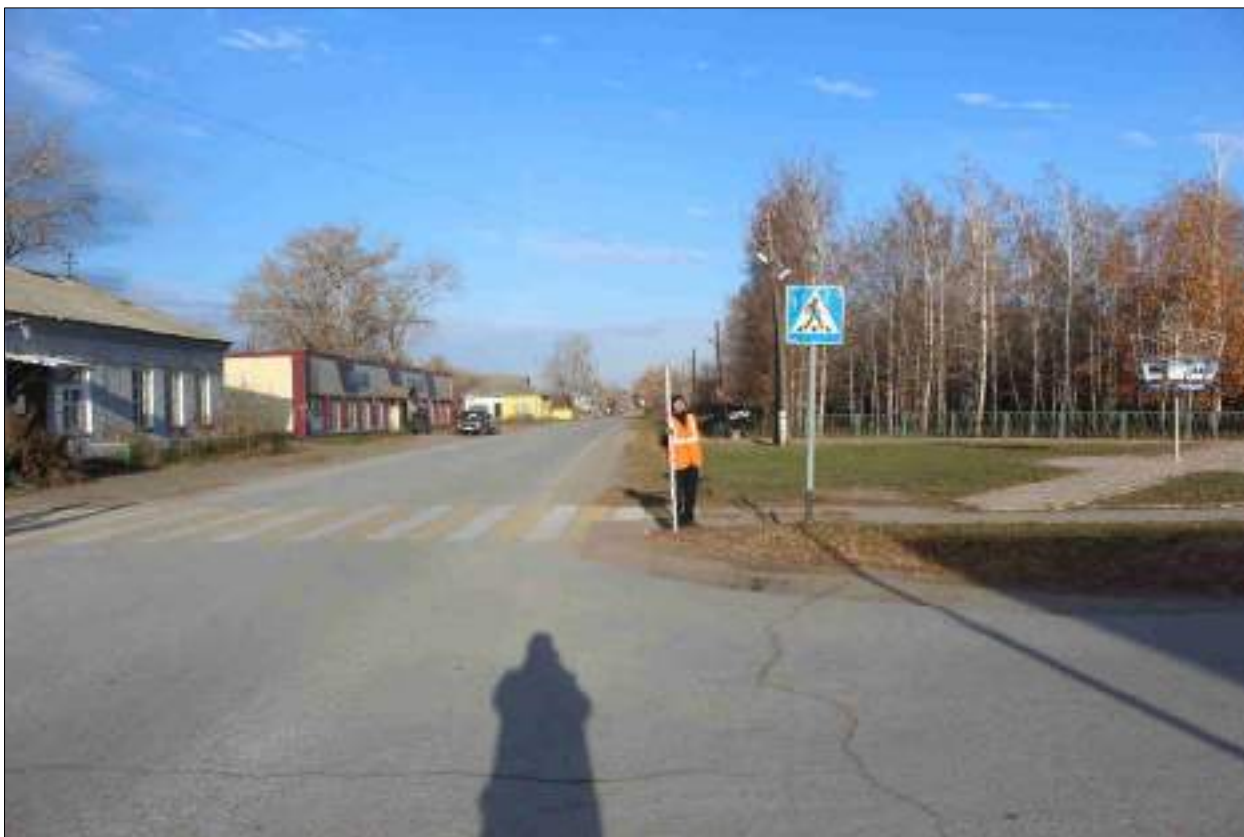
Рисунок 287 – «Распределительный газопровод р.п. Чистоозерное». Вид из точки 45 в направлении точки 22. Снято с ЮВ.
