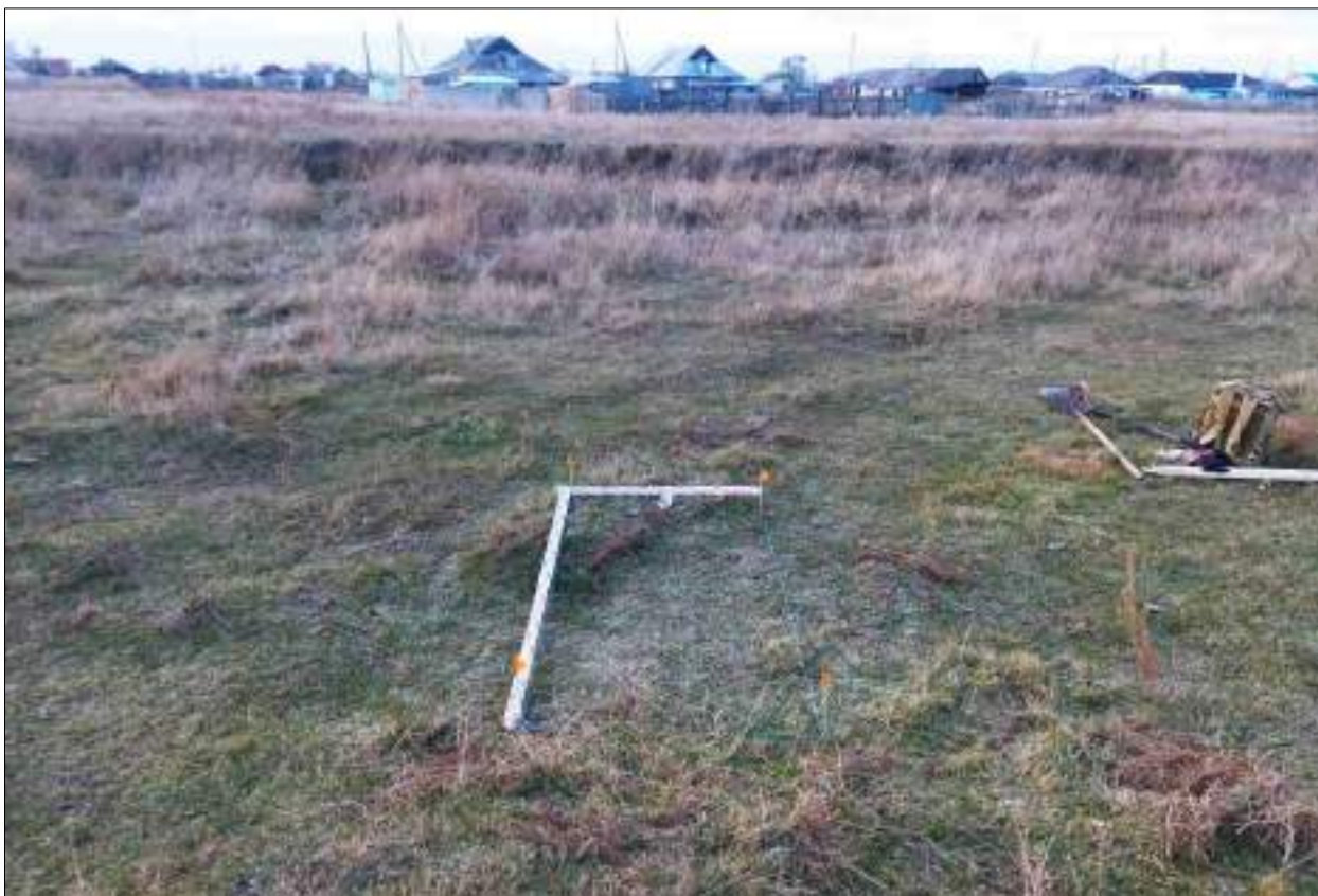
Рисунок 471 – «Распределительный газопровод р.п. Чистоозерное». Шурф №22. Общий вид. Разбивка. Снято с С.
