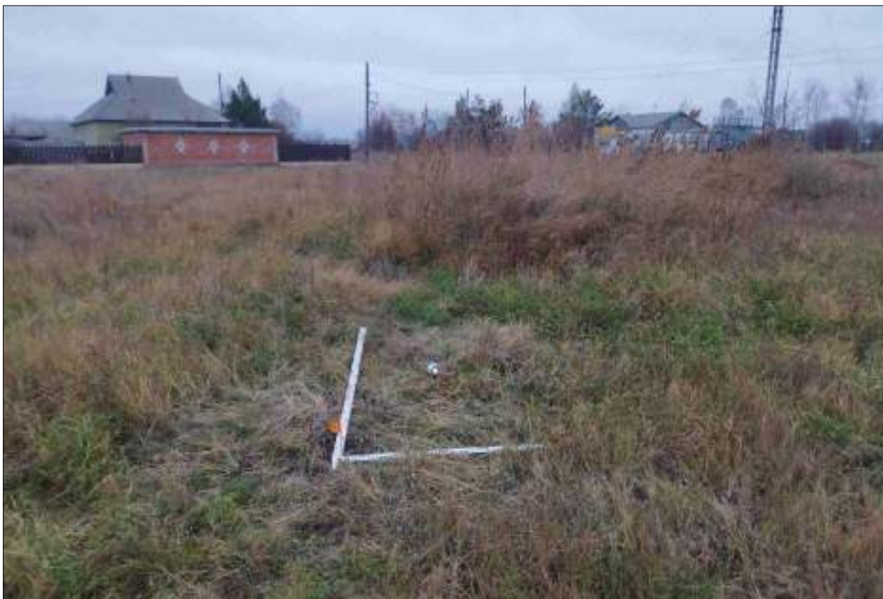
Рисунок 401 – «Распределительный газопровод р.п. Чистоозерное». Шурф №8. Общий вид. Разбивка. Снято с Ю.
