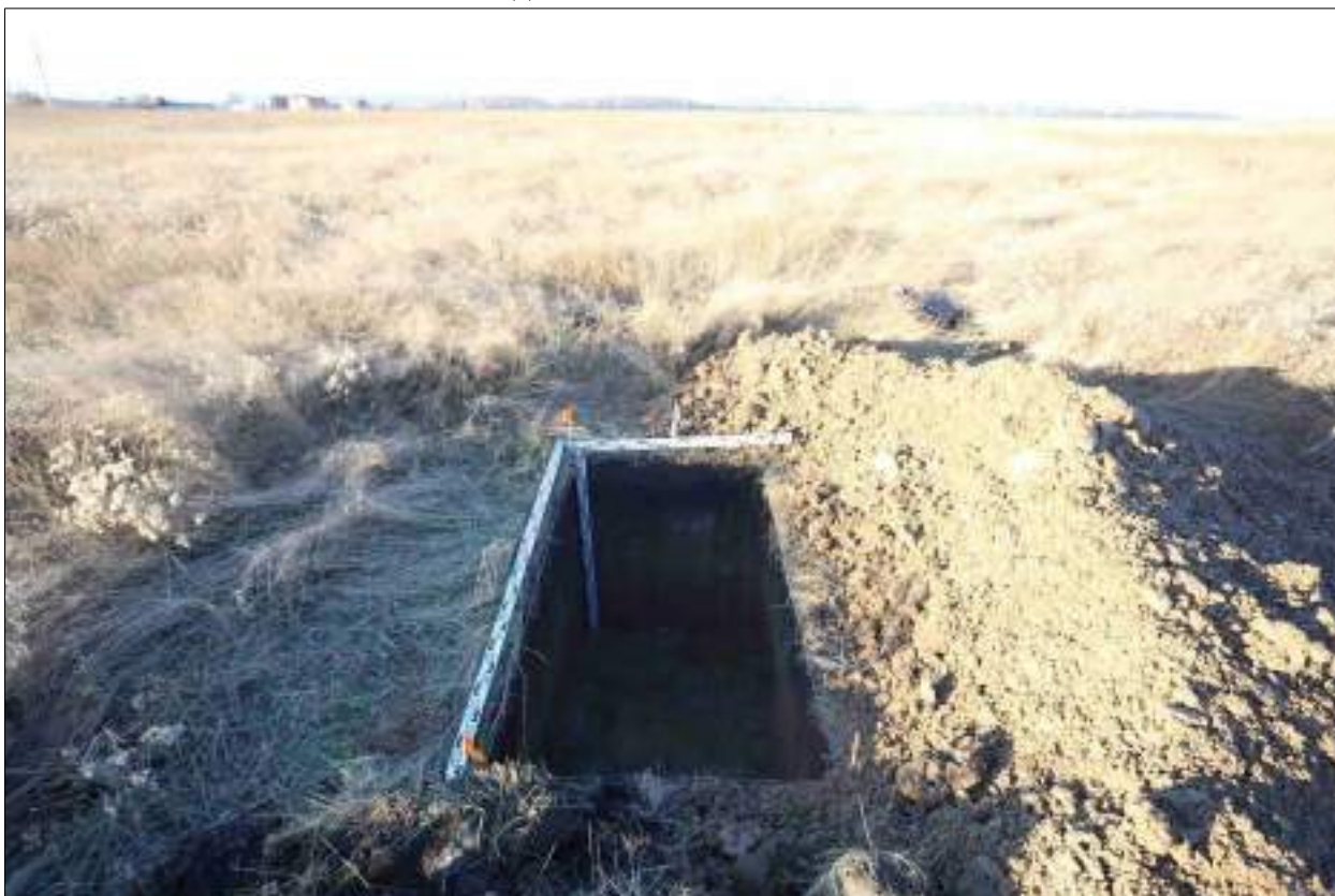
Рисунок 452 – «Распределительный газопровод р.п. Чистоозерное». Шурф №18. Общий вид выполненного шурфа. Снято с Ю.
