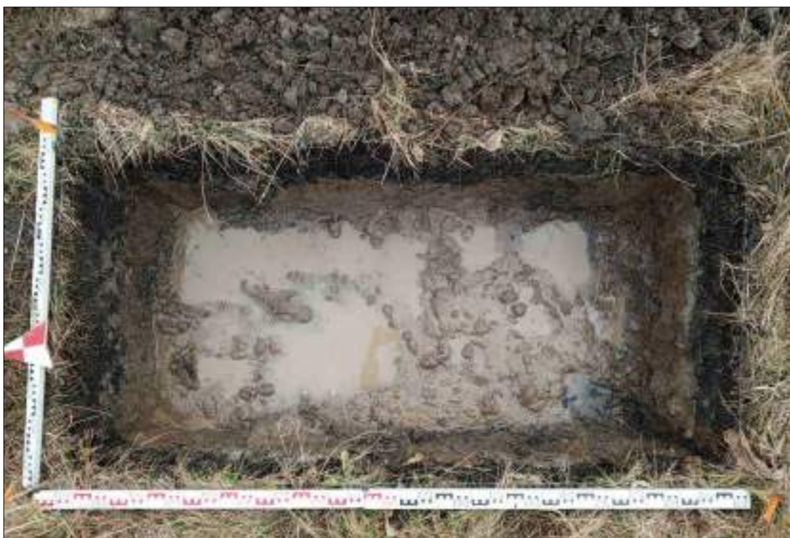
Рисунок 469 – «Распределительный газопровод р.п. Чистоозерное». Шурф №21. Дно шурфа. Снято с З.
