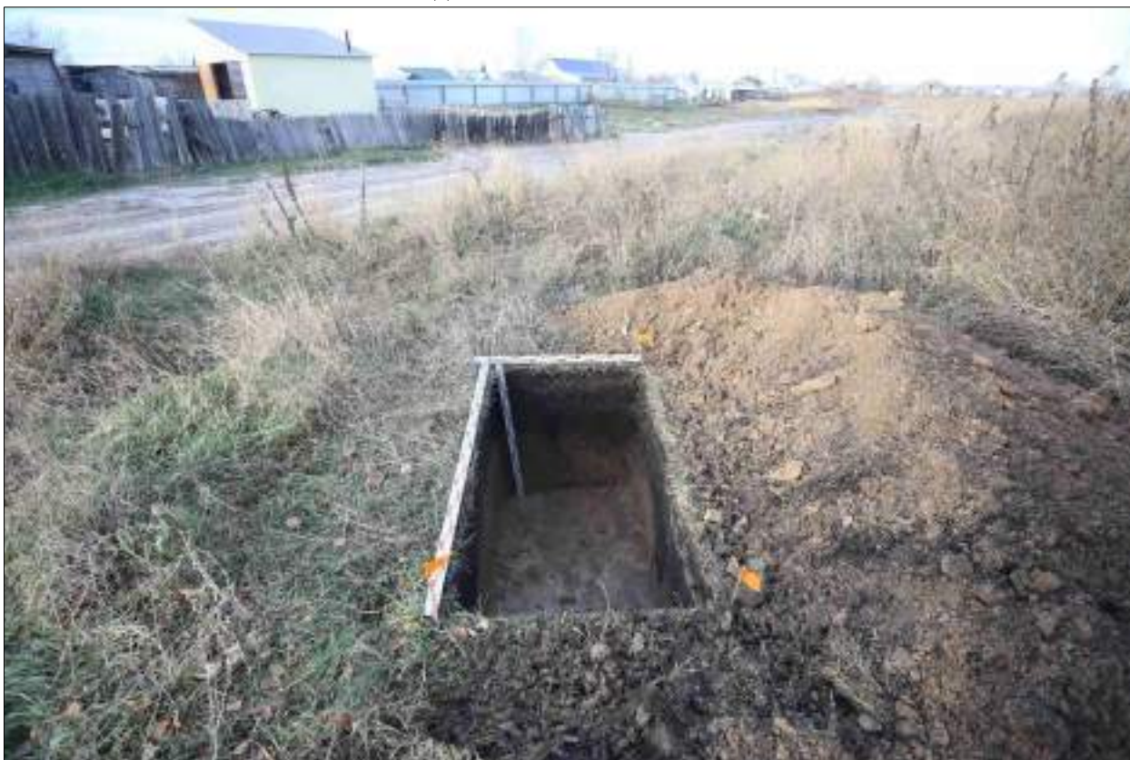
Рисунок 382 – «Распределительный газопровод р.п. Чистоозерное». Шурф №4. Общий вид выполненного шурфа. Снято с Ю.
