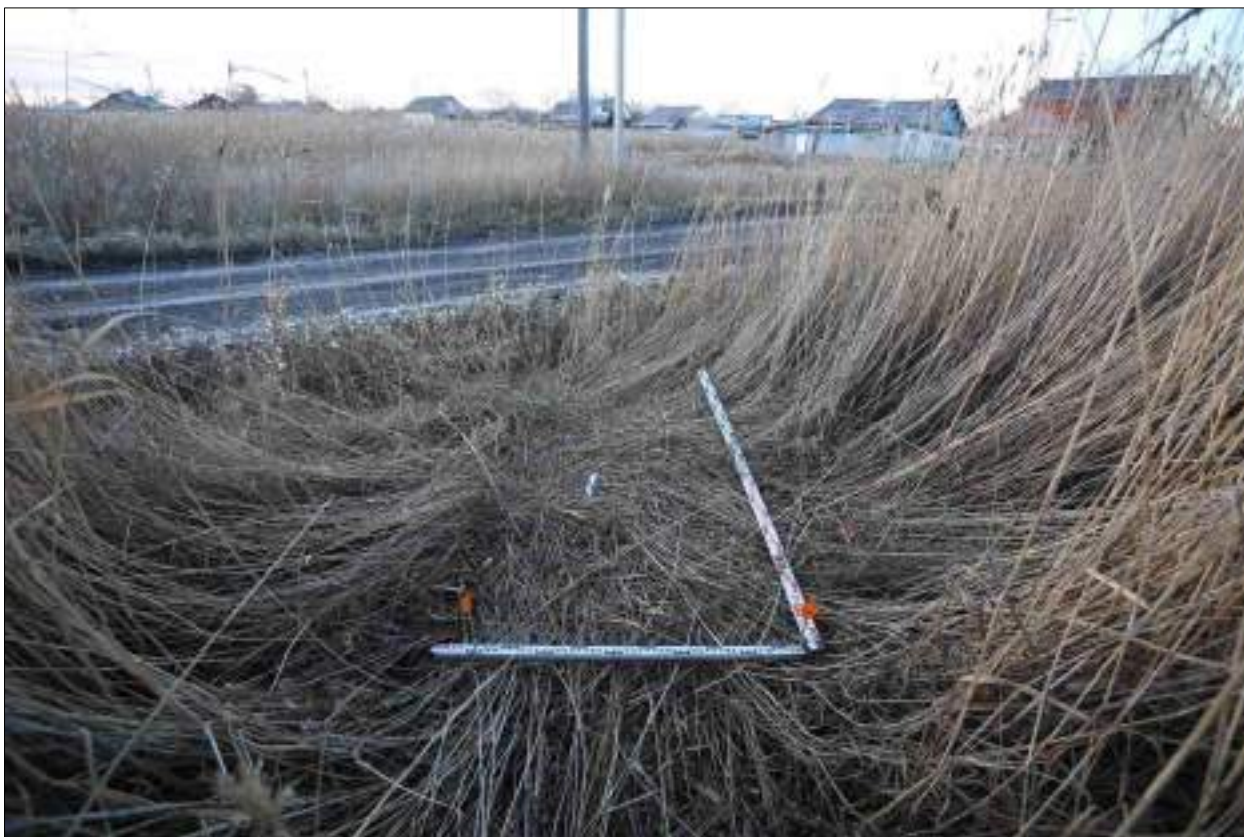
Рисунок 489 – «Распределительный газопровод р.п. Чистоозерное». Шурф №25. Общий вид. Разбивка. Снято с С.
