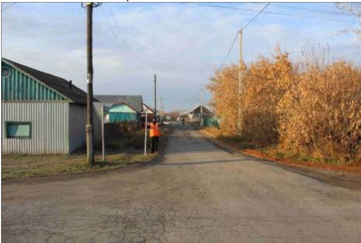
Рисунок 258 – «Распределительный газопровод р.п. Чистоозерное». Вид из точки 41 в направлении точки 42. Снято с СВ.
