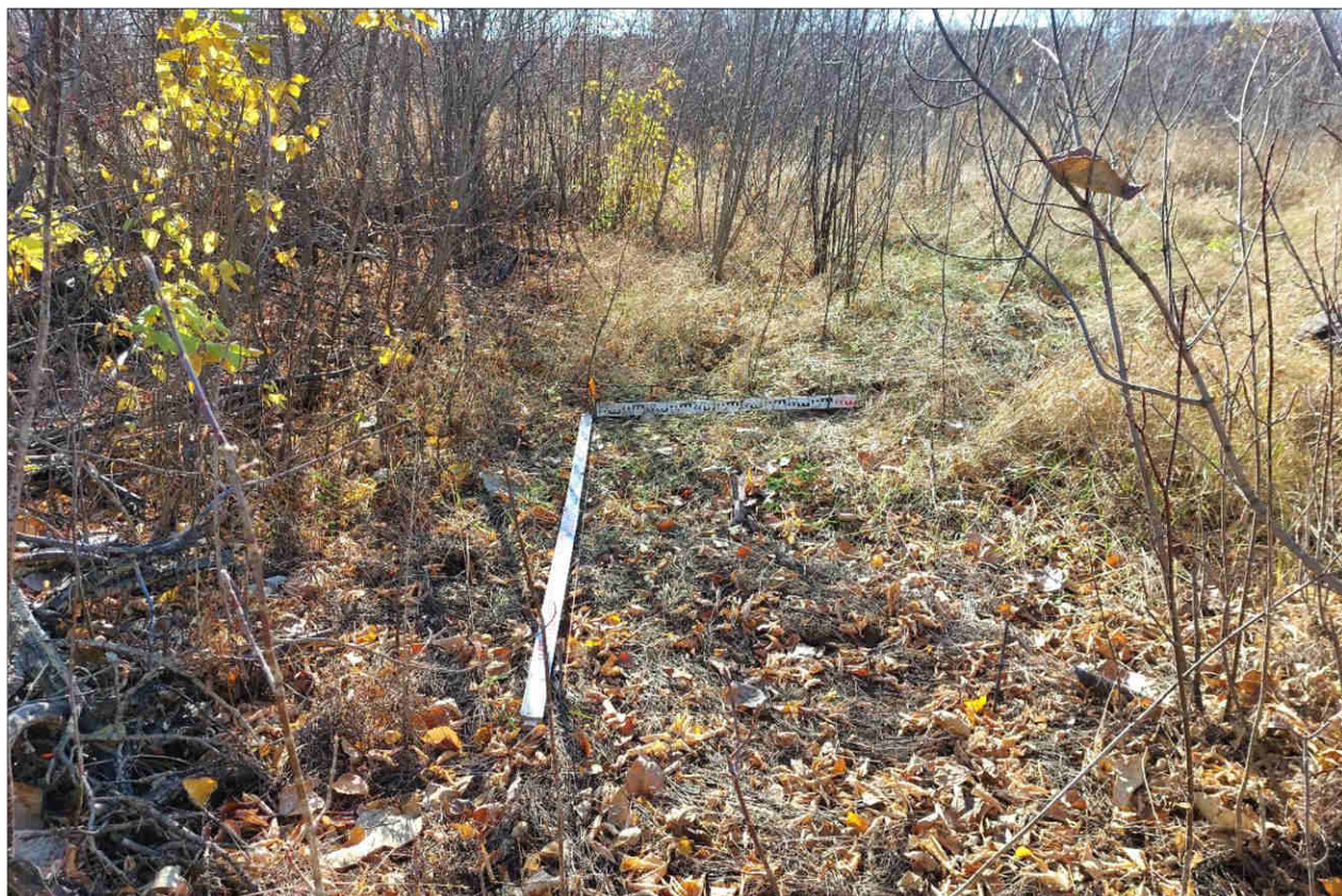
Рисунок 559 – «Распределительный газопровод р.п. Чистоозерное». Шурф №39. Общий вид. Разбивка. Снято с С.
