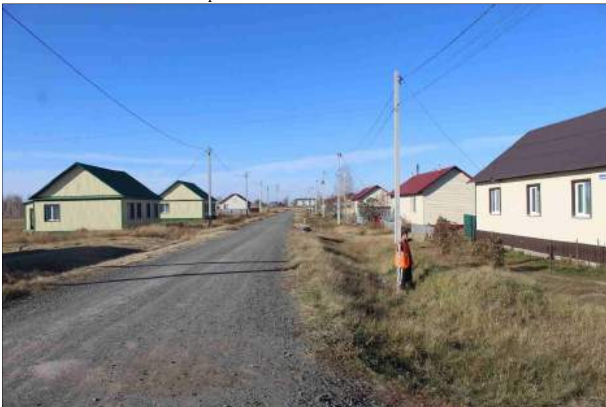
Рисунок 162 – «Распределительный газопровод р.п. Чистоозерное». Вид из точки 99 в направлении точки 98. Снято с ЮВ.
