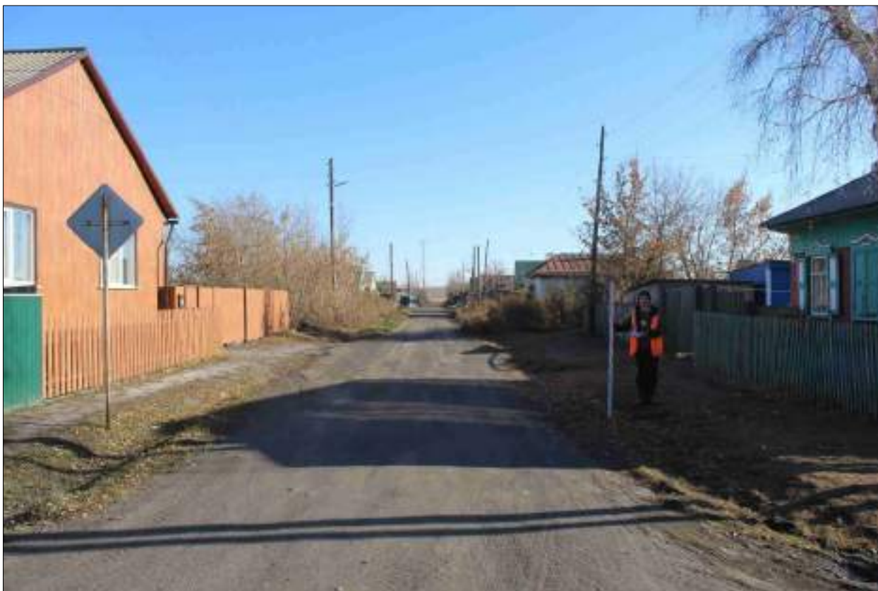
Рисунок 185 – «Распределительный газопровод р.п. Чистоозерное». Вид из точки 114 в направлении точки 89. Снято с СЗ.
