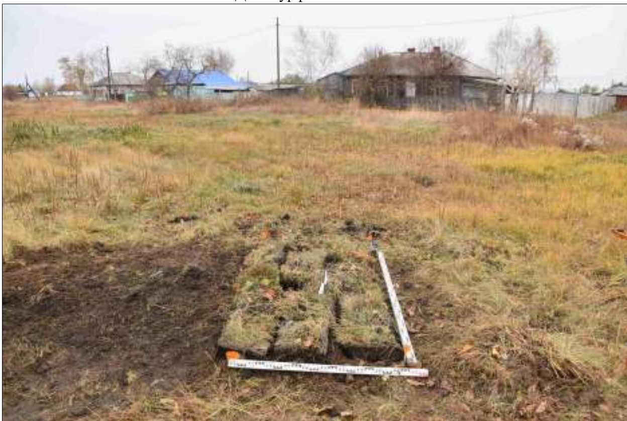
Рисунок 430 – «Распределительный газопровод р.п. Чистоозерное». Шурф №13. Рекультивация. Снято с Ю.
