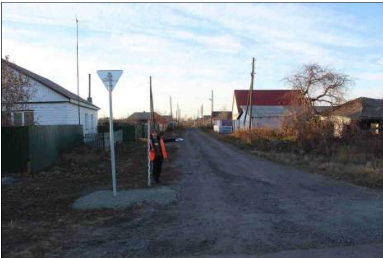
Рисунок 243 – «Распределительный газопровод р.п. Чистоозерное». Вид из точки 57 в направлении точки 40. Снято с ЮВ.
