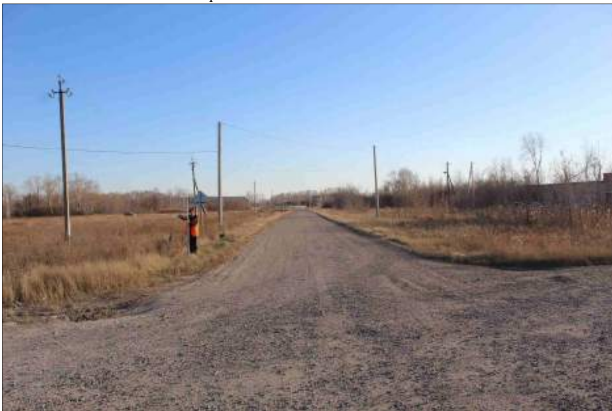
Рисунок 214 – «Распределительный газопровод р.п. Чистоозерное». Вид из точки 84 в направлении точки 85. Снято с СЗ.
