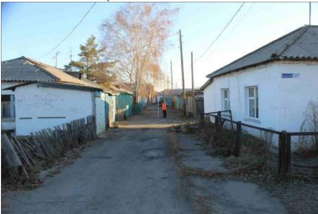
Рисунок 22 – «Распределительный газопровод р.п. Чистоозерное». Вид из точки 185 в направлении точки 186. Снято с З.
