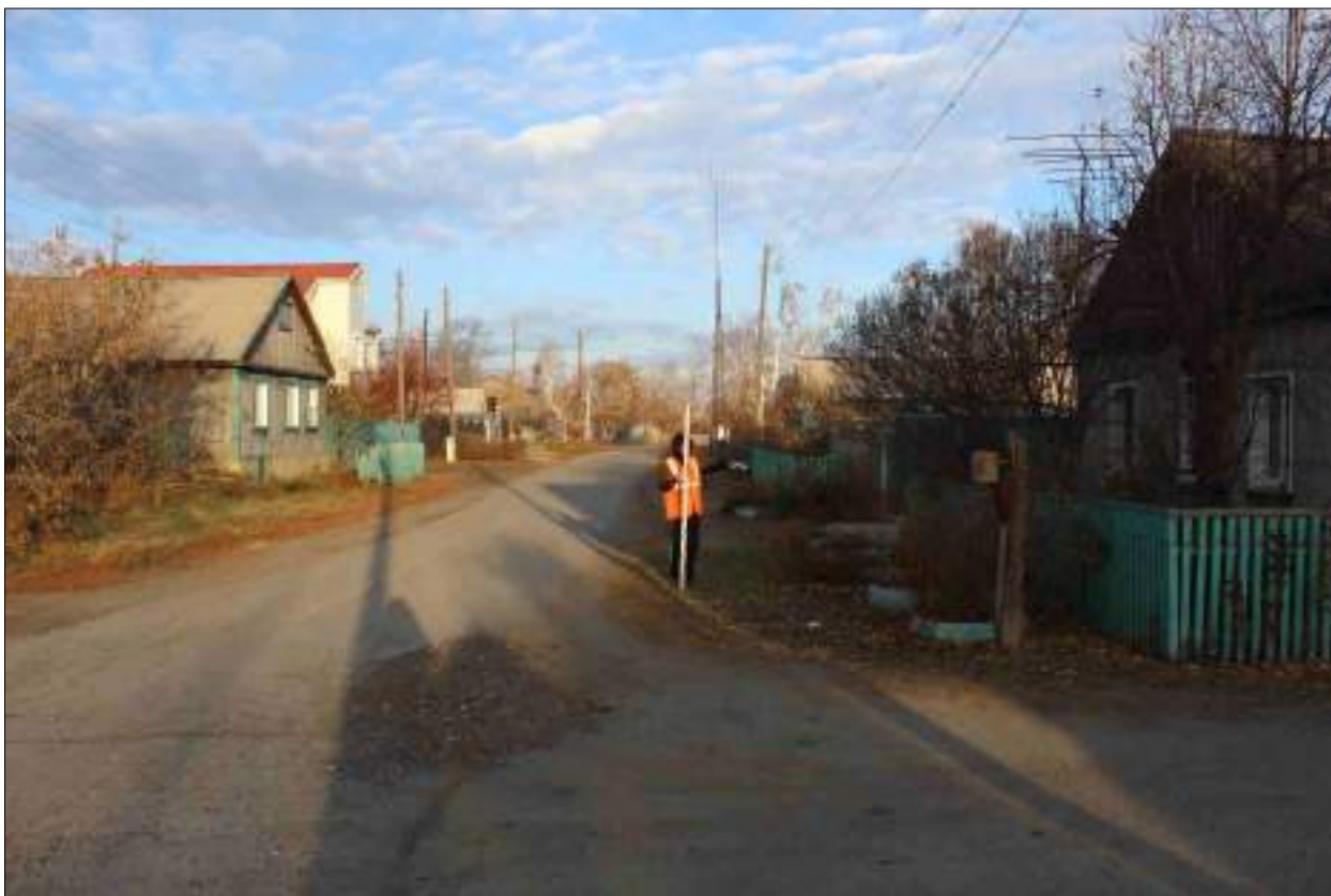
Рисунок 259 – «Распределительный газопровод р.п. Чистоозерное». Вид из точки 41 в направлении точки 47. Снято с ЮВ.
