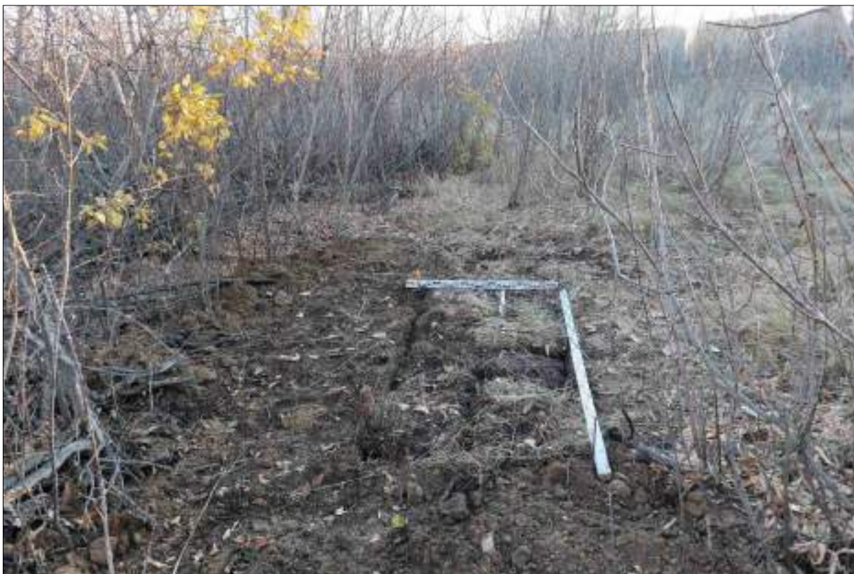
Рисунок 563 – «Распределительный газопровод р.п. Чистоозерное». Шурф №39. Рекультивация. Снято с С.
