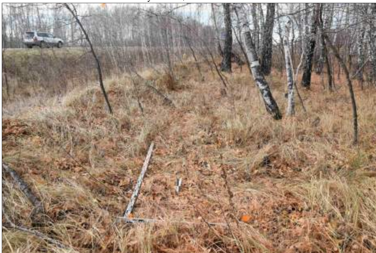
Рисунок 524 – «Распределительный газопровод р.п. Чистоозерное». Шурф №32. Общий вид. Разбивка. Снято с С.
