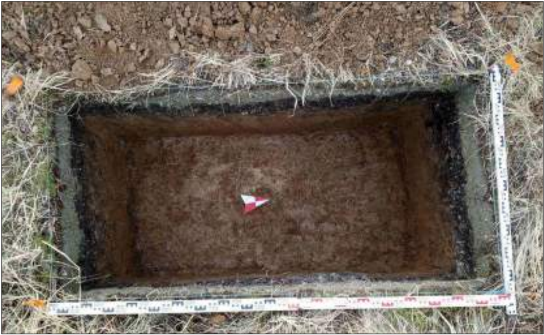
Рисунок 537 – «Распределительный газопровод р.п. Чистоозерное». Шурф №34. Дно шурфа. Снято с В.
