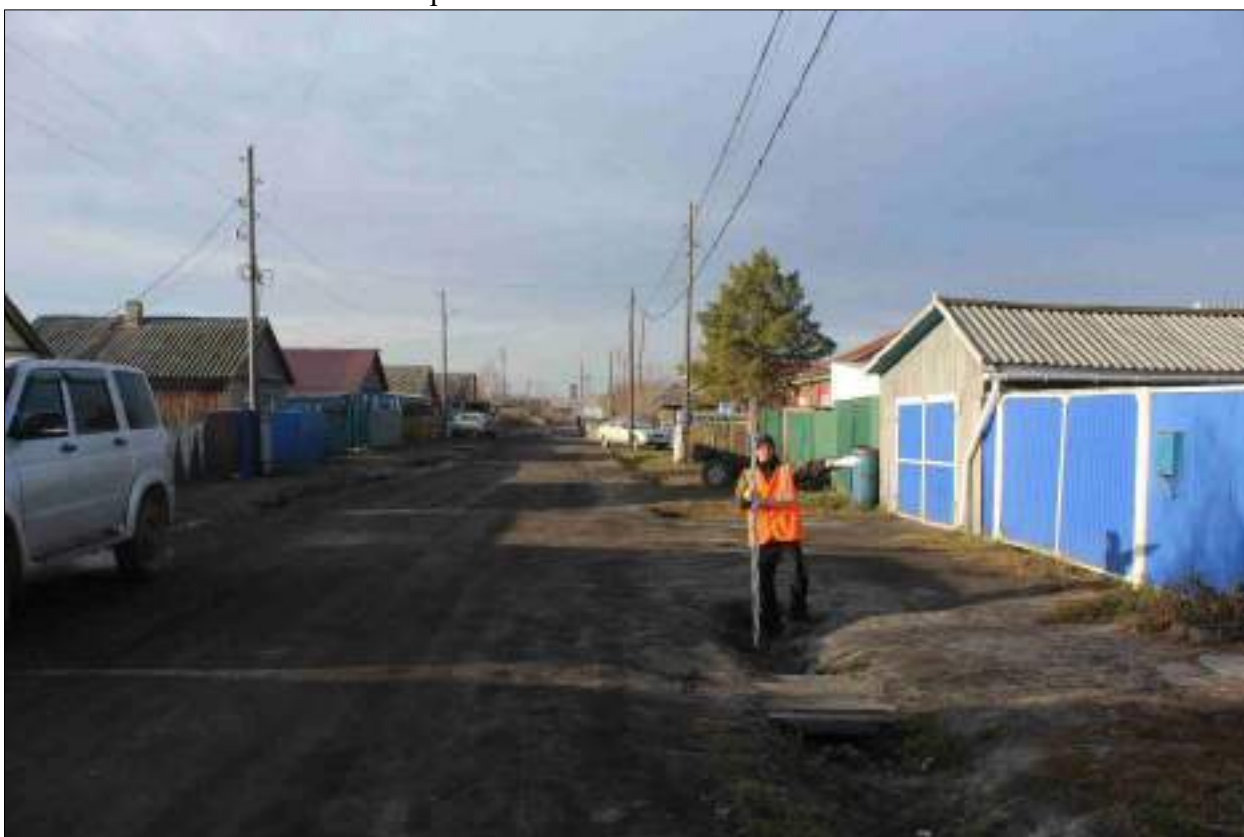
Рисунок 290 – «Распределительный газопровод р.п. Чистоозерное». Вид из точки 35 в направлении точки 38. Снято с СВ.
