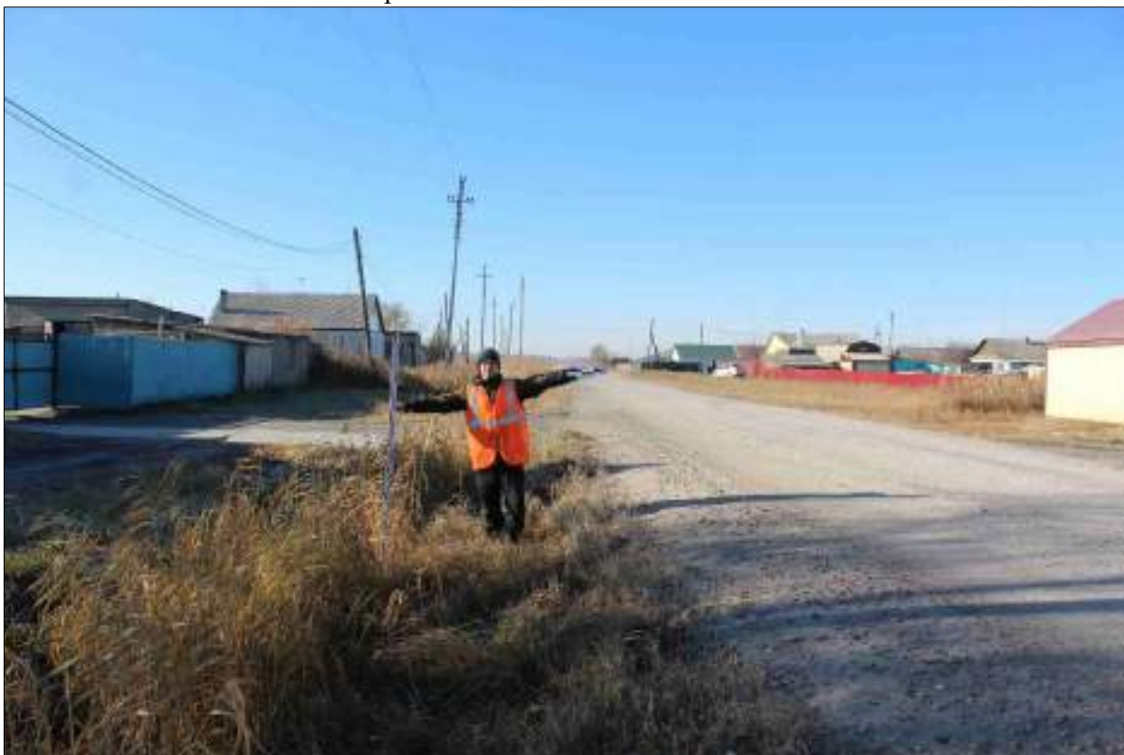
Рисунок 62 – «Распределительный газопровод р.п. Чистоозерное». Вид из точки 155 в направлении точки 168. Снято с В.
