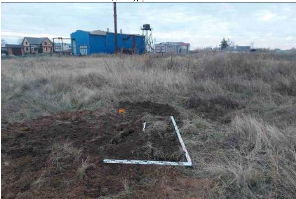
Рисунок 518 – «Распределительный газопровод р.п. Чистоозерное». Шурф №30. Рекультивация. Снято с С.
