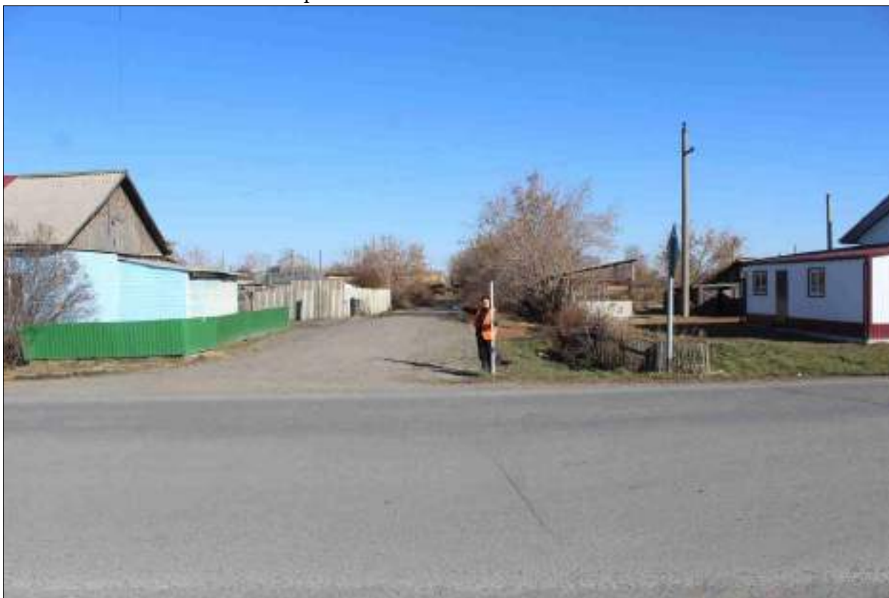
Рисунок 108 – «Распределительный газопровод р.п. Чистоозерное». Вид из точки 130 в направлении точки 131. Снято с ЮЗ.
