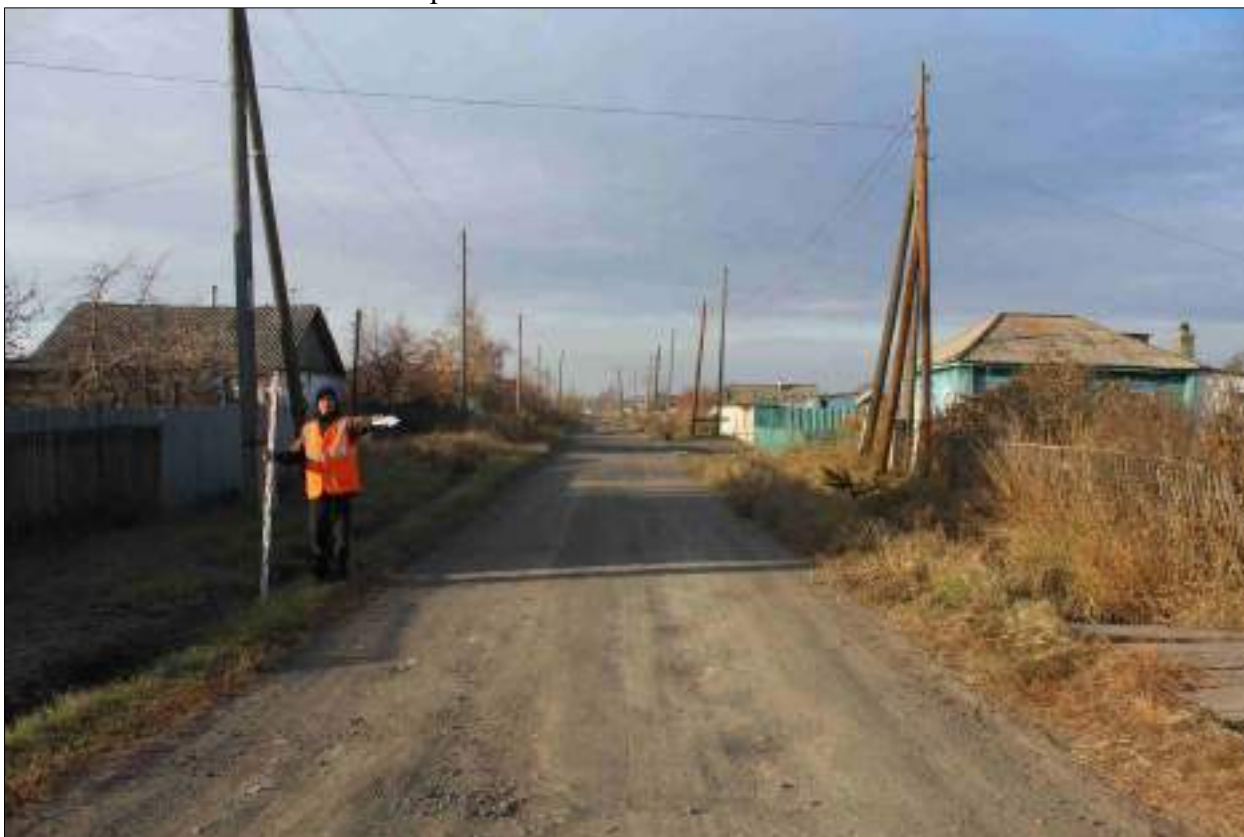
Рисунок 292 – «Распределительный газопровод р.п. Чистоозерное». Вид из точки 30 в направлении точки 35. Снято с СВ.
