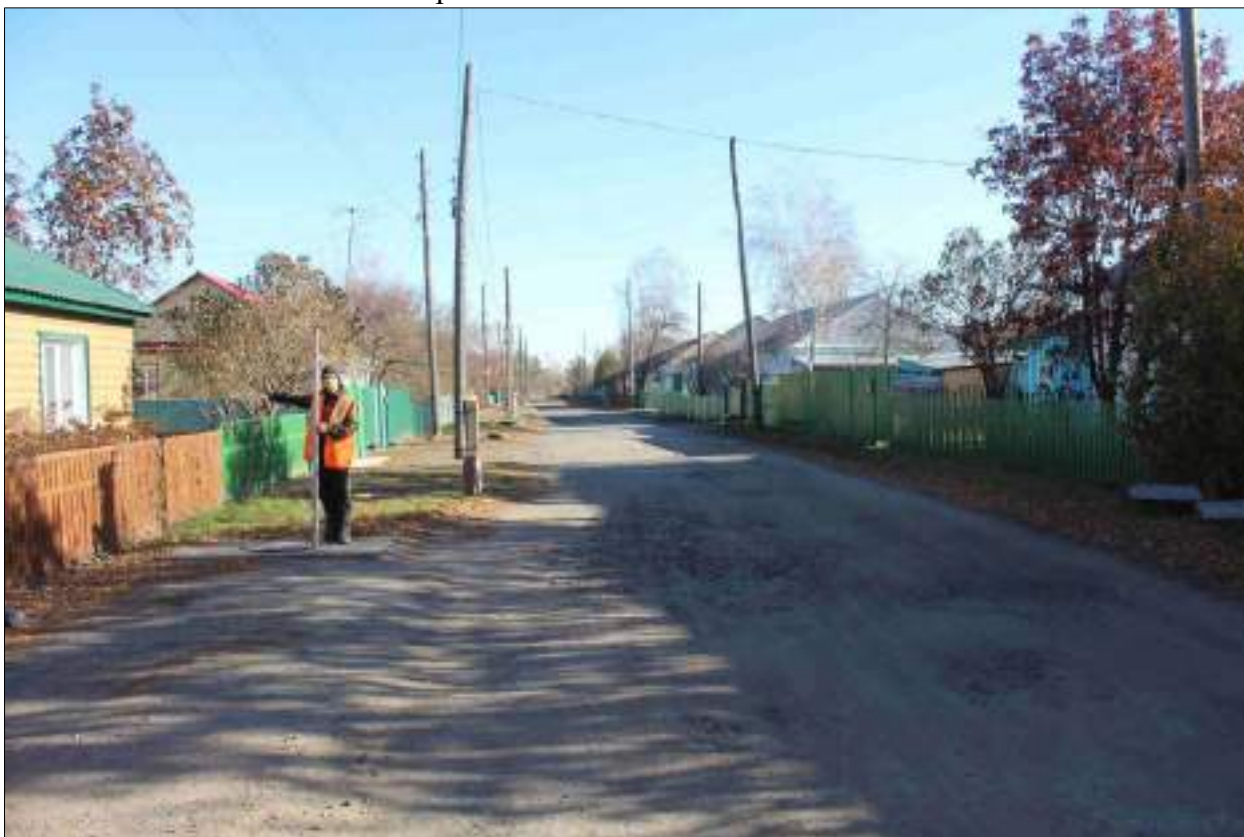
Рисунок 86 – «Распределительный газопровод р.п. Чистоозерное». Вид из точки 142 в направлении точки 141. Снято с ЮЗ.
