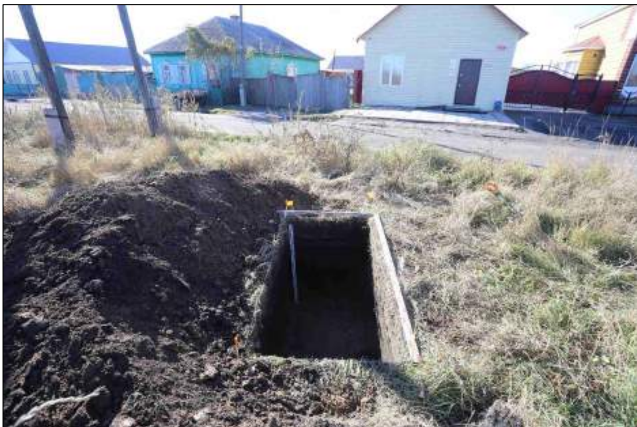
Рисунок 641 – «Распределительный газопровод р.п. Чистоозерное». Шурф №55. Общий вид выполненного шурфа. Снято с С.
