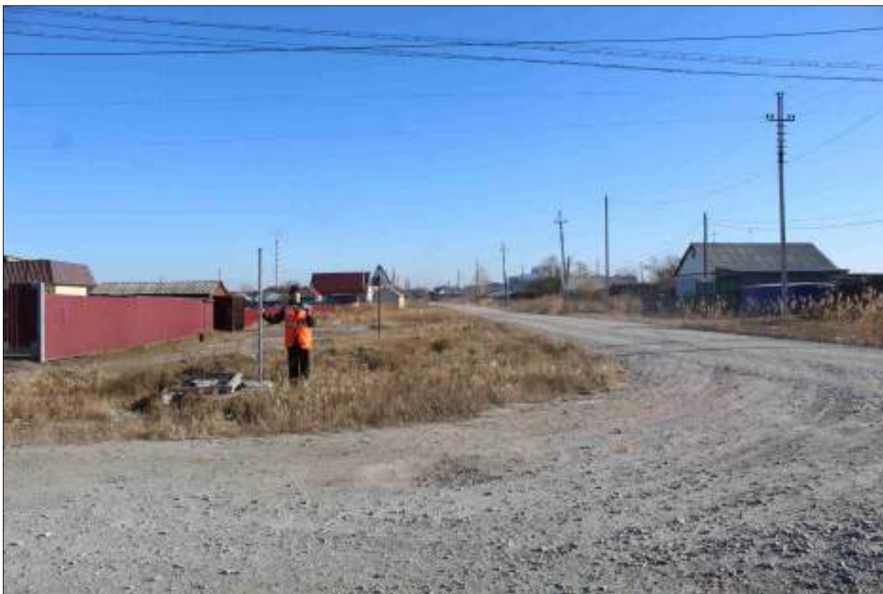
Рисунок 59 – «Распределительный газопровод р.п. Чистоозерное». Вид из точки 168 в направлении точки 155. Снято с ЮЗ.
