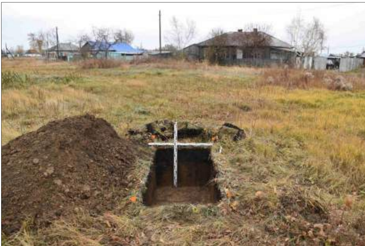
Рисунок 427 – «Распределительный газопровод р.п. Чистоозерное». Шурф №13. Общий вид выполненного шурфа. Снято с Ю.
