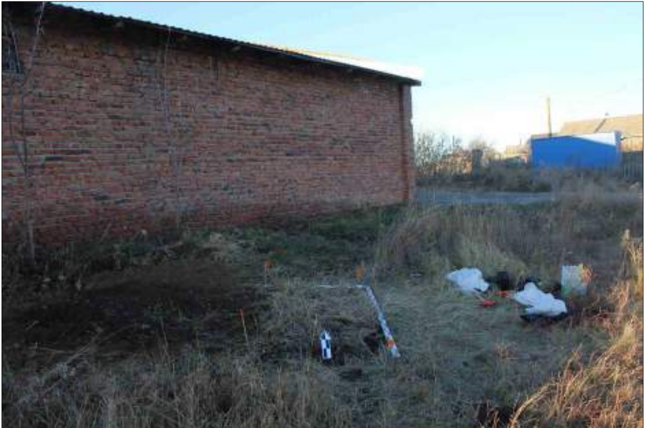
Рисунок 579 – «Распределительный газопровод р.п. Чистоозерное». Шурф №42. Рекультивация. Снято с Ю.
