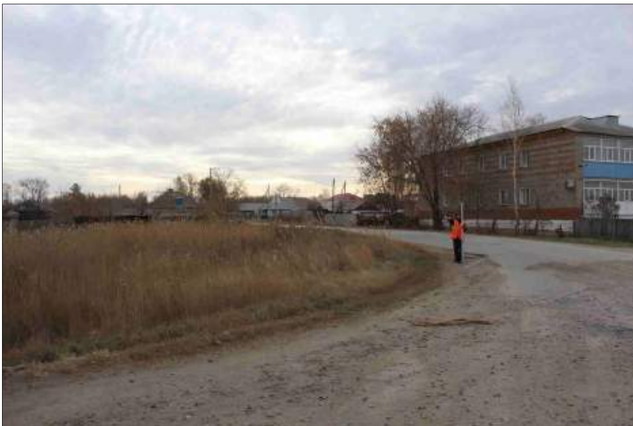
Рисунок 337 – «Распределительный газопровод р.п. Чистоозерное». Вид из точки 14 в направлении точки 19. Снято с СЗ.
