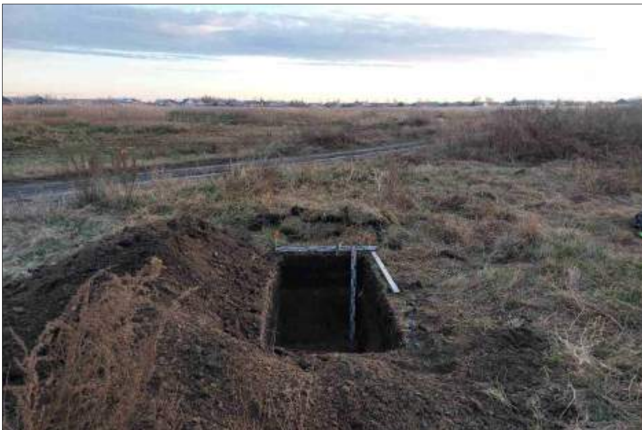
Рисунок 591 – «Распределительный газопровод р.п. Чистоозерное». Шурф №45. Общий вид выполненного шурфа. Снято с С.
