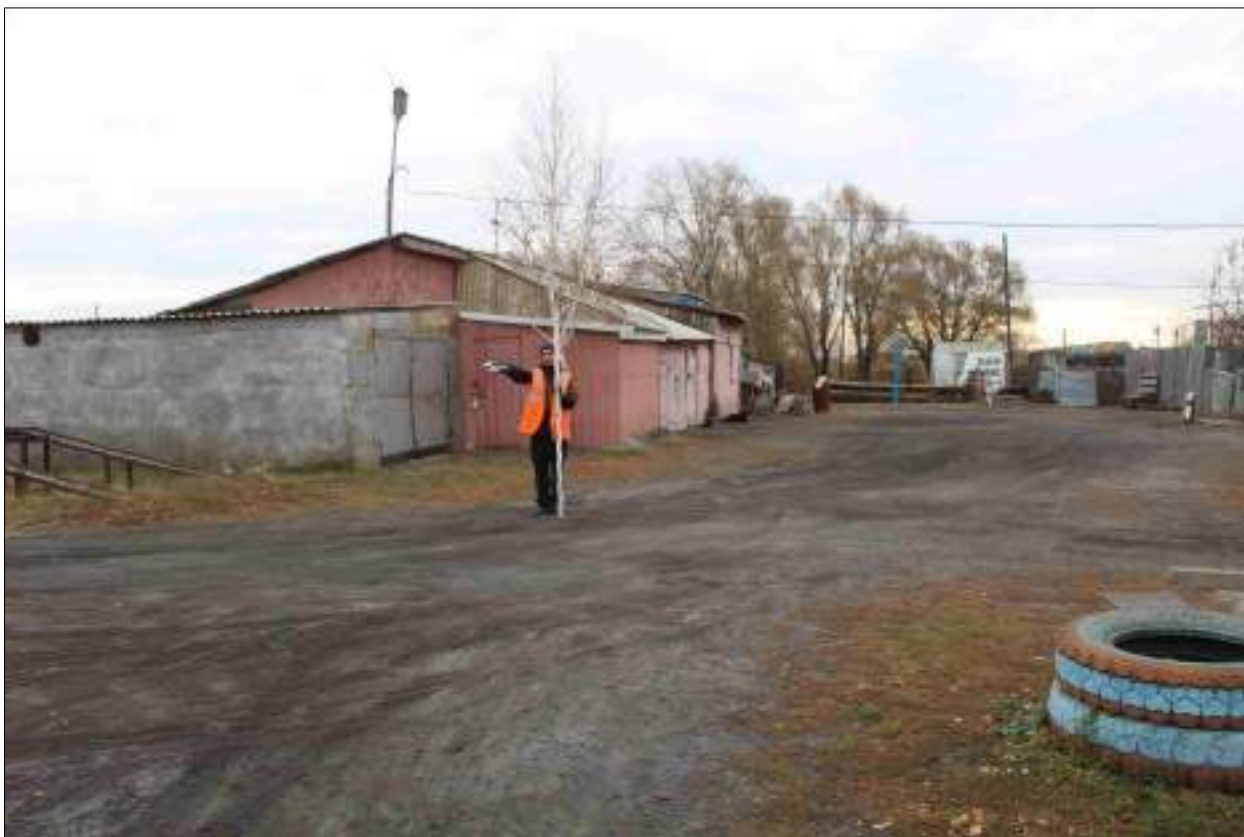
Рисунок 365 – «Распределительный газопровод р.п. Чистоозерное». Вид на точку 13. Снято с СЗ.
