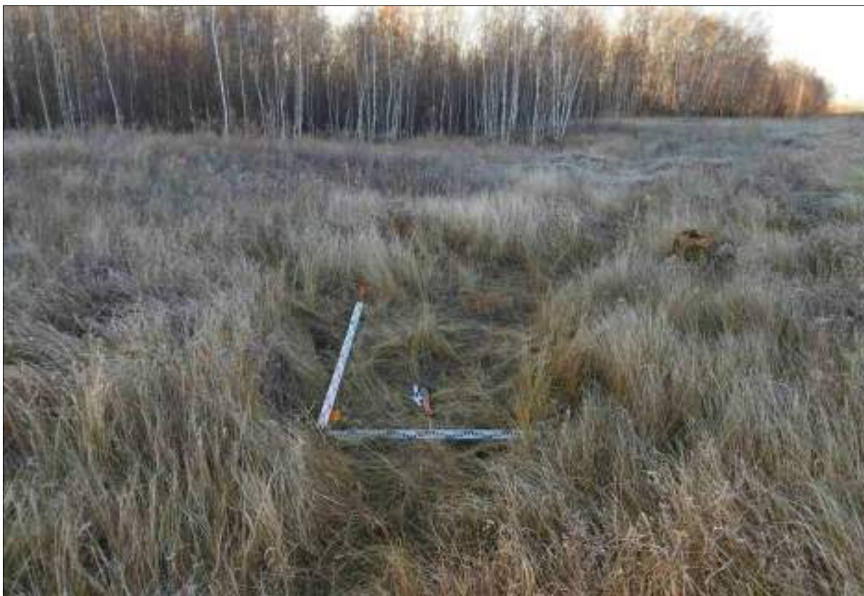
Рисунок 529 – «Распределительный газопровод р.п. Чистоозерное». Шурф №33. Общий вид. Разбивка. Снято с С.
