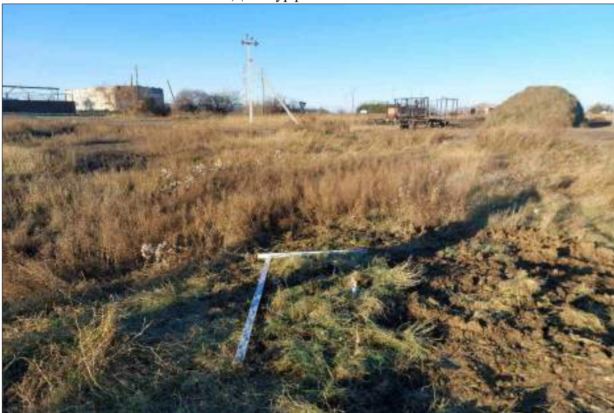
Рисунок 488 – «Распределительный газопровод р.п. Чистоозерное». Шурф №24. Рекультивация. Снято с Ю.
