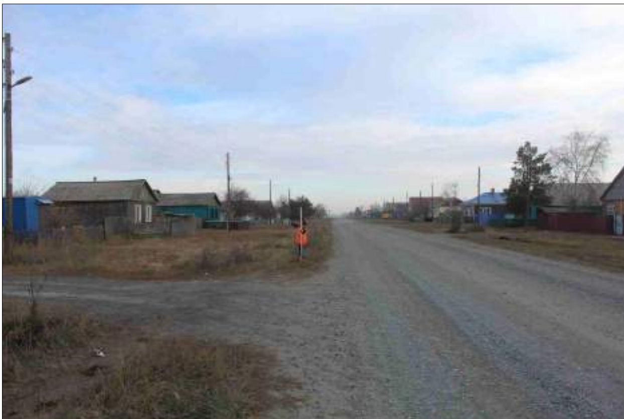
Рисунок 315 – «Распределительный газопровод р.п. Чистоозерное». Вид из Шурфа №42 в направлении точки 2. Снято с ЮЗ.
