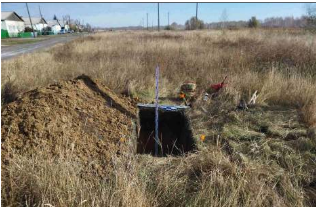
Рисунок 447 – «Распределительный газопровод р.п. Чистоозерное». Шурф №17. Общий вид выполненного шурфа. Снято с 3.
