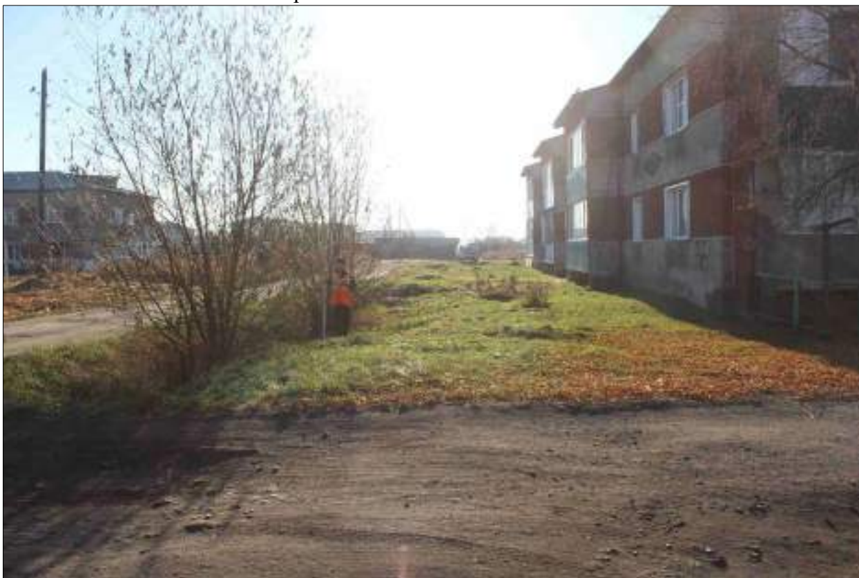
Рисунок 48 – «Распределительный газопровод р.п. Чистоозерное». Вид из точки 165 в направлении точки 166. Снято с СЗ.
