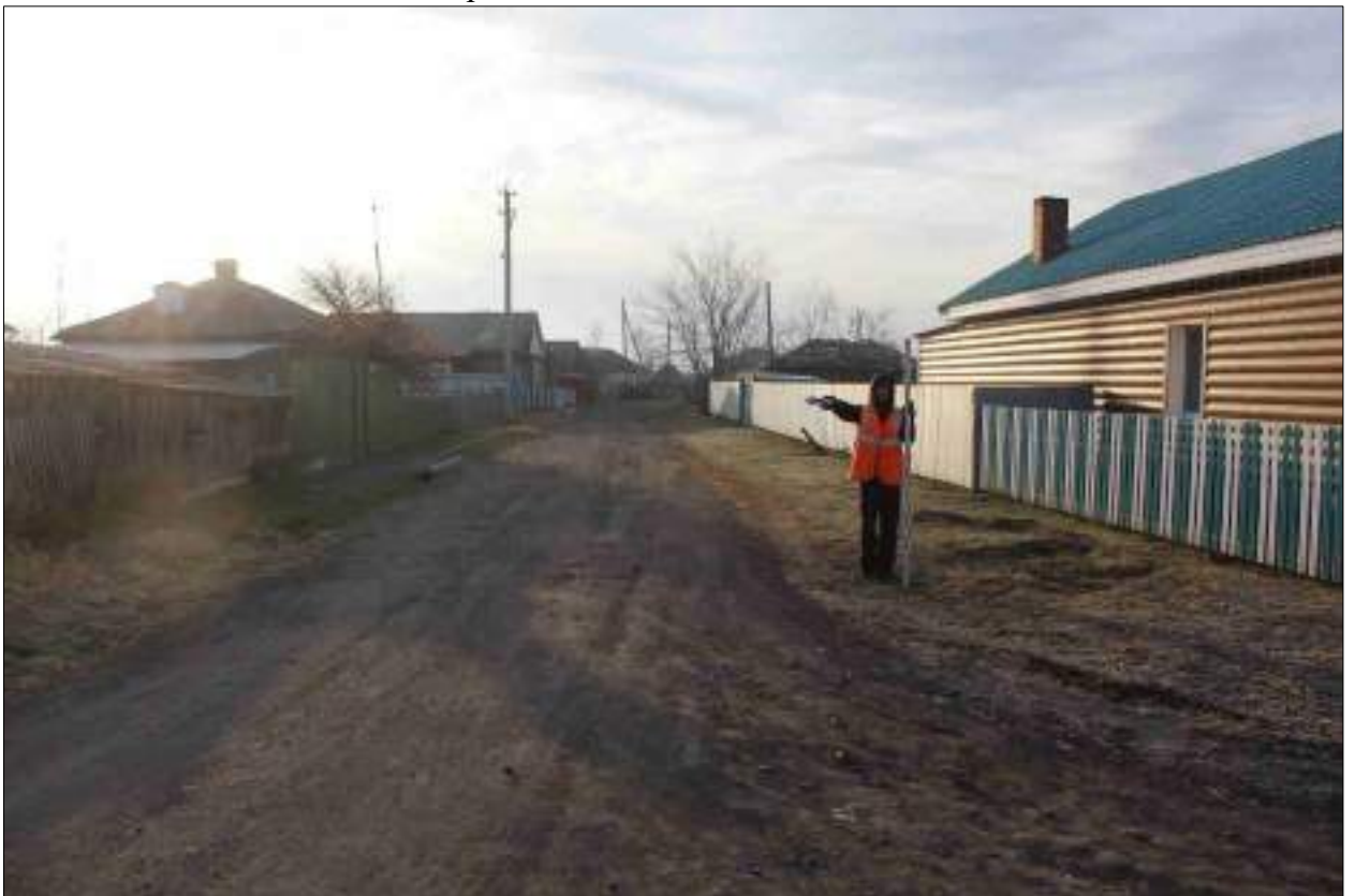
Рисунок 262 – «Распределительный газопровод р.п. Чистоозерное». Вид из точки 40 в направлении точки 57. Снято с СЗ.
