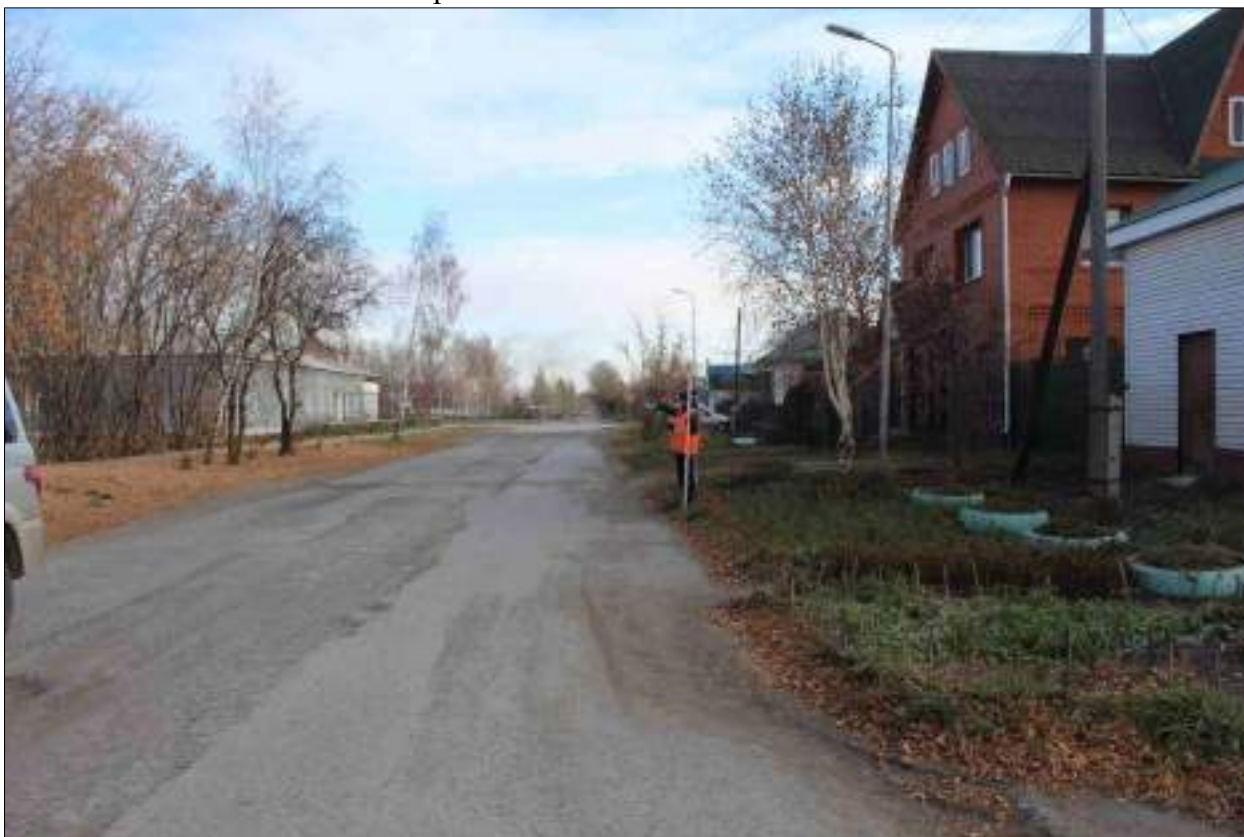
Рисунок 298 – «Распределительный газопровод р.п. Чистоозерное». Вид из точки 44 в направлении точки 45. Снято с ЮЗ.
