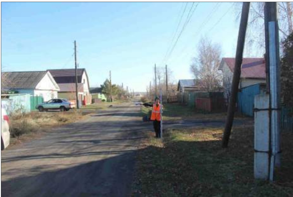
Рисунок 165 – «Распределительный газопровод р.п. Чистоозерное». Вид из точки 112 в направлении точки 92. Снято с СЗ.
