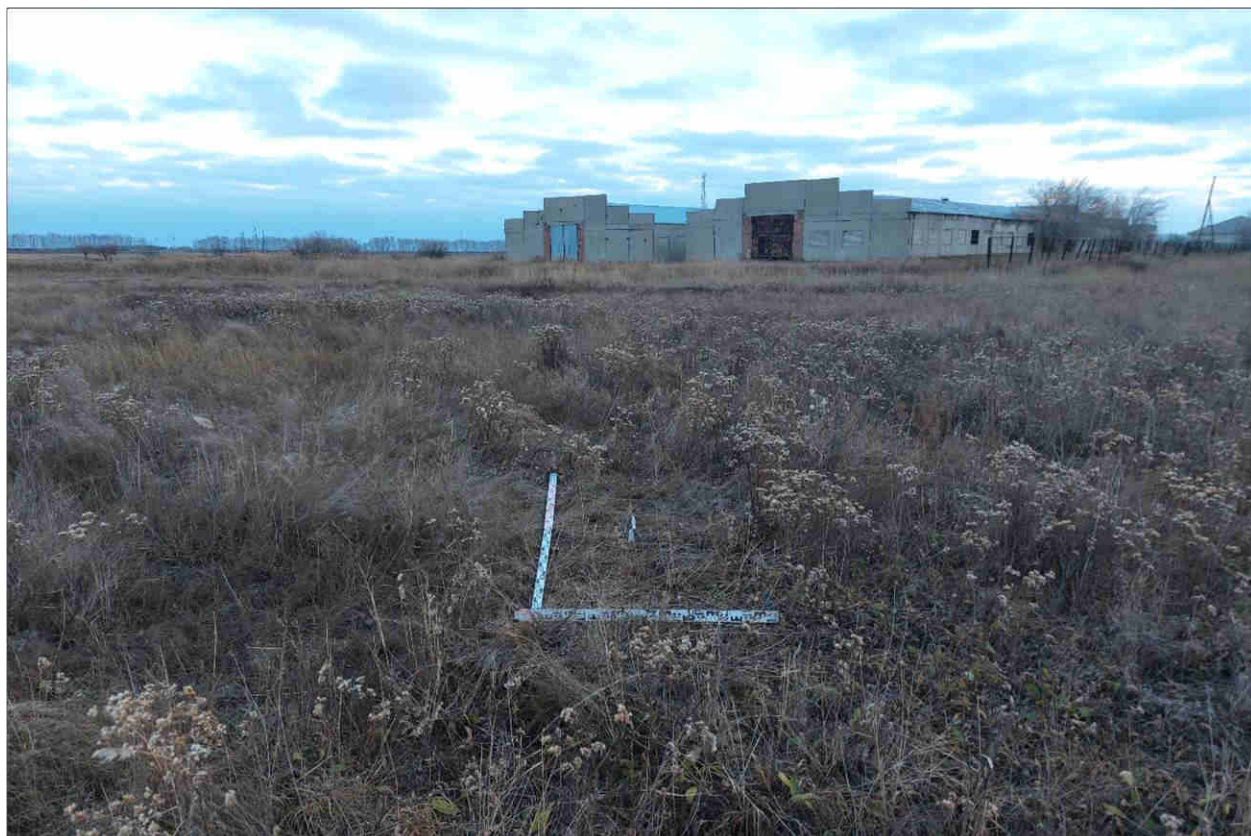
Рисунок 461 – «Распределительный газопровод р.п. Чистоозерное». Шурф №20. Общий вид. Разбивка. Снято с Ю.
