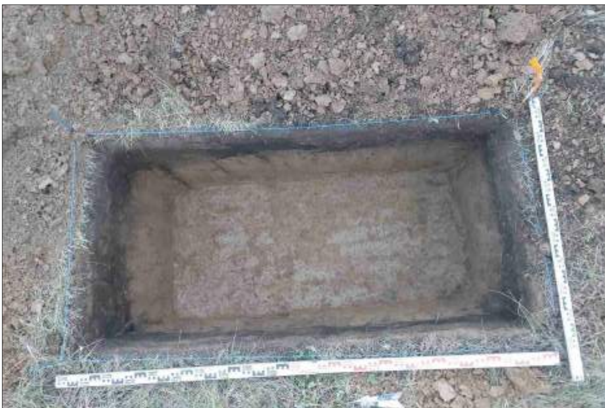
Рисунок 517 – «Распределительный газопровод р.п. Чистоозерное». Шурф №30. Дно шурфа. Снято с З.
