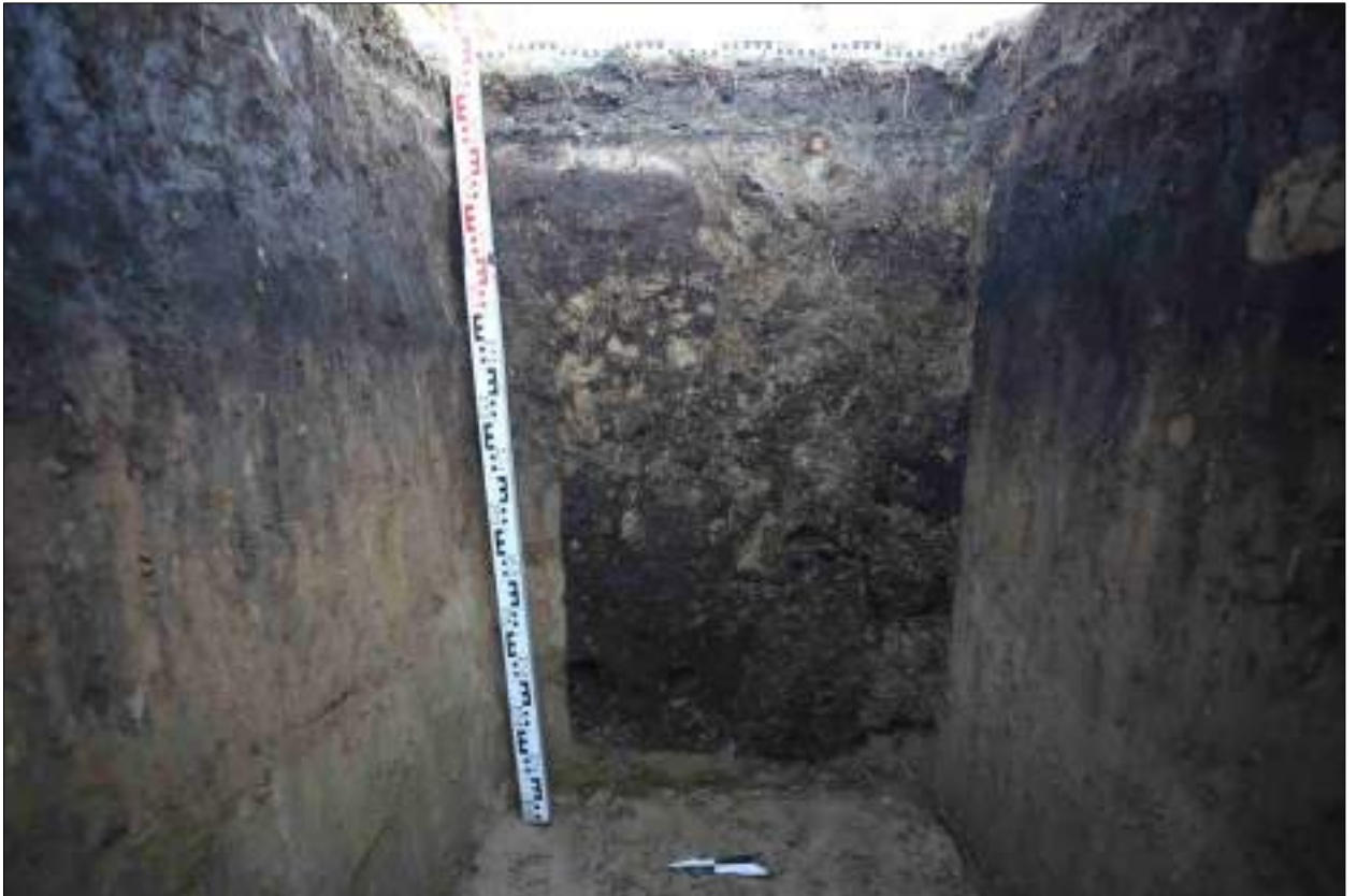
Рисунок 653 – «Распределительный газопровод р.п. Чистоозерное». Шурф №57. Восточная стенка. Снято с 3
