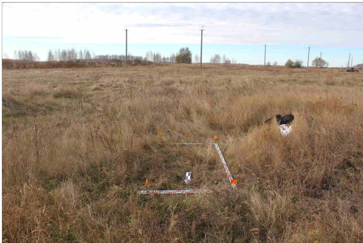
Рисунок 610 – «Распределительный газопровод р.п. Чистоозерное». Шурф №49. Общий вид. Разбивка. Снято с С.
