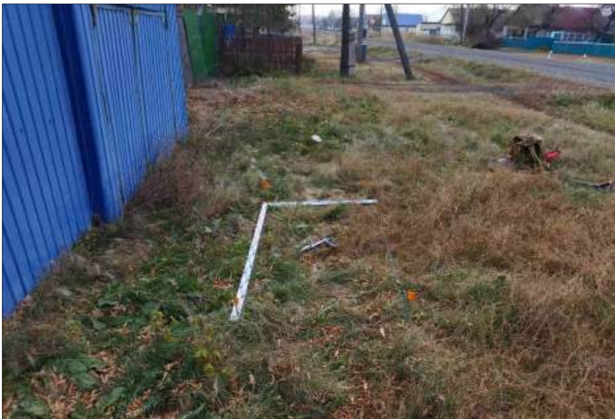
Рисунок 605 – «Распределительный газопровод р.п. Чистоозерное». Шурф №48. Общий вид. Разбивка. Снято с СЗ.
