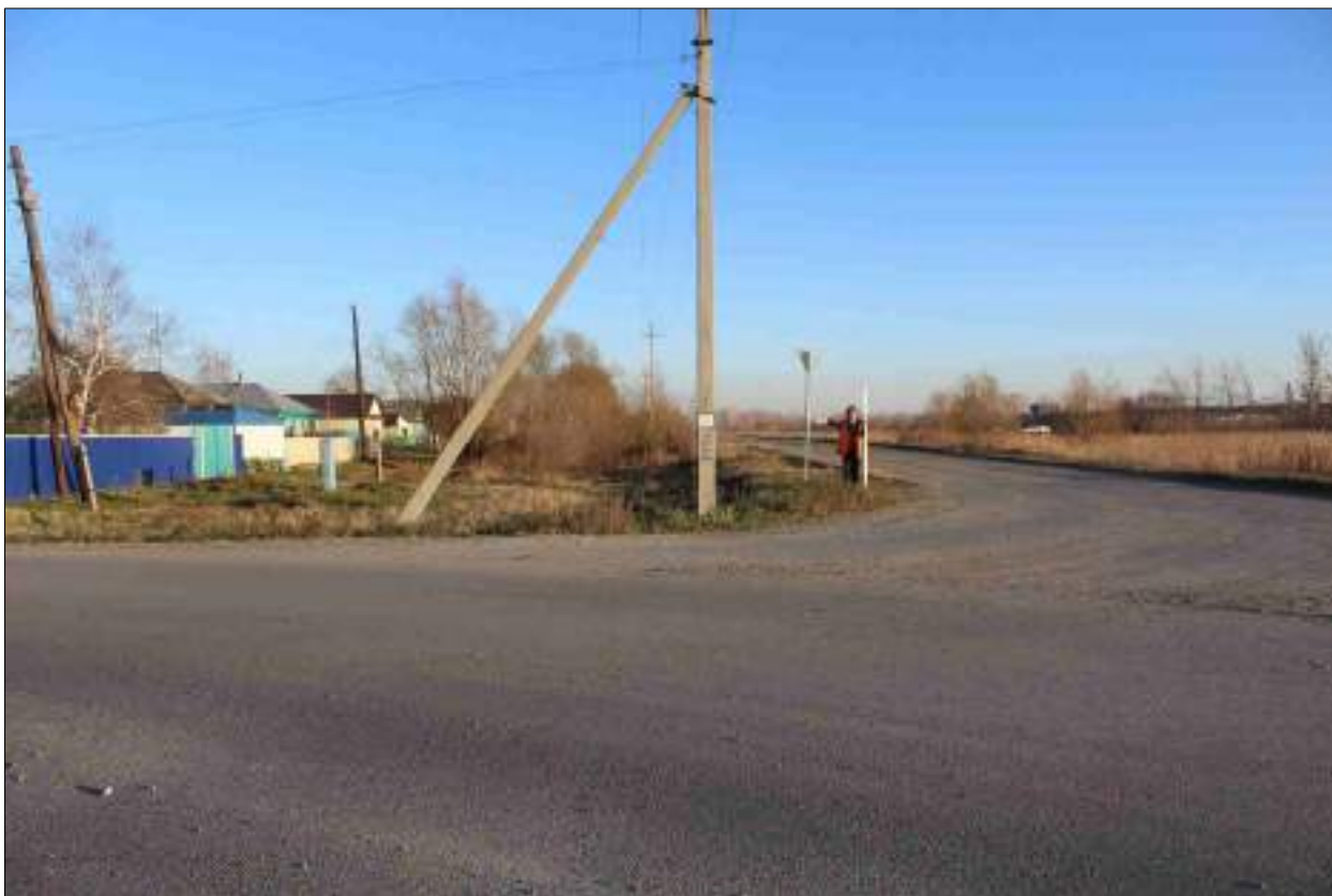
Рисунок 245 – «Распределительный газопровод р.п. Чистоозерное». Вид из точки 56 в направлении точки 69. Снято с СЗ.
