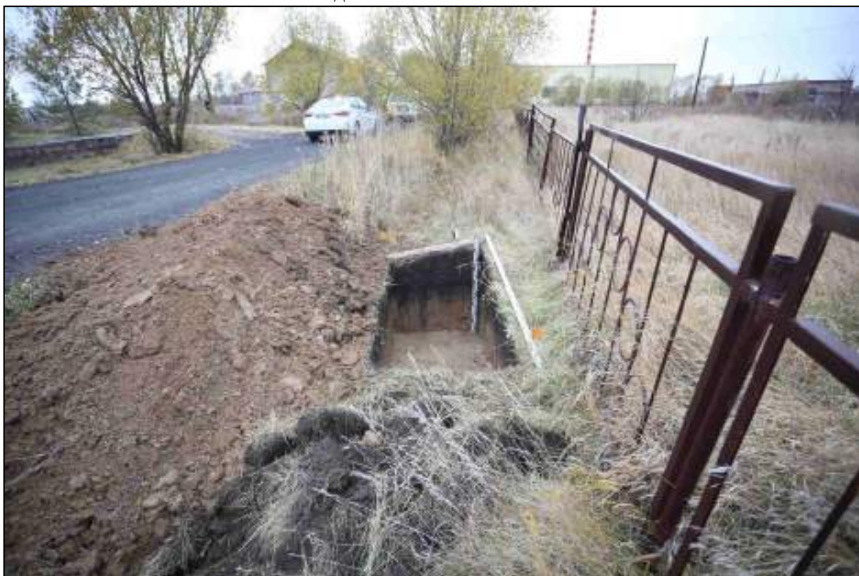
Рисунок 422 – «Распределительный газопровод р.п. Чистоозерное». Шурф №12. Общий вид выполненного шурфа. Снято с С.
