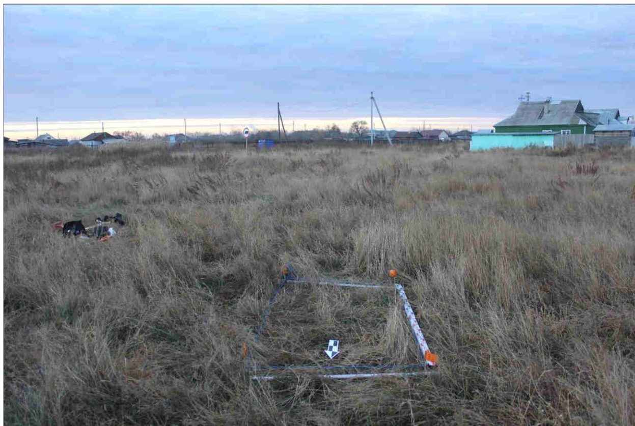
Рисунок 376 – «Распределительный газопровод р.п. Чистоозерное». Шурф №3. Общий вид. Разбивка. Снято с С.
