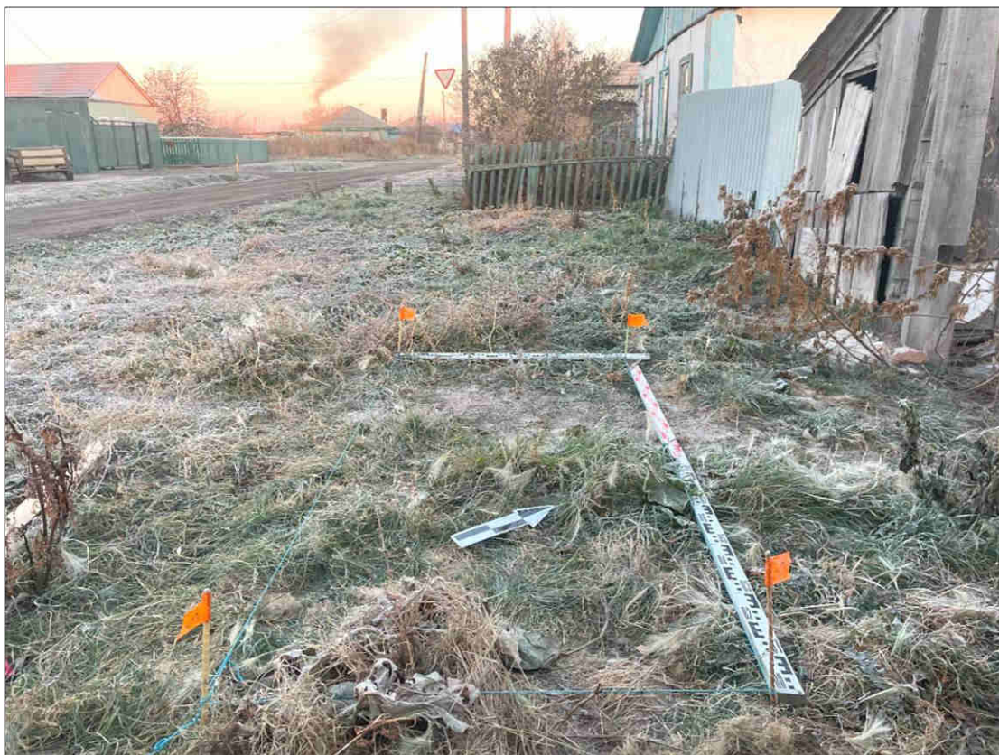
Рисунок 645 – «Распределительный газопровод р.п. Чистоозерное». Шурф №56. Общий вид. Разбивка. Снято с ЮВ.
