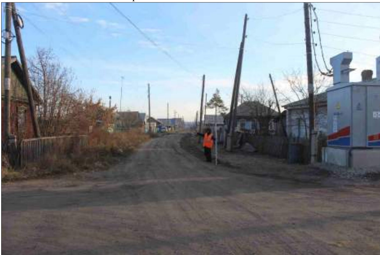
Рисунок 274 – «Распределительный газопровод р.п. Чистоозерное». Вид из точки 34 в направлении точки 31. Снято с ЮЗ.
