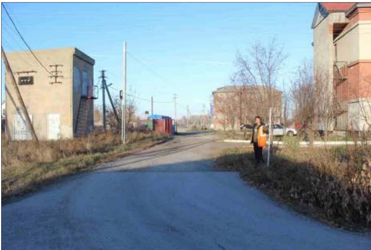
Рисунок 233 – «Распределительный газопровод р.п. Чистоозерное». Вид из точки 196 в направлении точки 197. Снято с ЮЗ.
