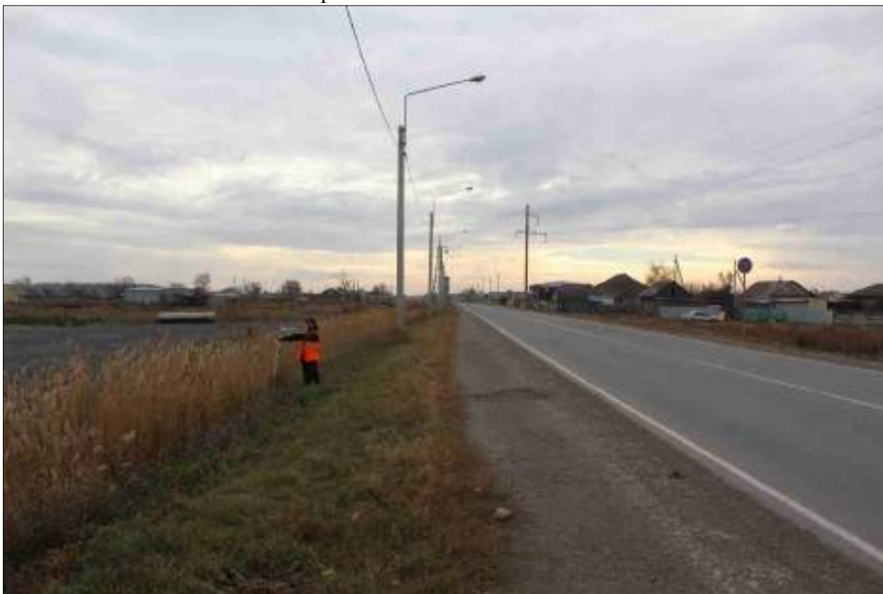
Рисунок 348 – «Распределительный газопровод р.п. Чистоозерное». Вид из точки 5 в направлении точки 4. Снято с СЗ.
