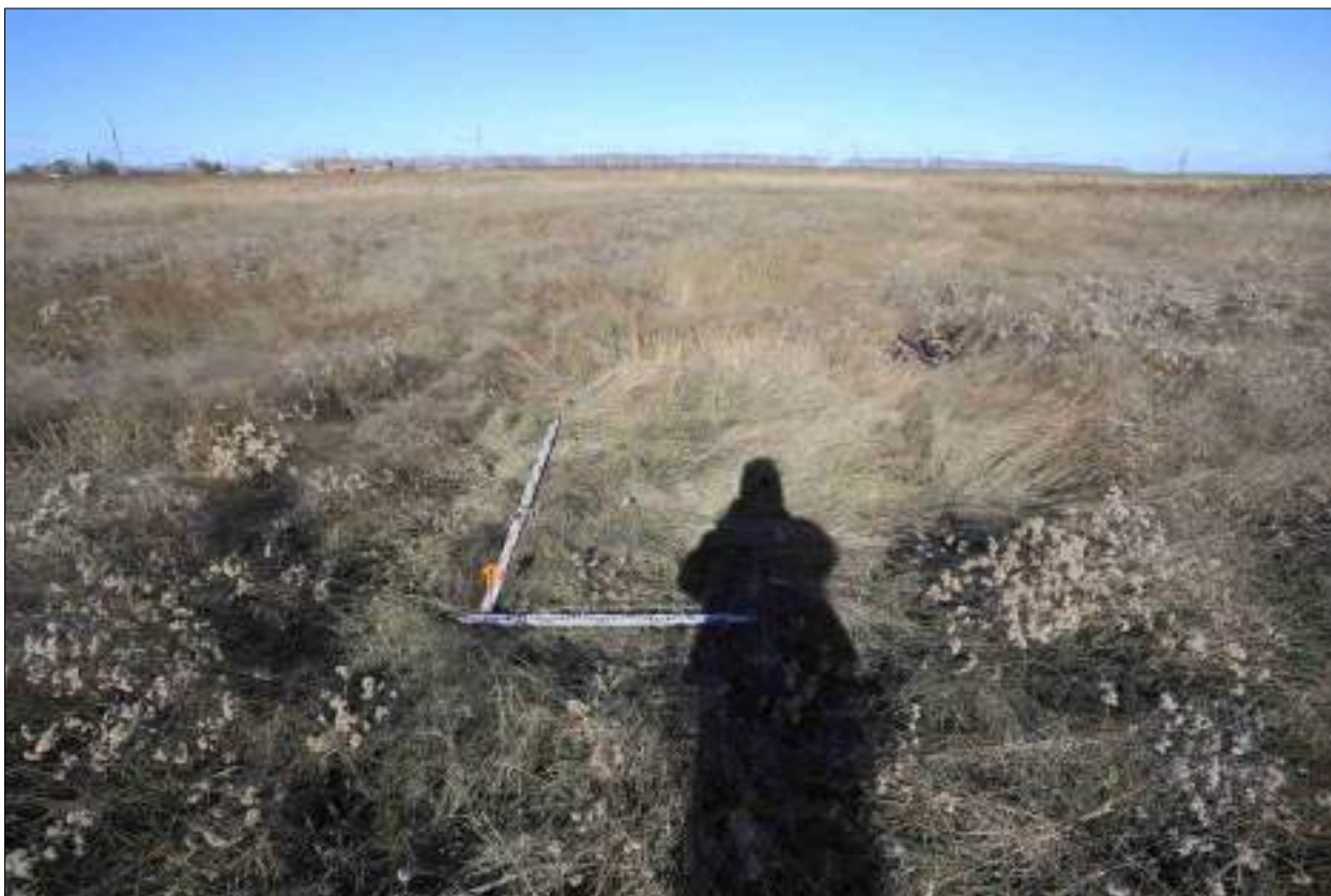
Рисунок 451 – «Распределительный газопровод р.п. Чистоозерное». Шурф №18. Общий вид. Разбивка. Снято с Ю.
