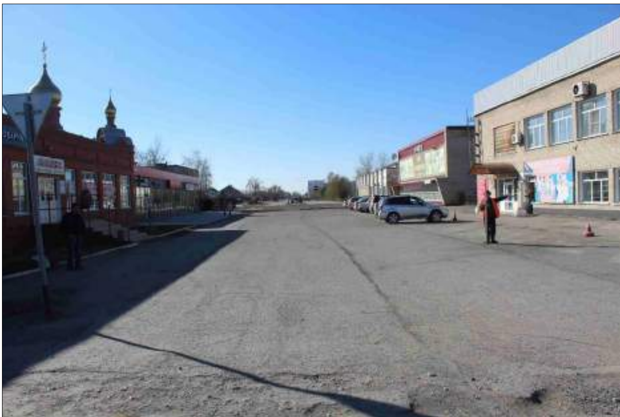
Рисунок 103 – «Распределительный газопровод р.п. Чистоозерное». Вид из точки 133 в направлении точки 125. Снято с СВ.
