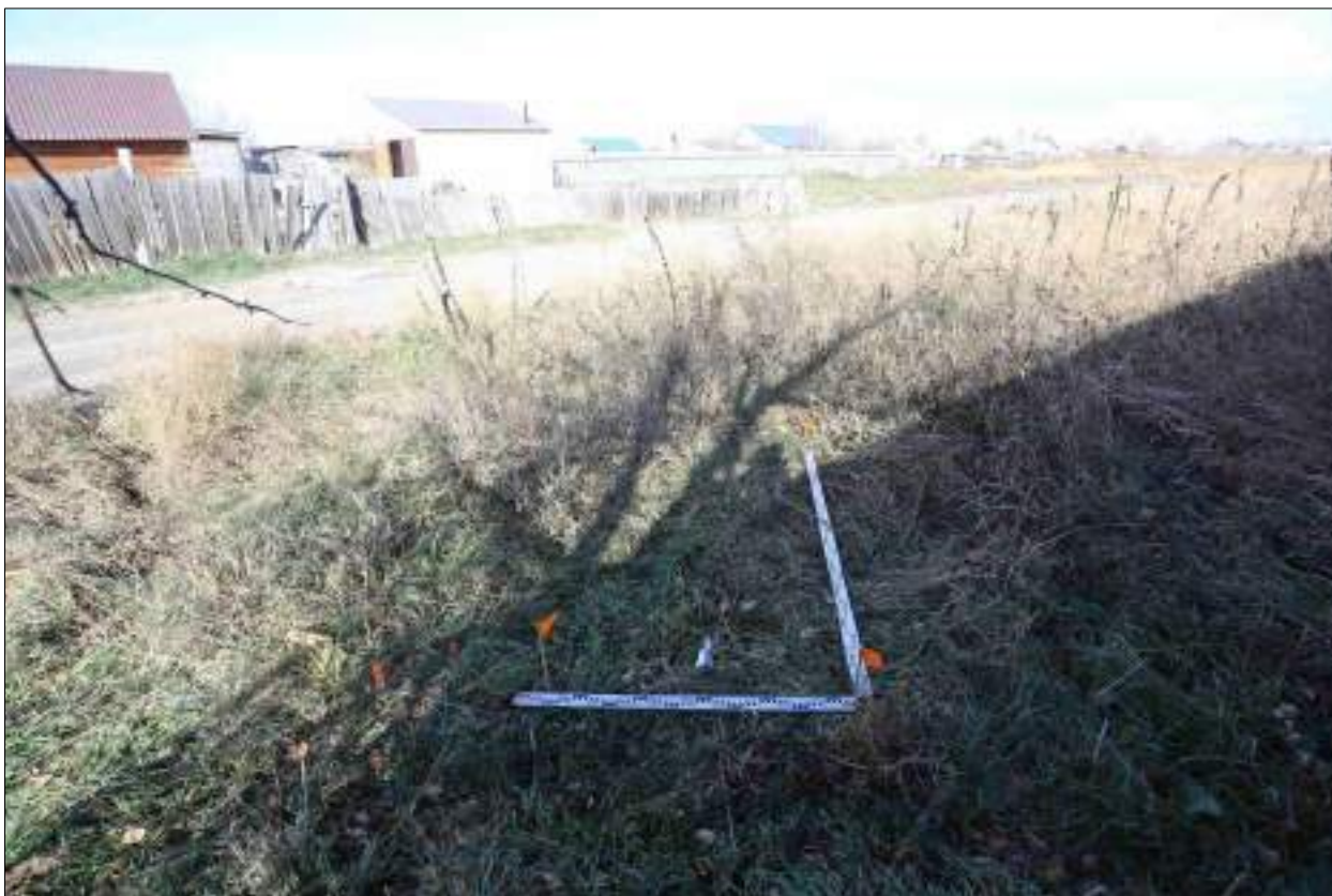
Рисунок 381 – «Распределительный газопровод р.п. Чистоозерное». Шурф №4. Общий вид. Разбивка. Снято с Ю.
