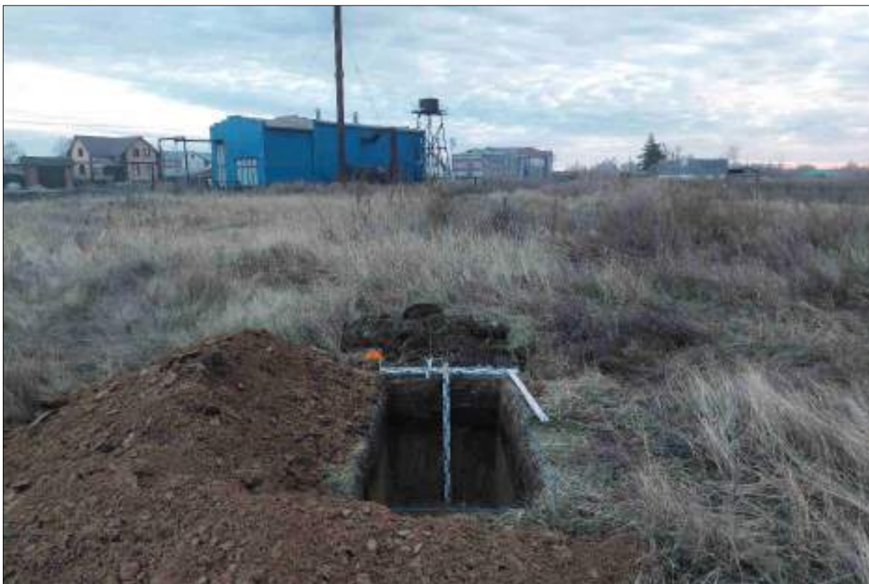
Рисунок 515 – «Распределительный газопровод р.п. Чистоозерное». Шурф №30. Общий вид выполненного шурфа. Снято с С.
