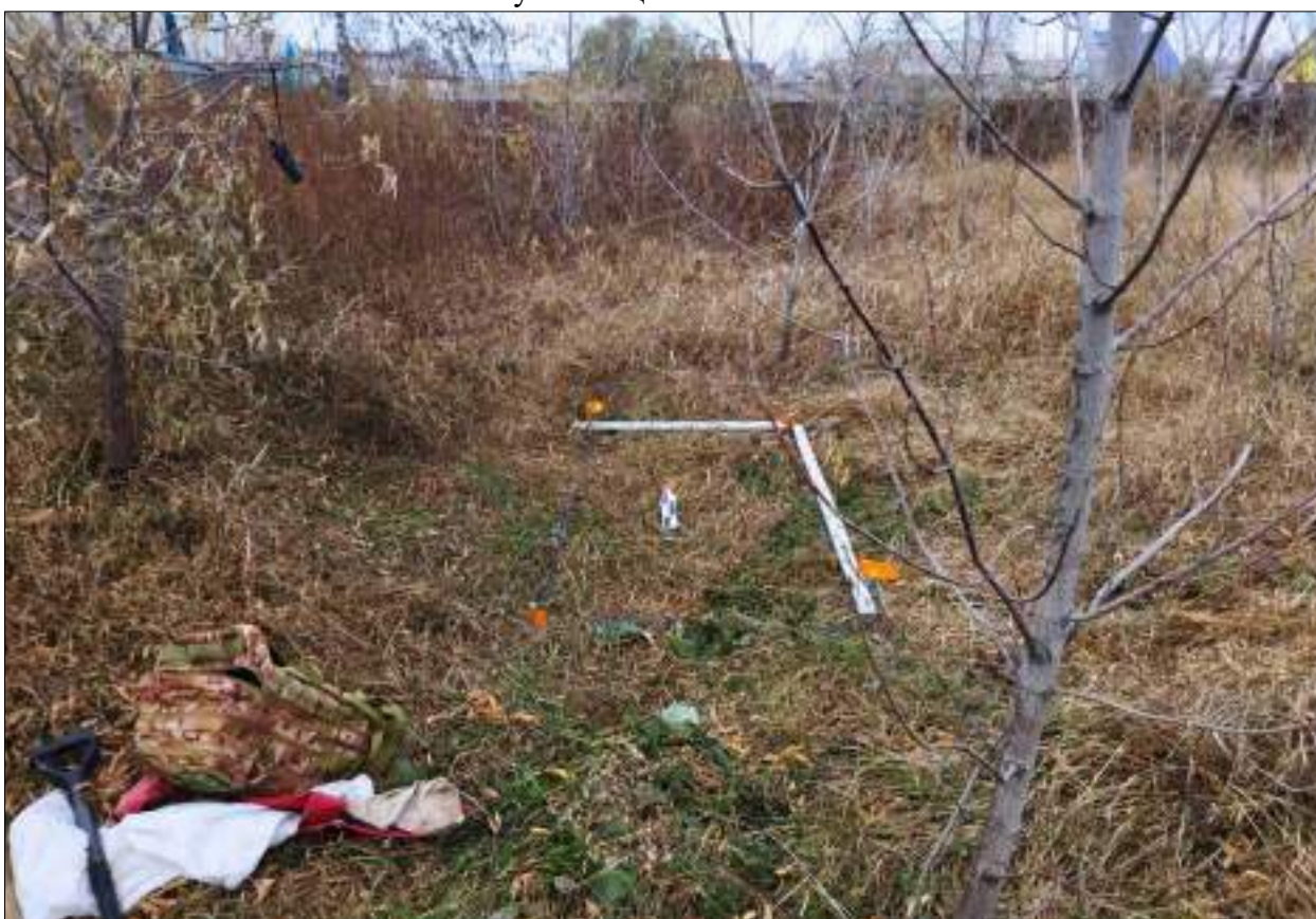
Рисунок 406 – «Распределительный газопровод р.п. Чистоозерное». Шурф №9. Общий вид. Разбивка. Снято с Ю.
