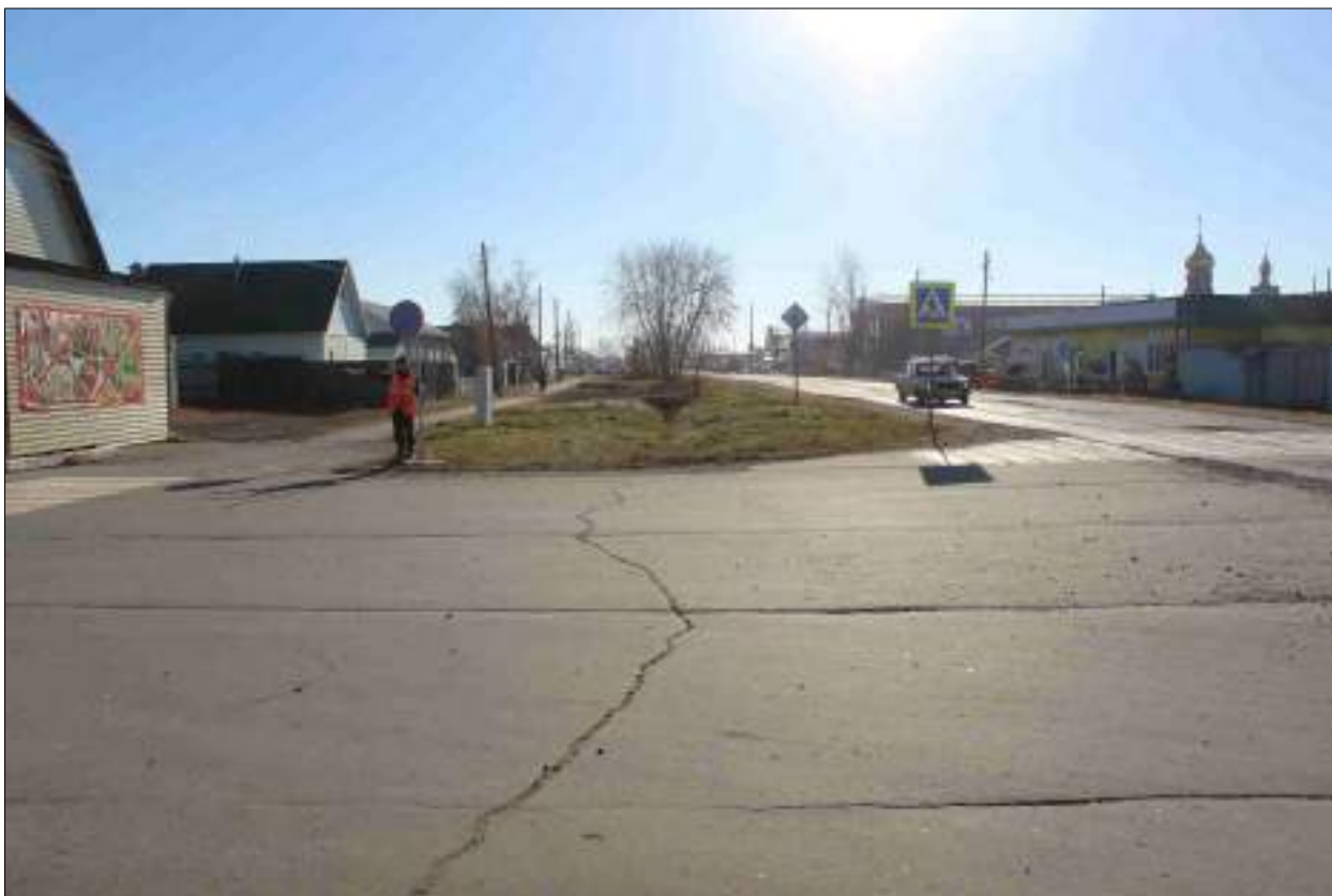
Рисунок 73 – «Распределительный газопровод р.п. Чистоозерное». Вид из точки 134 в направлении точки 133. Снято с СЗ.
