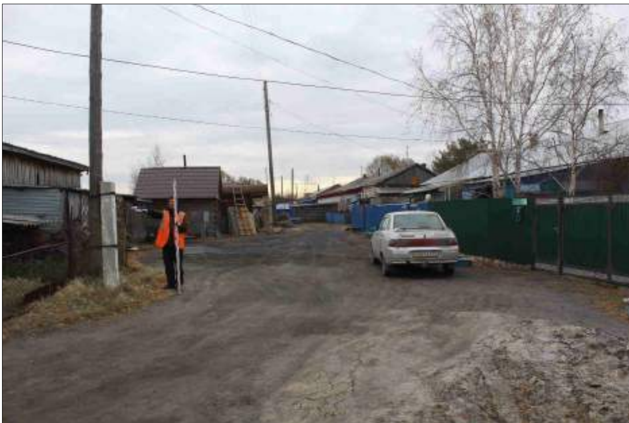
Рисунок 363 – «Распределительный газопровод р.п. Чистоозерное». Вид из точки 12 в направлении точки 13. Снято с СЗ.
