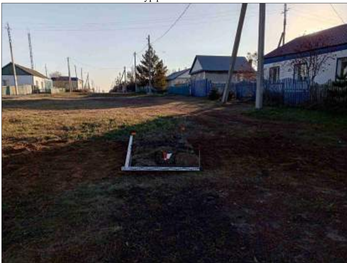
Рисунок 420 – «Распределительный газопровод р.п. Чистоозерное». Шурф №11. Рекультивация. Снято с С.
