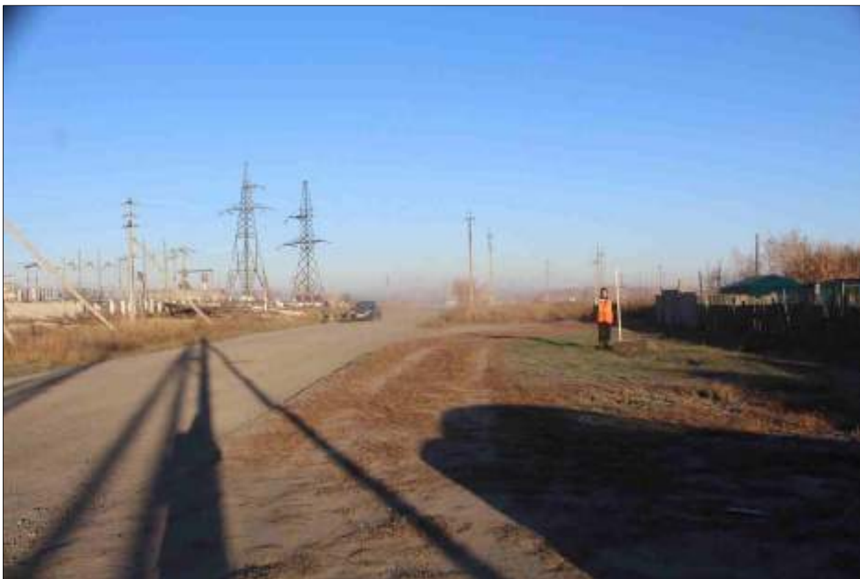
Рисунок 25 – «Распределительный газопровод р.п. Чистоозерное». Вид из точки 185 в направлении точки 188. Снято с В.
