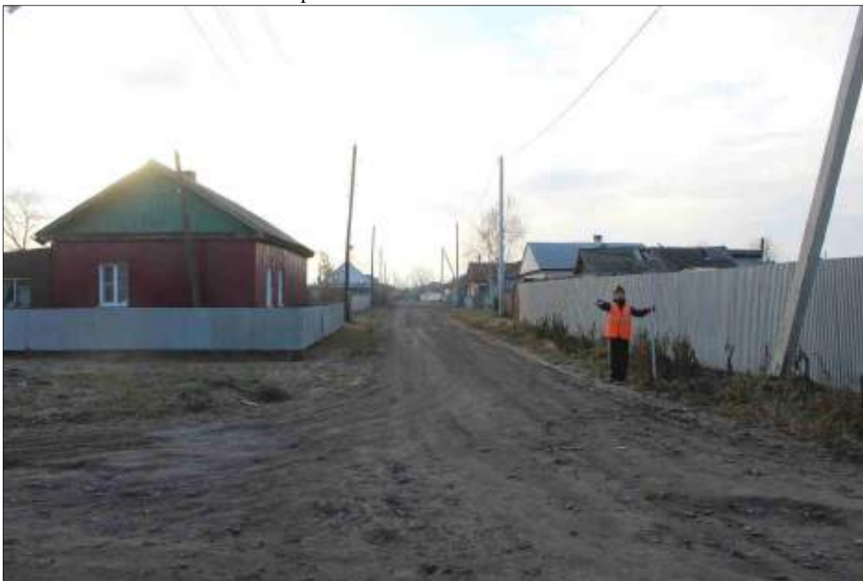
Рисунок 280 – «Распределительный газопровод р.п. Чистоозерное». Вид из точки 39 в направлении точки 40. Снято с СЗ.
