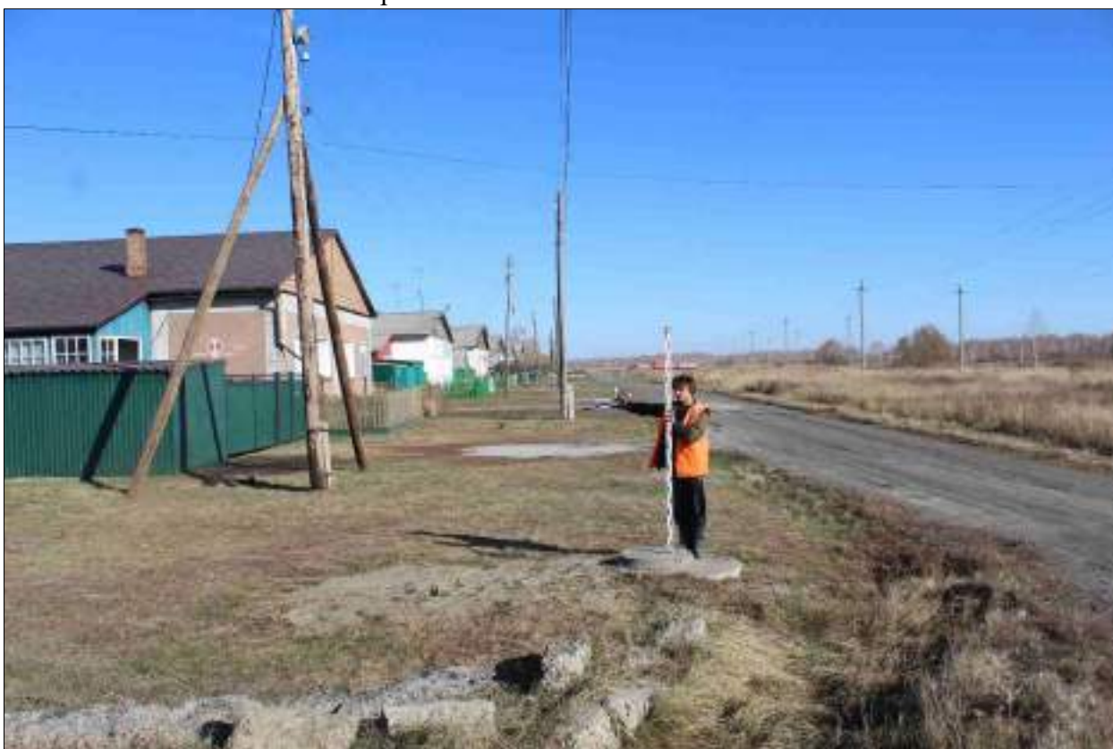
Рисунок 134 – «Распределительный газопровод р.п. Чистоозерное». Вид из точки 102 в направлении точки 103. Снято с ЮЗ.
