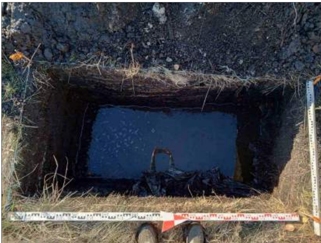
Рисунок 567 – «Распределительный газопровод р.п. Чистоозерное». Шурф №40. Дно шурфа. Снято с В.
