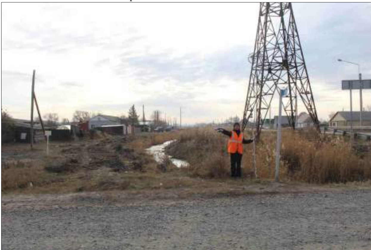
Рисунок 312 – «Распределительный газопровод р.п. Чистоозерное». Вид из точки 3 в направлении точки 27. Снято с СЗ.
