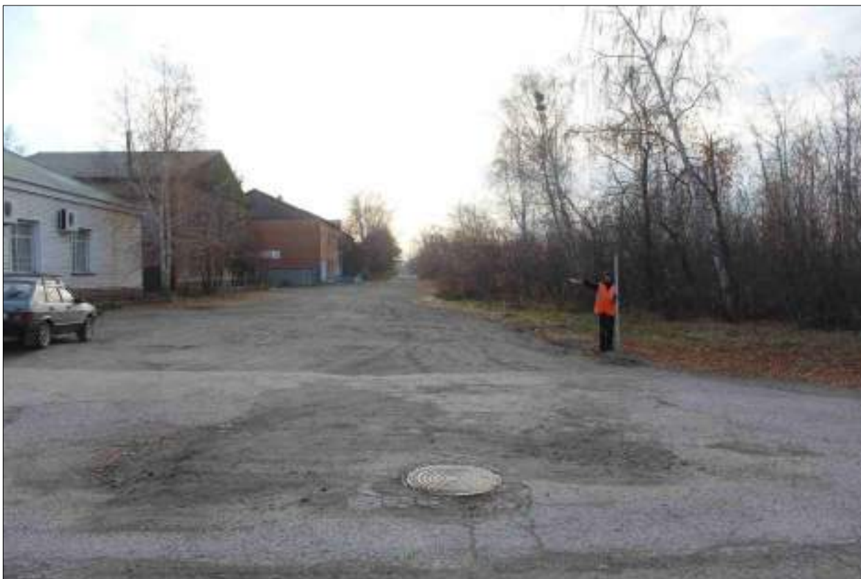
Рисунок 299 – «Распределительный газопровод р.п. Чистоозерное». Вид из точки 44 в направлении точки 43. Снято с СЗ.
