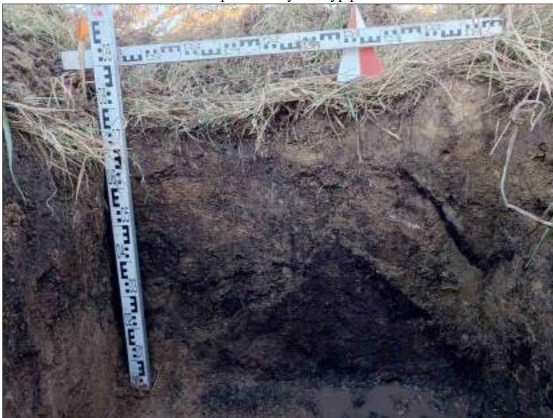
Рисунок 480 – «Распределительный газопровод р.п. Чистоозерное». Шурф №23. Северная стенка. Снято с Ю.
