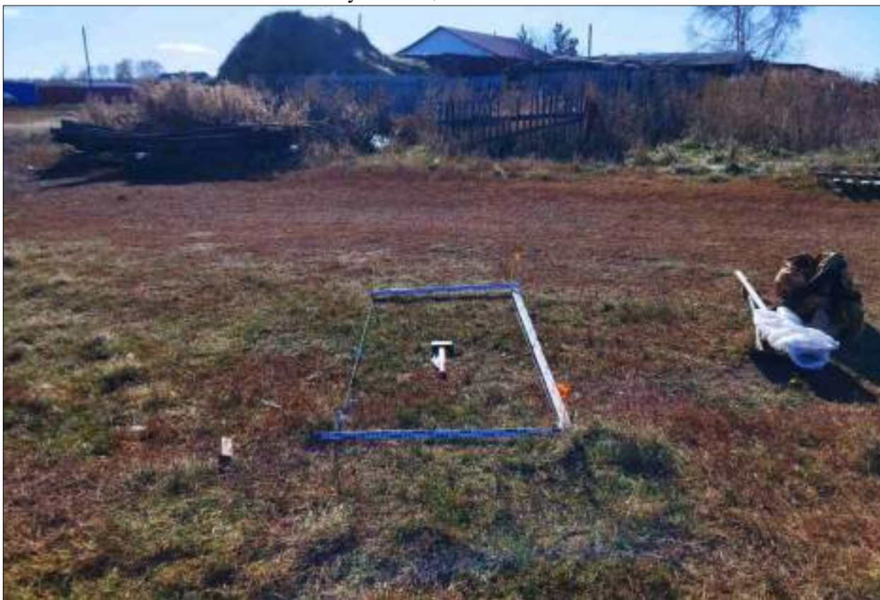
Рисунок 396 – «Распределительный газопровод р.п. Чистоозерное». Шурф №7. Общий вид. Разбивка. Снято с С.
