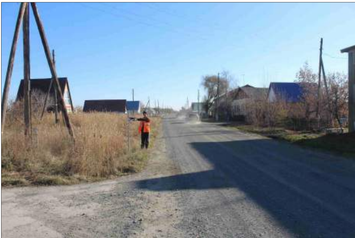
Рисунок 147 – «Распределительный газопровод р.п. Чистоозерное». Вид из точки 124 в направлении точки 122. Снято с СЗ.
