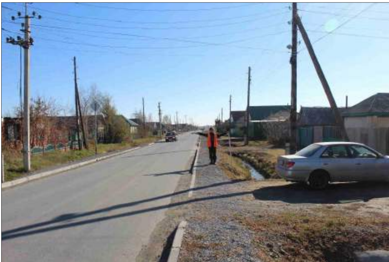
Рисунок 115 – «Распределительный газопровод р.п. Чистоозерное». Вид из точки 126 в направлении точки 120. Снято с СЗ.
