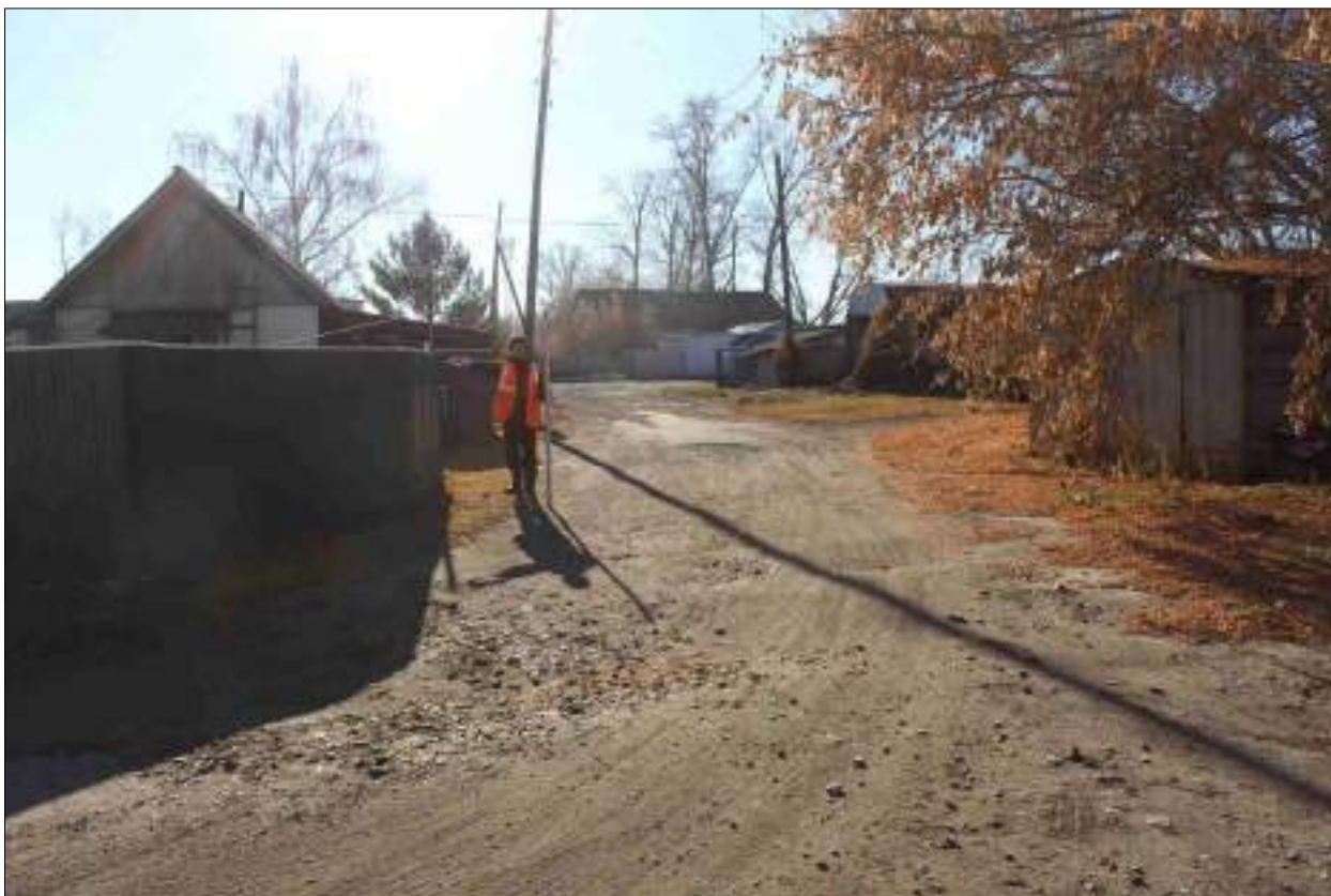
Рисунок 87 – «Распределительный газопровод р.п. Чистоозерное». Вид из точки 142 в направлении точки 143. Снято с СВ.
