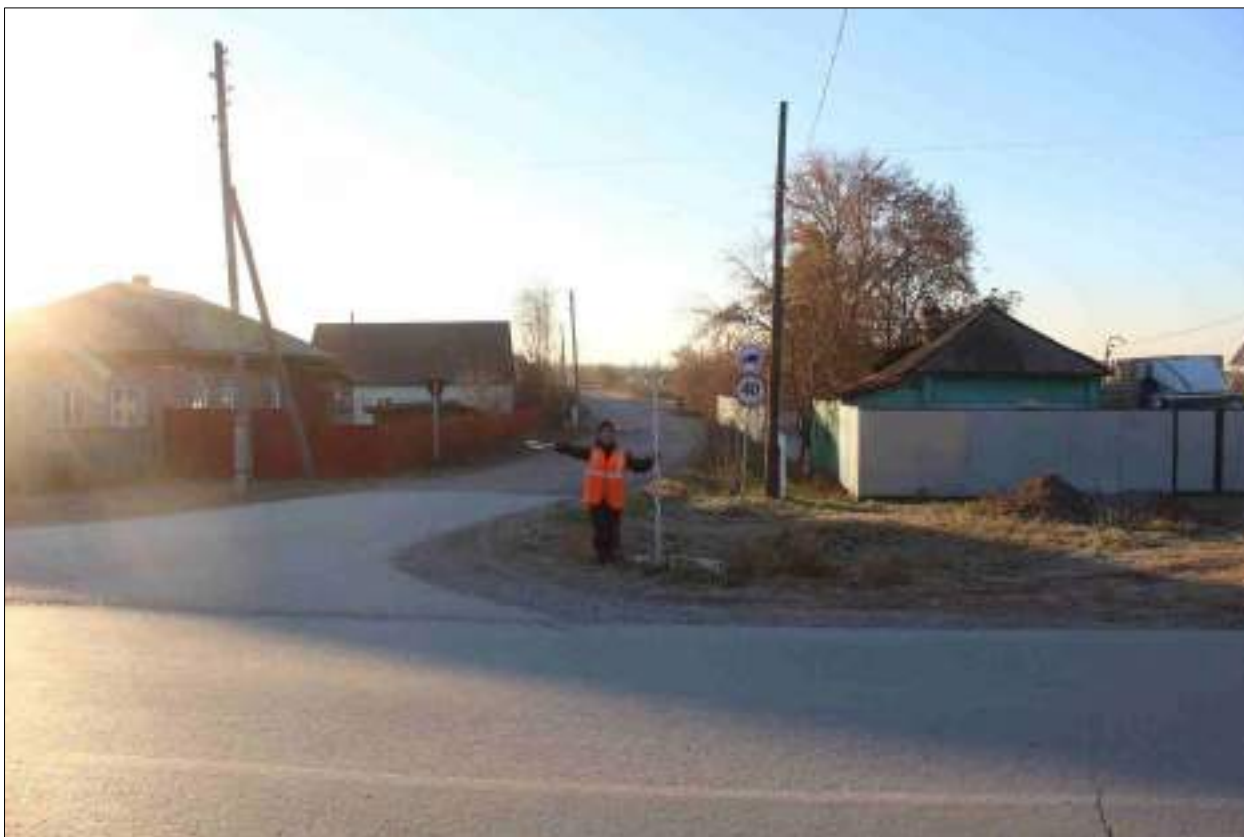
Рисунок 13 – «Распределительный газопровод р.п. Чистоозерное». Вид из точки 182 в направлении точки 155. Снято с СЗ.
