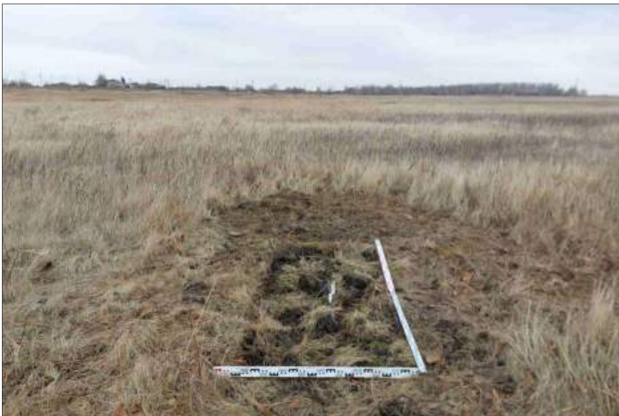
Рисунок 395 – «Распределительный газопровод р.п. Чистоозерное». Шурф №6. Рекультивация. Снято с С.
