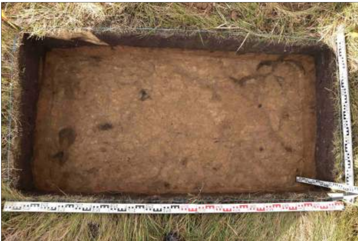
Рисунок 598 – «Распределительный газопровод р.п. Чистоозерное». Шурф №46. Дно шурфа. Снято с В.
