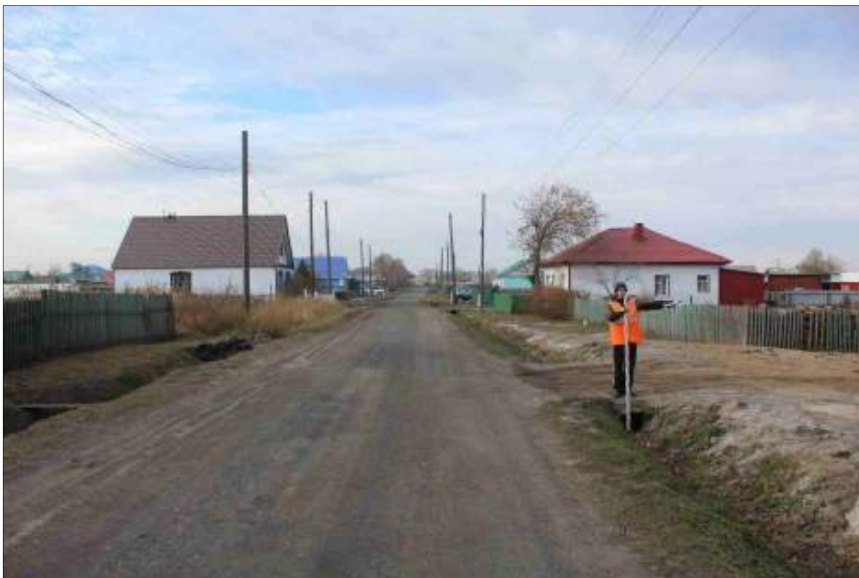
Рисунок 309 – «Распределительный газопровод р.п. Чистоозерное». Вид из точки 27 в направлении точки 26. Снято с СВ.
