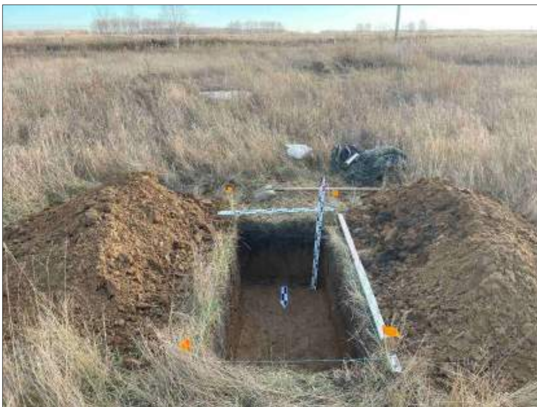
Рисунок 581 – «Распределительный газопровод р.п. Чистоозерное». Шурф №43. Общий вид выполненного шурфа. Снято с С.
