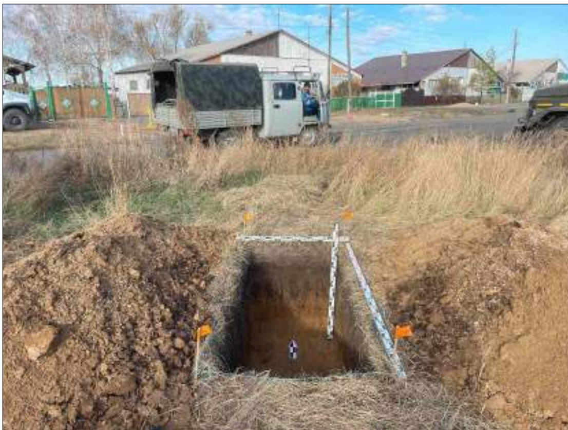
Рисунок 601 – «Распределительный газопровод р.п. Чистоозерное». Шурф №47. Общий вид выполненного шурфа. Снято с Ю.
