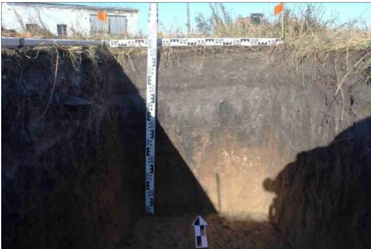
Рисунок 501 – «Распределительный газопровод р.п. Чистоозерное». Шурф №27. Северная стенка. Снято с Ю.
