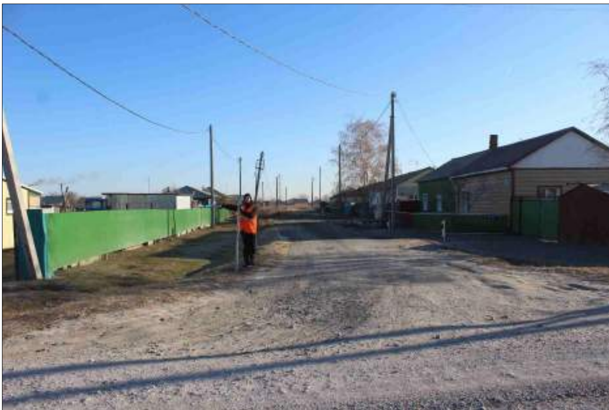
Рисунок 41 – «Распределительный газопровод р.п. Чистоозерное». Вид из точки 172 в направлении точки 171. Снято с ЮЗ.
