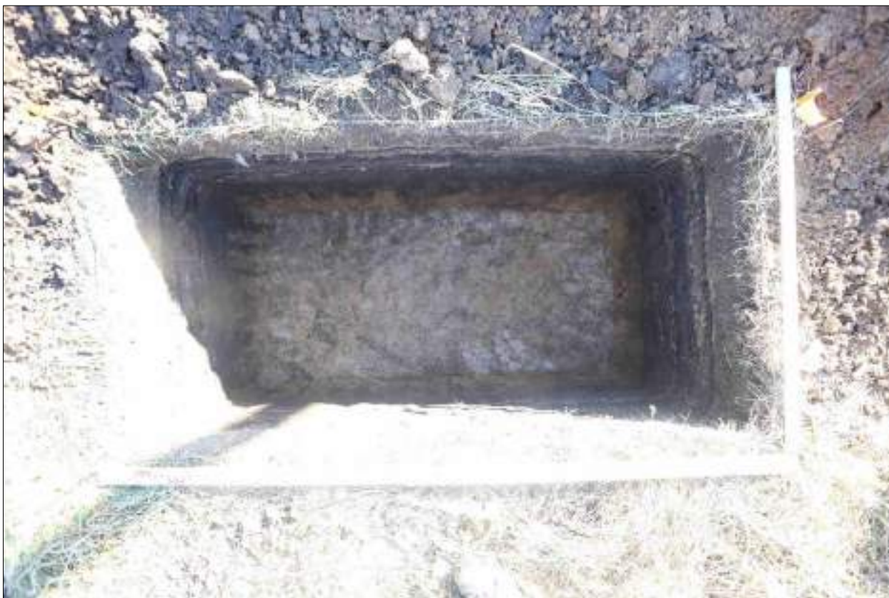
Рисунок 643 – «Распределительный газопровод р.п. Чистоозерное». Шурф №55. Дно шурфа. Снято с З.
