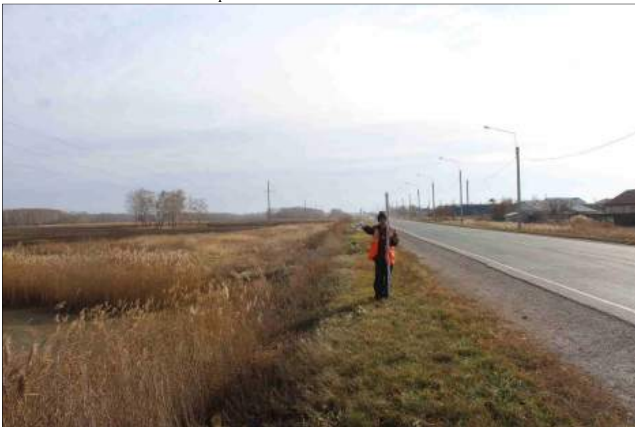
Рисунок 272 – «Распределительный газопровод р.п. Чистоозерное». Вид из точки 32 в направлении точки 64. Снято с СЗ.
