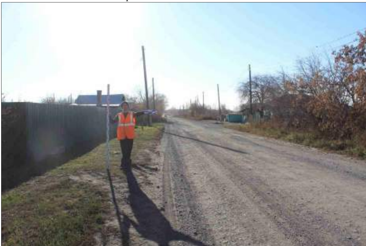
Рисунок 178 – «Распределительный газопровод р.п. Чистоозерное». Вид из точки 117 в направлении точки 118. Снято с СВ.
