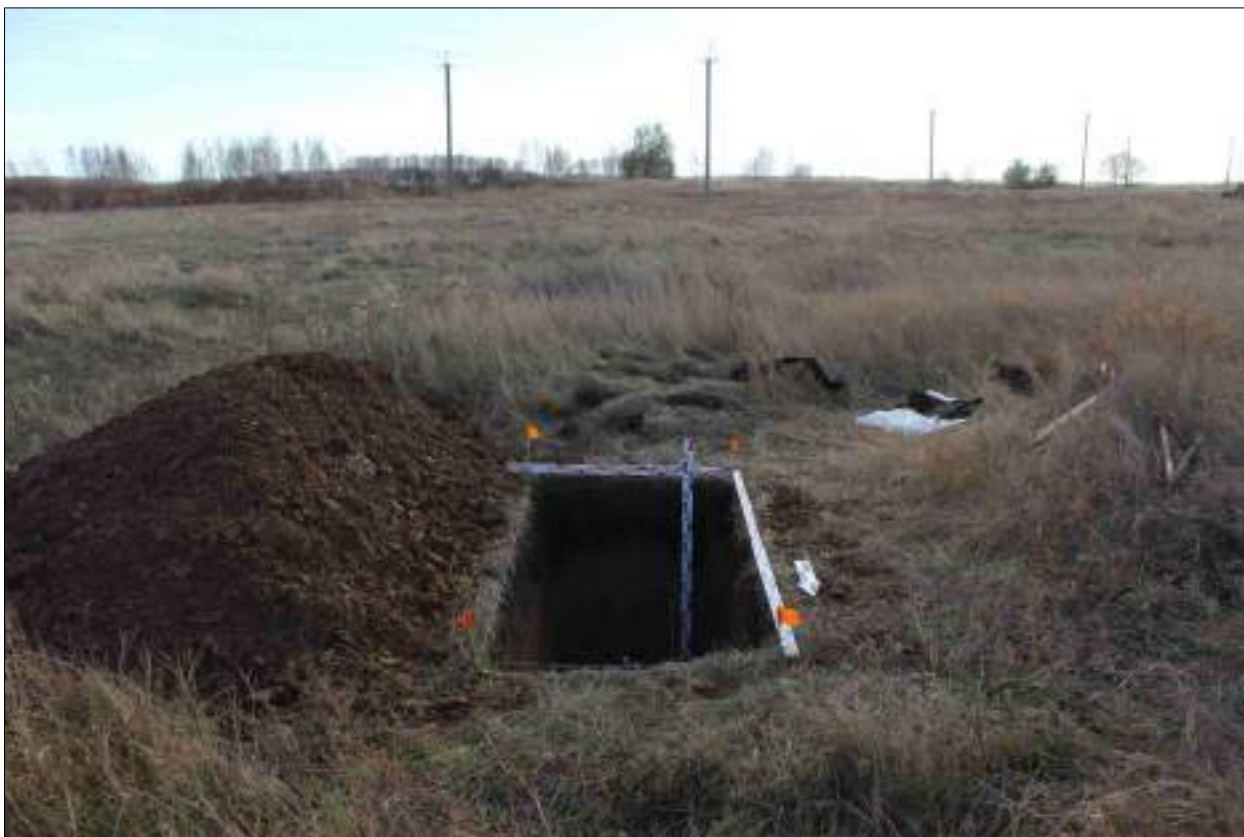
Рисунок 611 – «Распределительный газопровод р.п. Чистоозерное». Шурф №49. Общий вид выполненного шурфа. Снято с С.
