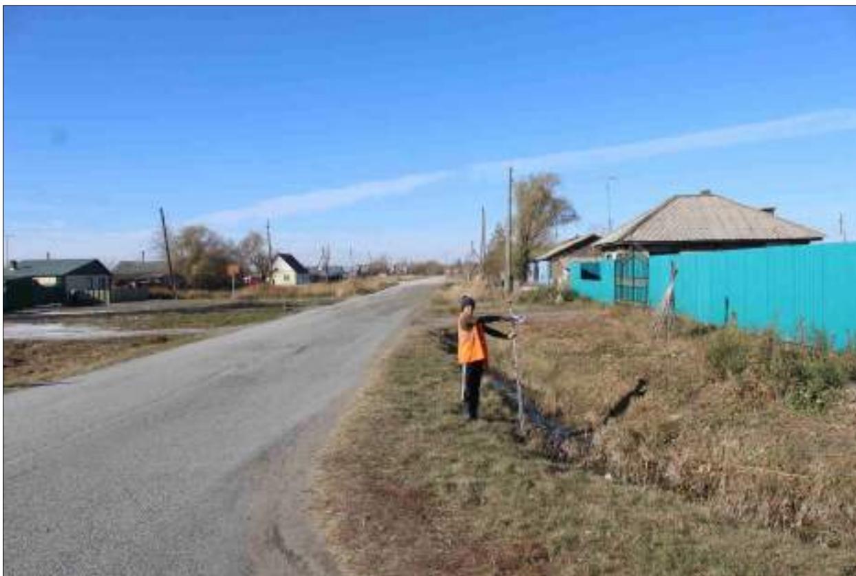
Рисунок 151 – «Распределительный газопровод р.п. Чистоозерное». Вид из точки 156 в направлении точки 155. Снято с ЮВ.
