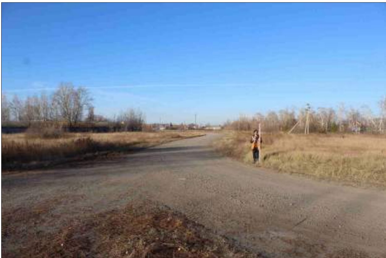
Рисунок 215 – «Распределительный газопровод р.п. Чистоозерное». Вид из точки 85 в направлении точки 84. Снято с Ю.
