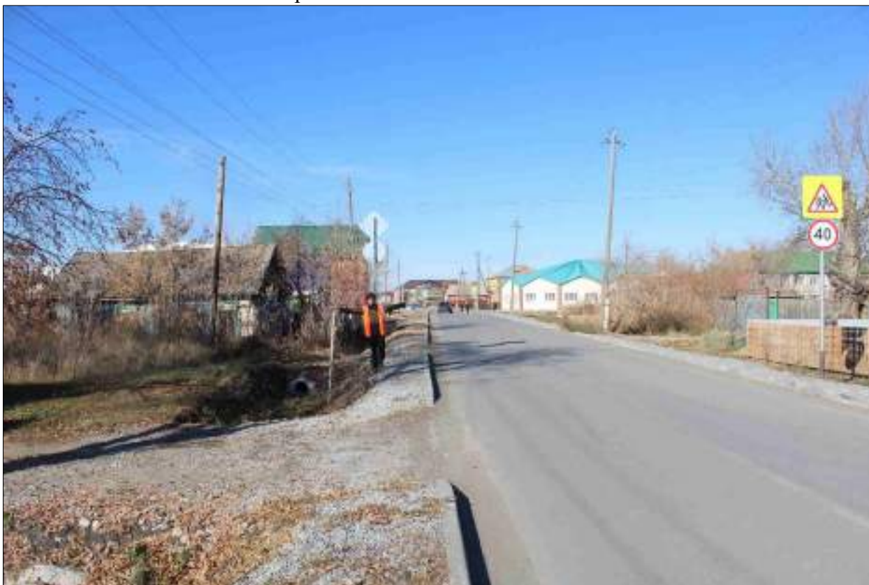
Рисунок 114 – «Распределительный газопровод р.п. Чистоозерное». Вид из точки 126 в направлении точки 125. Снято с ЮВ.
