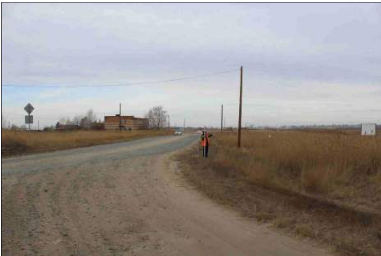
Рисунок 359 – «Распределительный газопровод р.п. Чистоозерное». Вид из точки 10 в направлении точки 11. Снято с ЮВ.
