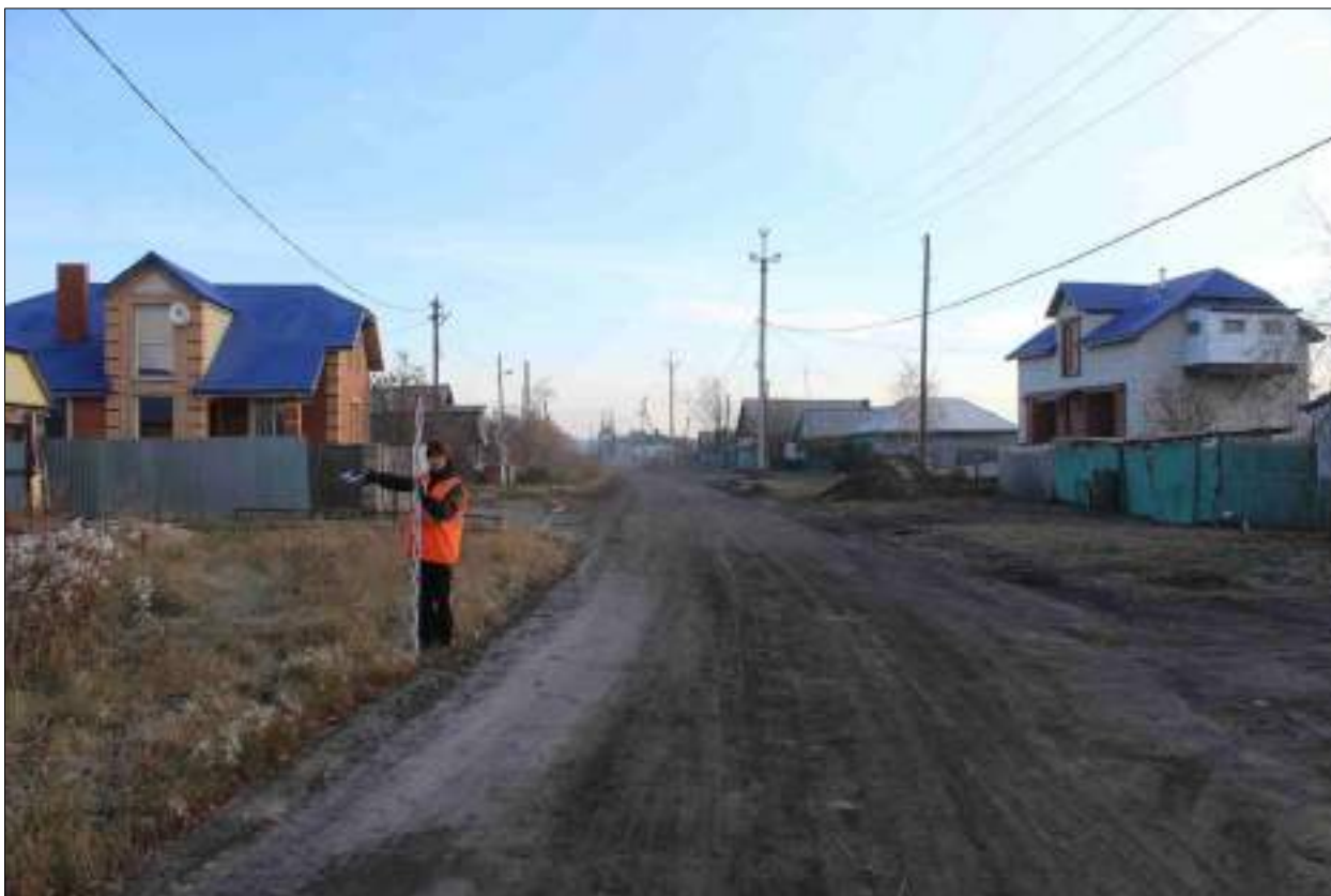
Рисунок 277 – «Распределительный газопровод р.п. Чистоозерное». Вид из точки 39 в направлении точки 34. Снято с ЮЗ.
