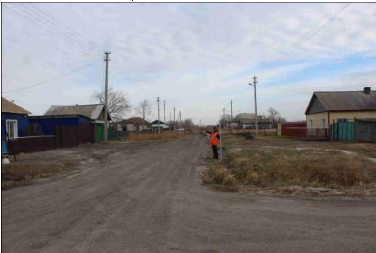
Рисунок 342 – «Распределительный газопровод р.п. Чистоозерное». Вид из точки 16 в направлении точки 5. Снято с ЮЗ.
