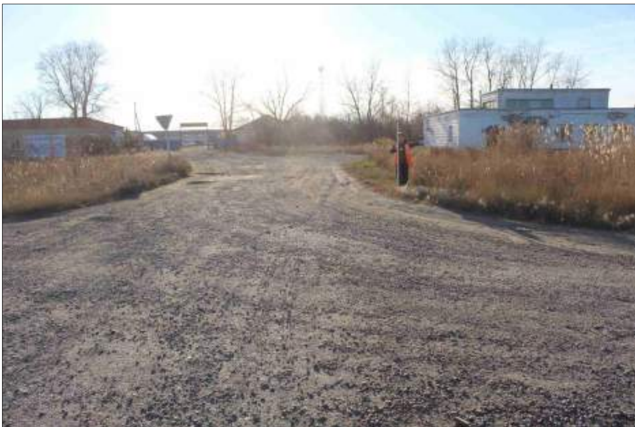
Рисунок 213 – «Распределительный газопровод р.п. Чистоозерное». Вид из точки 84 в направлении точки 193. Снято с СВ.
