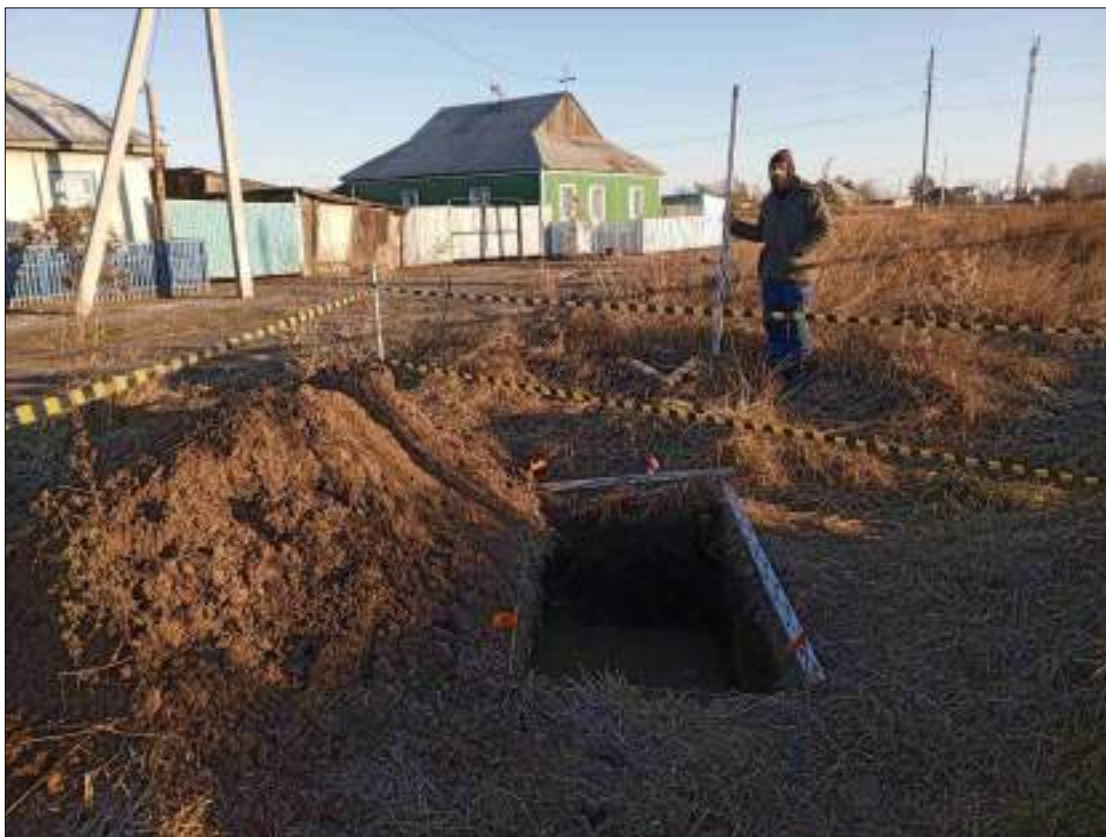
Рисунок 477 – «Распределительный газопровод р.п. Чистоозерное». Шурф №23. Колодец к северо-востоку от шурфа. Снято с Ю.
