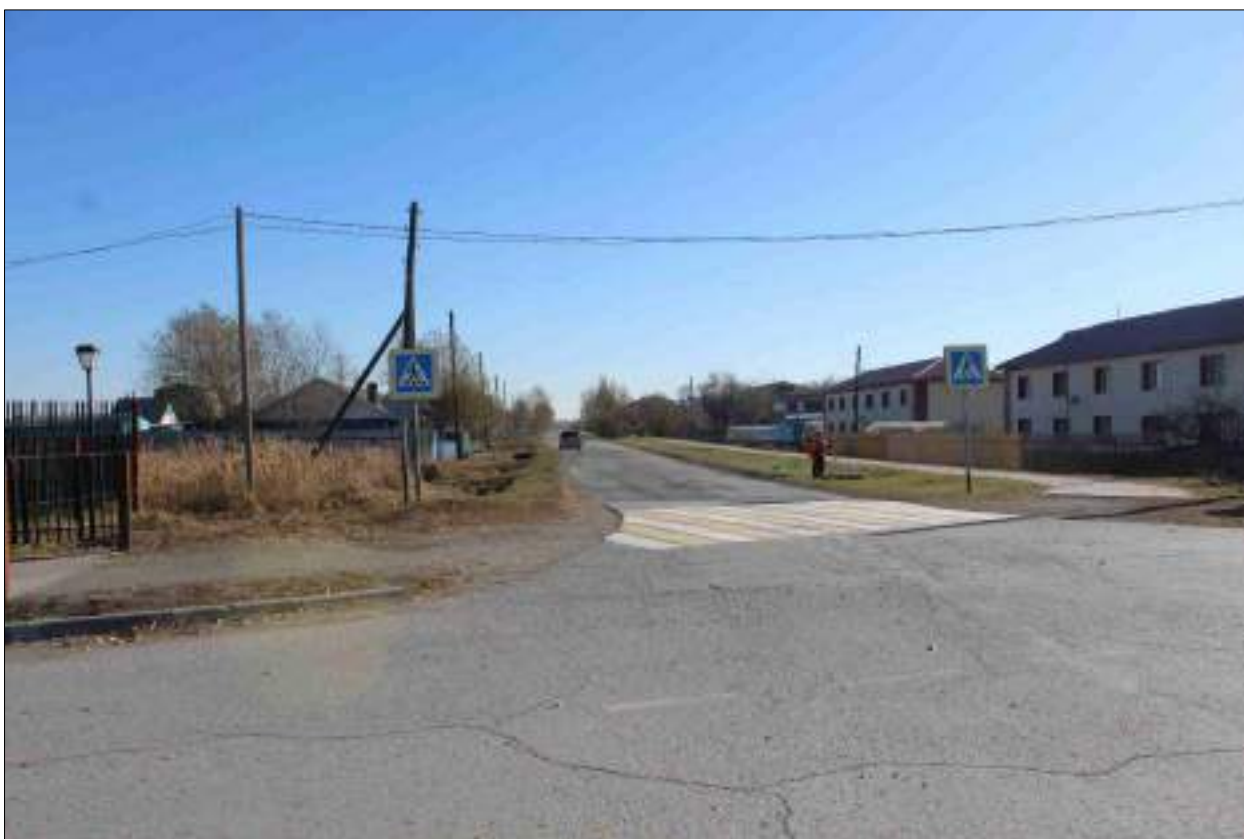
Рисунок 153 – «Распределительный газопровод р.п. Чистоозерное». Вид из точки 156 в направлении точки 157. Снято с СЗ.
