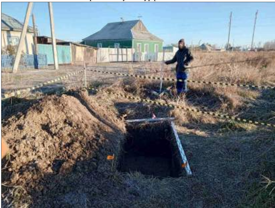
Рисунок 478 – «Распределительный газопровод р.п. Чистоозерное». Шурф №23. Общий вид выполненного шурфа. Снято с Ю.
