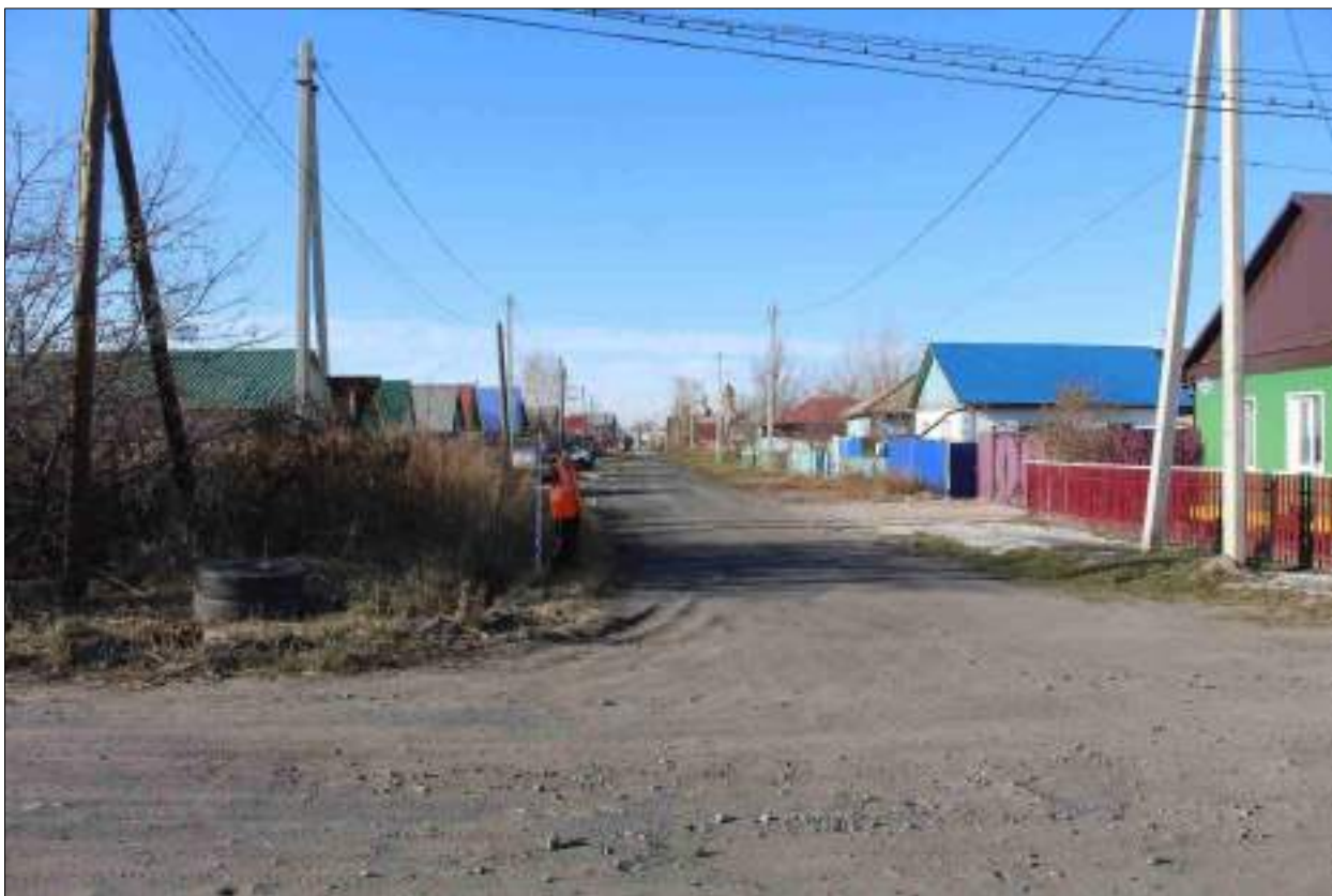
Рисунок 175 – «Распределительный газопровод р.п. Чистоозерное». Вид из точки 117 в направлении точки 129. Снято с ЮВ.
