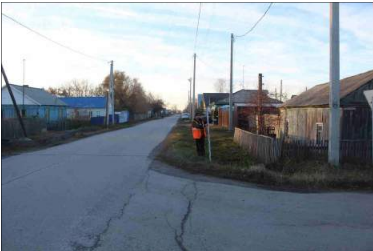
Рисунок 251 – «Распределительный газопровод р.п. Чистоозерное». Вид из точки 42 в направлении точки 46. Снято с ЮВ.
