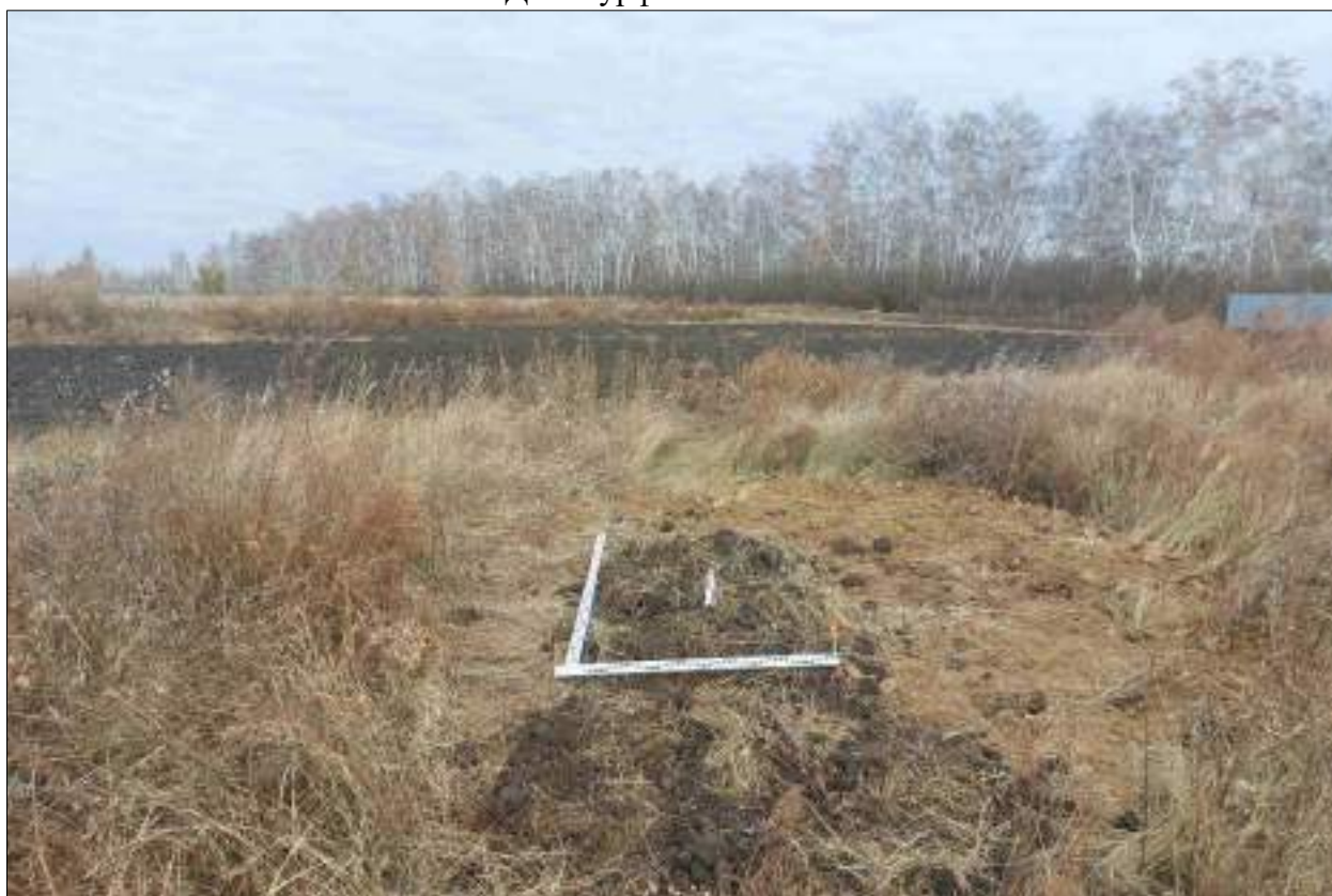
Рисунок 440 – «Распределительный газопровод р.п. Чистоозерное». Шурф №15. Рекультивация. Снято с Ю.
