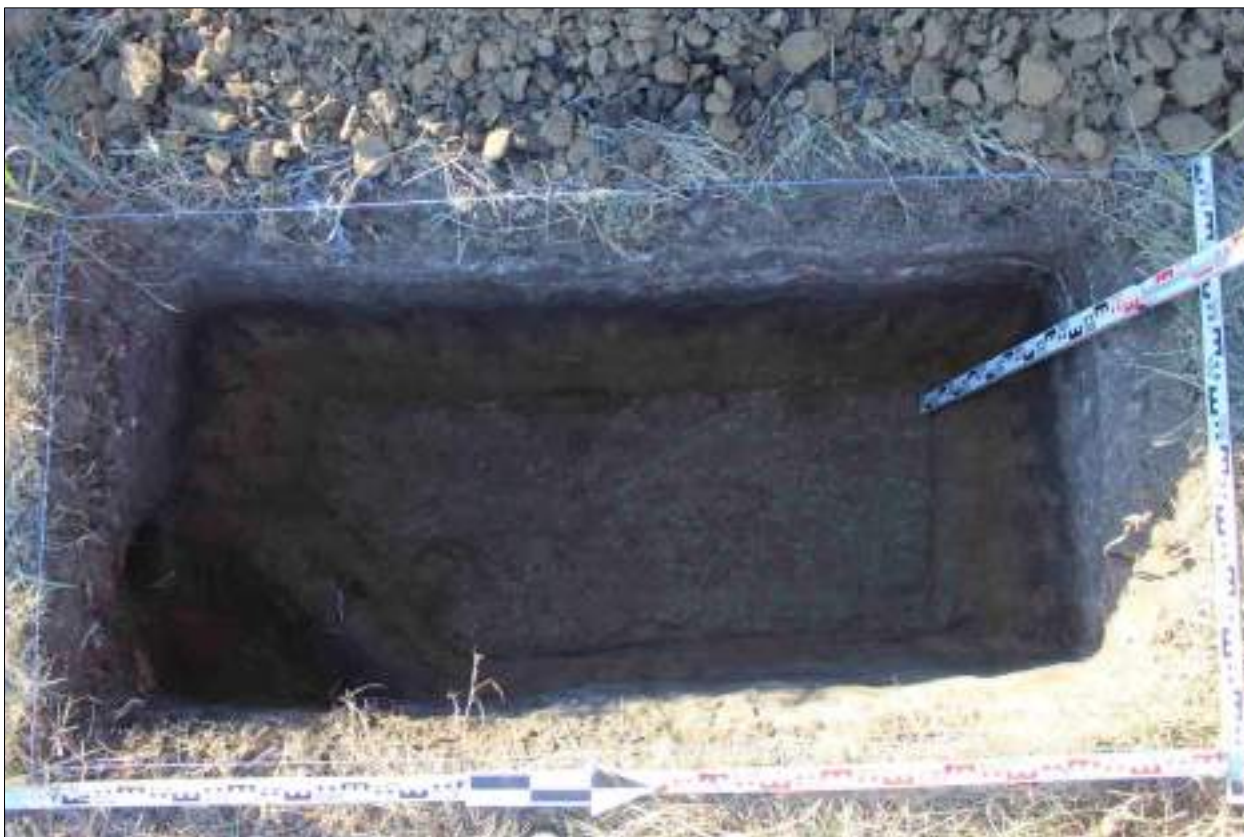
Рисунок 578 – «Распределительный газопровод р.п. Чистоозерное». Шурф №42. Дно шурфа. Снято с В.
