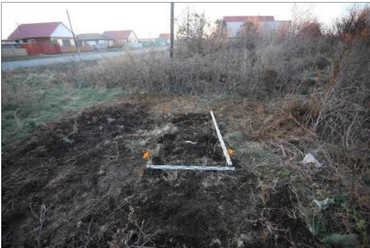
Рисунок 655 – «Распределительный газопровод р.п. Чистоозерное». Шурф №57. Рекультивация. Снято с В.
