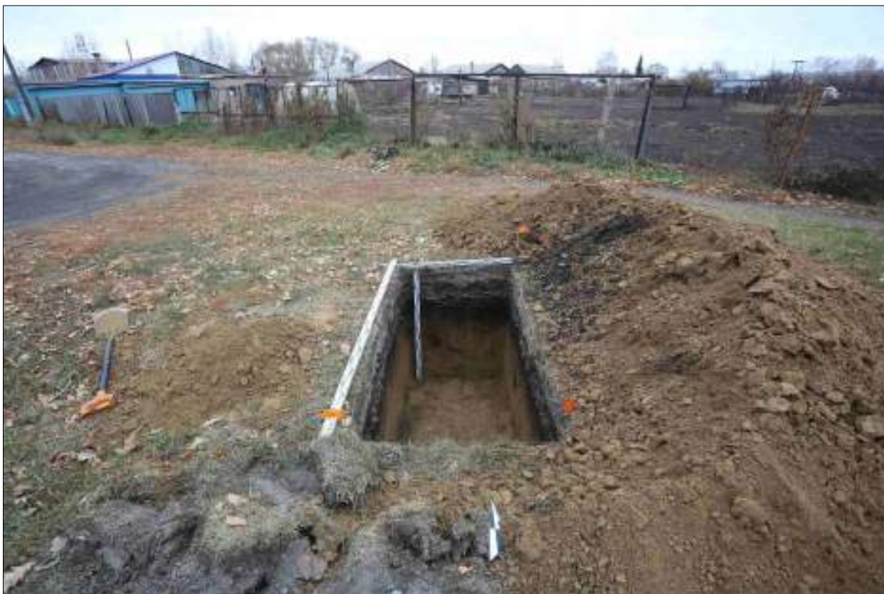
Рисунок 545 – «Распределительный газопровод р.п. Чистоозерное». Шурф №36. Общий вид выполненного шурфа. Снято с Ю.
