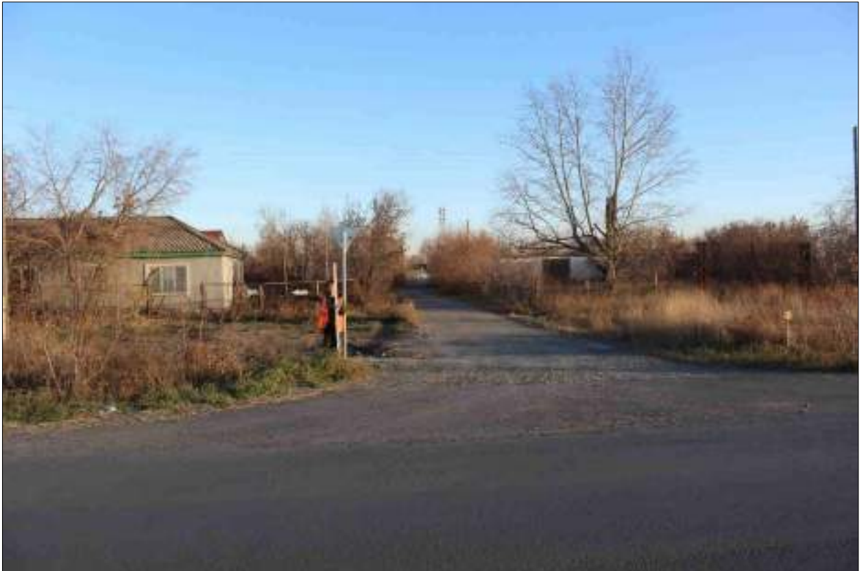
Рисунок 241 – «Распределительный газопровод р.п. Чистоозерное». Вид из точки 60 в направлении точки 68. Снято с СЗ.
