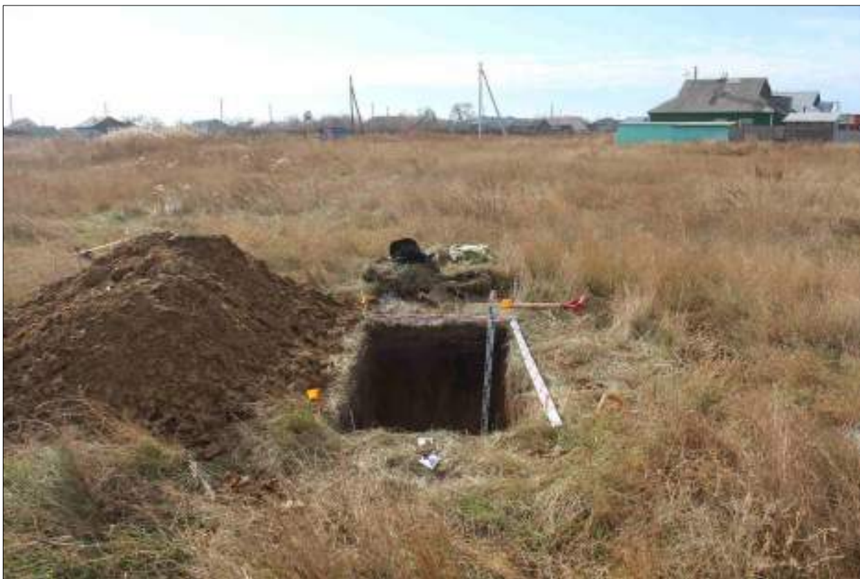
Рисунок 377 – «Распределительный газопровод р.п. Чистоозерное». Шурф №3. Общий вид выполненного шурфа. Снято с С.
