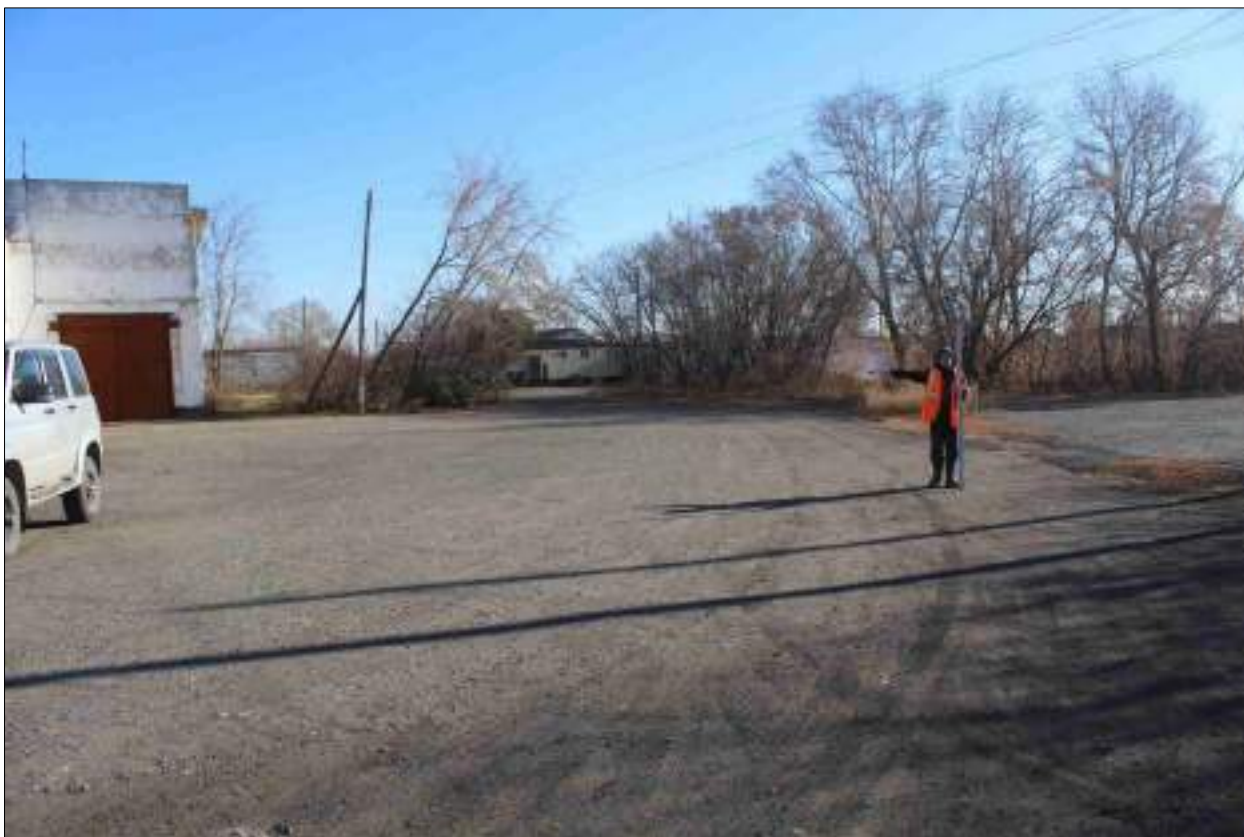
Рисунок 89 – «Распределительный газопровод р.п. Чистоозерное». Вид из точки 146 в направлении точки 145. Снято с З.
