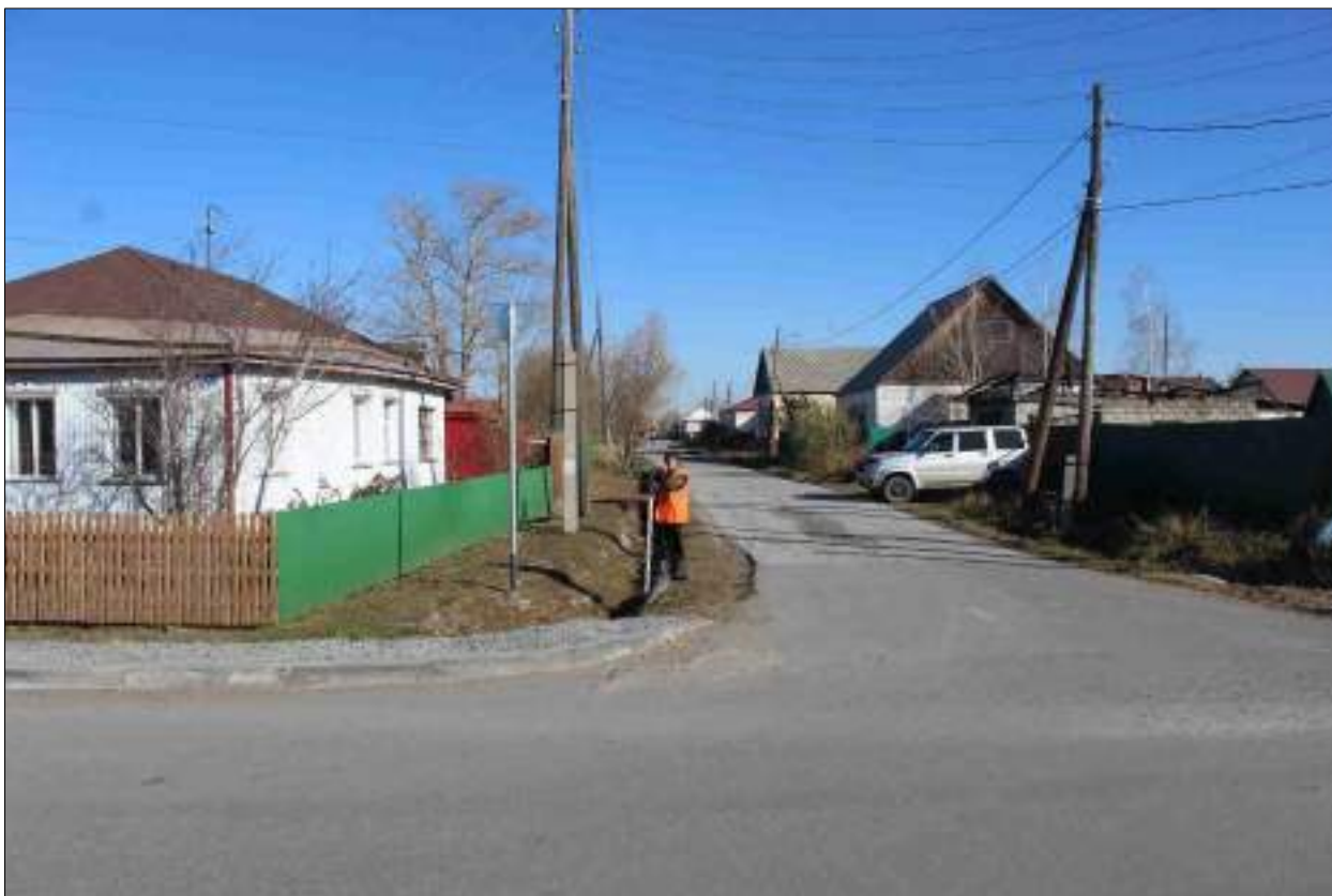
Рисунок 113 – «Распределительный газопровод р.п. Чистоозерное». Вид из точки 126 в направлении точки 127. Снято с ЮЗ.
