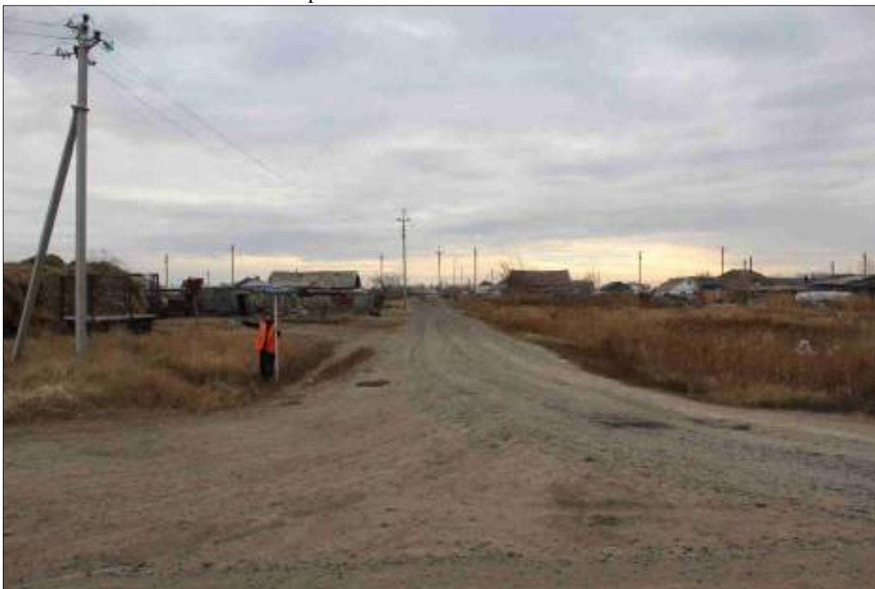
Рисунок 354 – «Распределительный газопровод р.п. Чистоозерное». Вид из точки 8 в направлении точки 16. Снято с СЗ.
