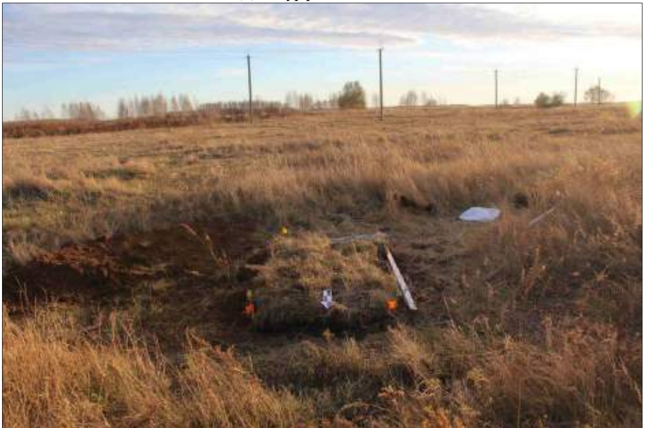
Рисунок 614 – «Распределительный газопровод р.п. Чистоозерное». Шурф №49. Рекультивация. Снято с С.
