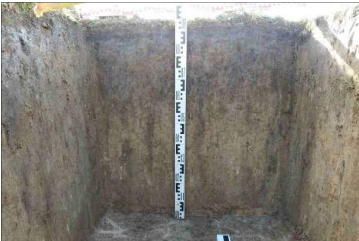
Рисунок 473 – «Распределительный газопровод р.п. Чистоозерное». Шурф №22. Южная стенка. Снято с С.
