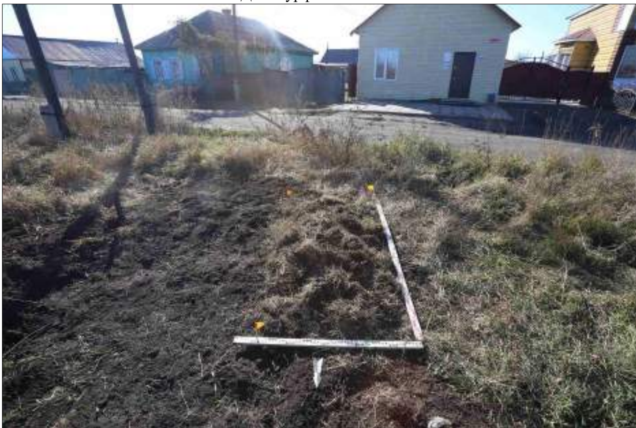
Рисунок 644 – «Распределительный газопровод р.п. Чистоозерное». Шурф №55. Рекультивация. Снято с С.
