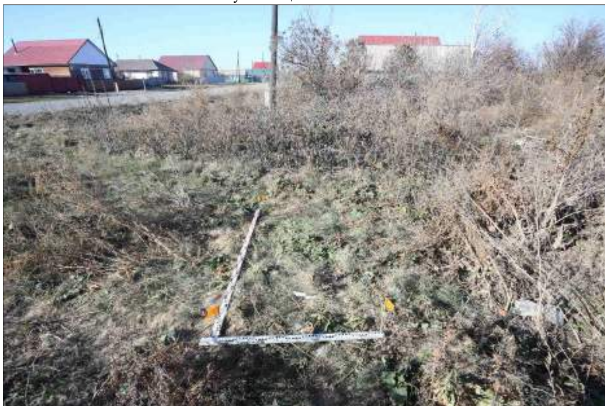
Рисунок 650 – «Распределительный газопровод р.п. Чистоозерное». Шурф №57. Общий вид. Разбивка. Снято с В.
