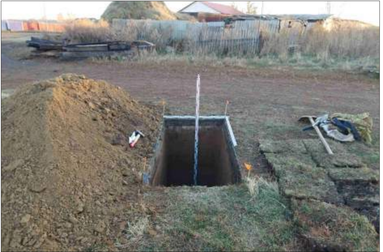
Рисунок 397 – «Распределительный газопровод р.п. Чистоозерное». Шурф №7. Общий вид выполненного шурфа. Снято с С.
