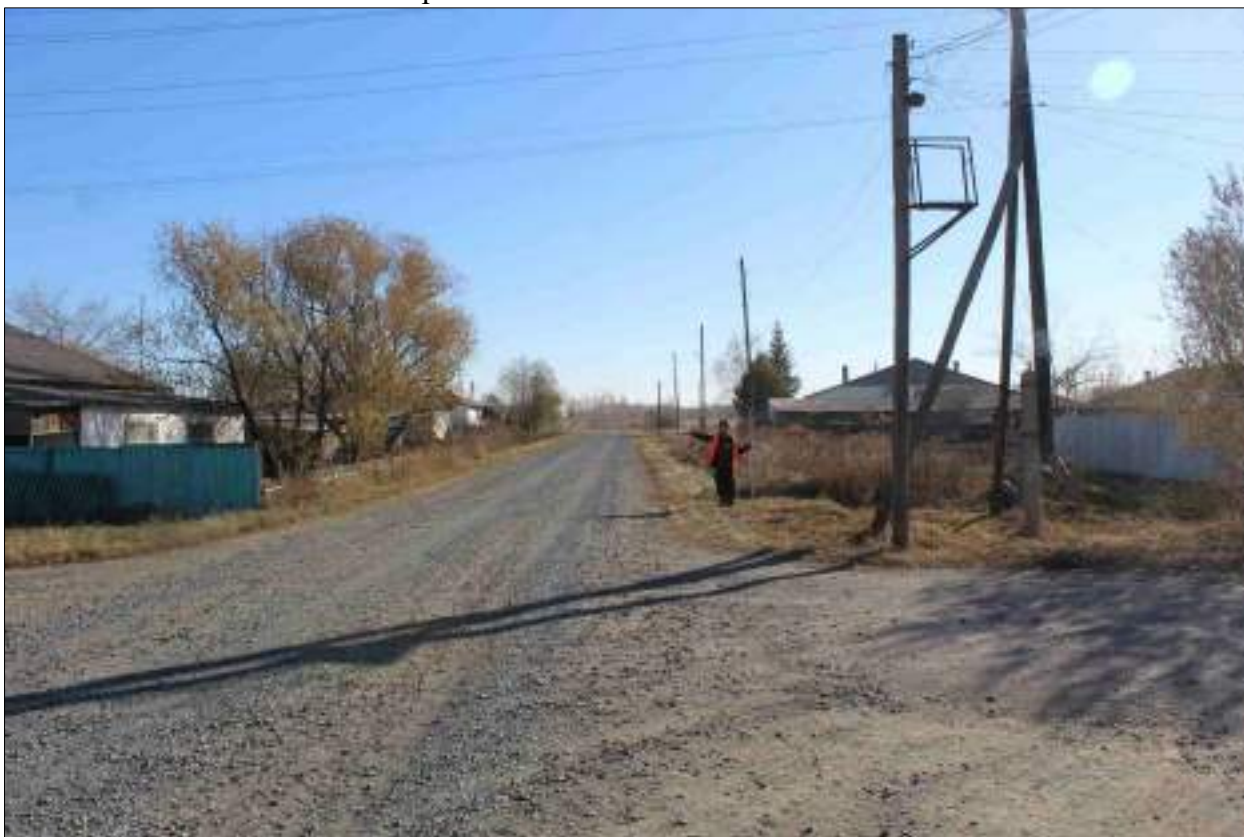
Рисунок 130 – «Распределительный газопровод р.п. Чистоозерное». Вид из точки 106 в направлении точки 103. Снято с СЗ.
