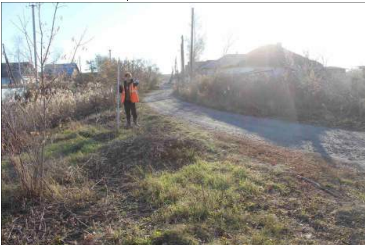
Рисунок 220 – «Распределительный газопровод р.п. Чистоозерное». Вид из точки 68 в направлении точки 69. Снято с СВ.
