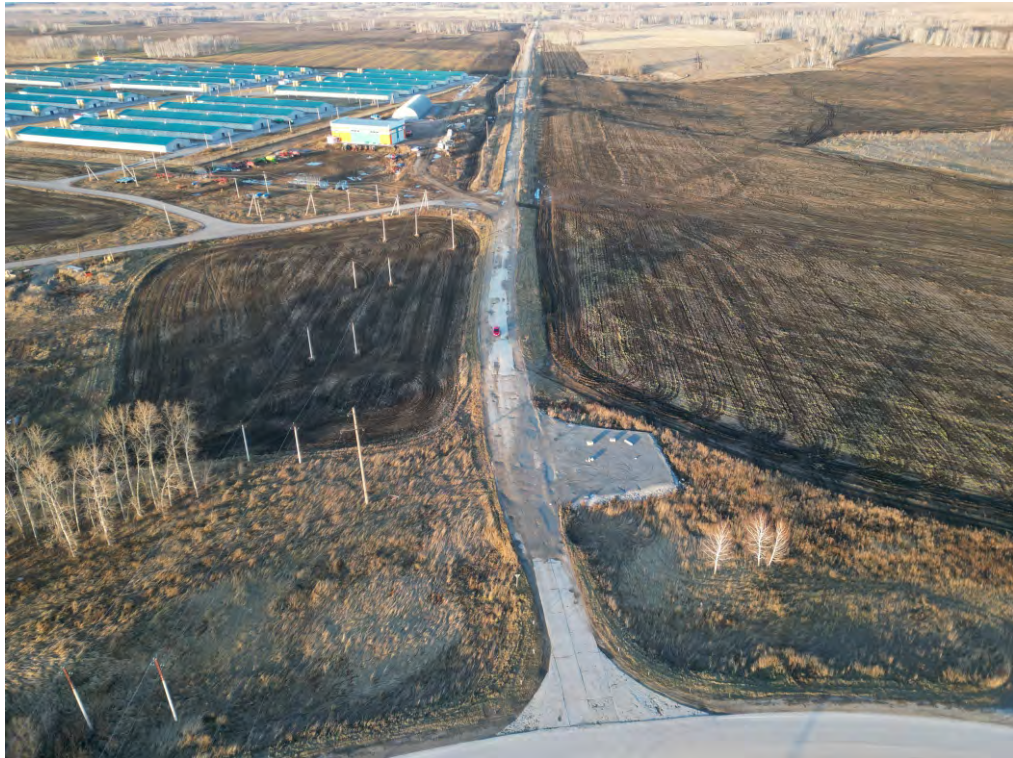
Рис. 9. Фото. Новосибирская область. Искитимский район. Археологическая разведка по объекту: «Реконструкция автомобильной дороги «от с. Сосновка до Улыбино» в Искитимском районе Новосибирской области». Общий вид участка № 1 с юга.
