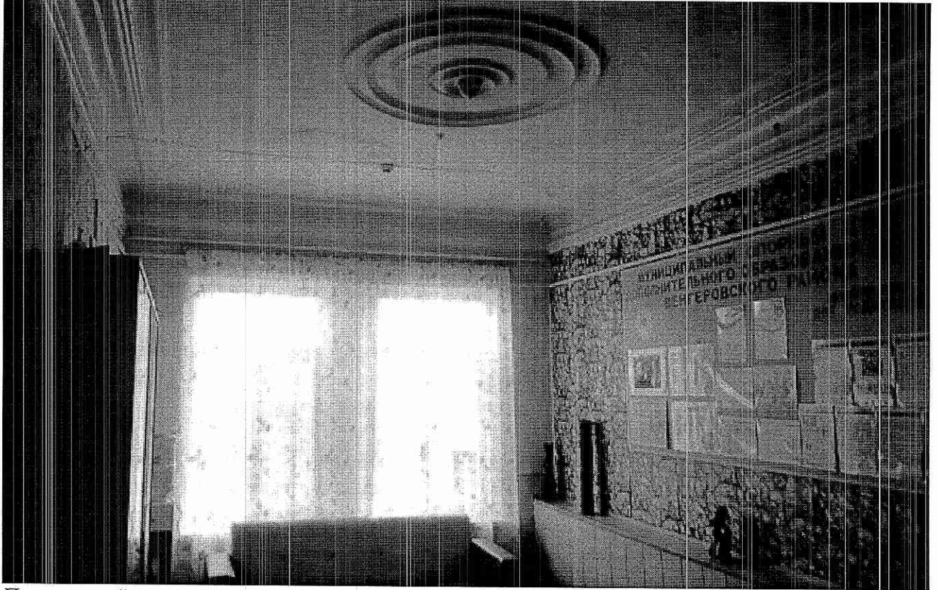
Потолочный карниз и потолочная розетка.
