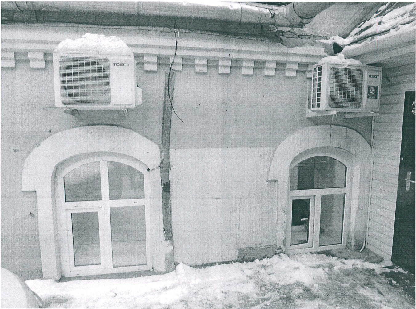
14. Фрагмент северного фасада.
