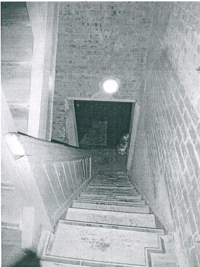
23. Служебная лестница: нижний марш.
