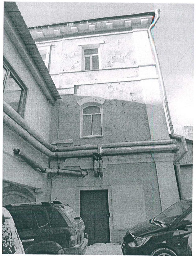
4. Фрагмент восточного фасада.
