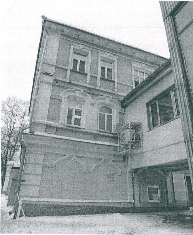
3. Фрагмент восточного фасада.
