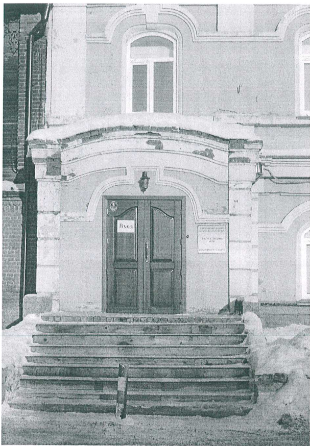
8. Вход на южном фасаде.
