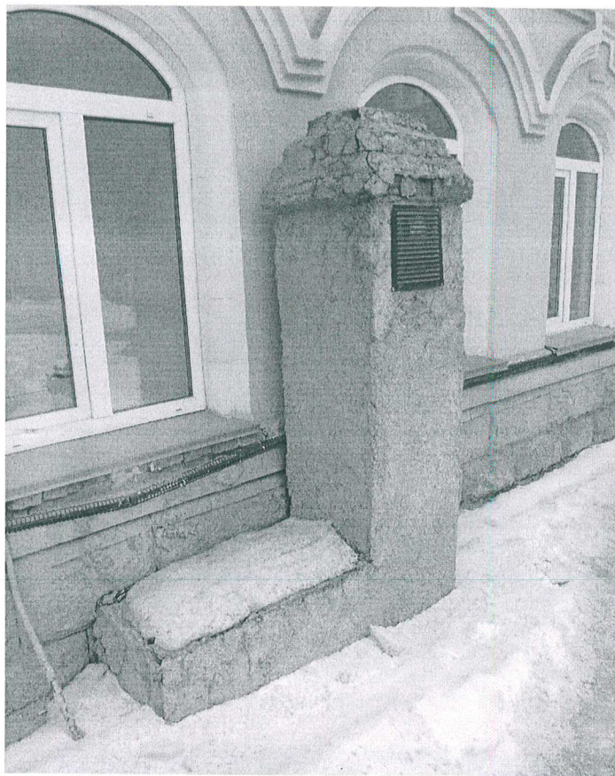
9. Шахта воздухозабора на южном фасаде.
