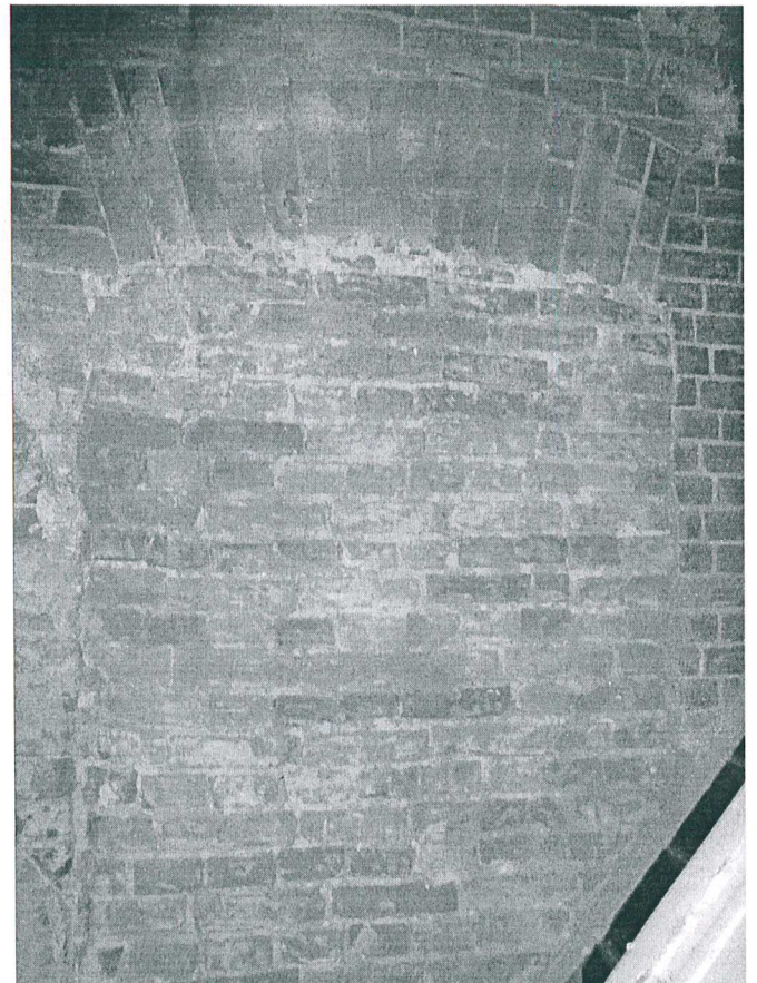
24. Фрагмент стены лестничной клетки.
