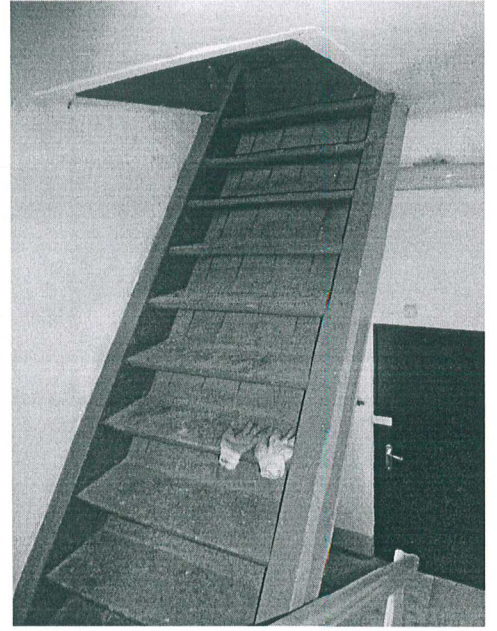
22. Подъем на чердак.
