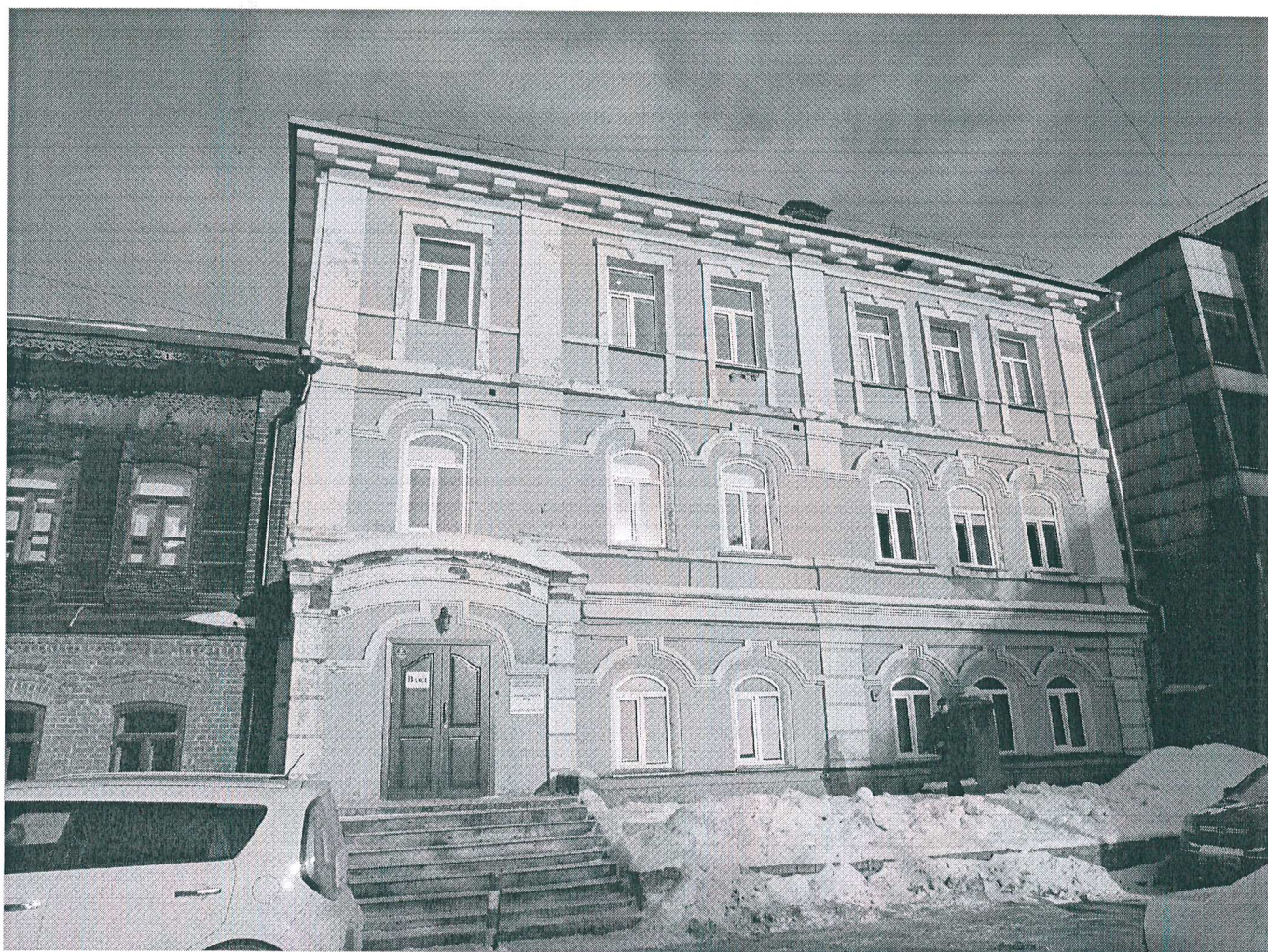
2. Общий вид южного фасада Памятника.
