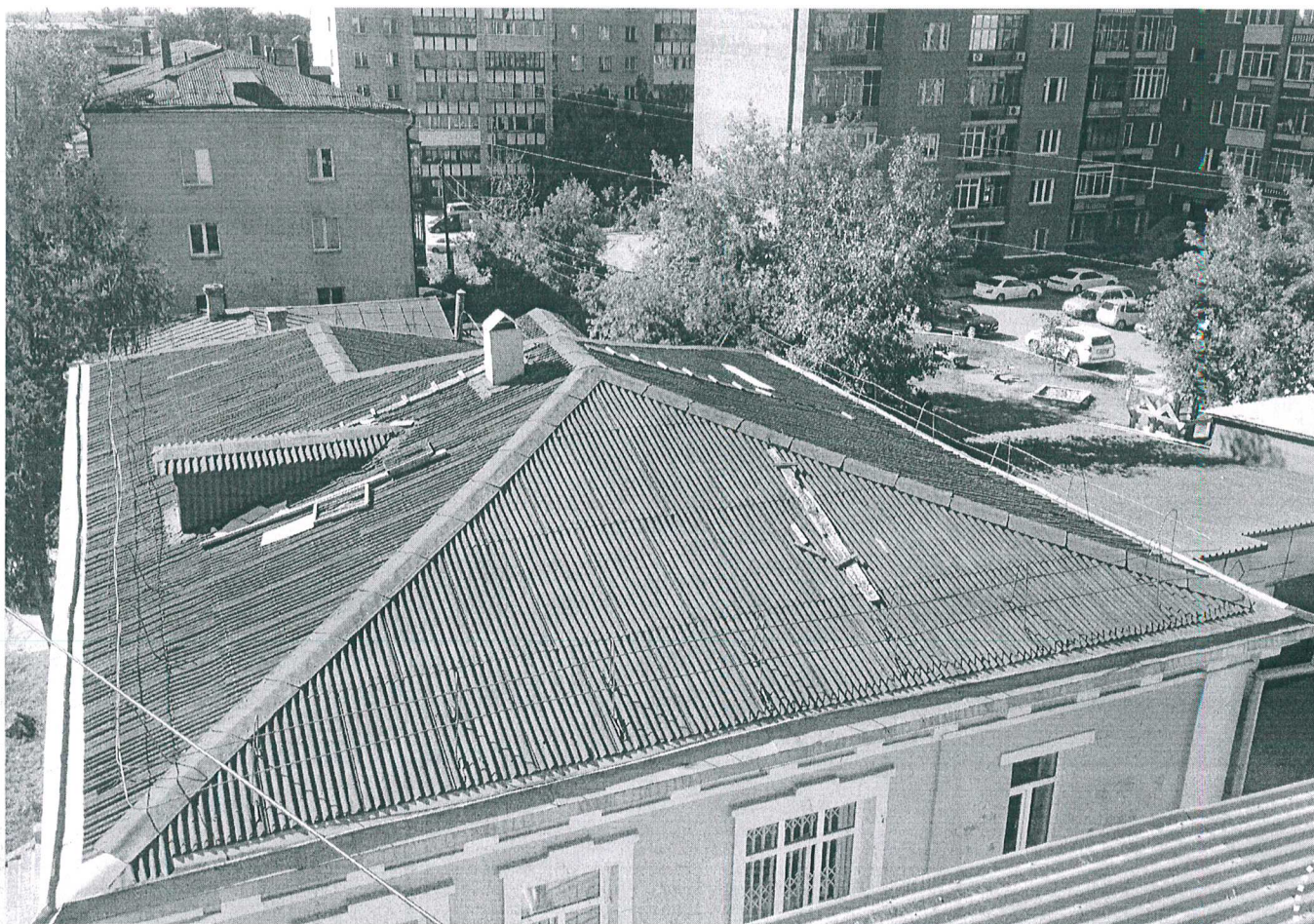
15. Общий вид крыши с восточной стороны.
