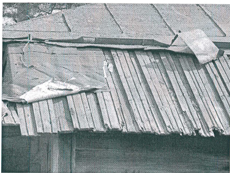
14. Фрагмент северного ската крыши.
