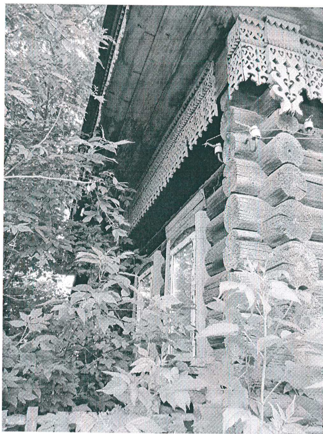
10. Фрагмент западной стороны сруба.
