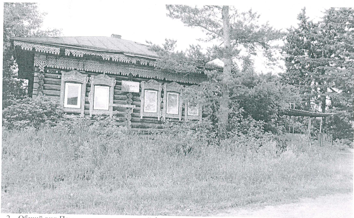
2. Общий вид Памятника с юга: главный фасад.
