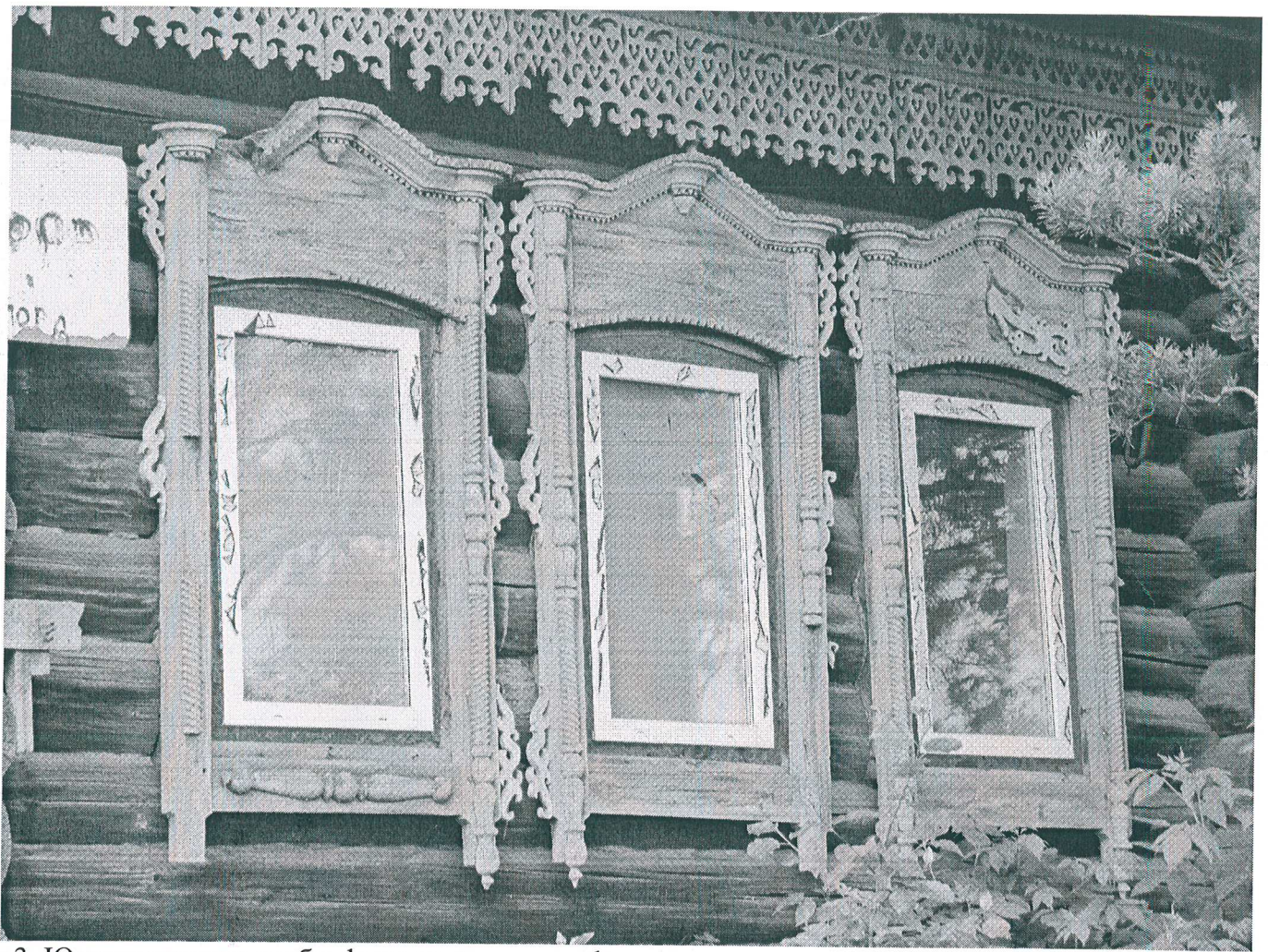
3. Южная сторона сруба: фрагмент главного фасада.
