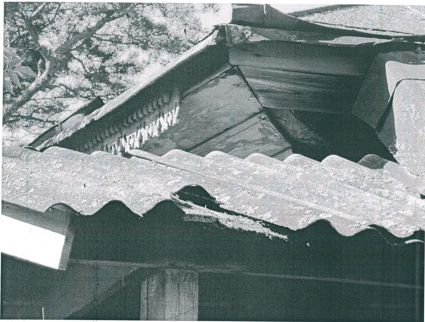
13. Фрагмент северо-восточного угла сруба.
