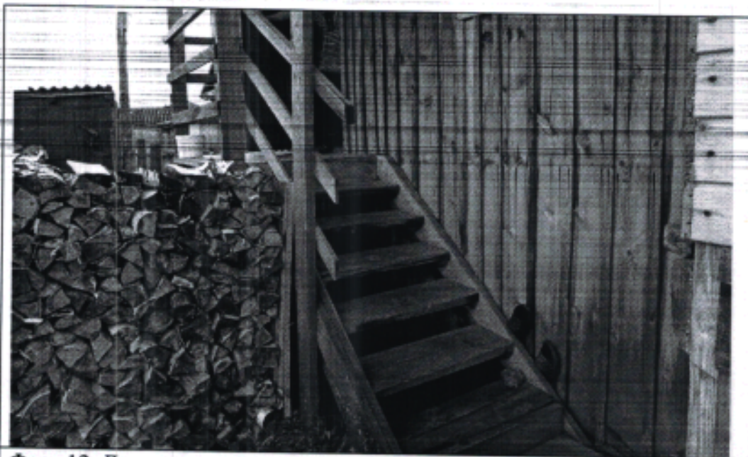
Фото 13. Лестница на второй этаж.
