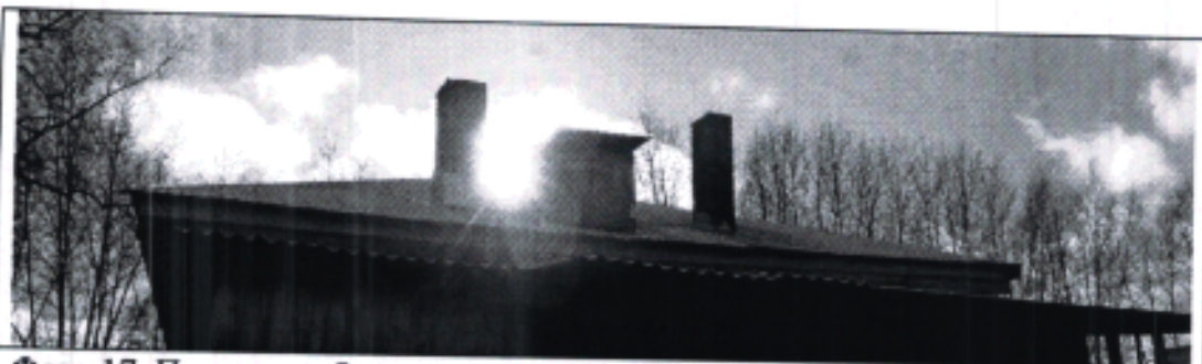
Фото 17. Печные трубы и слуховое окно на дворовом скате крыши.
