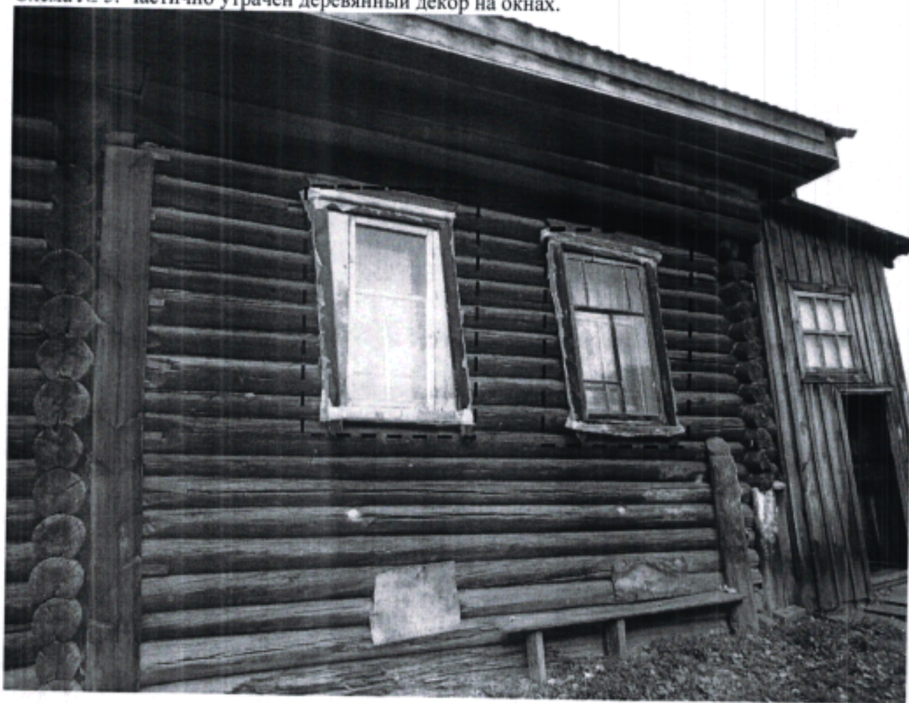
Схема № 5. Частично утрачен деревянный декор на окнах.
