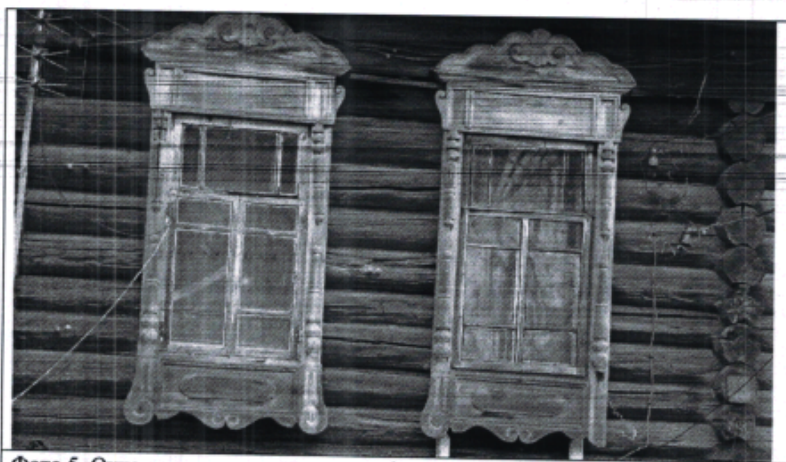
Фото 5. Окна на втором этаже южного фасада.
