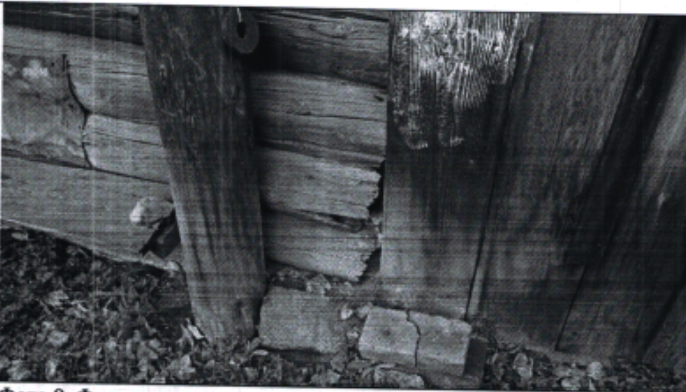
Фото 9. Фрагмент стены дома.
