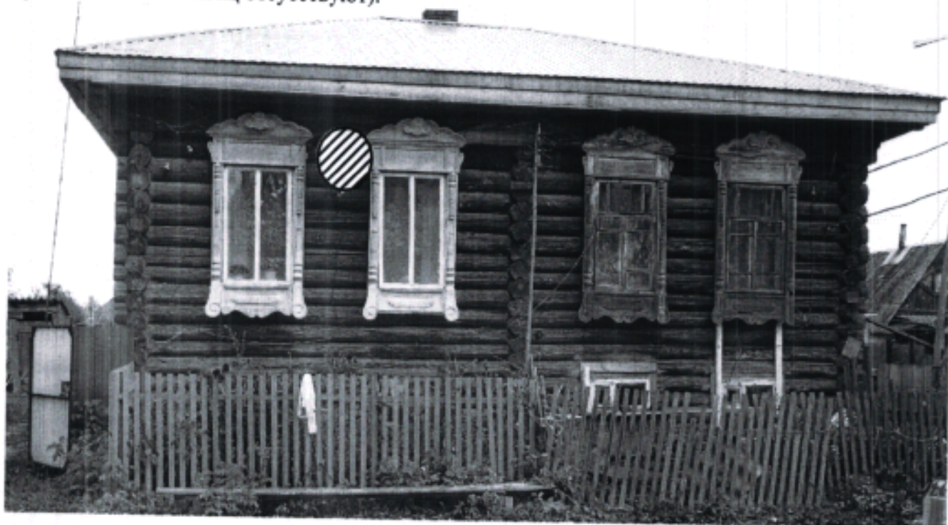
Схема № 5. Частично утрачен деревянный декор на окнах.
