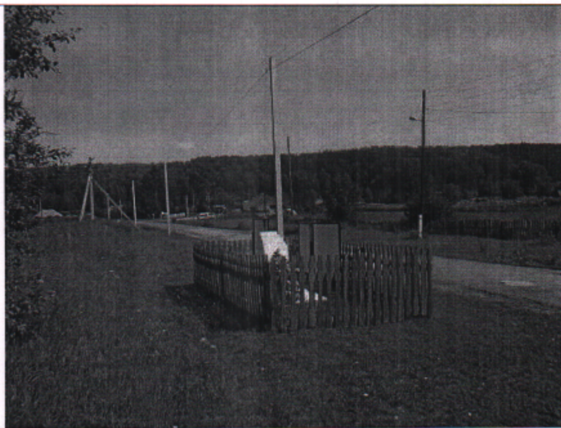
Фото 2. Общий вид с северо-запада.
