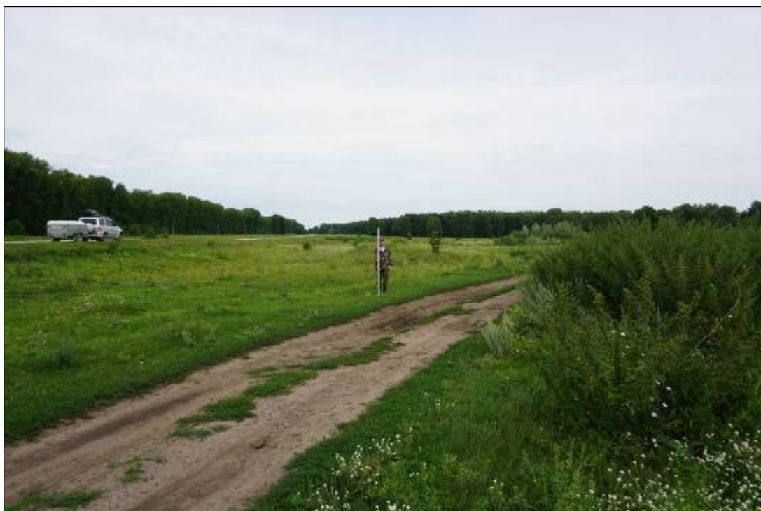
Приложение 16. ФОТО. Земельные участки под размещение объекта: «Газопровод межпоселковый ГРС Электродный завод - р.п. Сузун с газопроводами-отводами для газоснабжения населенных пунктов Искитимского и Сузунского районов Новосибирской области». Точка фотофиксации 1. Вид с ЮЮЗ на участок подхода трассы газопровода к с. Бедрино.
