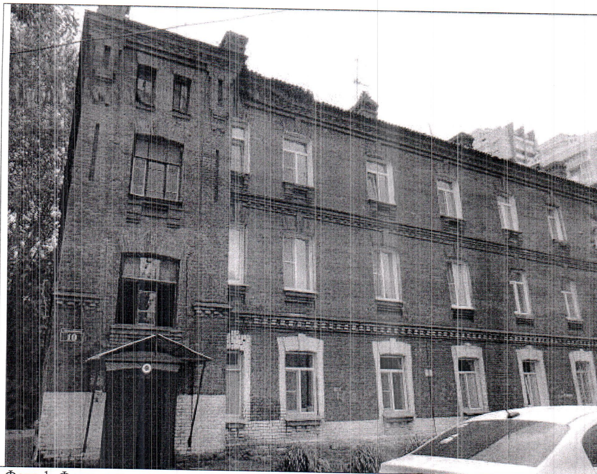
Фото 1. Фрагмент северо-западного главного фасада, северная часть
