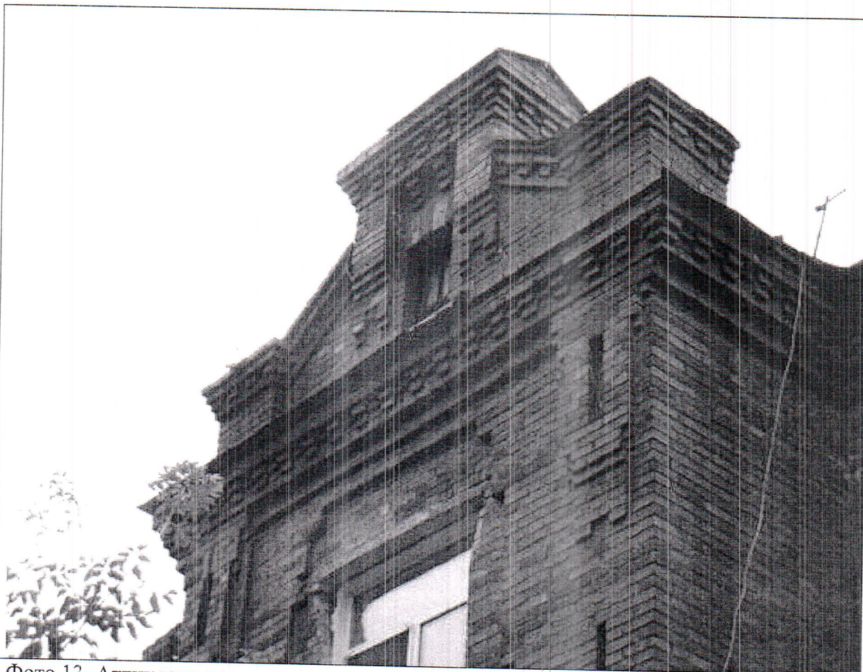
Фото 13. Аттик юго-восточного ризалита
