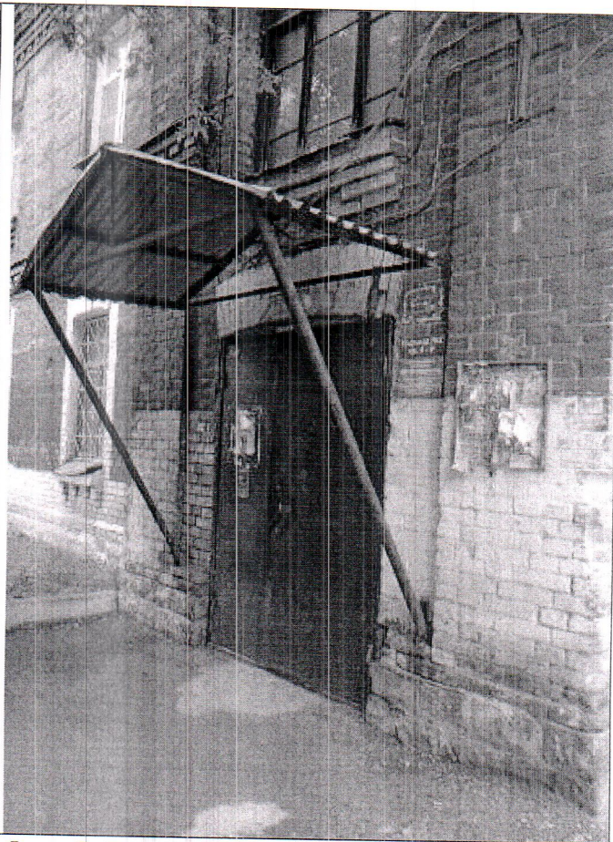
Фото 7. Входной узел в подъезд № 2
