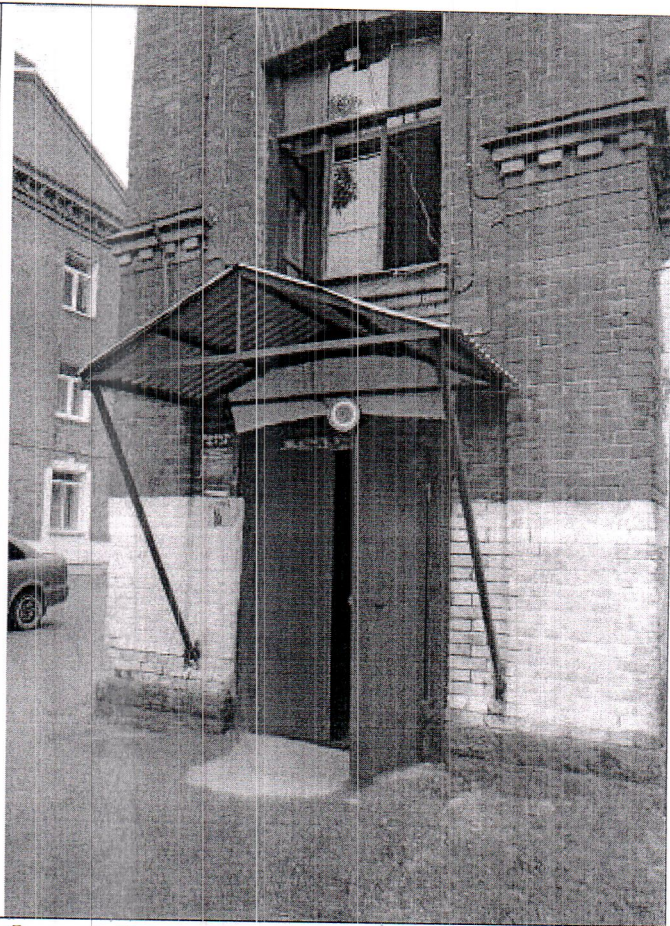
Фото 4. Входной узел в подъезд № 1
