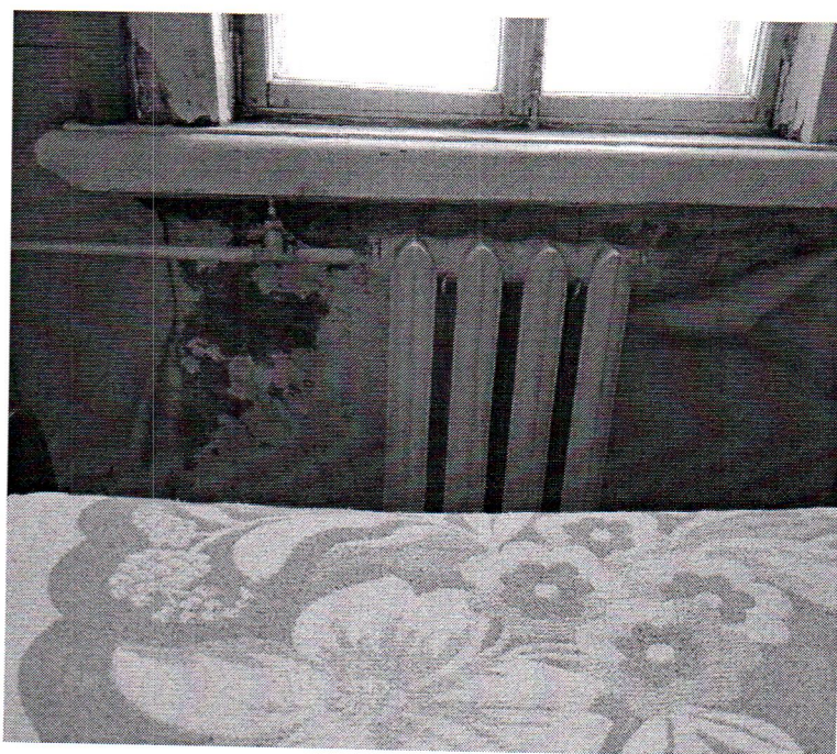
Фото 25, 26. Следы протечек и промерзания стен в жилом помещении кв.10.
