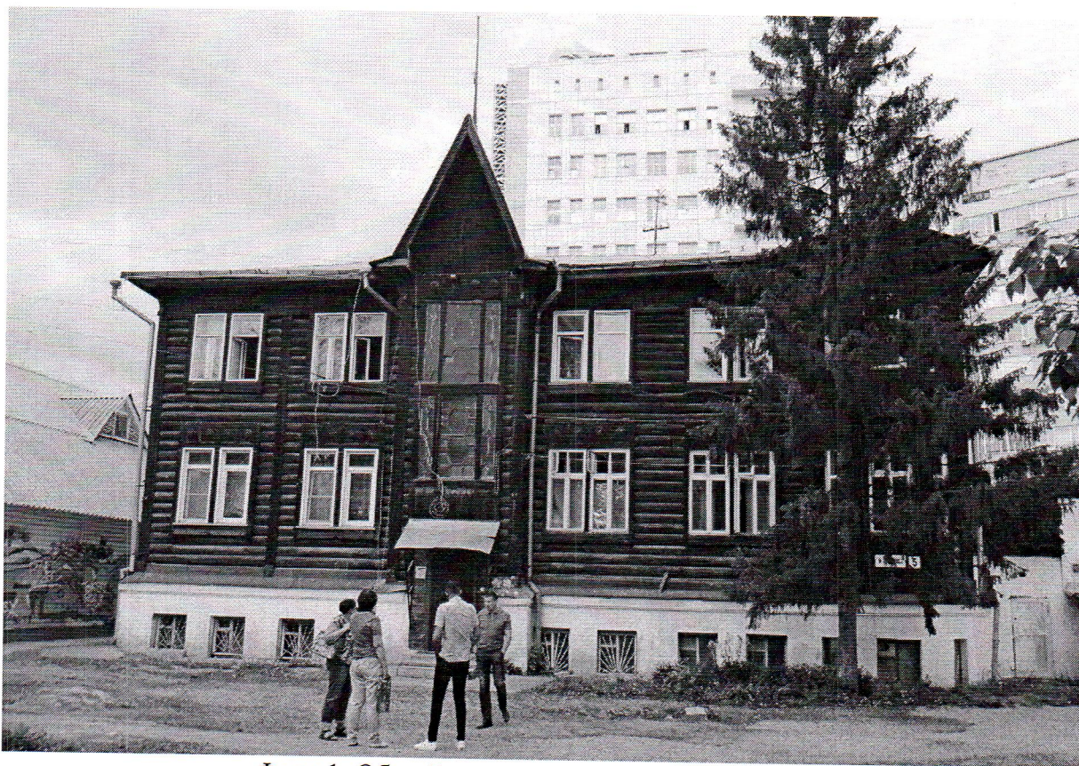
Фото 1. Общий вид главного (южного) фасада.
