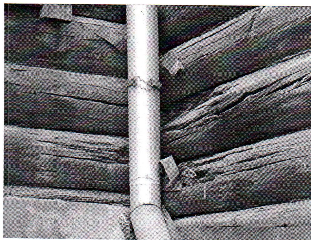
Фото 8, 9. Поражение гнилью нижних венцов на внутренних углах сруба на северном фасаде.
