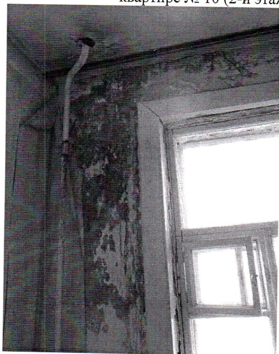
Фото 25, 26. Следы протечек и промерзания стен в жилом помещении кв.10.
