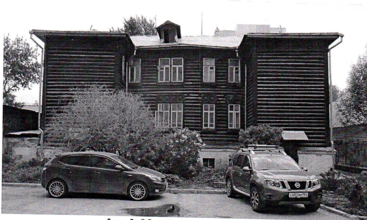
Фото 2. Общий вид северного фасада.
