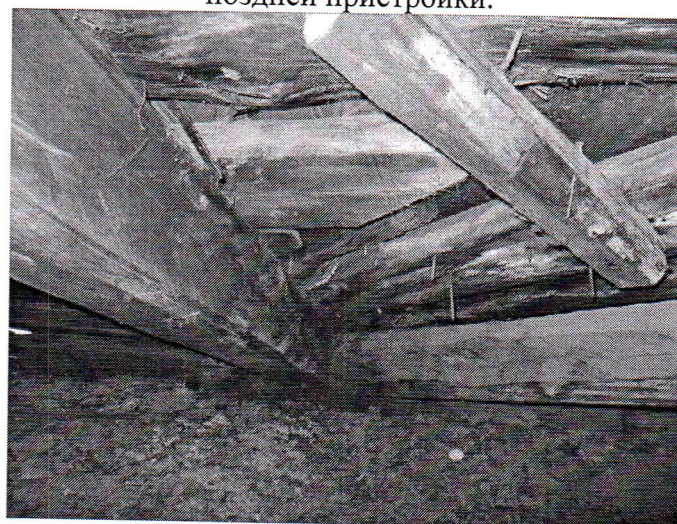
Фото 12, 13. Поражение гнилью опорных концов стропильных ног в ендовах.
