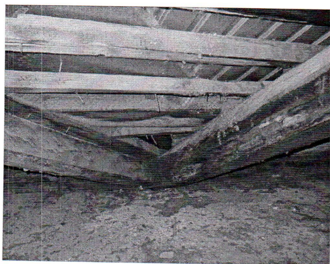
Фото 12, 13. Поражение гнилью опорных концов стропильных ног в ендовах.
