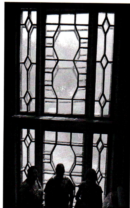
↑ Фото 20. Витраж (вид из помещения). Хорошо видна деформация верхней наружной рамы.
