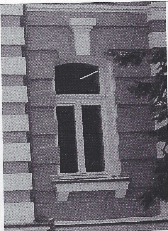
Фото 14. Декоративное оформление окон 1-ого этажа западного (главного) фасада.
