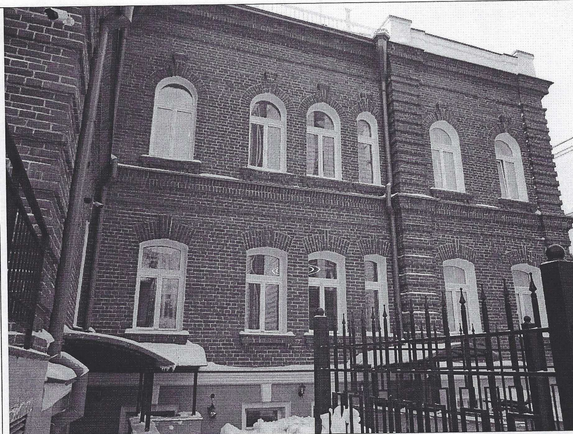
Фото 2. Правая часть восточного фасада.
