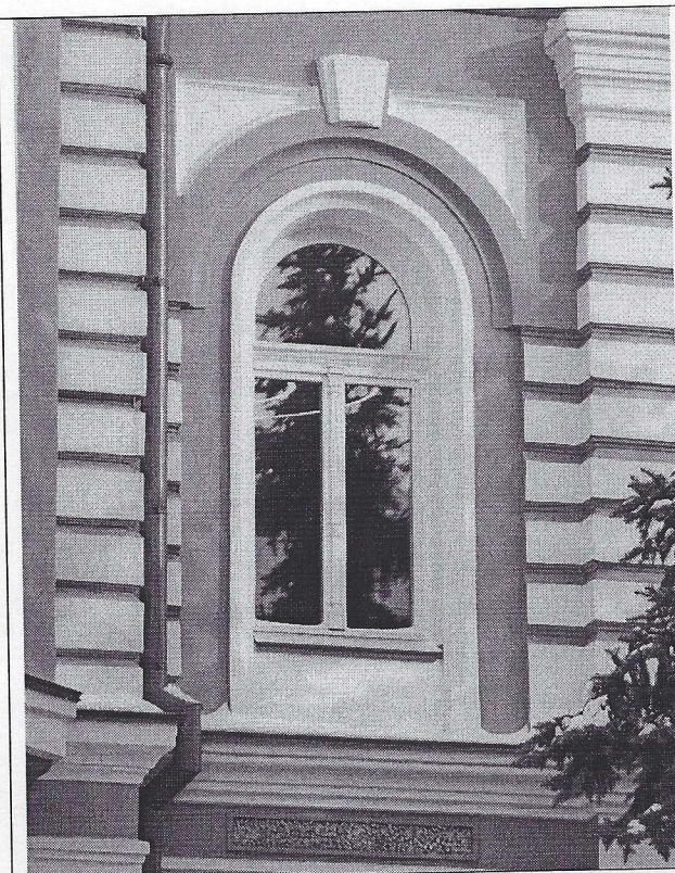
Фото 13. Декоративное оформление окон 2-ого этажа западного (главного) фасада.
