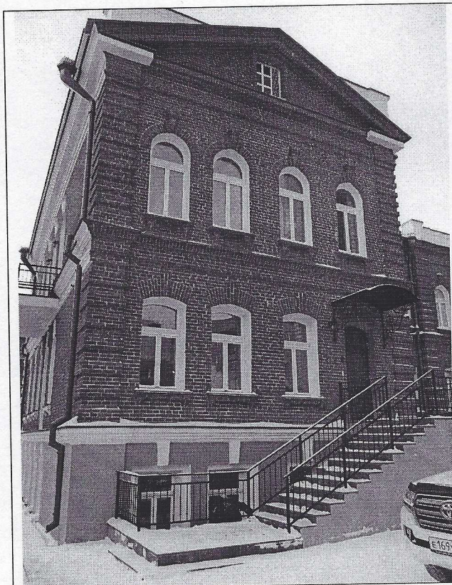
Фото 3. Левая часть восточного фасада.
