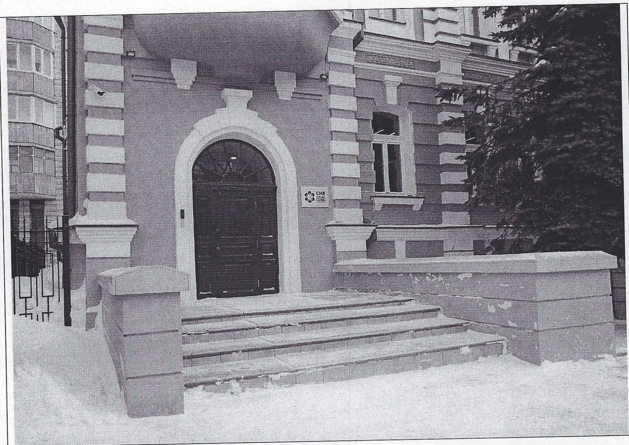
Фото 19. Вид крыльца на главном (западном) фасаде.
