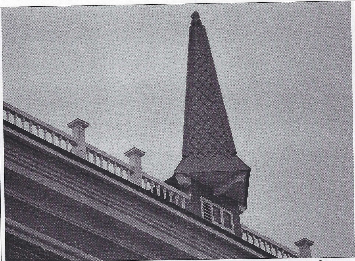
Фото 10. Четырёхгранный шатёр над чердачным окном на южном фасаде. Фрагмент ограждения кровли.
