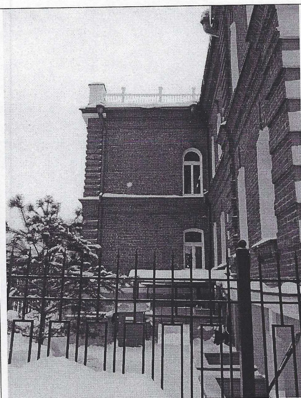
Фото 6. Дворовая часть северного фасада.
