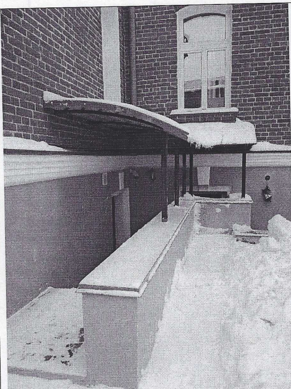
Фото 22. Приямок спуска в цокольный этаж со стороны северного фасада.
