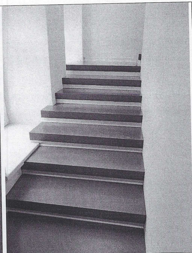
Фото 26. Лестница в южной части здания.
