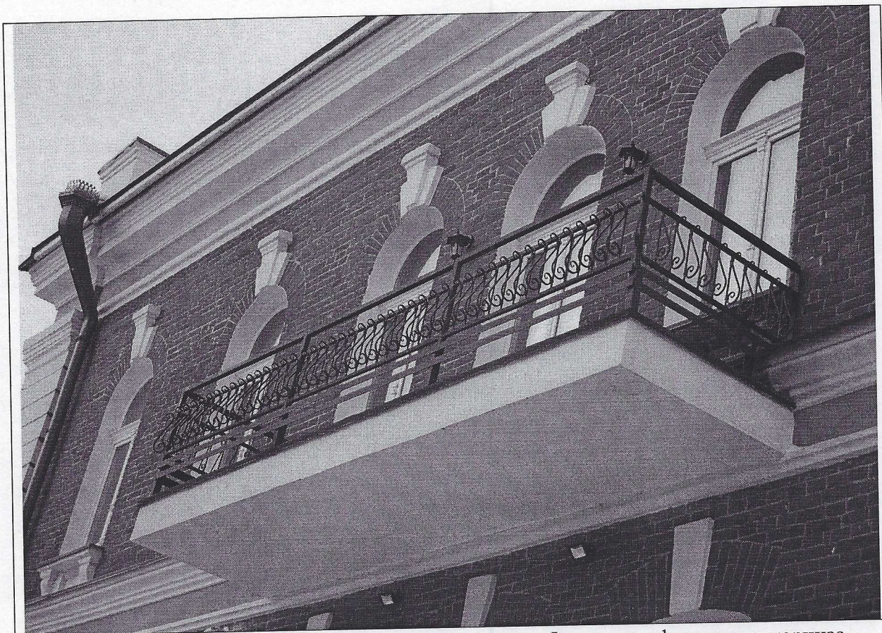
Фото 12. Восстановленный балкон на южном фасаде. Фрагмент оформления карниза.
