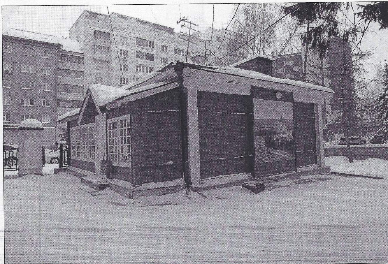
Фото 3. Вид фасадов с запада.
