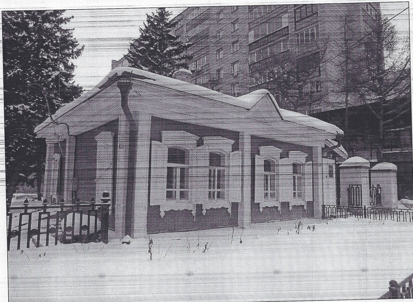
Фото 2. Вид здания с востока.
