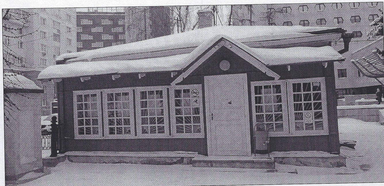
Фото 5. Северо-западный (боковой) фасад.
