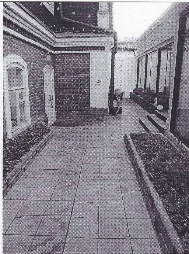
Фото 21. Вид приямков со стороны западного фасада.
