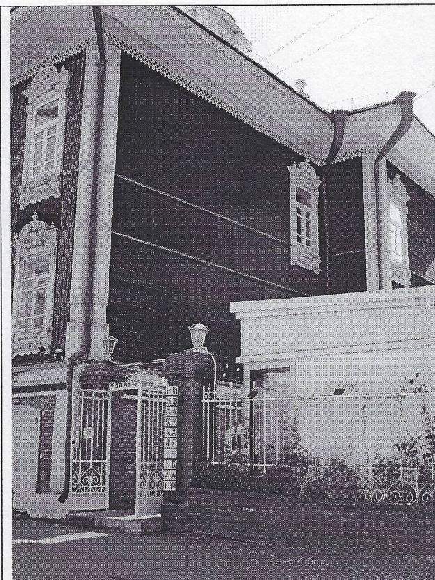
Фото 3. Левая часть западного фасада.
