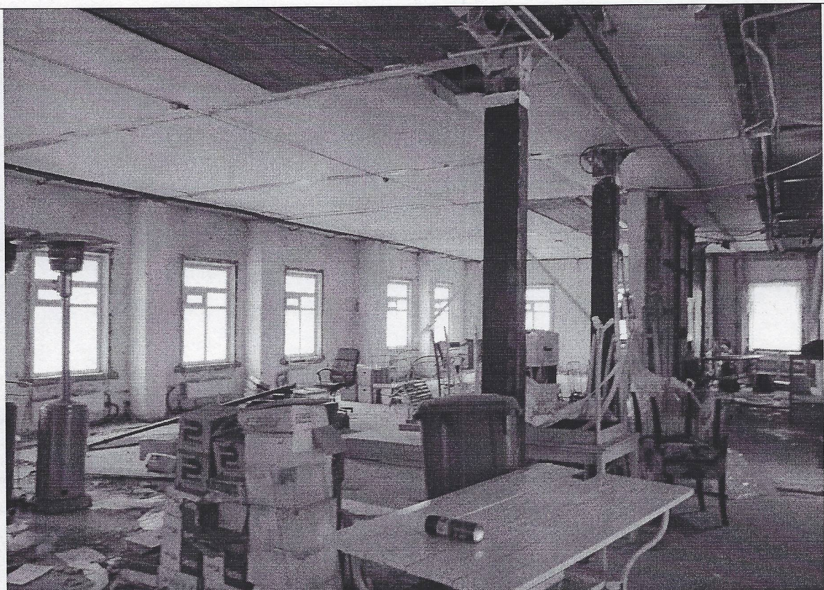
Фото 16. Вид колонн на 1-м этаже.
