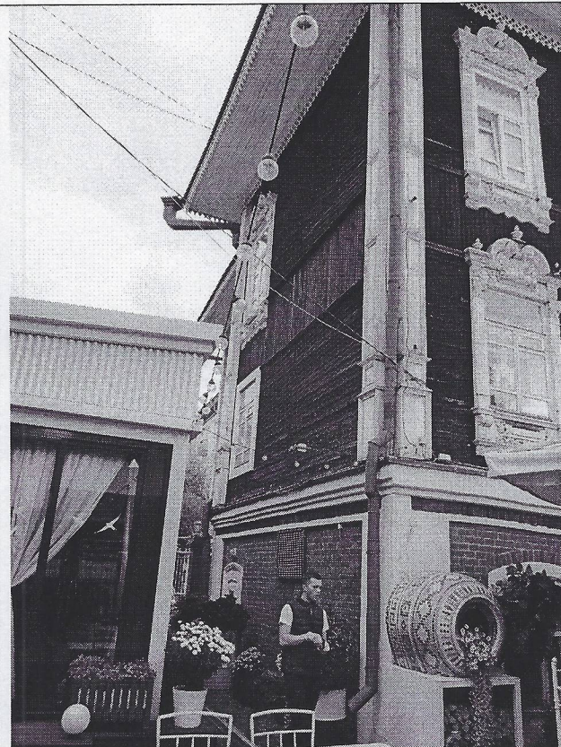
Фото 4. Правая часть западного фасада.
