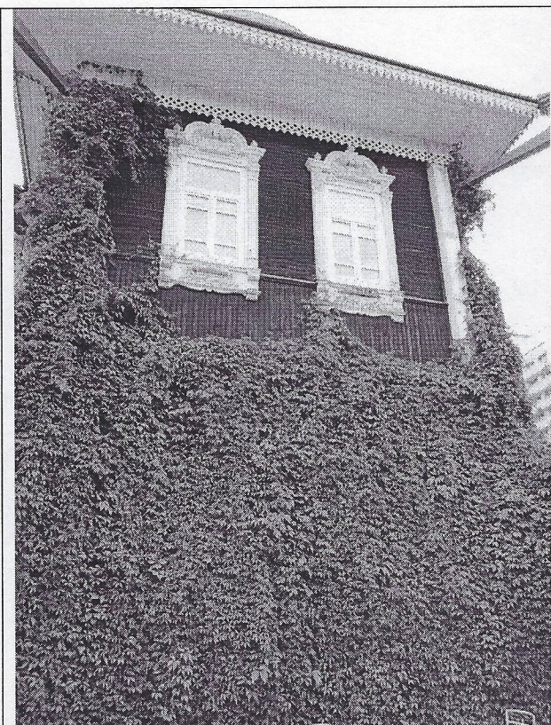
Фото 6. Правая часть южного фасада.
