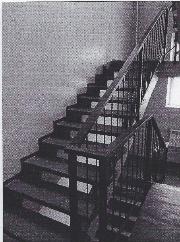
Фото 24. Лестница запасного входа.
