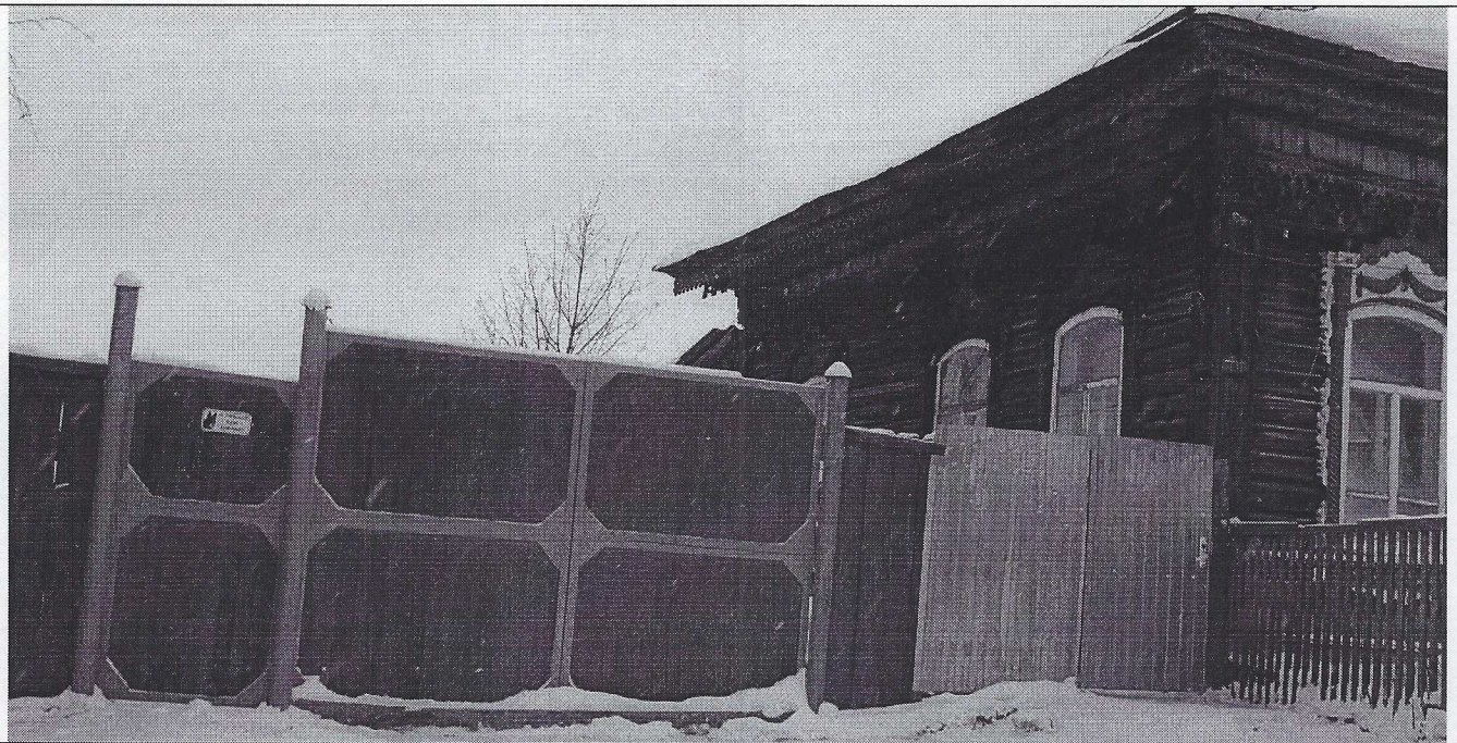
3. Фрагмент южного фасада.
