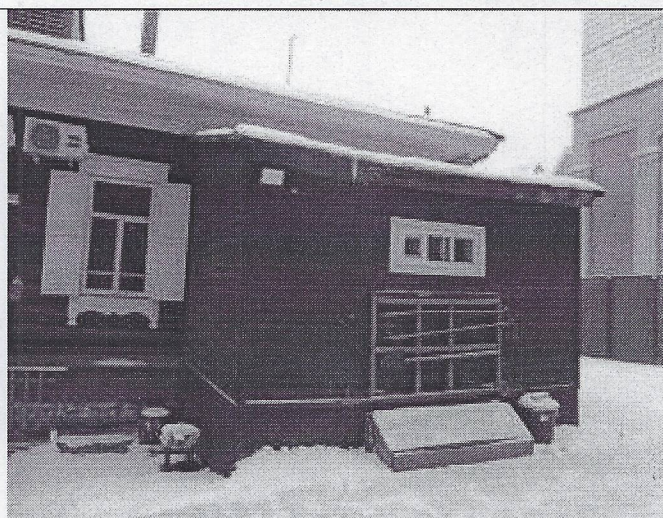
Фото 9. Восточные сени, вид с южной стороны
