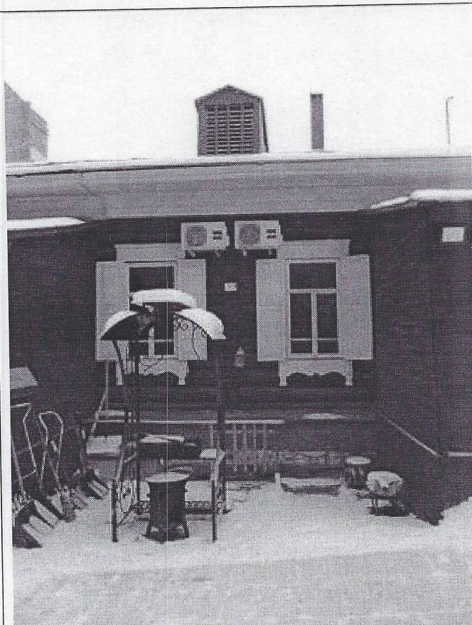
Фото 5. Фрагмент южного фасада, центральная часть
