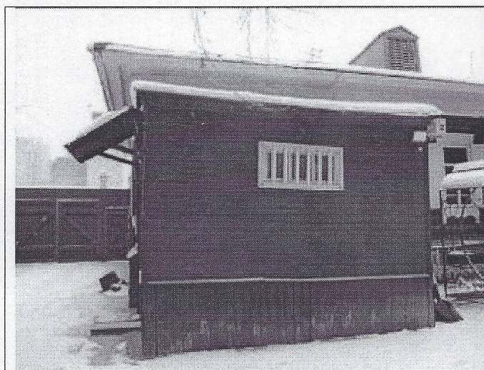
Фото 8. Западные сени, вид с южной стороны
