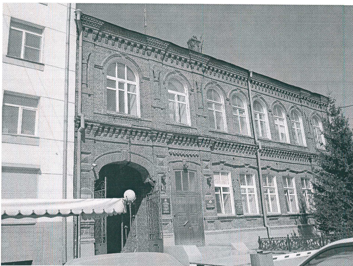
Фото 1. Южный (главный) фасад.
