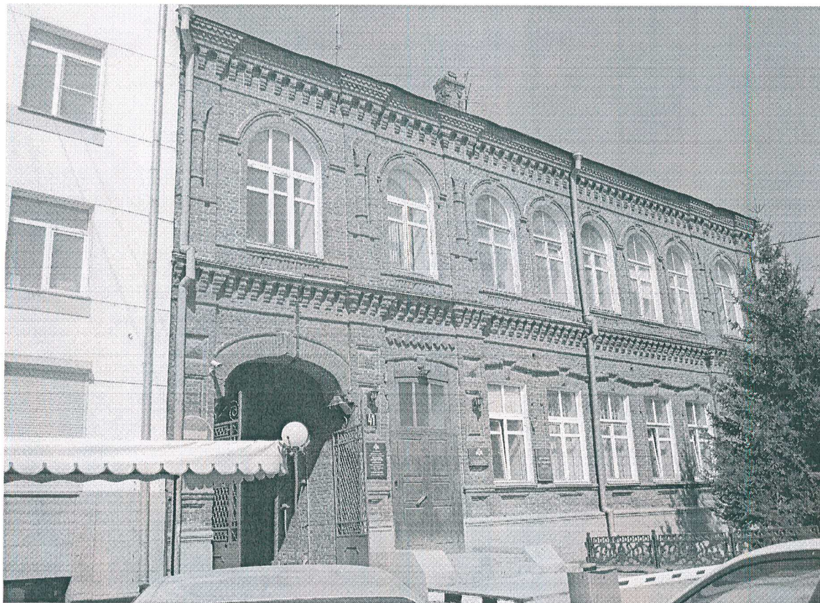
1. Южный (главный) фасад.
