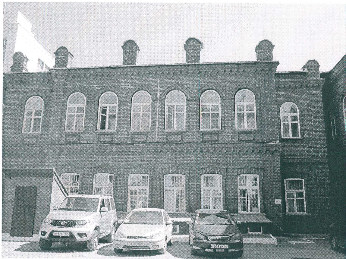
4. Правая часть западного фасада.
