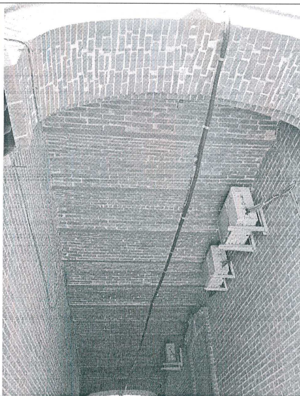
8. Сводчатое перекрытие арки-проезда.
