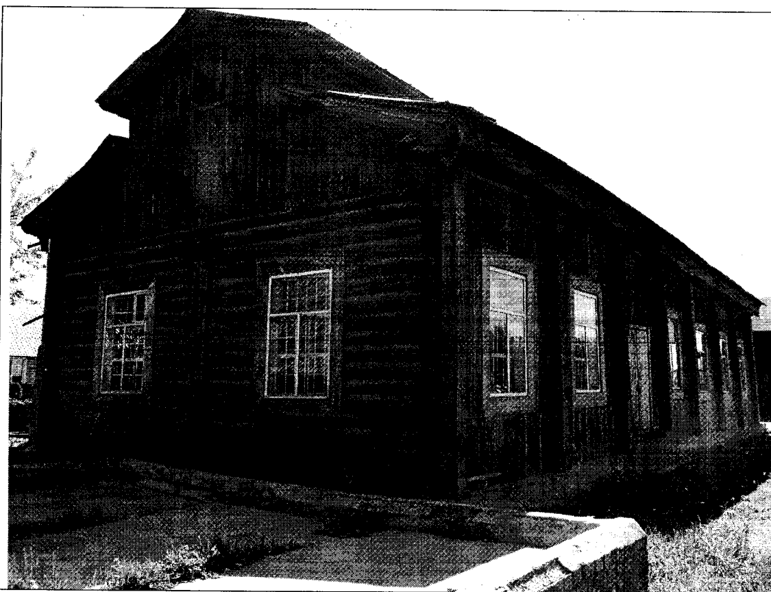
13. Восточный и северный фасады до пожара (фото 2016 года).
