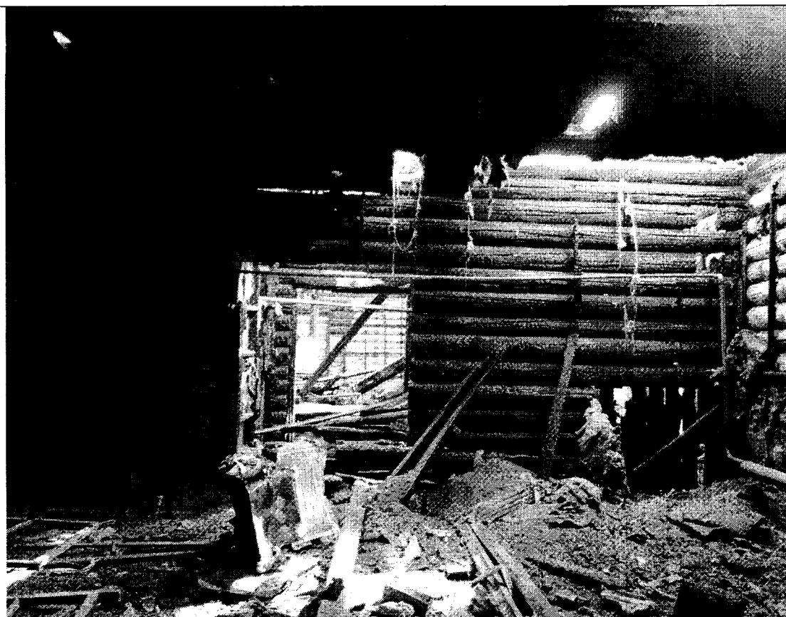
7. Вид помещений с сохранившимся перекрытием в западной части здания.
