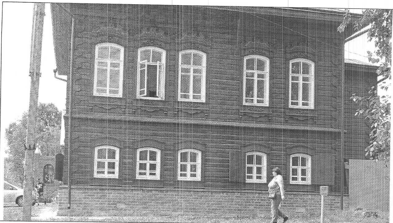
Фото 1. Восточный (уличный) фасад.
