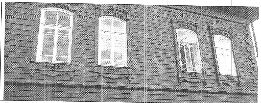
Фото 6. Окна на втором этаже.
