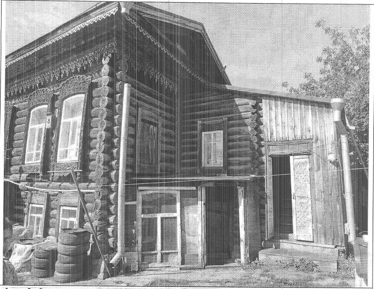
Фото 3. Фрагмент северного фасада.
