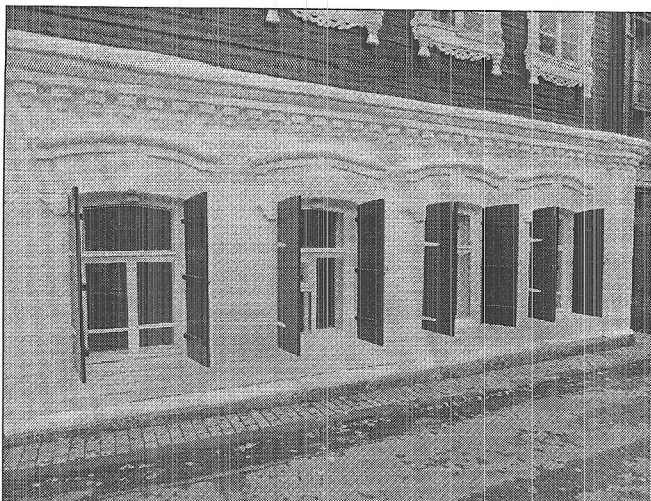
Фото 8. Фрагмент главного северного фасада.
