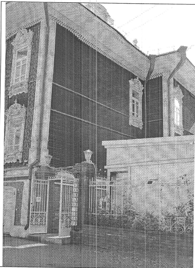
Фото 3. Левая часть западного фасада.
