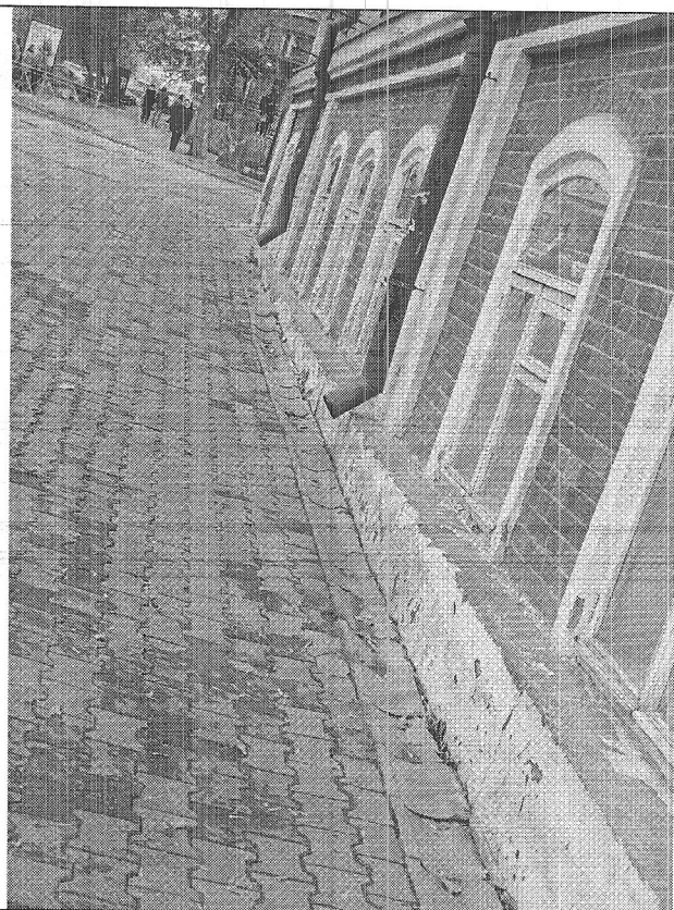
Фото 8. Выступающая на поверхность часть фундамента на северном (главном) фасаде. Отмостка.
