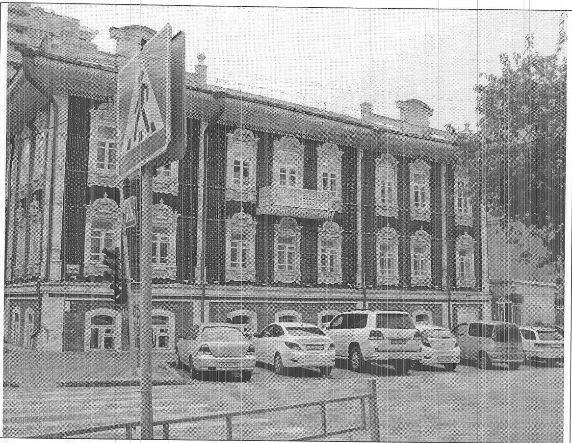
Фото 1. Северный (главный) фасад.
