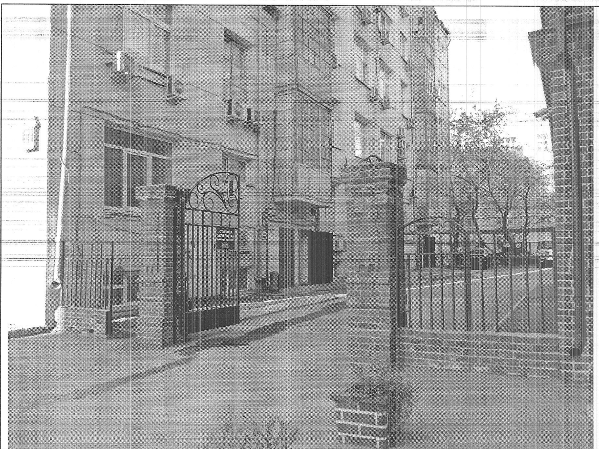
15. Ограждение со стороны главного (южного) фасада.
