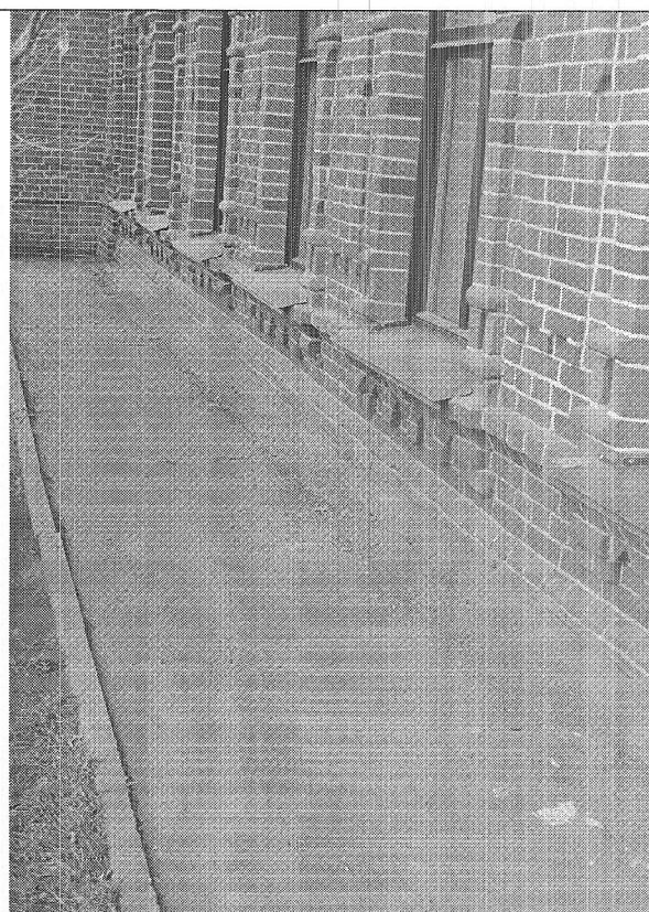
4. Вид отмостки и цоколя со стороны южного (главного) фасада.
