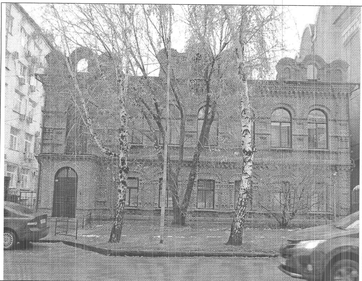
1. Южный (главный) фасад.
