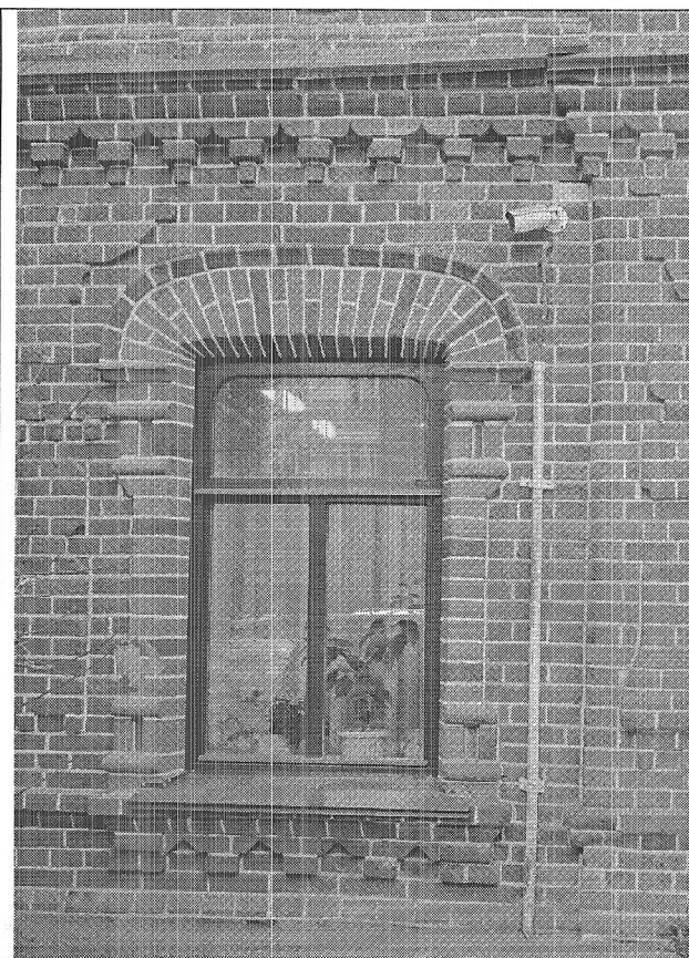
6. Декоративное оформление окна первого этажа и междуэтажного пояса главного (южного) фасада.
