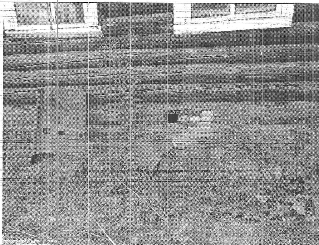
Фото 18. Вентиляционная отдушина.
