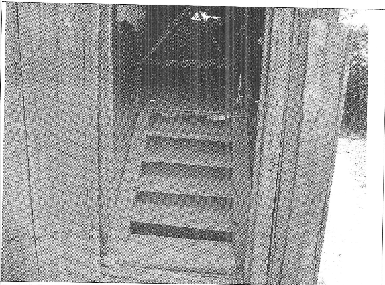
Фото 13. Крыльцо в сенях на южном фасаде.
