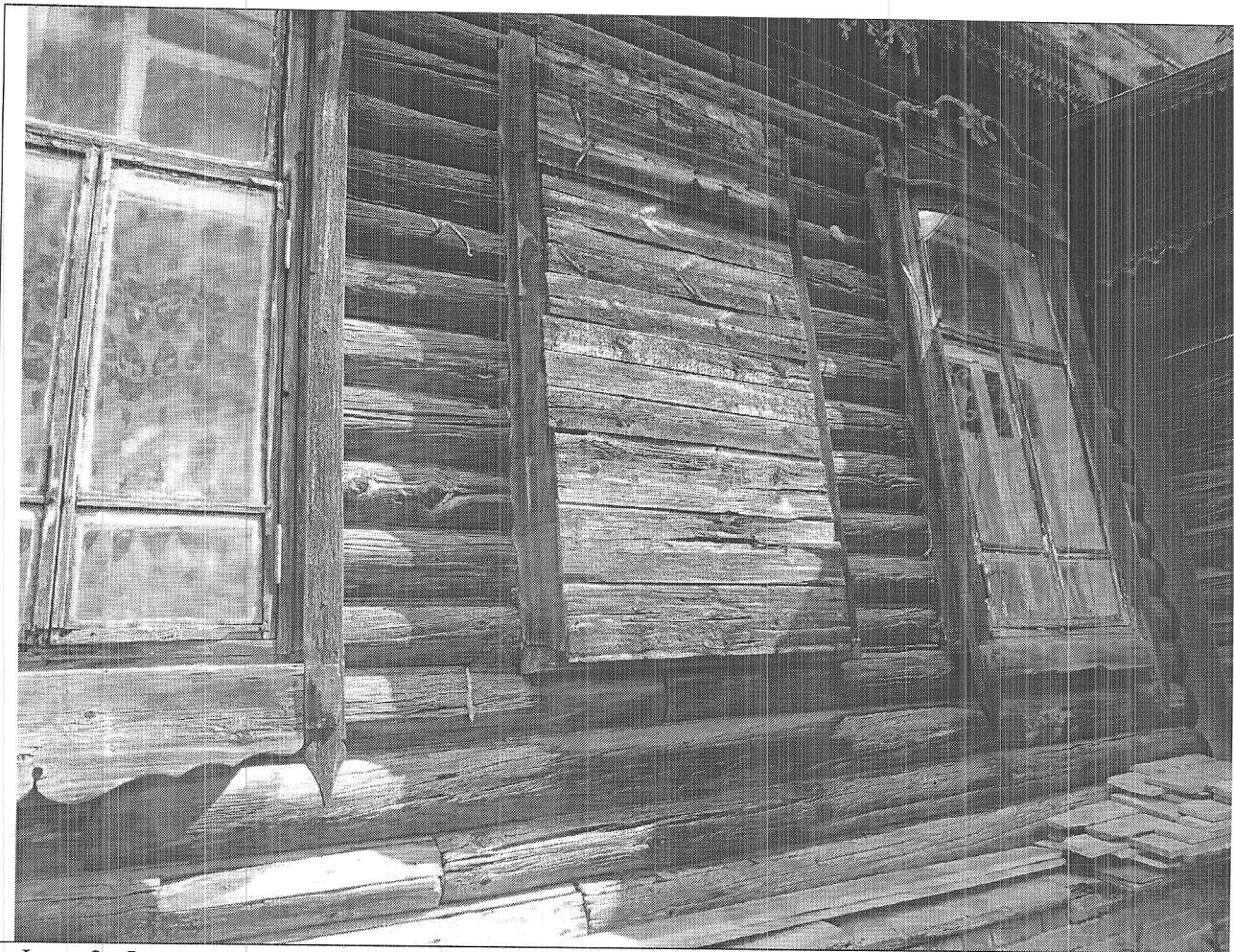
Фото 3. Фрагмент южного фасада.
