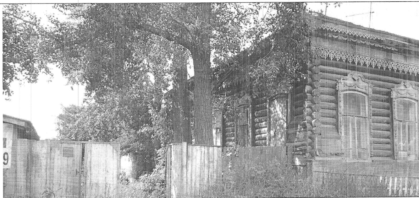
Фото 7. Фрагмент северного и восточного фасадов.
