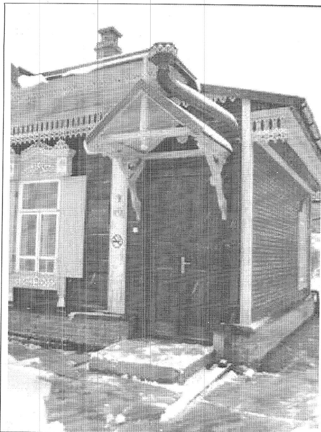
Фото 3. Главный входной узел на южном фасаде
