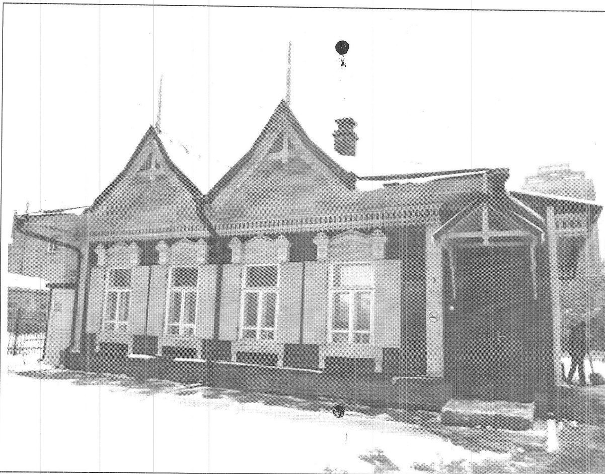
Фото 1. Южный главный фасад
