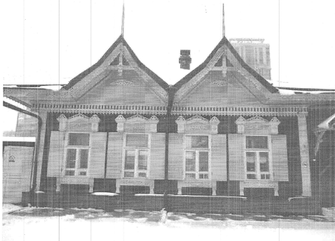
Фото 2. Фрагмент южного фасада
