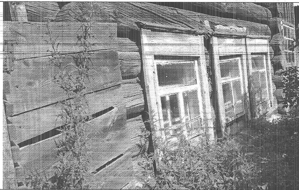
Фото 7. Окна на южном фасаде в цокольном этаже.
