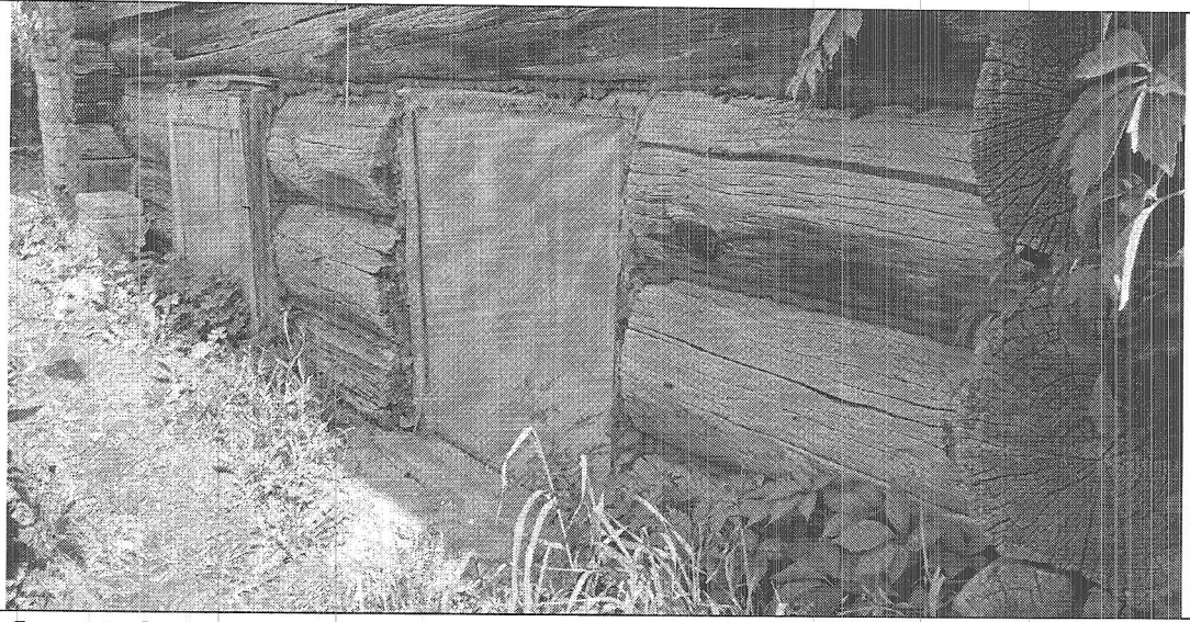
Фото 5. Окна западного фасада в цокольном этаже.
