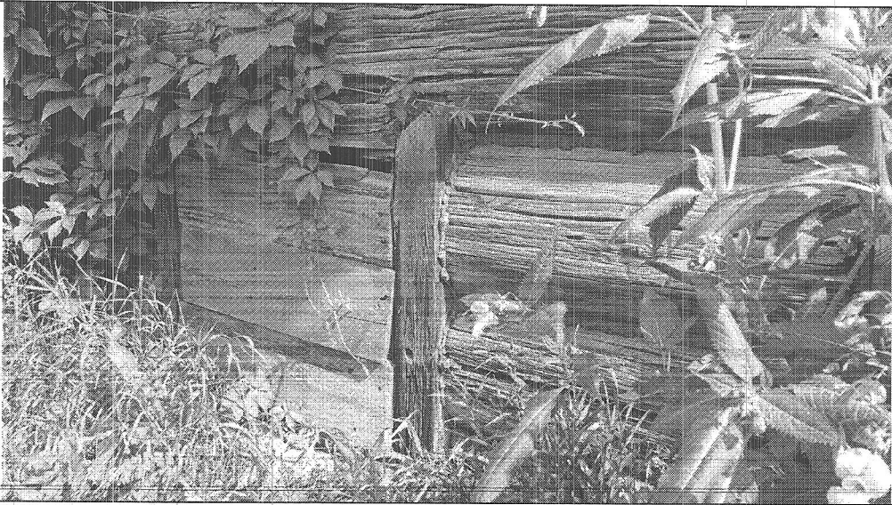
Фото 6. Зашитое окно на западном фасаде в цокольном этаже.
