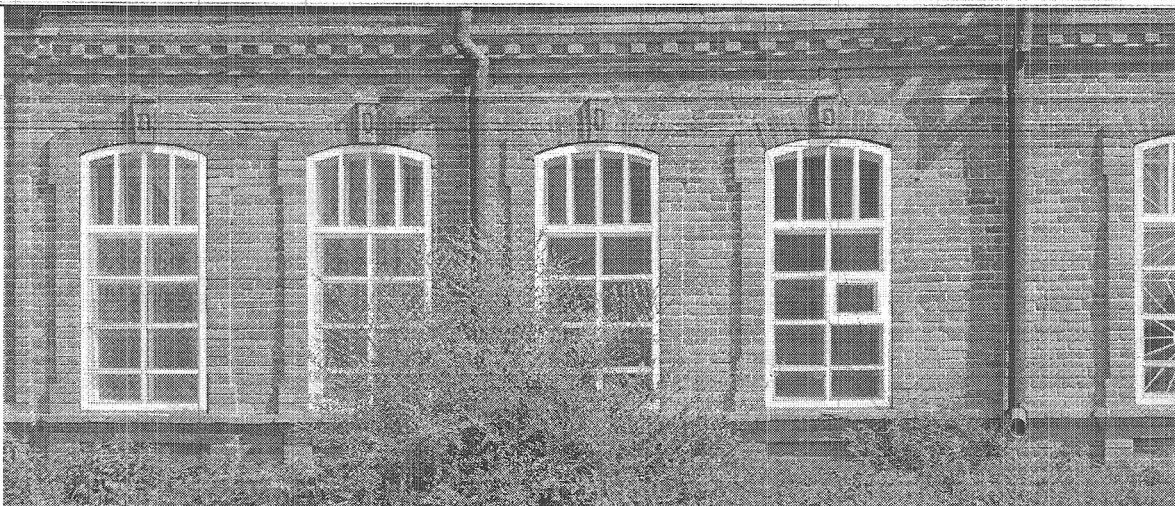
Фото 8. Окна первого этажа.
