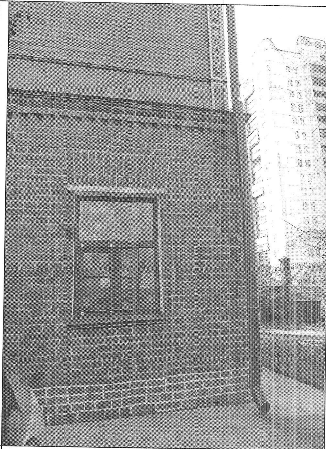
Фото 10. Фрагмент дворового (северо-восточного) фасада.
