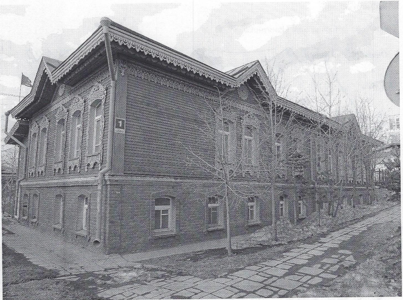
1. Общий вид с ул. Большевистская.
