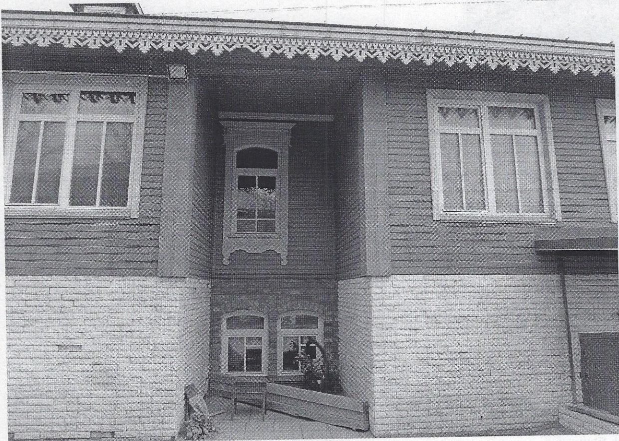
12. Фрагмент дворового фасада.
