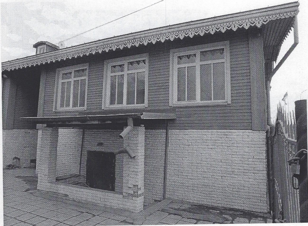
11. Фрагмент дворового фасада.
