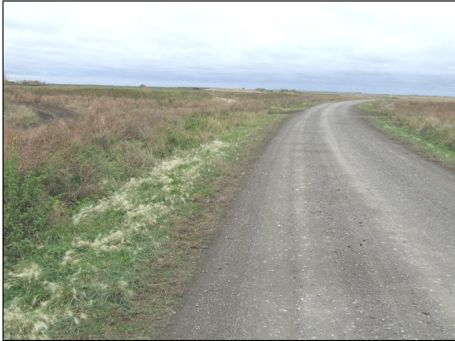
Рисунок 23. ФОТО. Реконструкция автомобильной дороги "Кушаги - Мураши" в Усть-Таркском районе Новосибирской области. Участок отвода земель под автодорогу. Вид с Ю с точки 018 (придорожная полоса с сильно изрытым рельефом).
