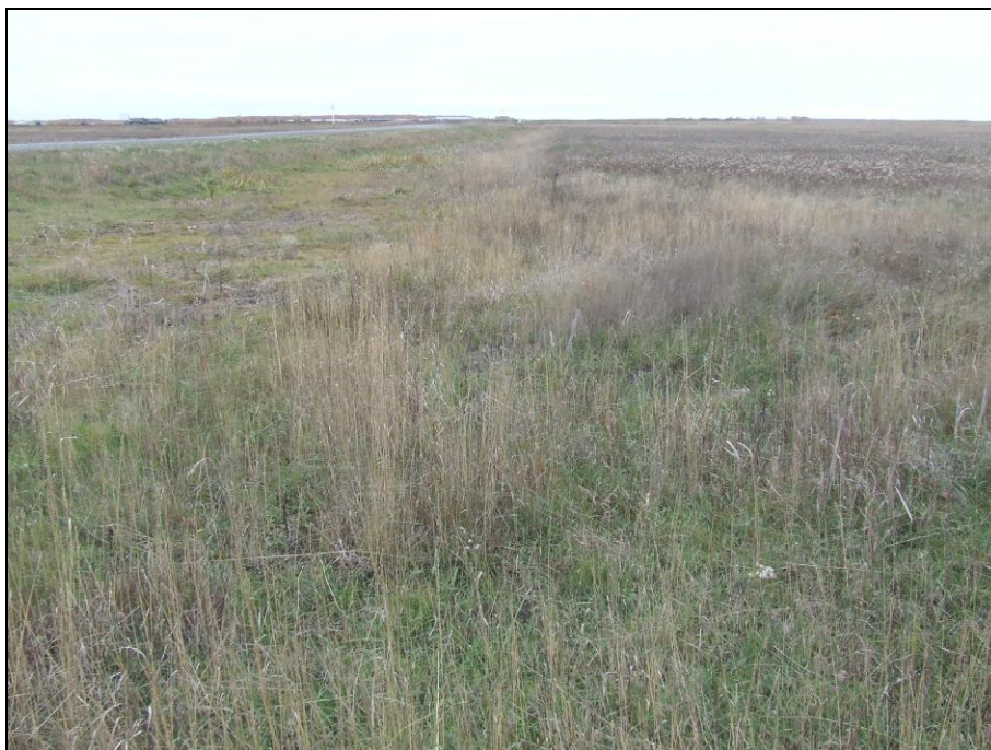
Рисунок 4. ФОТО. Реконструкция автомобильной дороги "Кушаги - Мураши" в Усть-Тарском районе Новосибирской области. Участок отвода земель под автодорогу справа. Вид с ЮВ с точки 003.
