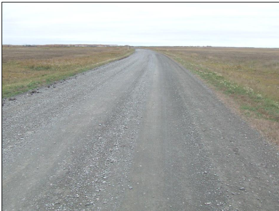
Рисунок 3. ФОТО. Реконструкция автомобильной дороги "Кушаги - Мураши" в Усть-Тарском районе Новосибирской области. Участок отвода земель под автодорогу. Общий вид с ЮВ с точки 002.
