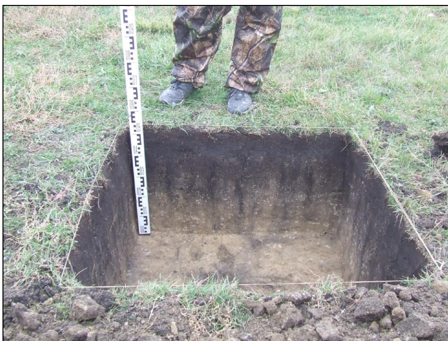
Рисунок 30. ФОТО. Реконструкция автомобильной дороги "Кушаги - Мураши" в Усть-Тарском районе Новосибирской области. Разведочное вскрытие (шурф) № 2. Вид с Ю.
