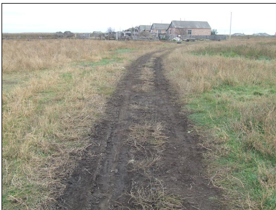
Рисунок 26. ФОТО. Реконструкция автомобильной дороги "Кушаги - Мураши" в Усть-Таркском районе Новосибирской области. Участок строительной площадки (подъезд к усадьбе в с. Мураши). Вид с ЗСЗ с точки 021.
