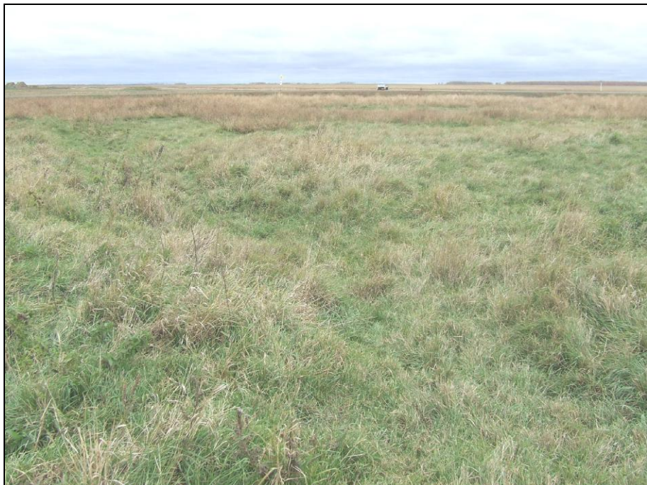
Рисунок 24. ФОТО. Реконструкция автомобильной дороги "Кушаги - Мураши" в Усть-Таркском районе Новосибирской области. Участок строительной площадки с сильно изрытым рельефом. Вид с Ю с точки 019.
