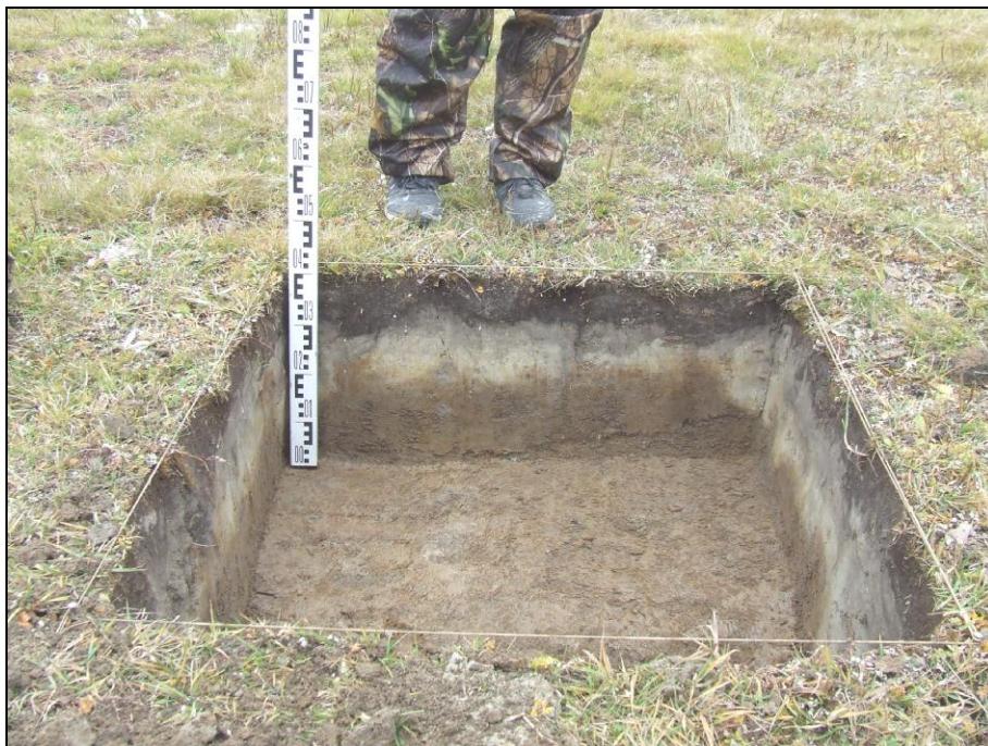
Рисунок 35. ФОТО. Реконструкция автомобильной дороги "Кушаги - Мураши" в Усть-Таркском районе Новосибирской области. Разведочное вскрытие (шурф) № 3. Вид с Ю.
