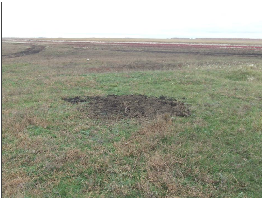
Рисунок 31. ФОТО. Реконструкция автомобильной дороги "Кушаги - Мураши" в Усть-Тарском районе Новосибирской области. Разведочное вскрытие (шурф) № 2. Рекультивация. Вид с Ю.
