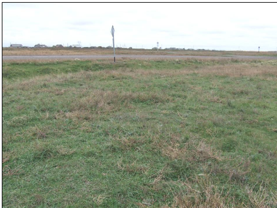
Рисунок 20. ФОТО. Реконструкция автомобильной дороги "Кушаги - Мураши" в Усть-Таркском районе Новосибирской области. Участок отвода земель под автодорогу. Вид с СВ с точки 015 на участок перехода трассы проектируемой реконструкции автодороги через существующую автодорогу.
