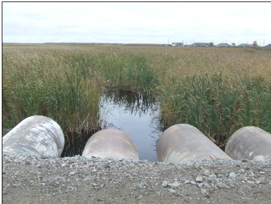
Рисунок 14. ФОТО. Реконструкция автомобильной дороги "Кушаги - Мураши" в Усть-Тарском районе Новосибирской области. Участок отвода земель под автодорогу. Вид с ССВ с точки 009 на участок отвода земель для расчистки русла реки Тарки ниже автодороги по течению.
