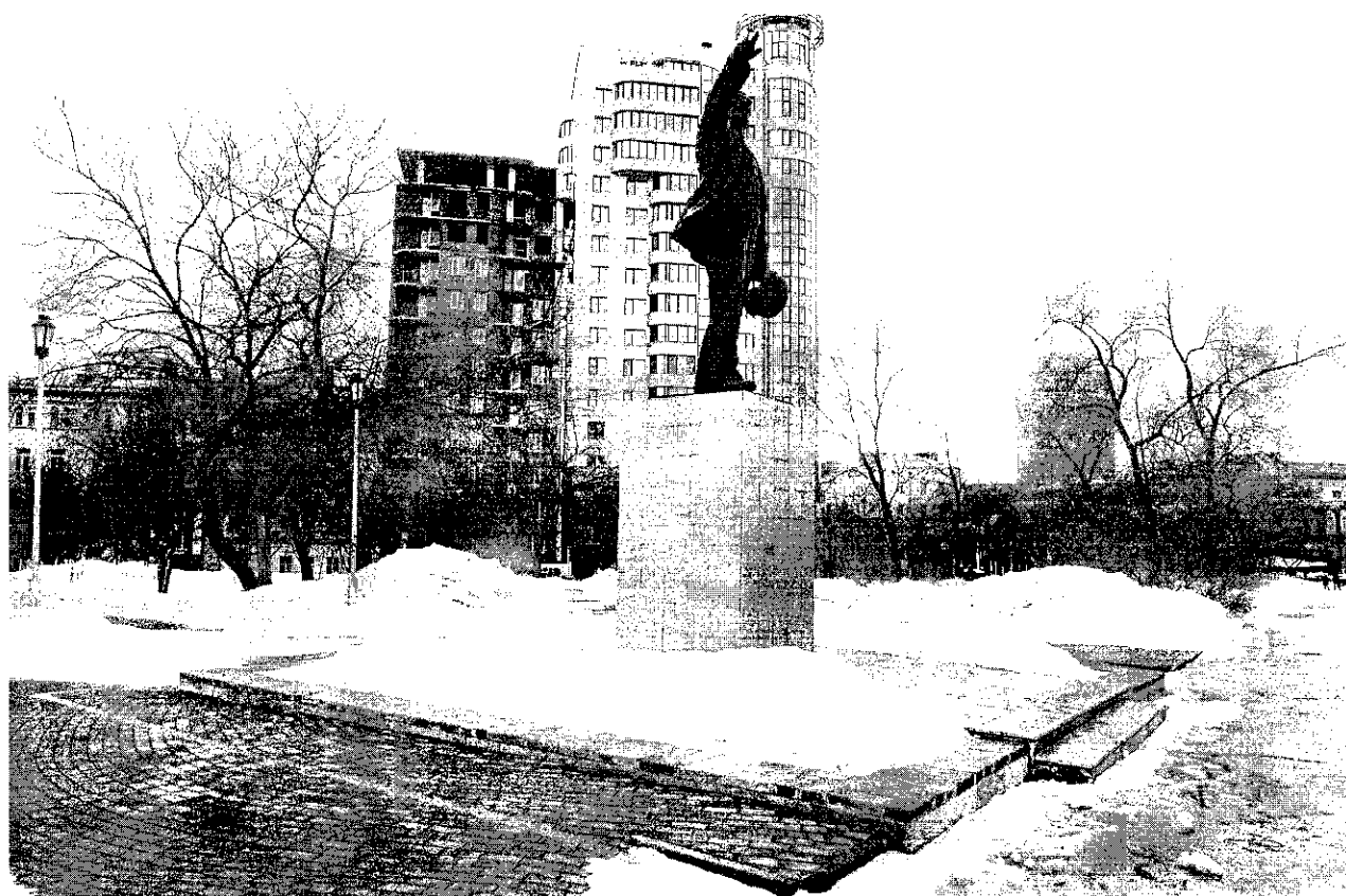
2. Общий вид с востока.
