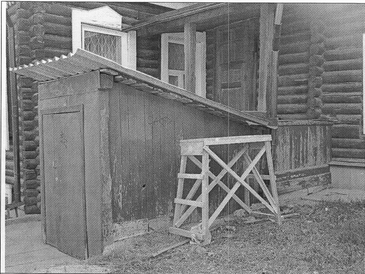
5. Спуск в подвал со стороны восточного фасада.
