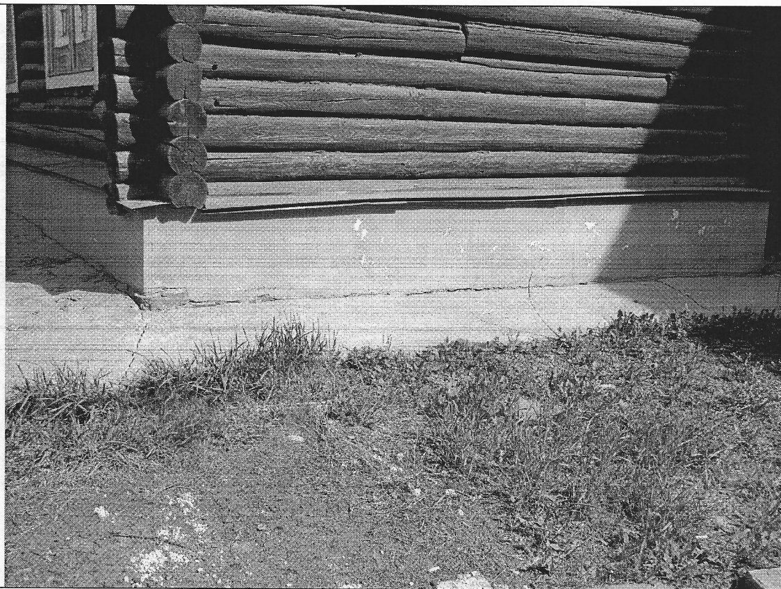
9. Цоколь и отмостка западного и северного фасадов.
