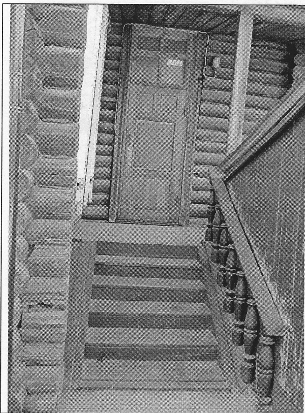
16. Вход в здание на восточном фасаде.
