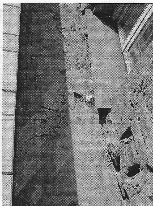
7. Состояние отмостки (днища приямка).
