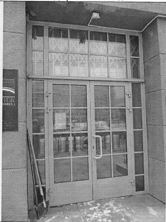
10. Дверь главного входа
