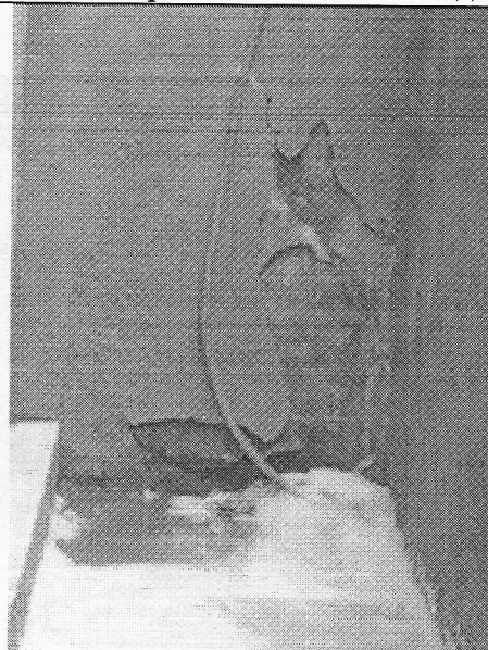
21. Участок отпадения штукатурного слоя на стенке крыльца главного входа
