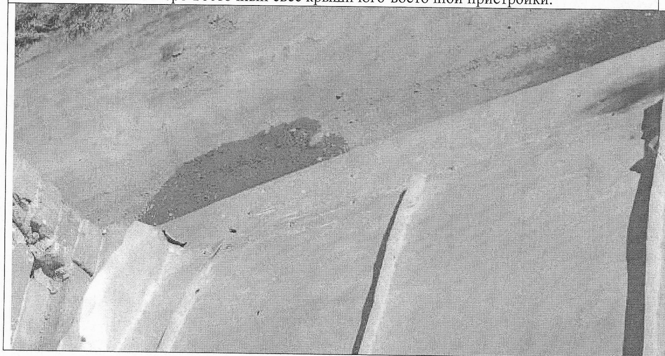
26. Северо-восточный свес крыши юго-восточной пристройки.
