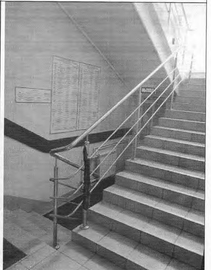
28. Северная лестничная клетка
