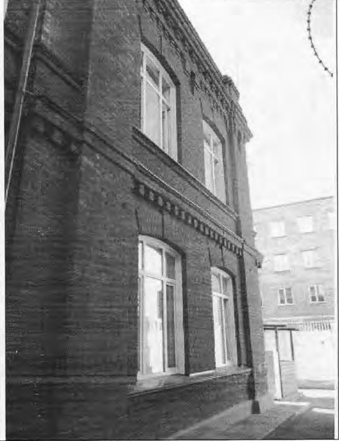
10. Северный ризалит северо-восточного фасада
