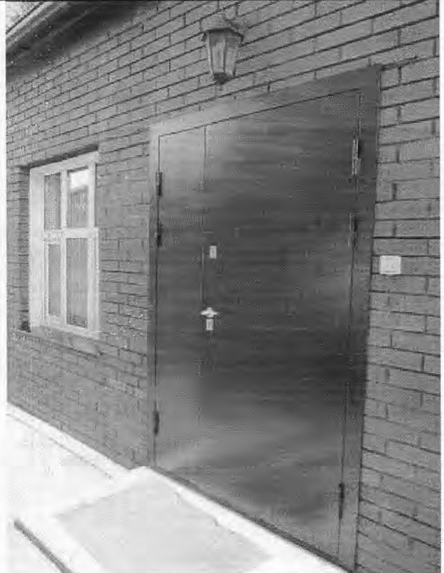
12. Входная дверь на северо-западном фасаде (в пристройке)
