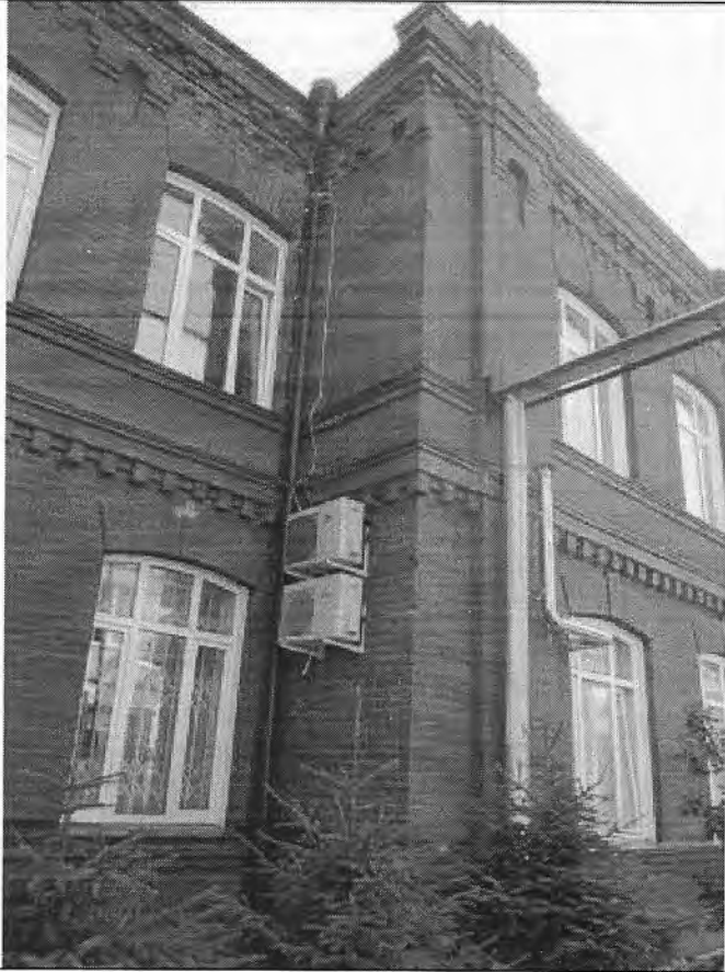
6. Фрагмент юго-западного фасада
