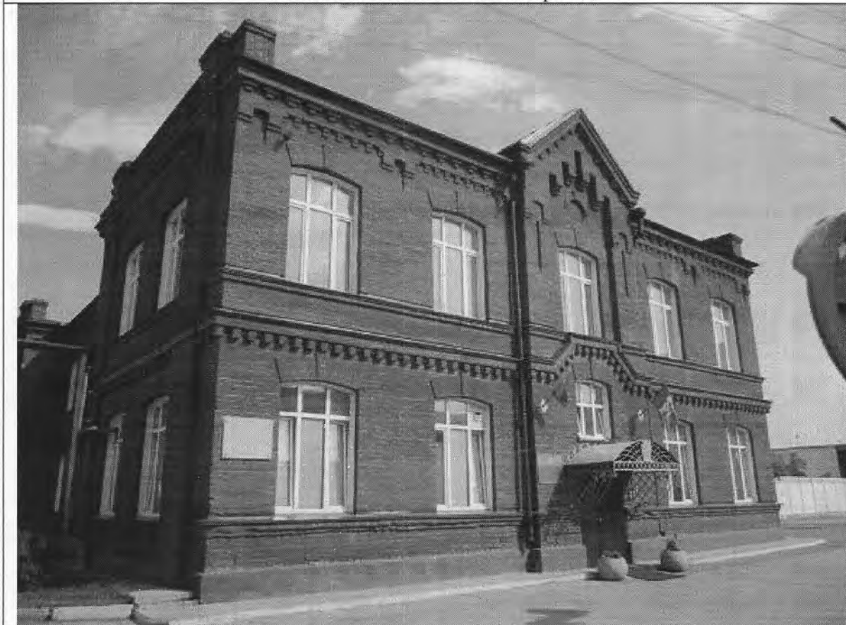
1. Главный юго-восточный фасад
