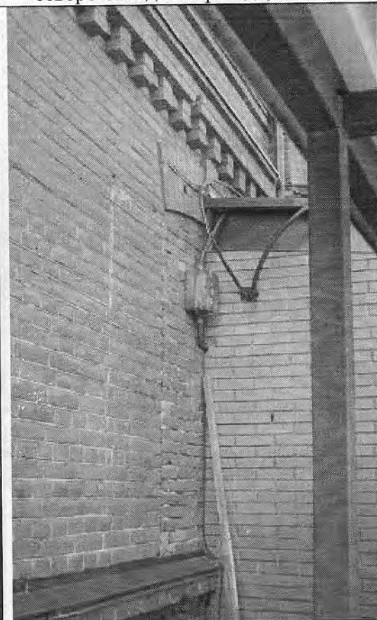
32. Заложенный оконный проем на северо-западном фасаде, 1 этаж
