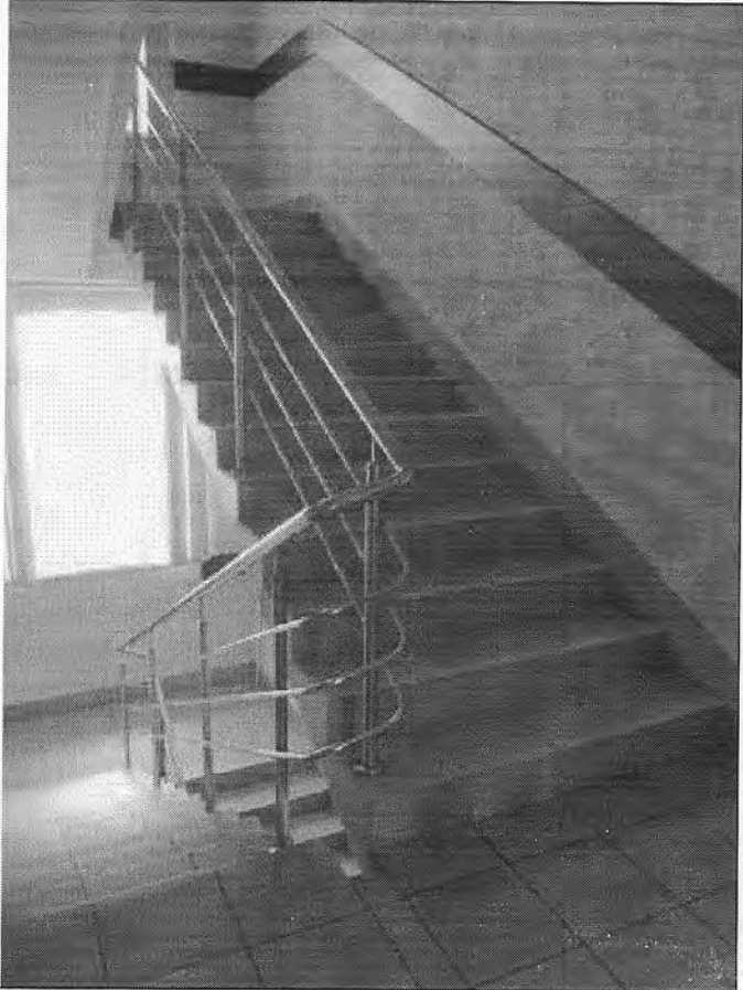
27. Южная лестничная клетка (на главном входе)
