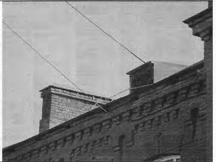
16. Слуховое окно и оголовок шахты дымоудаления на юго-западном скате крыши
