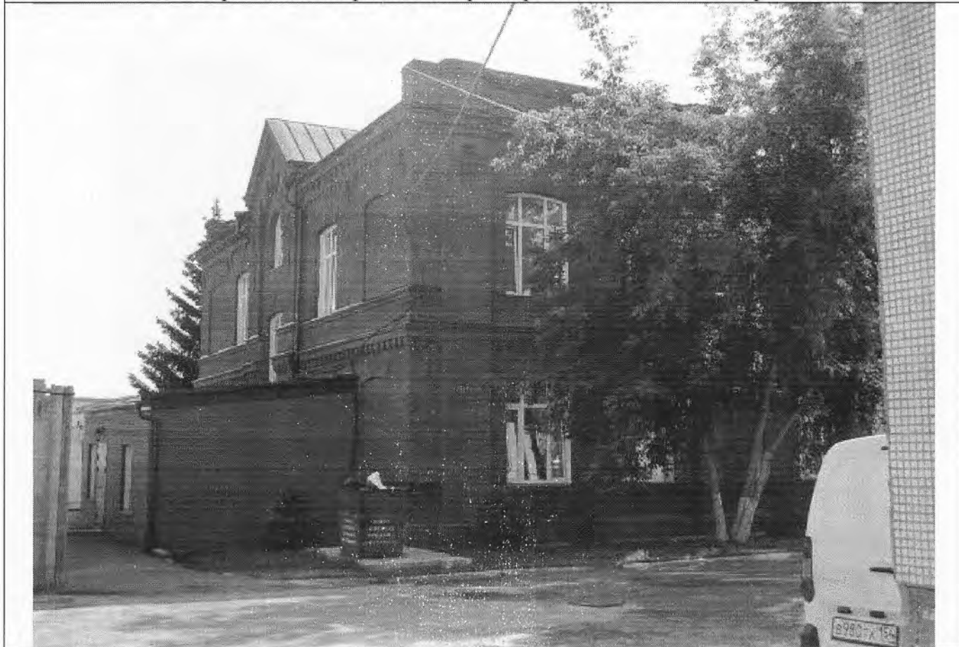
2. Северо-западный фасад и северный ризалит юго-западного фасада
