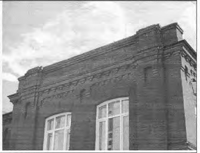
14. Фрагмент ризалита юго-западного фасада
