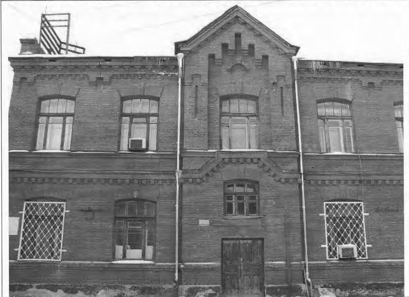
33. Фрагмент юго-восточного фасада с первоначальными окнами, фото из архива НПЦ, 2009 г.
