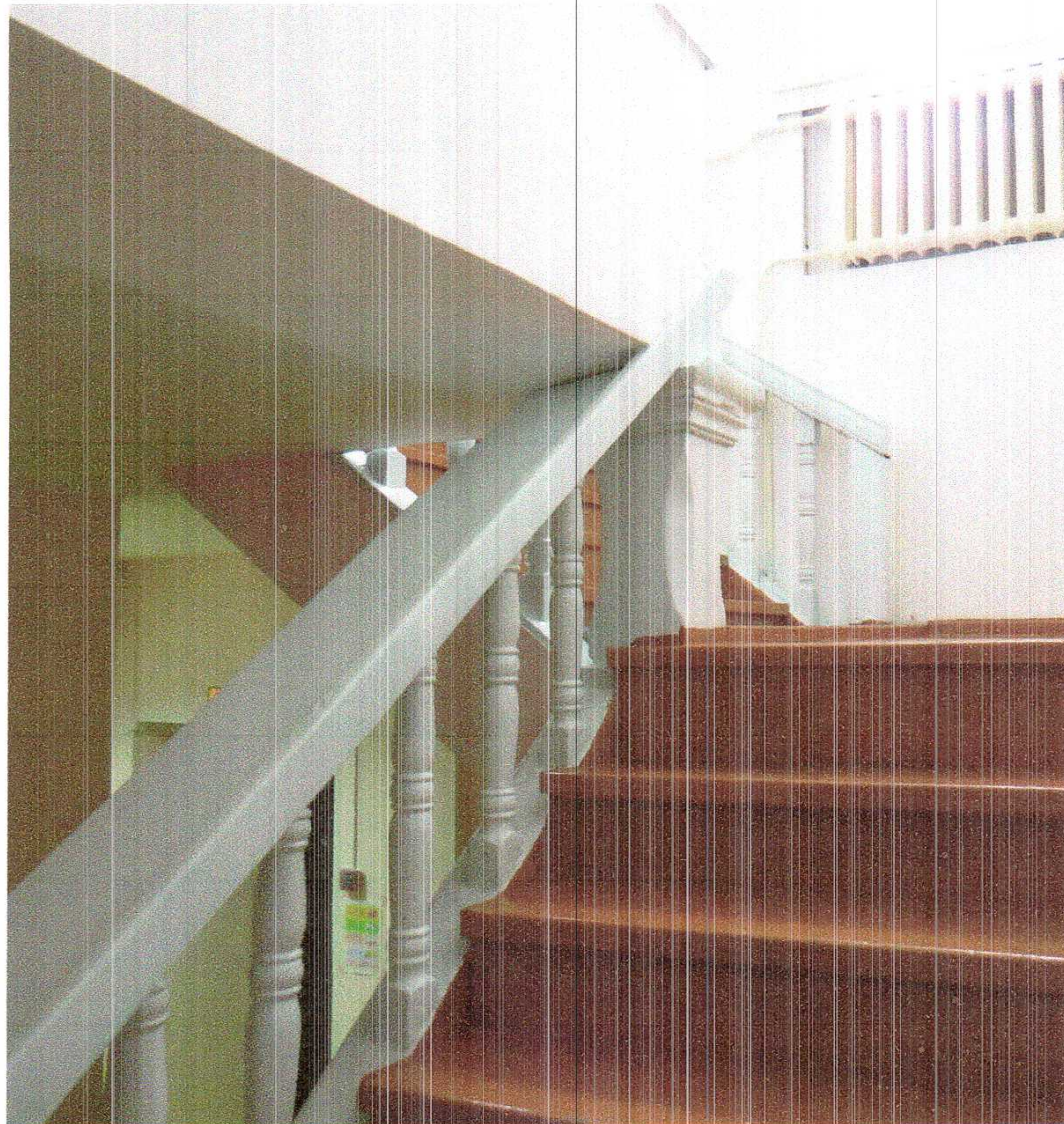
Рис. 19. Балясины ограждения и архитектурно оформленное завершение столба-опоры. Фото 2018 г.
