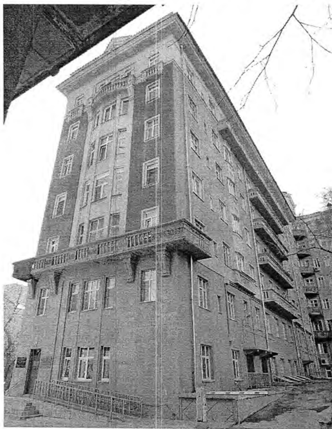
6. Вид южного крыла со двора.
