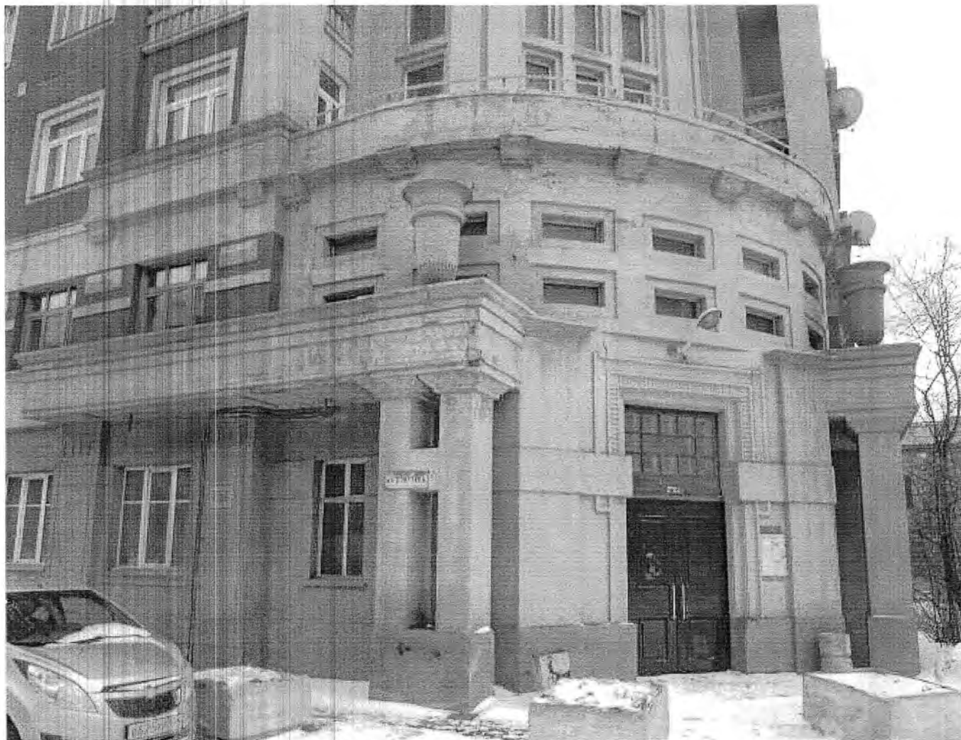
36. Фрагмент углового (северного) ризалита.
