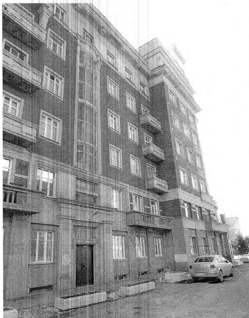
39. Фрагмент северного бокового фасада.
