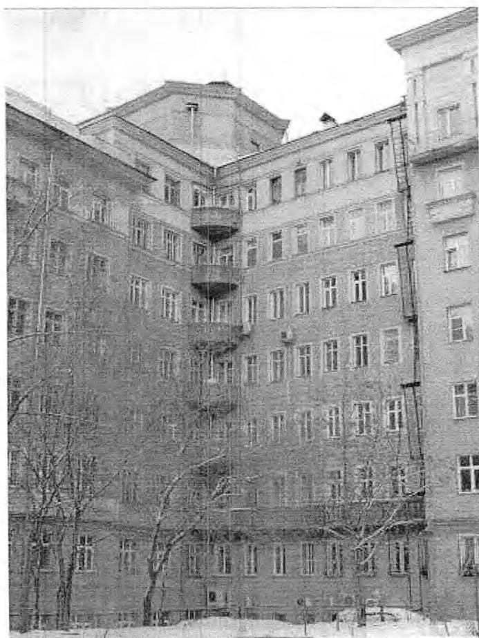
11. Северо-восточный угол дворовых фасадов.
