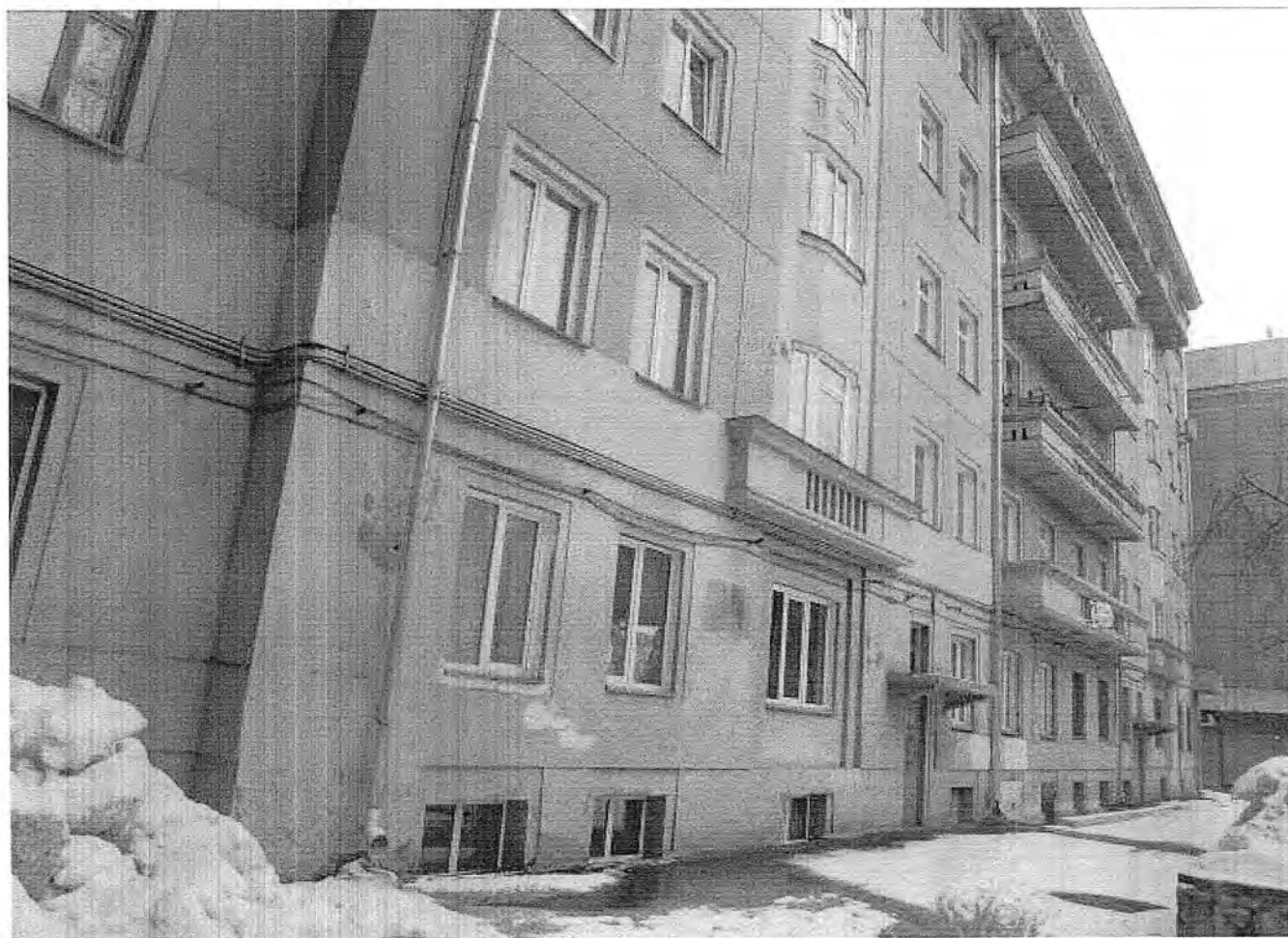
22. Фрагмент южноо (дворового) фасада северного крыла.
