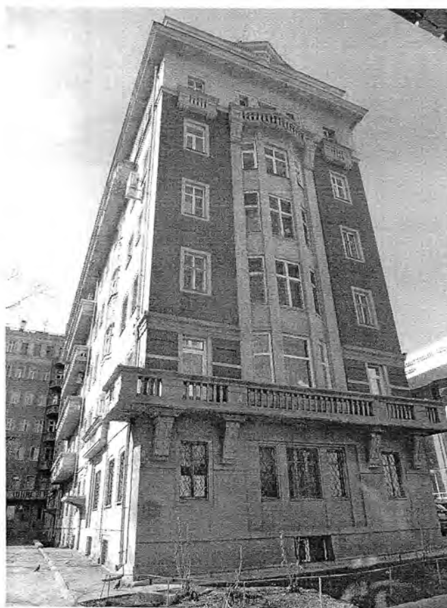
7. Вид северного крыла со двора.
