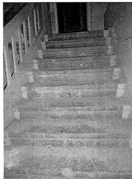
58. Гранитные ступени марша в подвале (подъезд №2).
