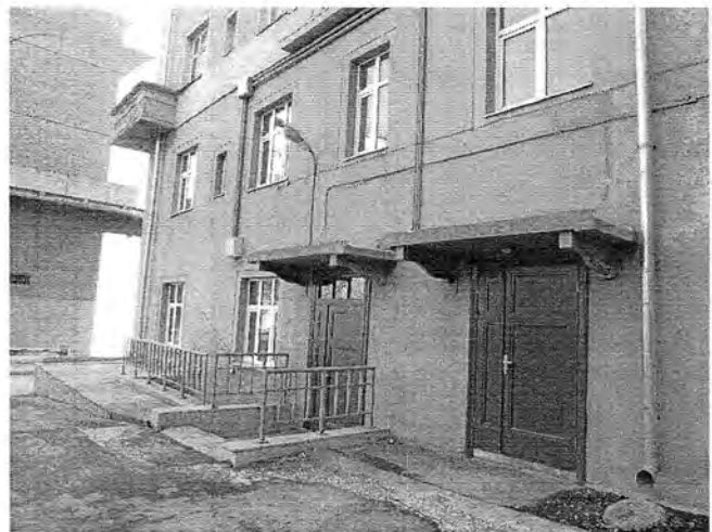
43. Входы на северном (дворовом) фасаде южного крыла.
