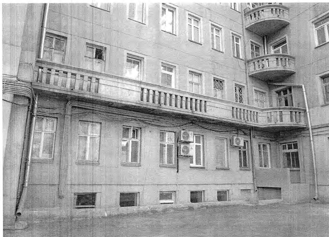
21. Фрагмент (дворового) фасада.
