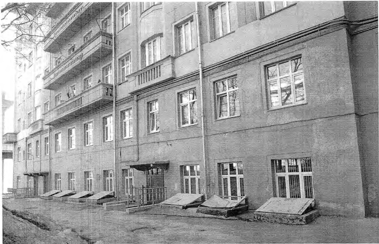
13. Фрагмент северного (дворового) фасада.
