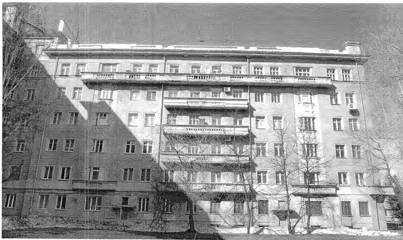
8. Южный (дворовый) фасад северного крыла.
