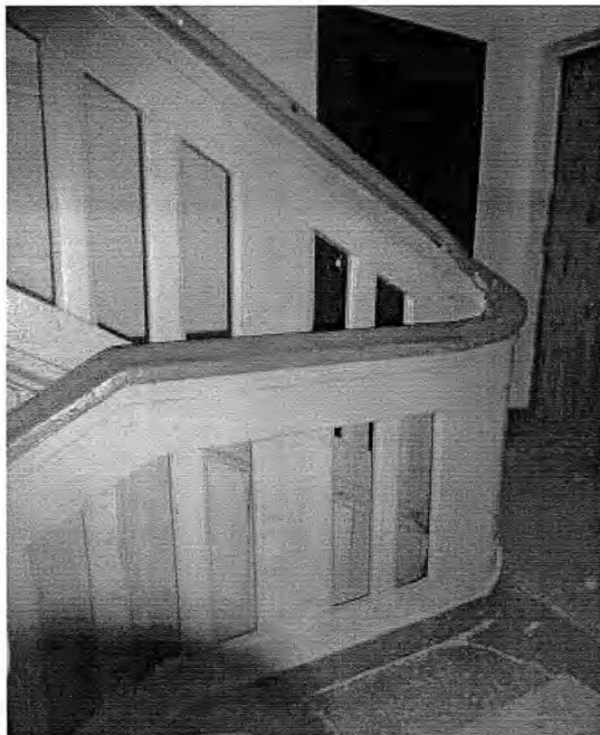
60. Фрагмент ограждения марша.
