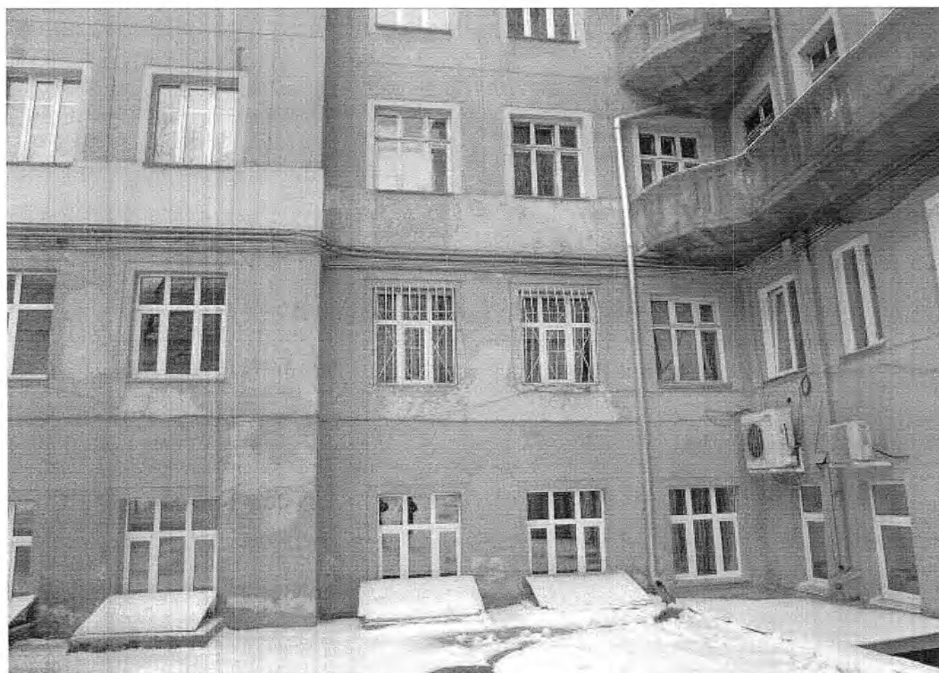
18. Фрагмент северного (дворового) фасада южного крыла.
