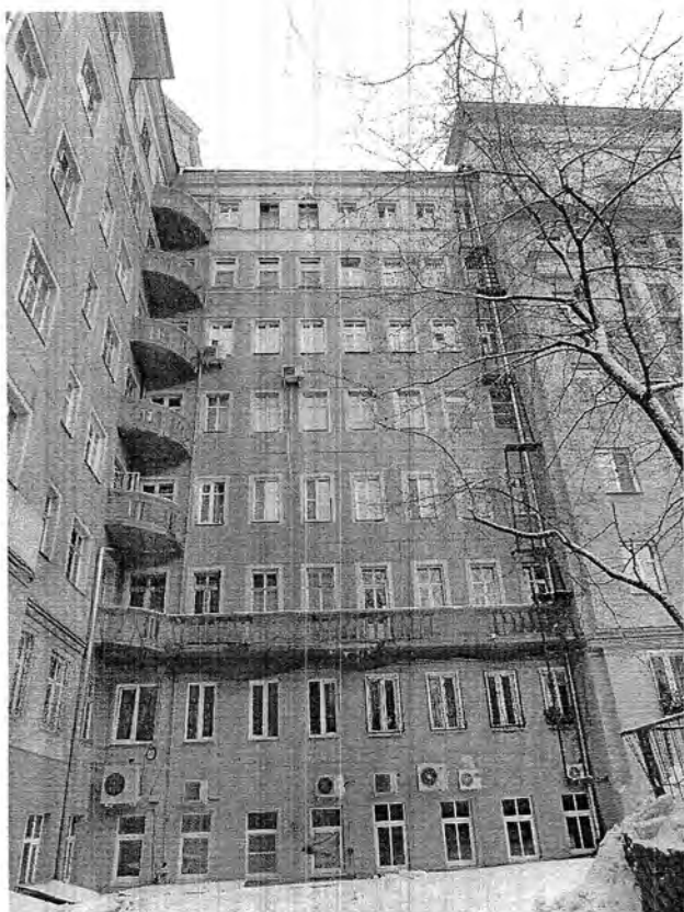
19. Фрагмент восточного фасада.
