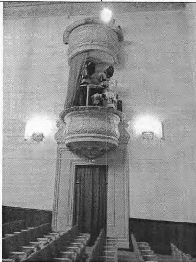
72. Балконы в зрительном зале
