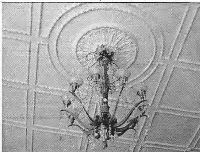
85. Люстра в объеме парадной лестничной клетки, 3 этаж
