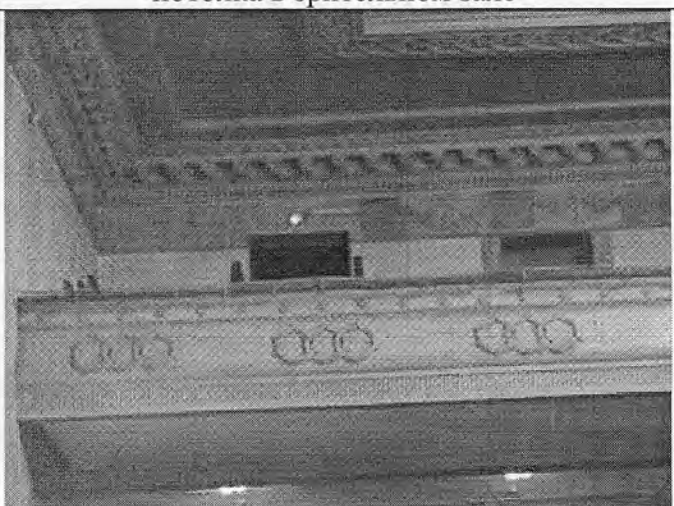
70. Декоративные элементы ограждения и потолка в зрительном зале
