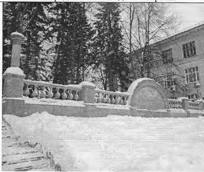
97. Ограда с юго-западной стороны
