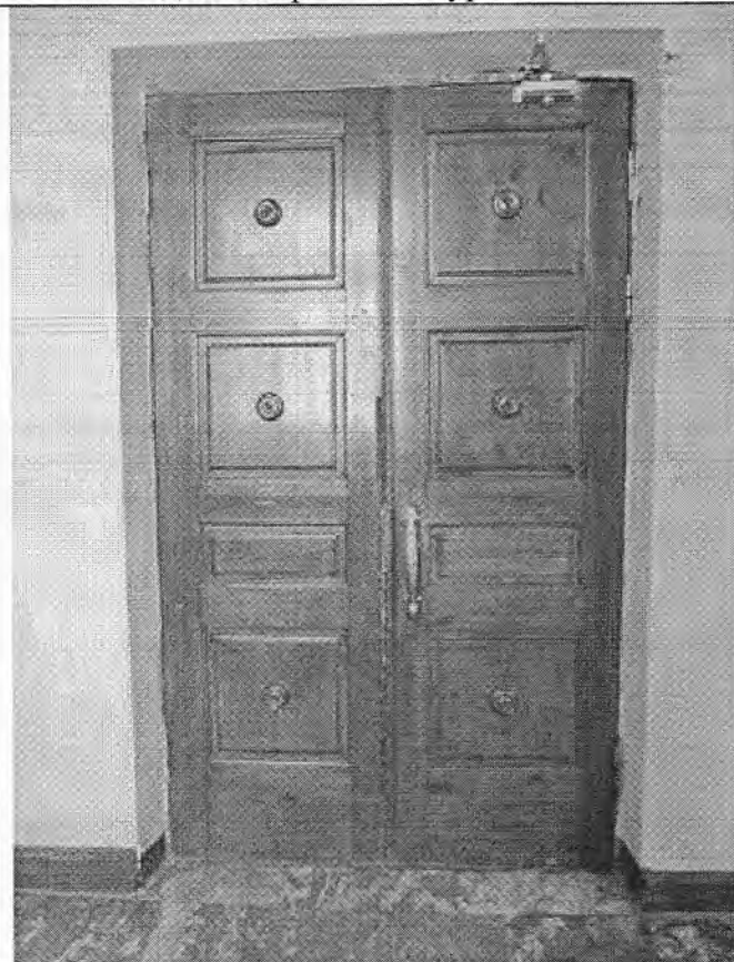
51. Входная дверь из тамбура в вестибюль
