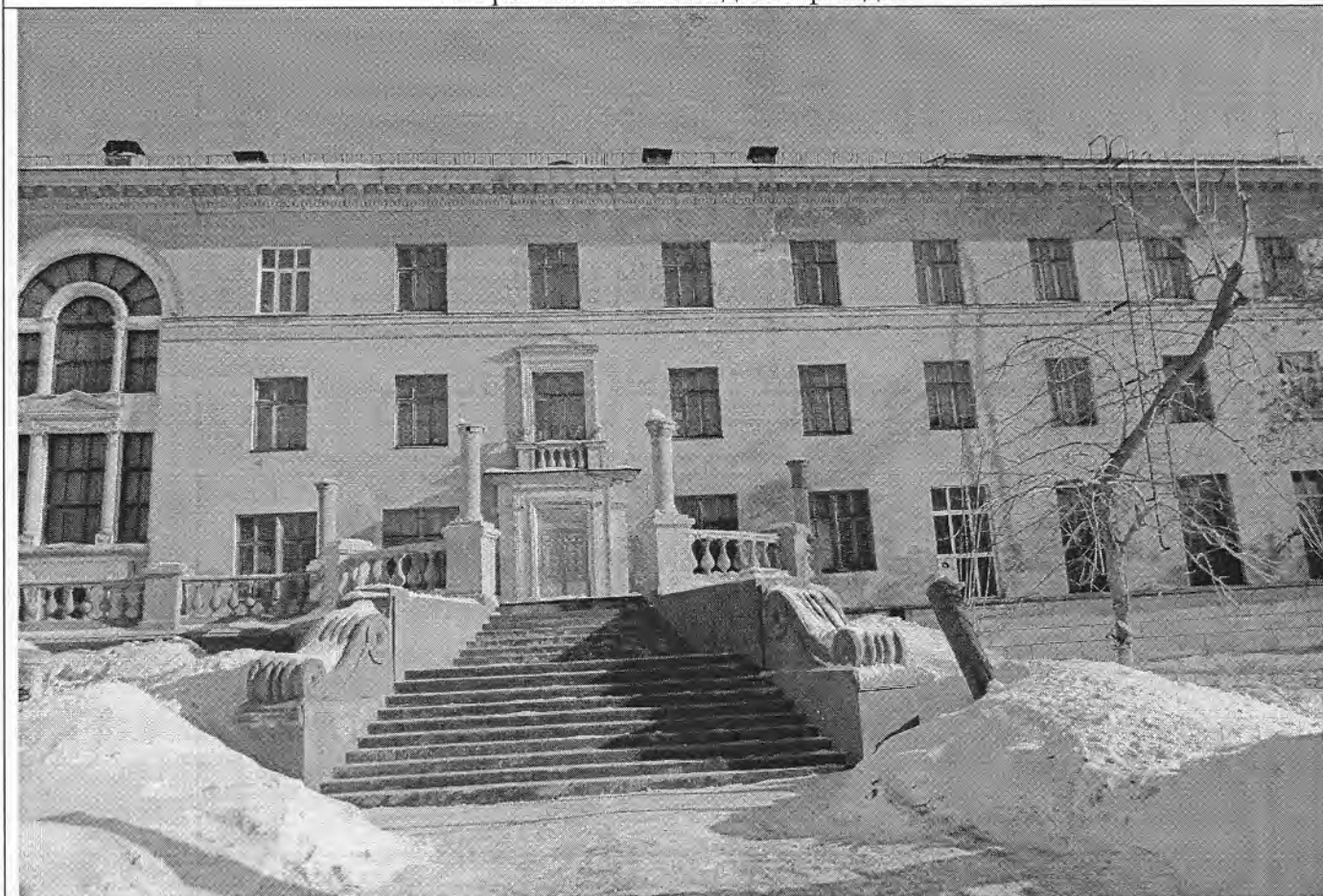
7. Фрагмент юго-западного фасада
