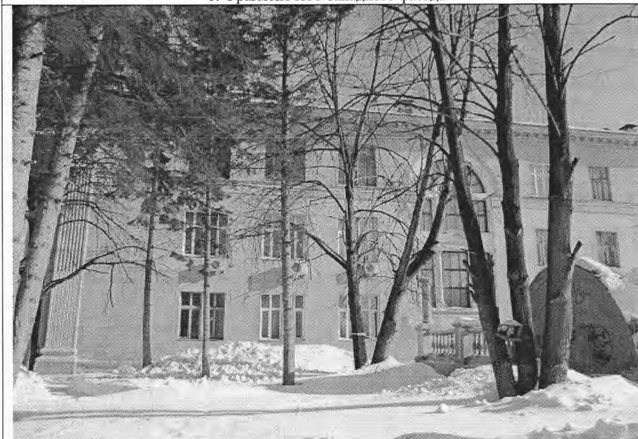
8. Фрагмент юго-западного фасада
