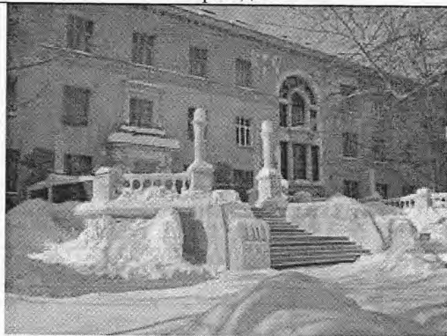
26. Крыльцо-терраса на северо-восточном фасаде
