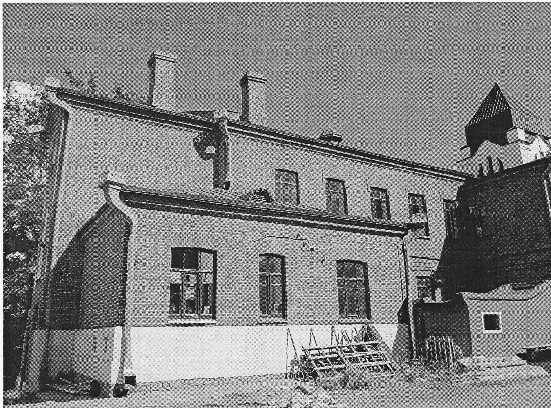
4. Левая часть юго-восточного фасада.
