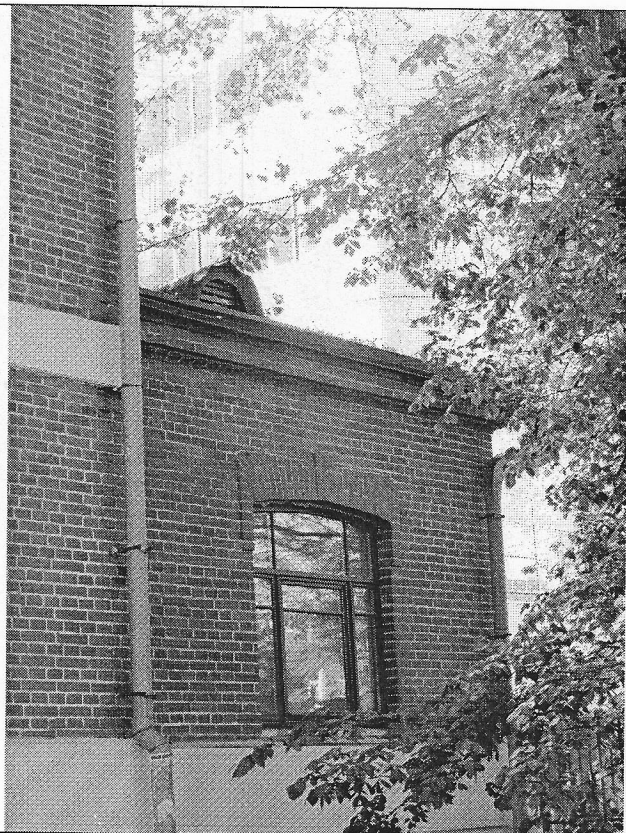
6. Северо-западный фасад (одноэтажный объём).
