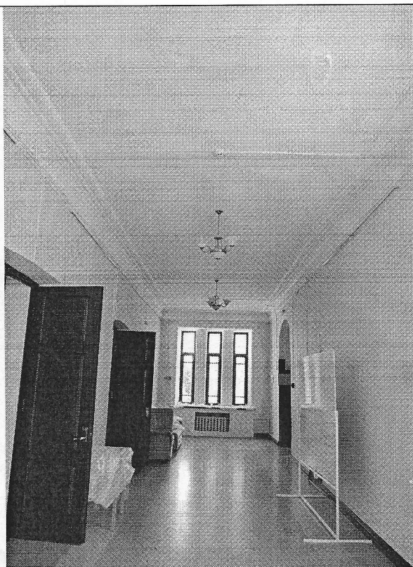
18. Интерьер помещений 2-ого этажа.
