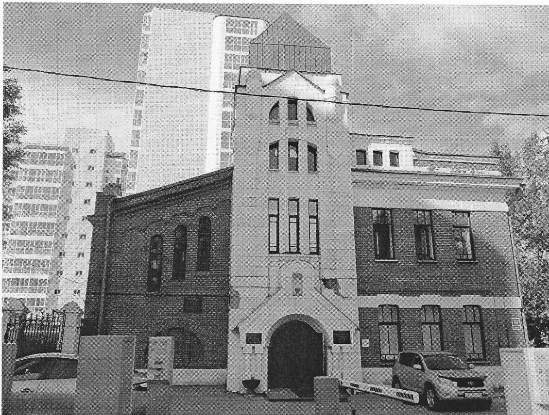
1. Северо-восточный (главный) фасад.
