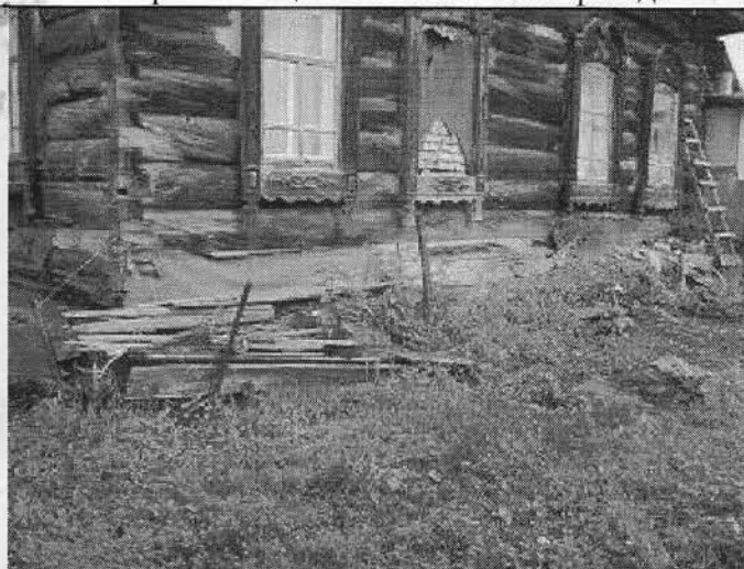
12. Фрагмент цоколя восточного фасада
