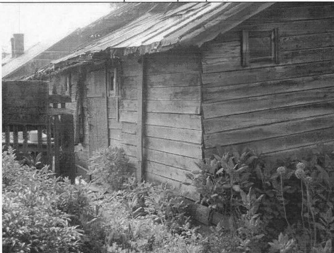
7. Фрагмент северного фасада
