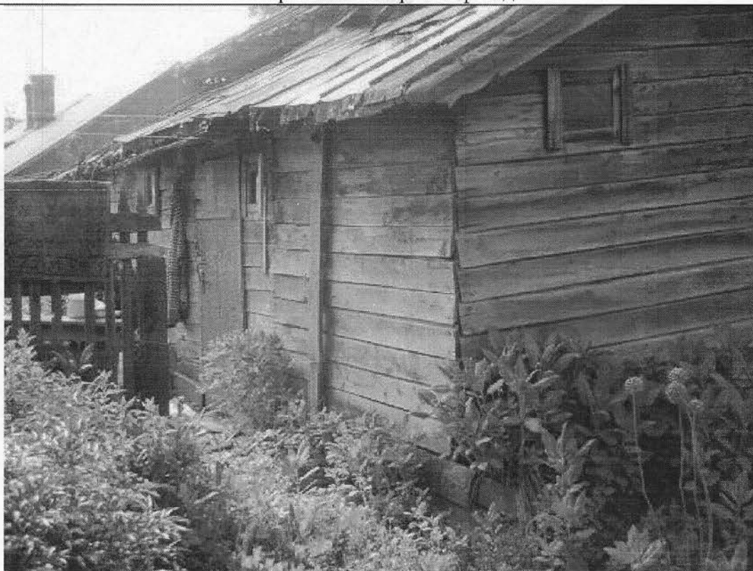
7. Фрагмент северного фасада
