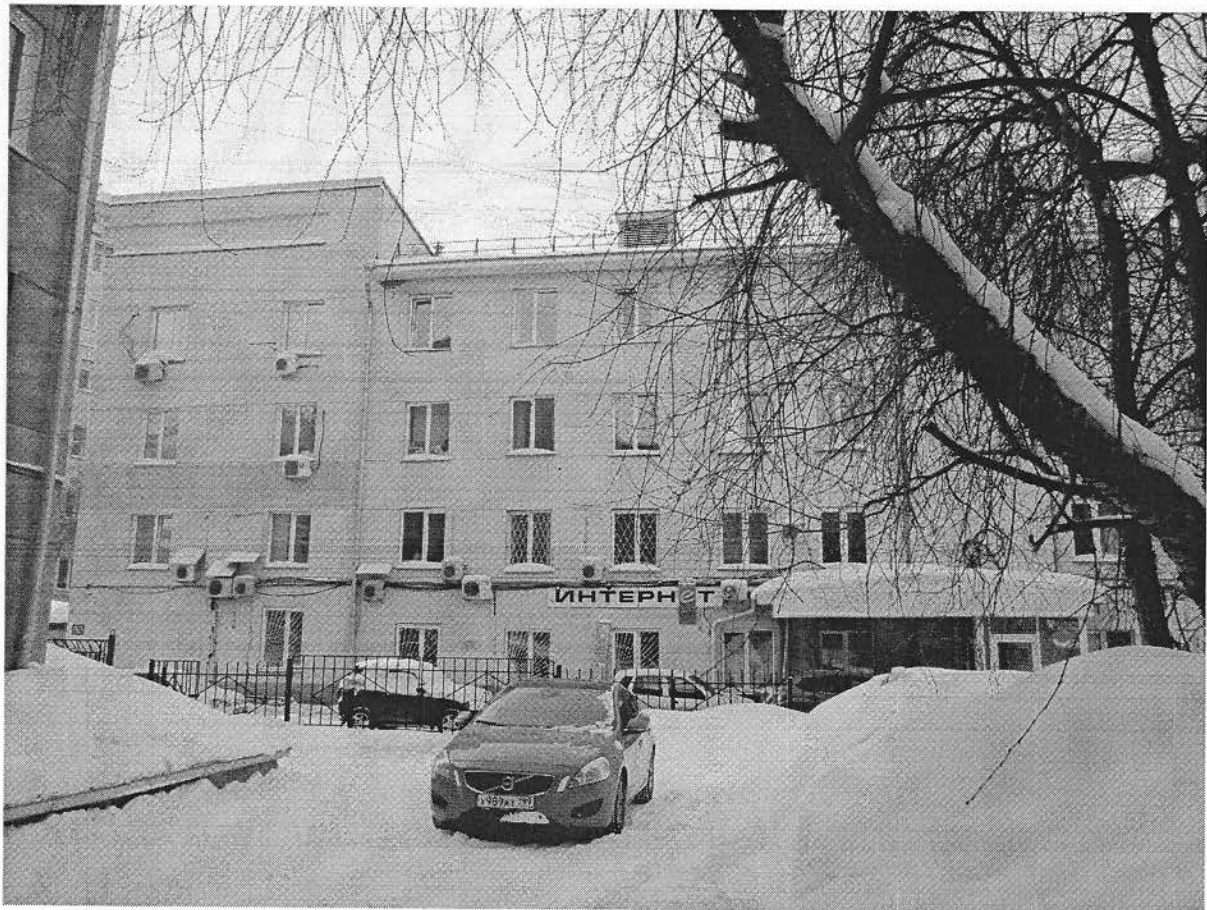
Фото 1. Левая часть восточного фасада.
