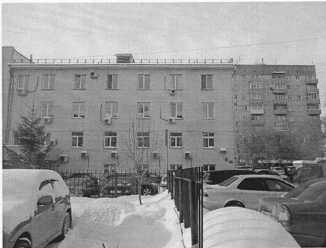
8. Правая часть восточного фасада.
