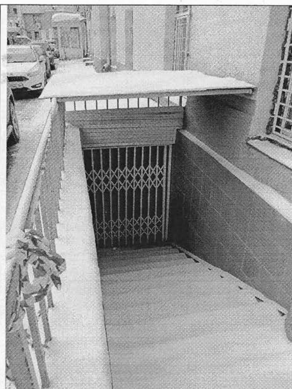
6. Спуск в подвал средней части восточного фасада.
