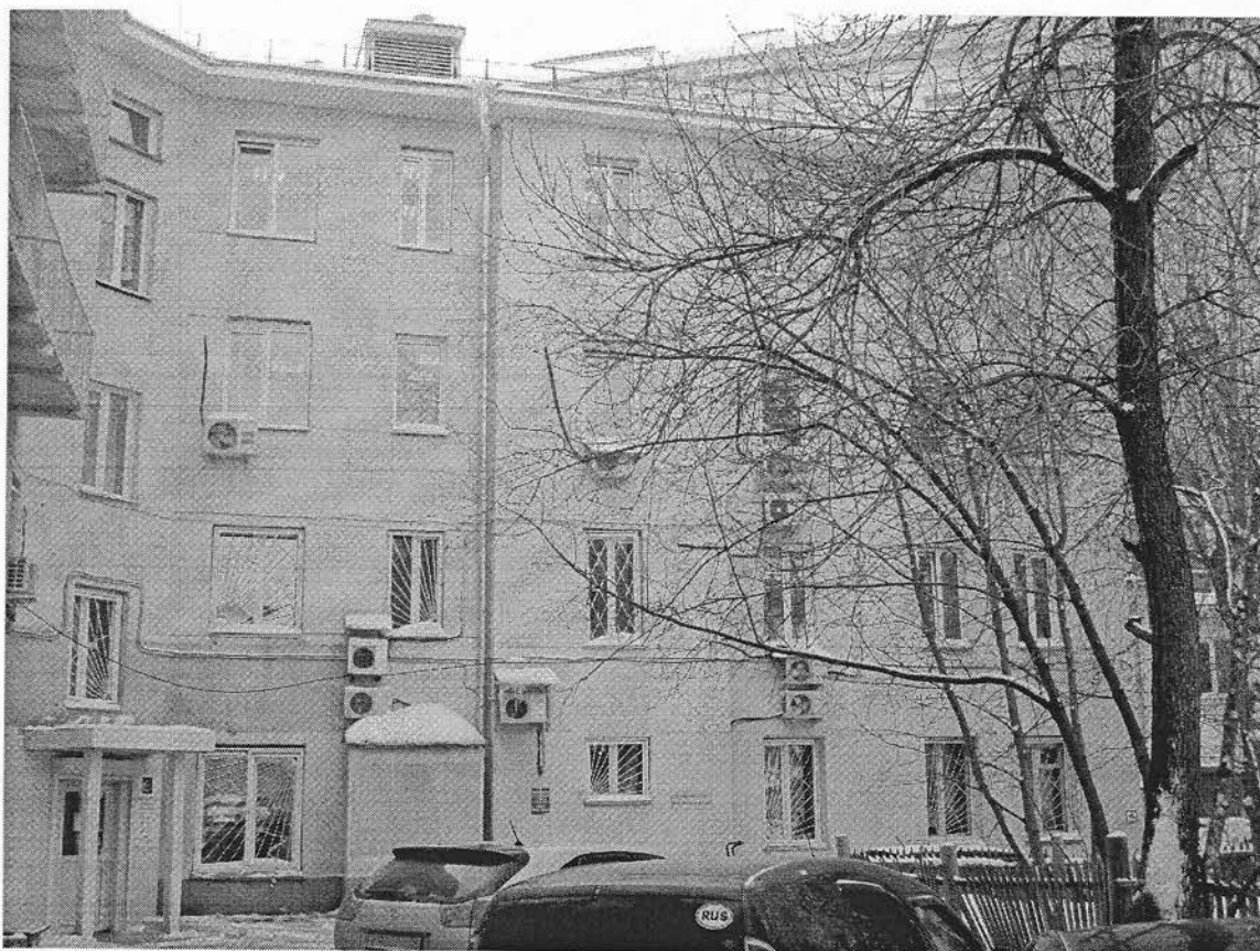
Фото 8. Северный фасад (дворовая часть).
