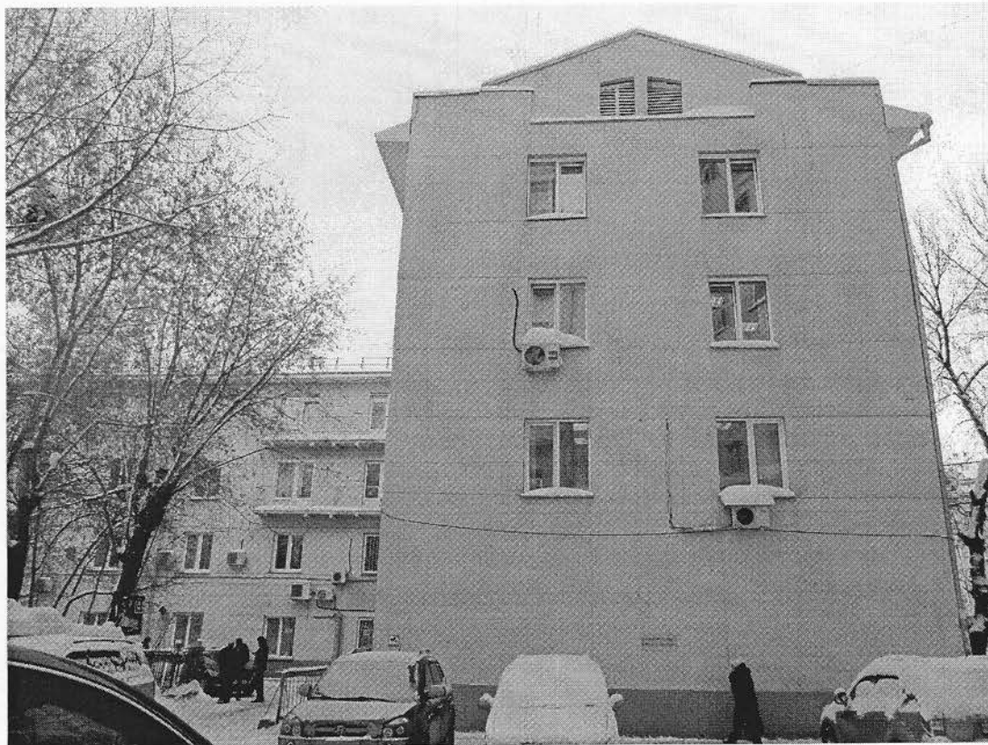
13. Правая часть западного фасада.
