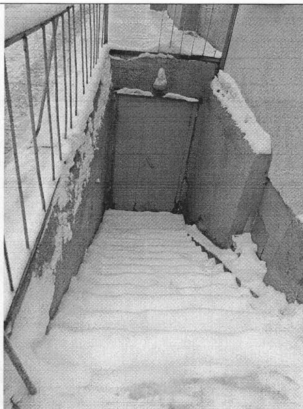
12. Прямо́к спуска в подвал на северном фасаде (дворовой части).
