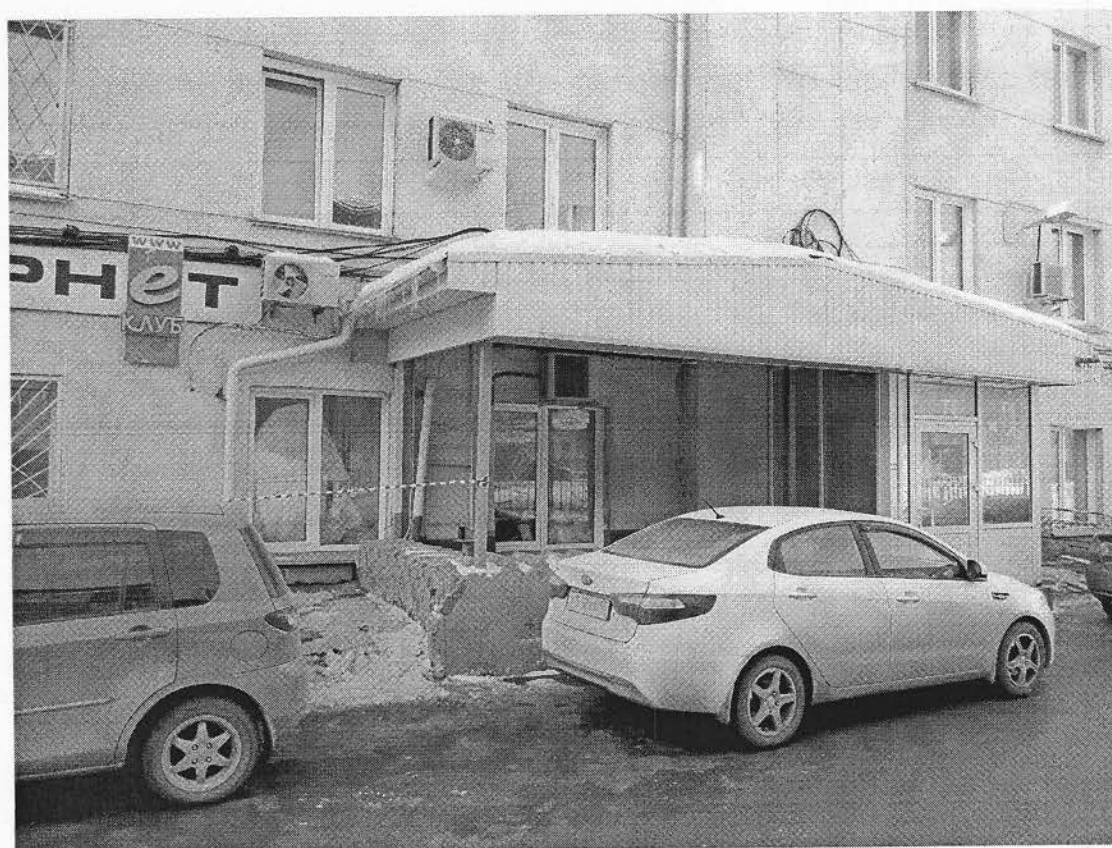
4. Выносной тамбур входа на 1-ый этаж и козырёк над спуском в подвал левой части восточного фасада.
