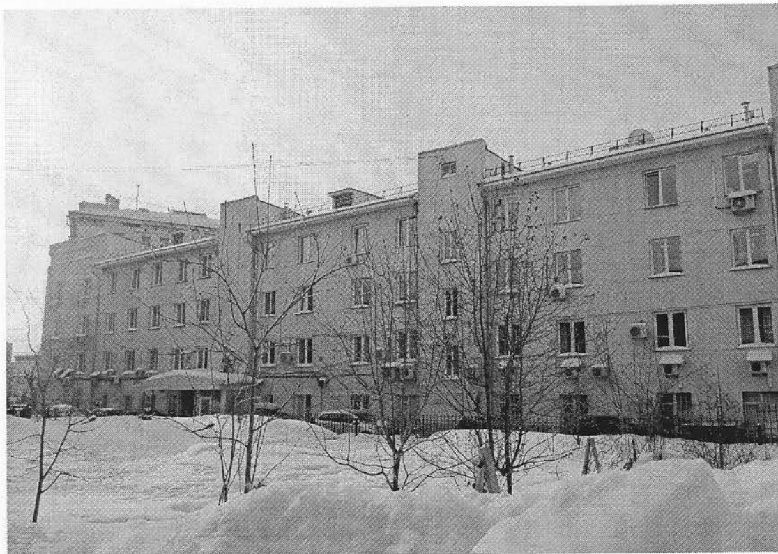
3. Левая часть восточного фасада.
