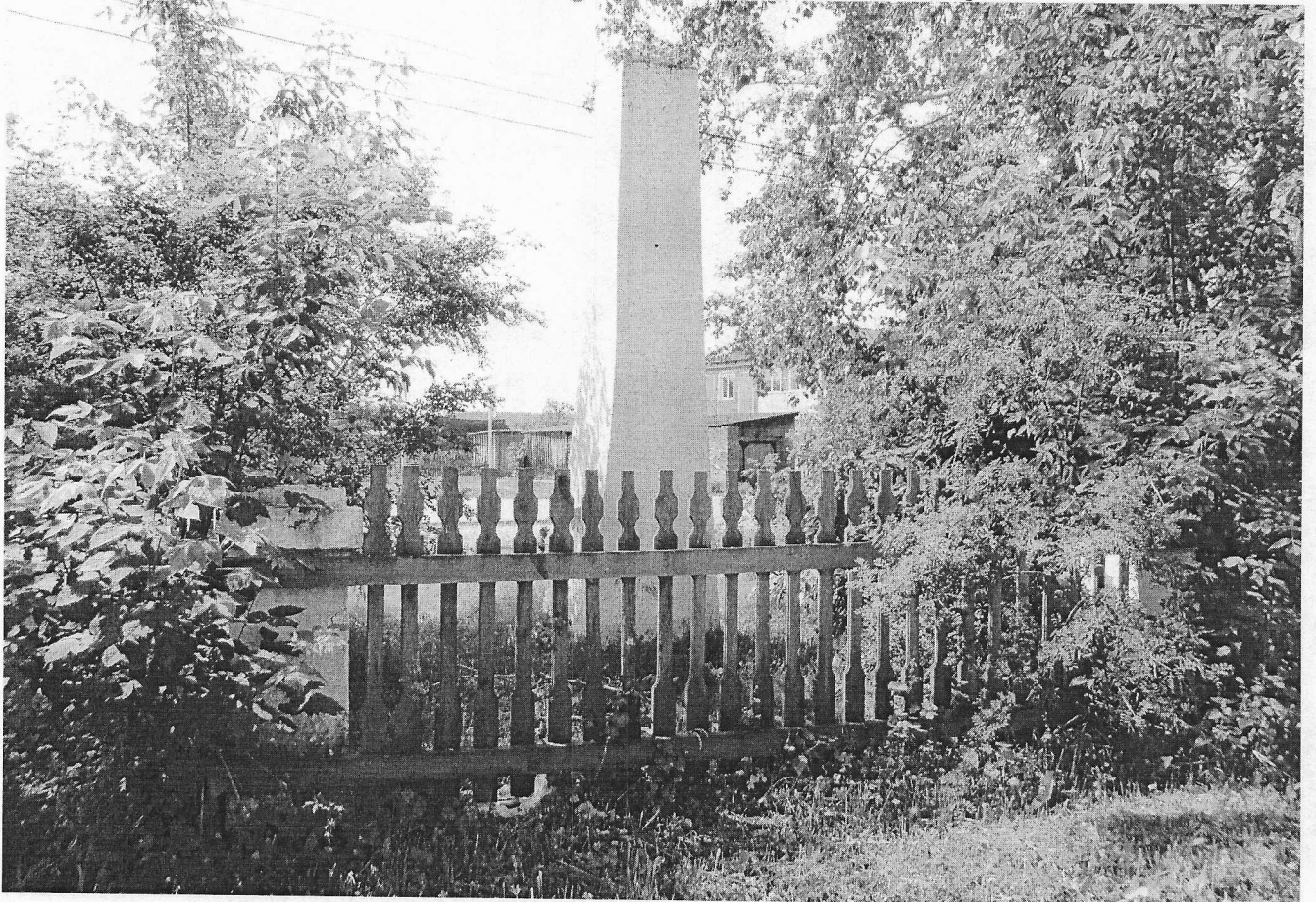
2. Общий вид Памятника с северо-востока.
