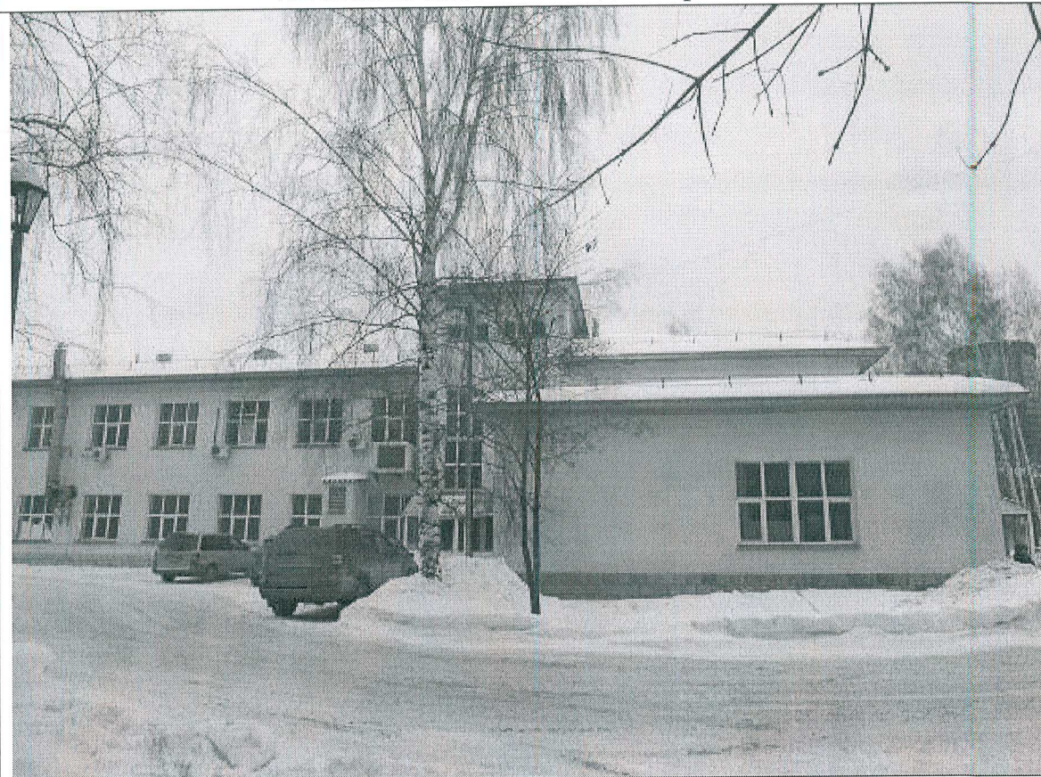
4.2. Южная часть юго-западного фасада.
