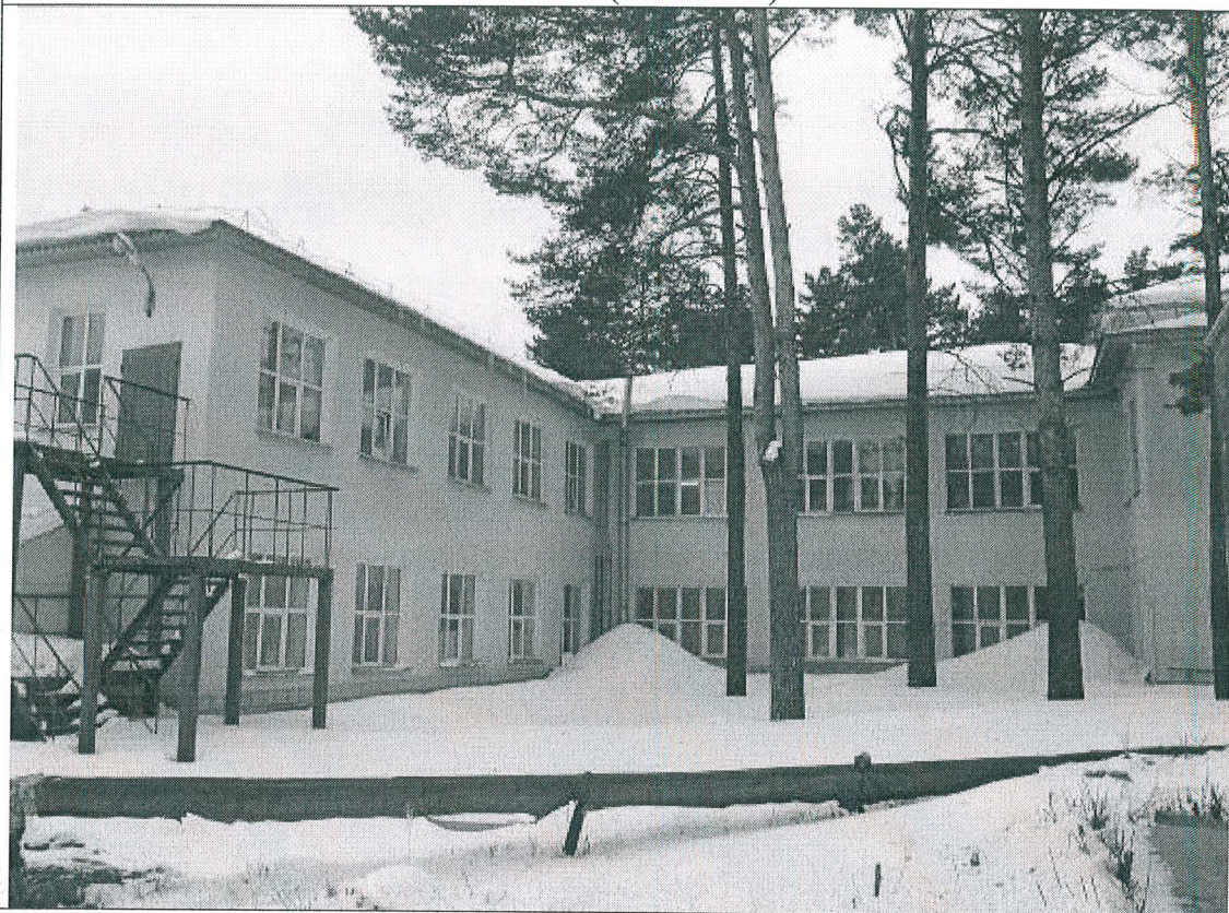
4.8. Северо-западный фасад по оси 3 (в осях Д-В) и северо-восточный фасад по оси В (в осях 3-2)
