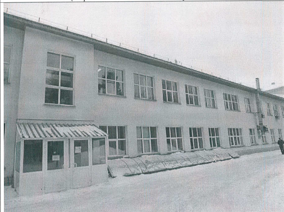
4.3. Центральная часть юго-западного фасада по оси Б.
