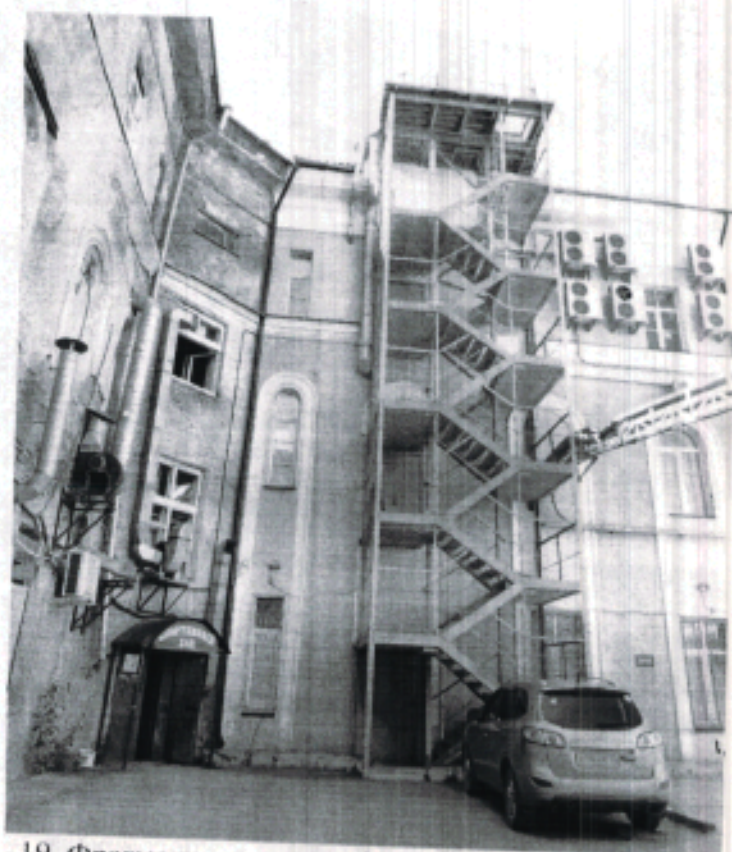
19. Фрагмент дворового фасада северного крыла.
