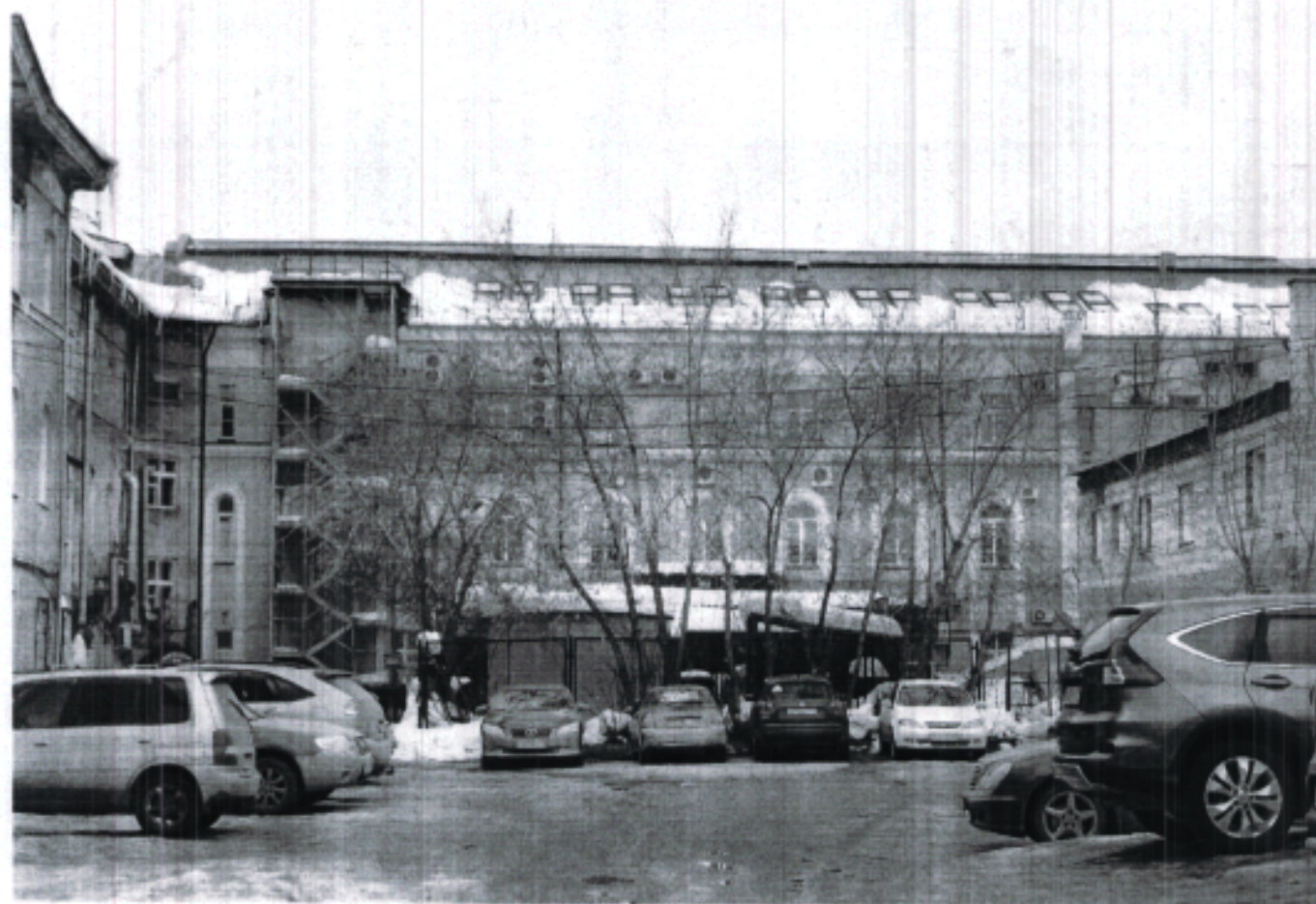
31. Общий вид дворового ската крыши северного крыла.
