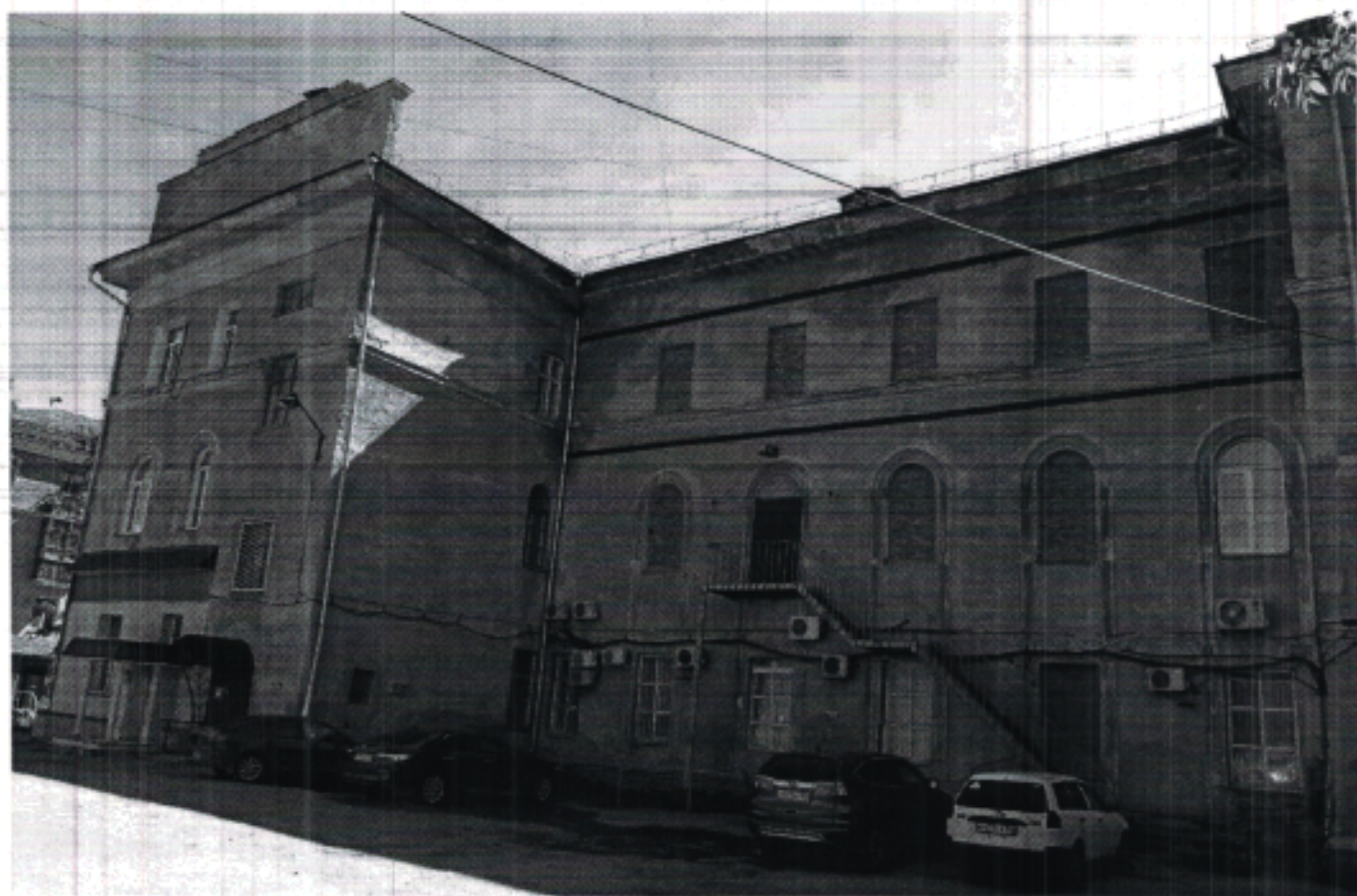
11. Фрагмент дворового фасада южного крыла.
