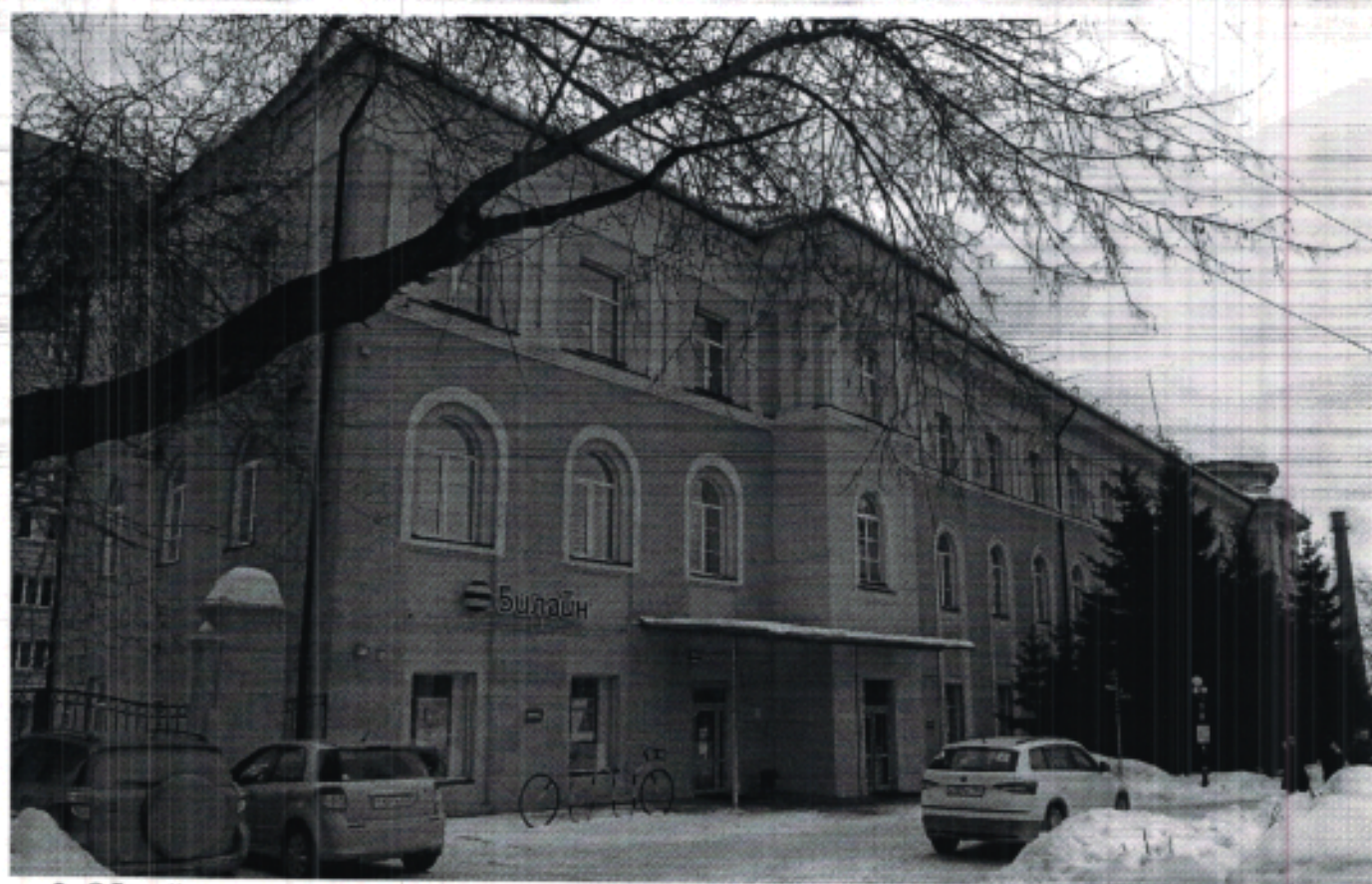
2. Общий вид северного крыла с севера.
