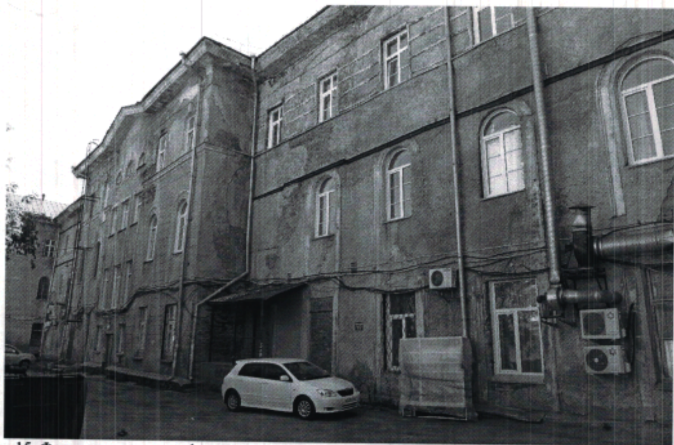
15. Фрагмент дворового фасада южного крыла.
