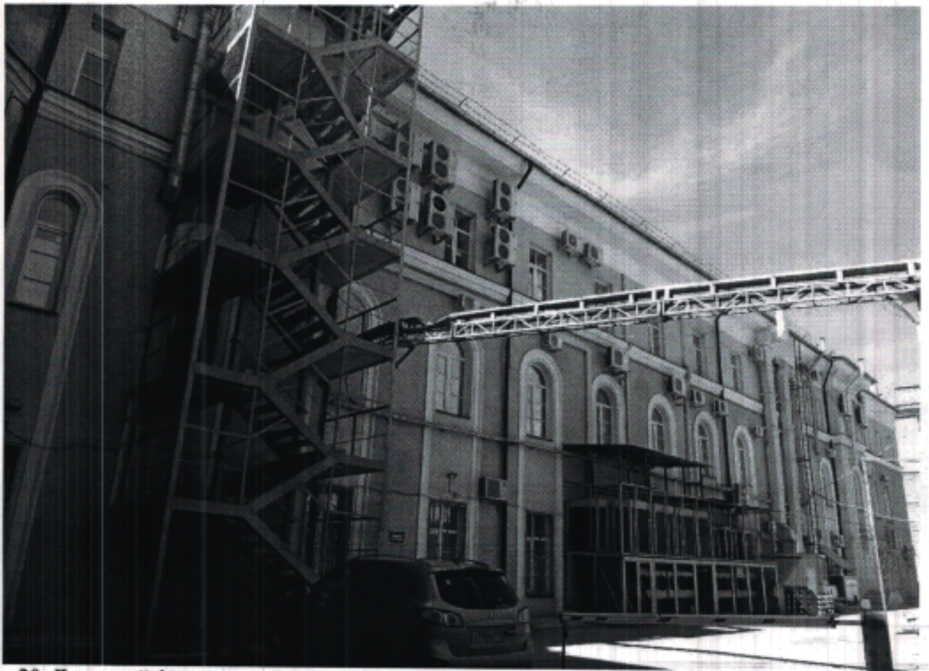
20. Дворовый фасад северного крыла.
