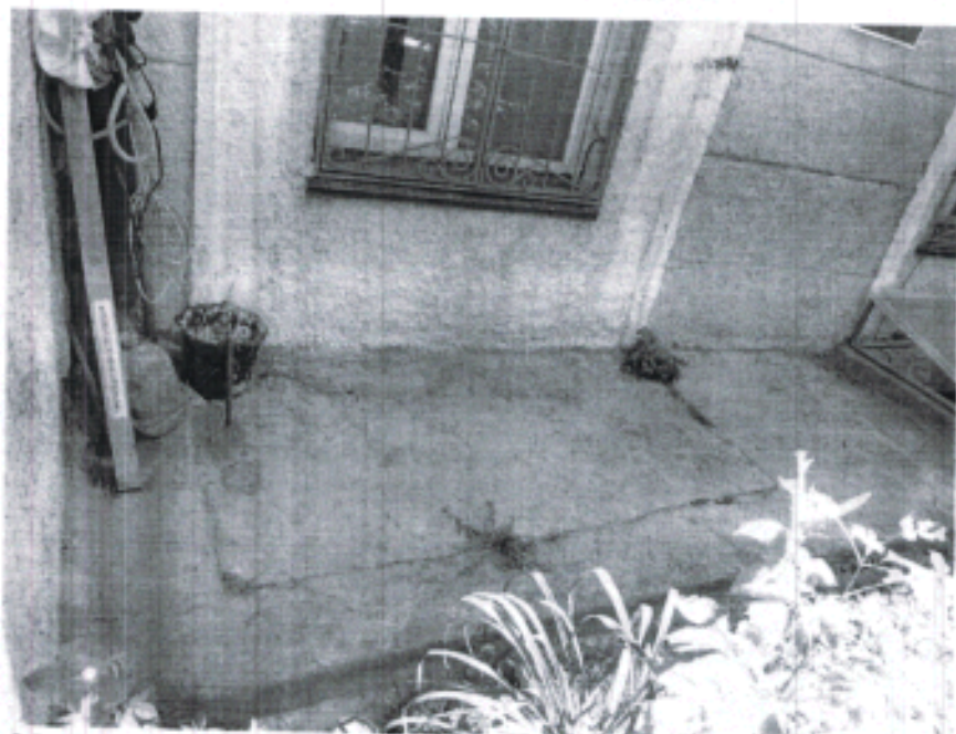
25. Фрагмент главного (северо-западного) фасада северного крыла.
