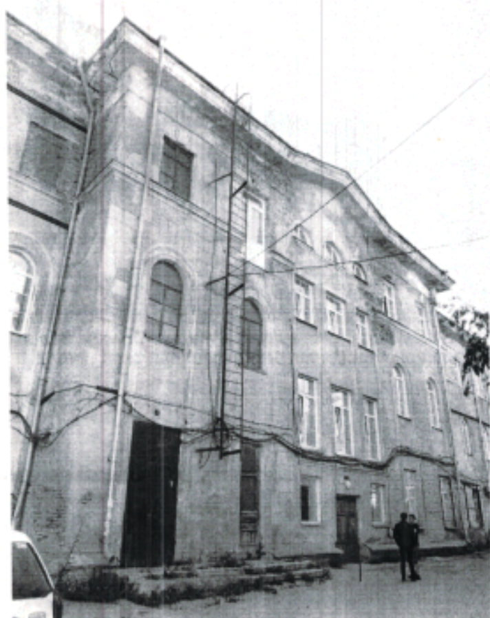
13. Фрагмент дворового фасада южного крыла.
