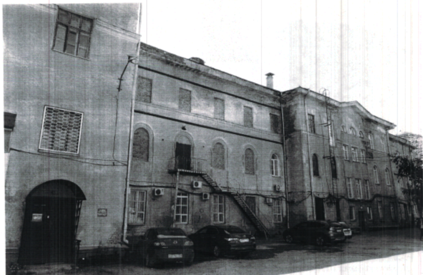
12. Фрагмент дворового фасада южного крыла.
