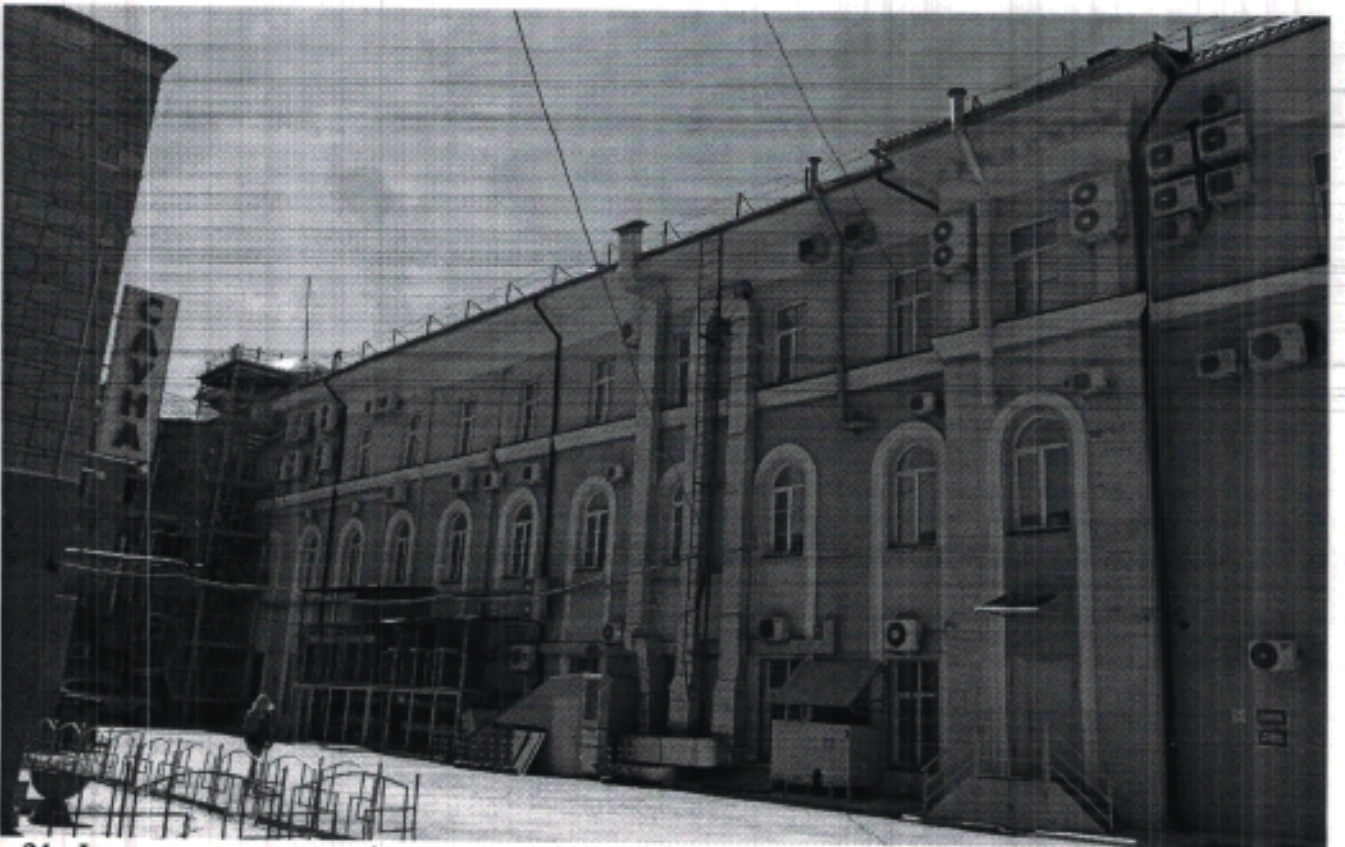
21. Фрагмент дворового фасада северного крыла.
