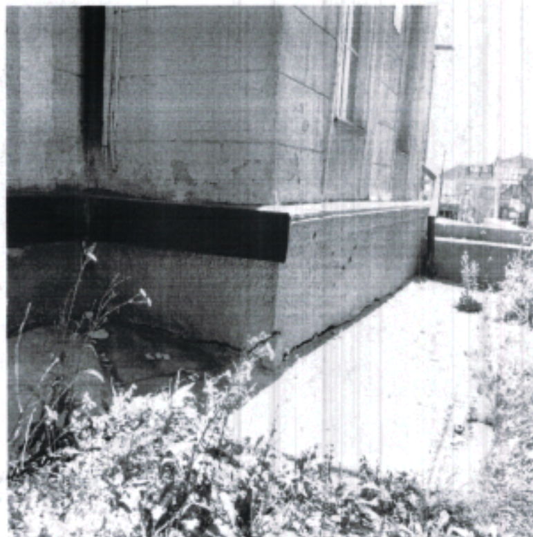
30. Фрагмент главного (северо-западного) фасада углового объема.
