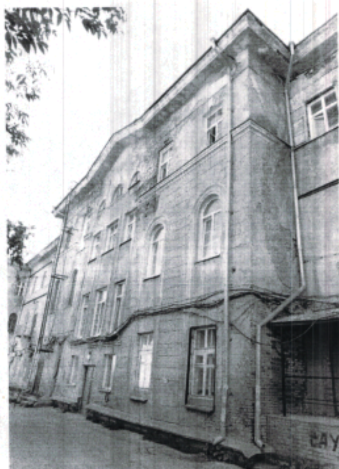
14. Фрагмент дворового фасада южного крыла.
