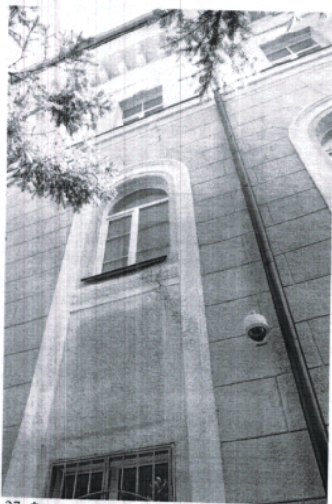
27. Фрагмент главного (северо-западного) фасада северного крыла.
