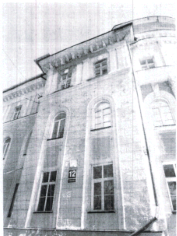
29. Фрагмент главного (северо-западного) фасада углового объема.
