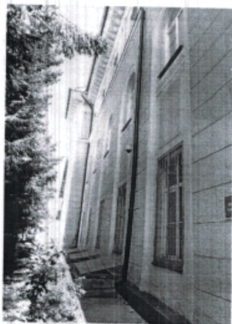
26. Фрагмент северо-западного фасада северного крыла.
