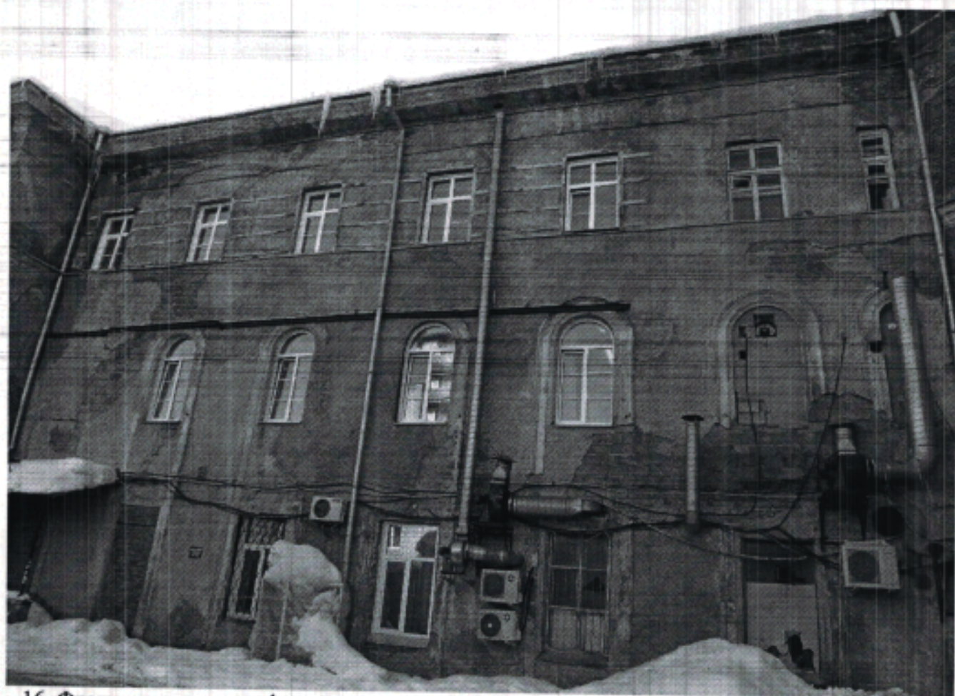
16. Фрагмент дворового фасада южного крыла.
