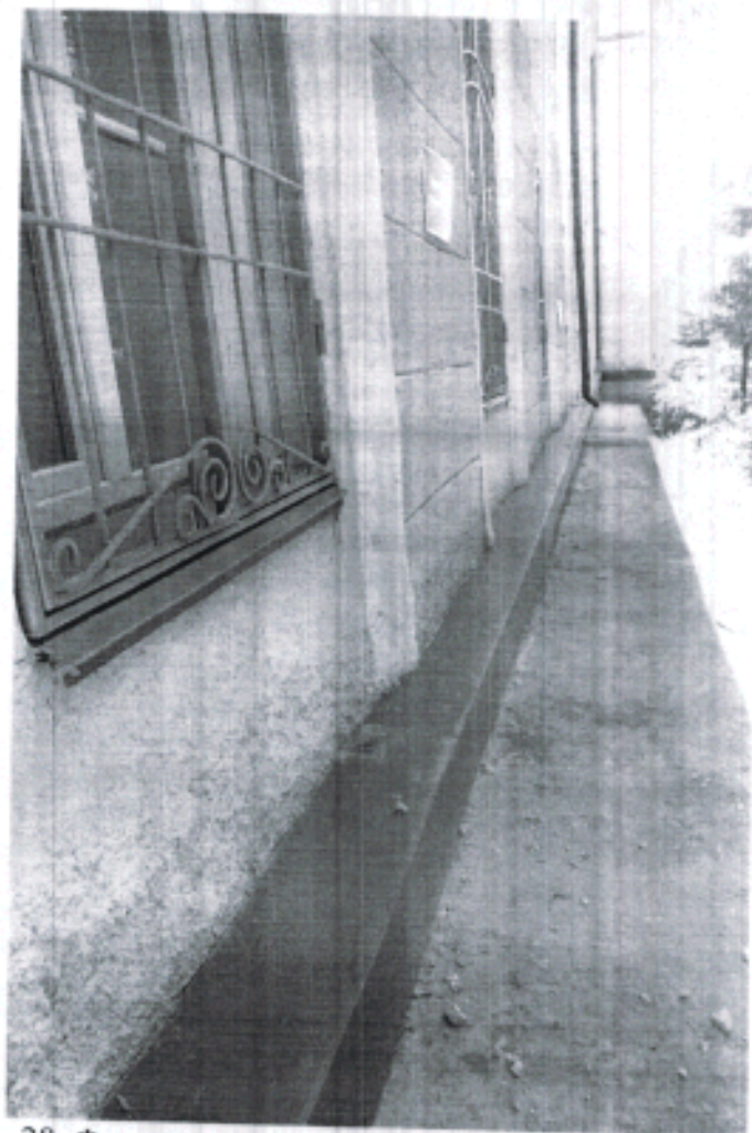
28. Фрагмент главного (северо-западного) фасада северного крыла.
