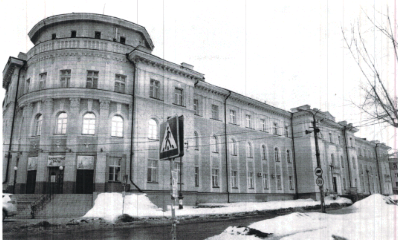
3. Общий вид главного фасада южного крыла.
