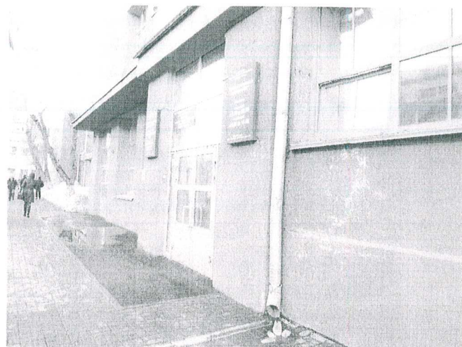
Фрагмент западного фасада. Главный вход.
