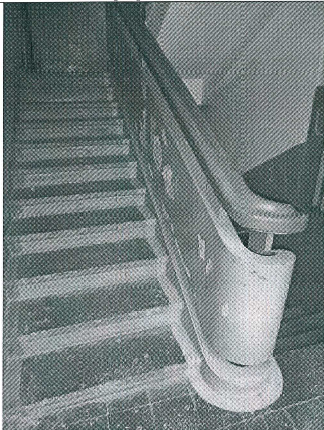
5.17. Интерьер лестничной клетки
