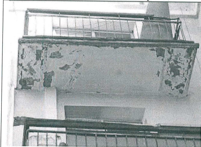
5.31. Балкон на западном фасаде
