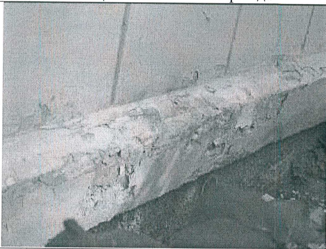
5.28. Цоколь восточного фасада
