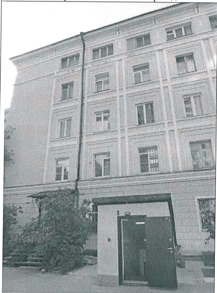
5.3. Фрагмент восточного фасада
