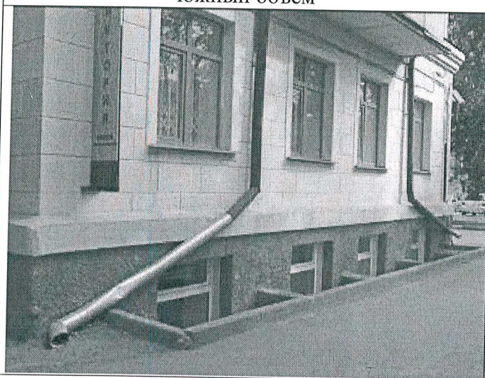
5.23. Световые приямки, западный фасад, южный объём
